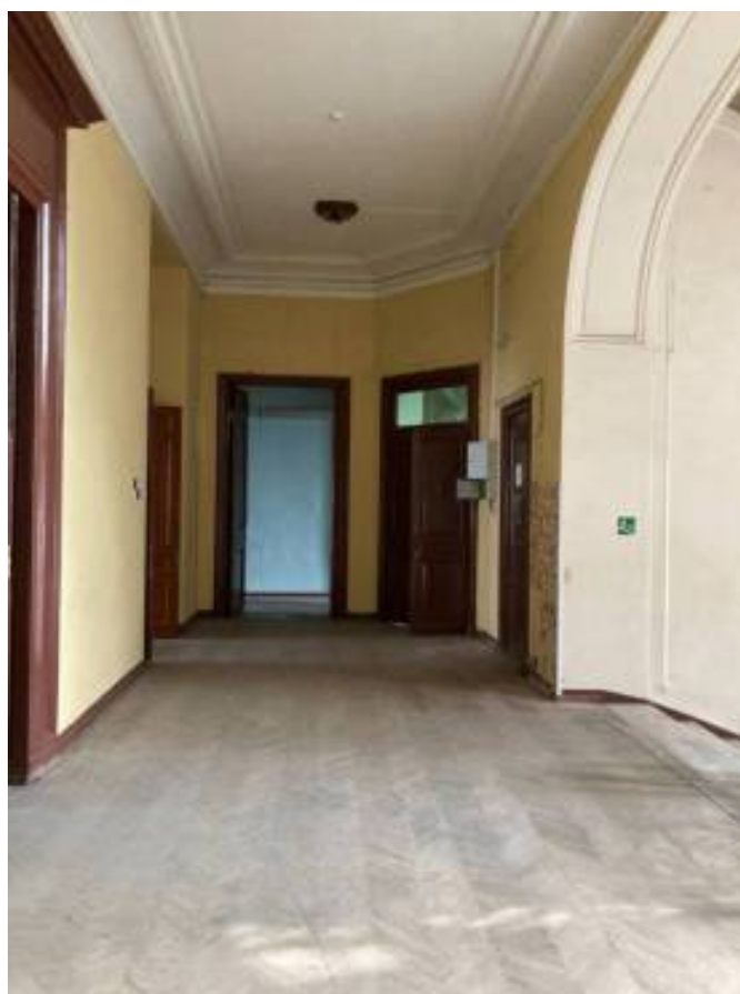
Фото 126. Интерьер третьего этажа объекта культурного наследия регионального значения «Дом Первого Российского страхового общества»
