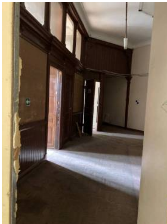
Фото 130. Интерьер третьего этажа объекта культурного наследия регионального значения «Дом Первого Российского страхового общества»
