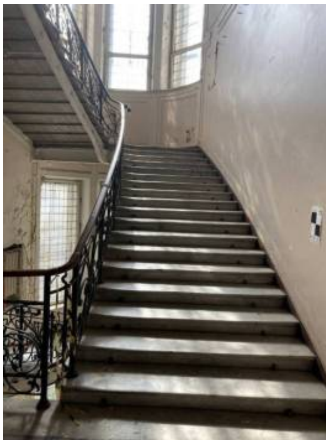
Фото 127. Интерьер третьего этажа объекта культурного наследия регионального значения «Дом Первого Российского страхового общества»
