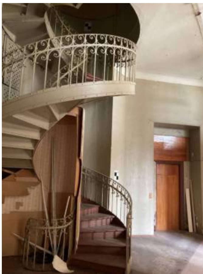
Фото 132. Интерьер третьего этажа объекта культурного наследия регионального значения «Дом Первого Российского страхового общества»
