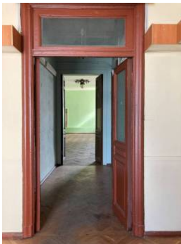
Фото 120. Интерьер третьего этажа объекта культурного наследия регионального значения «Дом Первого Российского страхового общества»
