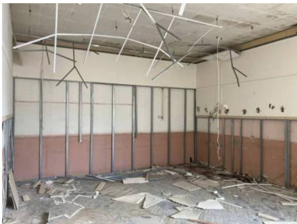
Фото 192. Интерьер пятого этажа объекта культурного наследия регионального значения «Дом Первого Российского страхового общества»
