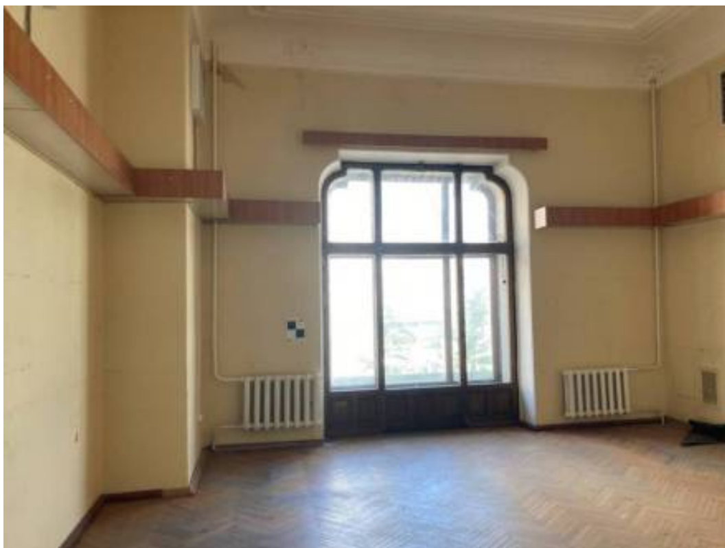
Фото 118. Интерьер третьего этажа объекта культурного наследия регионального значения «Дом Первого Российского страхового общества»
