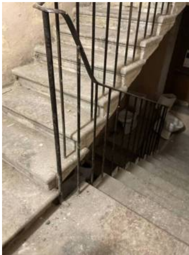
Фото 136. Интерьер третьего этажа объекта культурного наследия регионального значения «Дом Первого Российского страхового общества»
