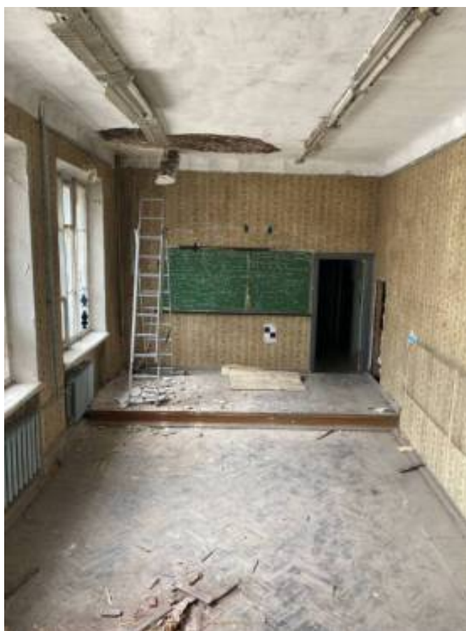
Фото 202. Интерьер пятого этажа объекта культурного наследия регионального значения «Дом Первого Российского страхового общества»
