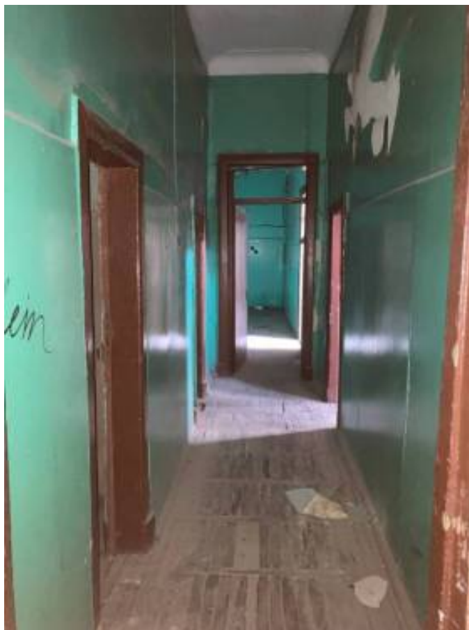
Фото 198. Интерьер пятого этажа объекта культурного наследия регионального значения «Дом Первого Российского страхового общества»
