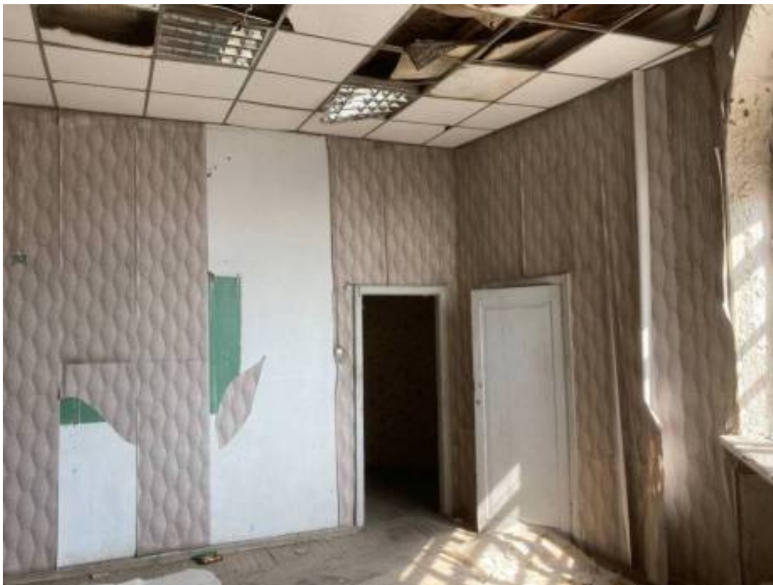
Фото 201. Интерьер пятого этажа объекта культурного наследия регионального значения «Дом Первого Российского страхового общества»
