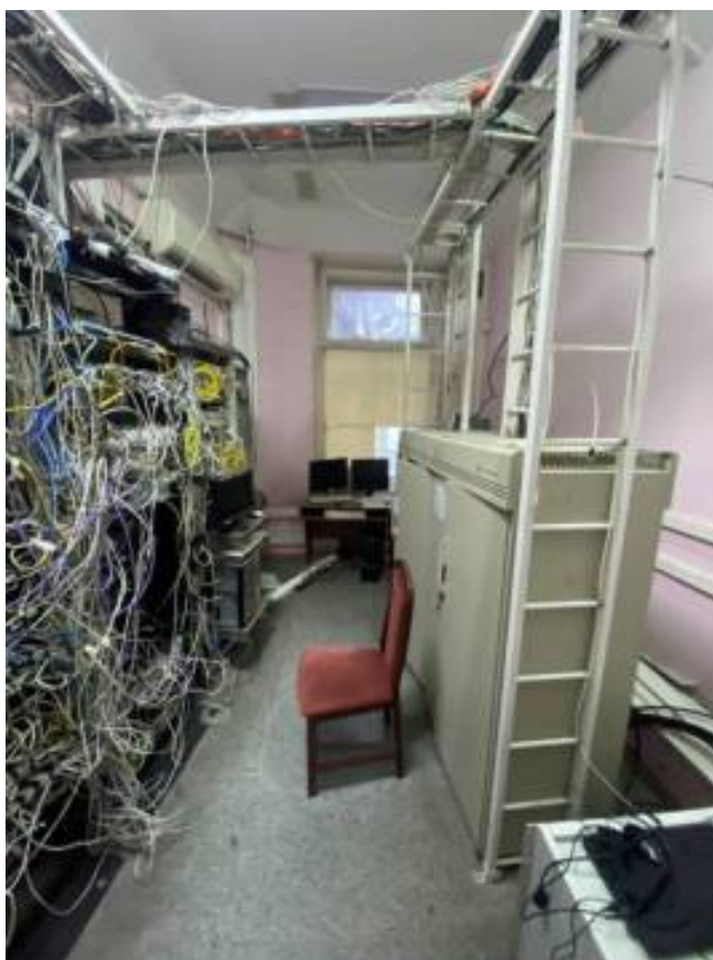
Фото 106. Интерьер третьего этажа объекта культурного наследия регионального значения «Дом Первого Российского страхового общества»
