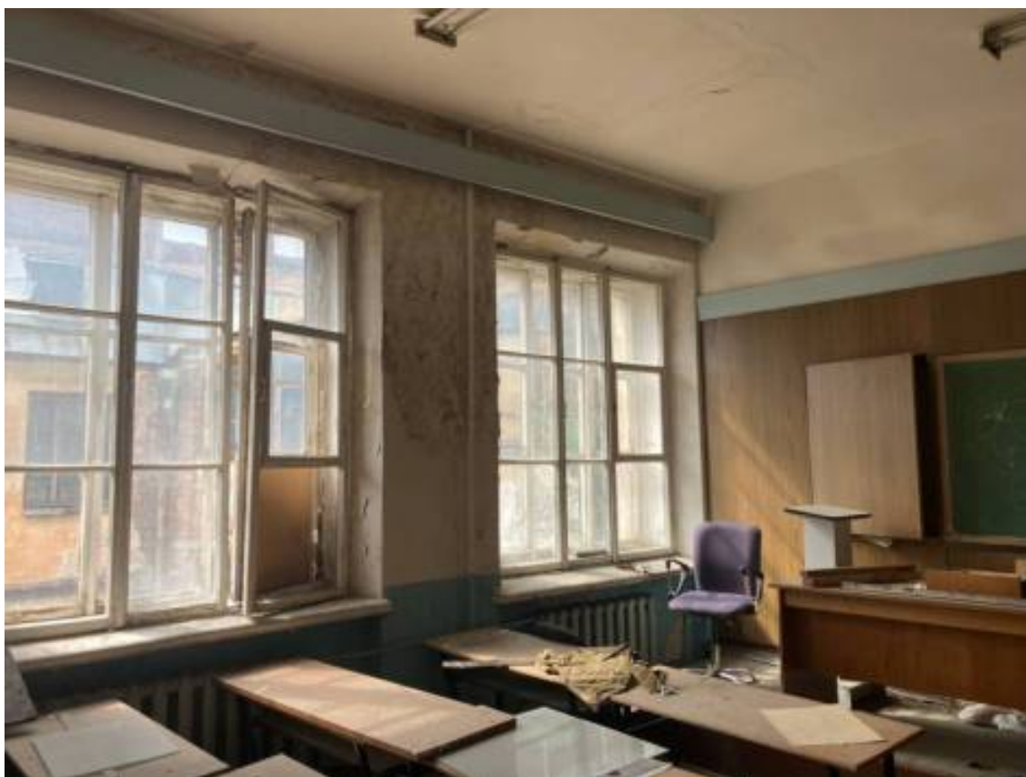
Фото 188. Интерьер пятого этажа объекта культурного наследия регионального значения «Дом Первого Российского страхового общества»
