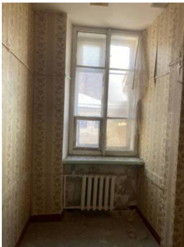
Фото 204. Интерьер пятого этажа объекта культурного наследия регионального значения «Дом Первого Российского страхового общества»
