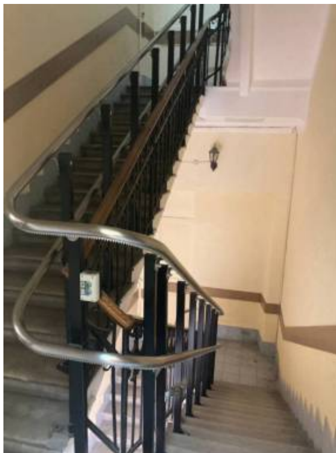
Фото 113. Интерьер третьего этажа объекта культурного наследия регионального значения «Дом Первого Российского страхового общества»
