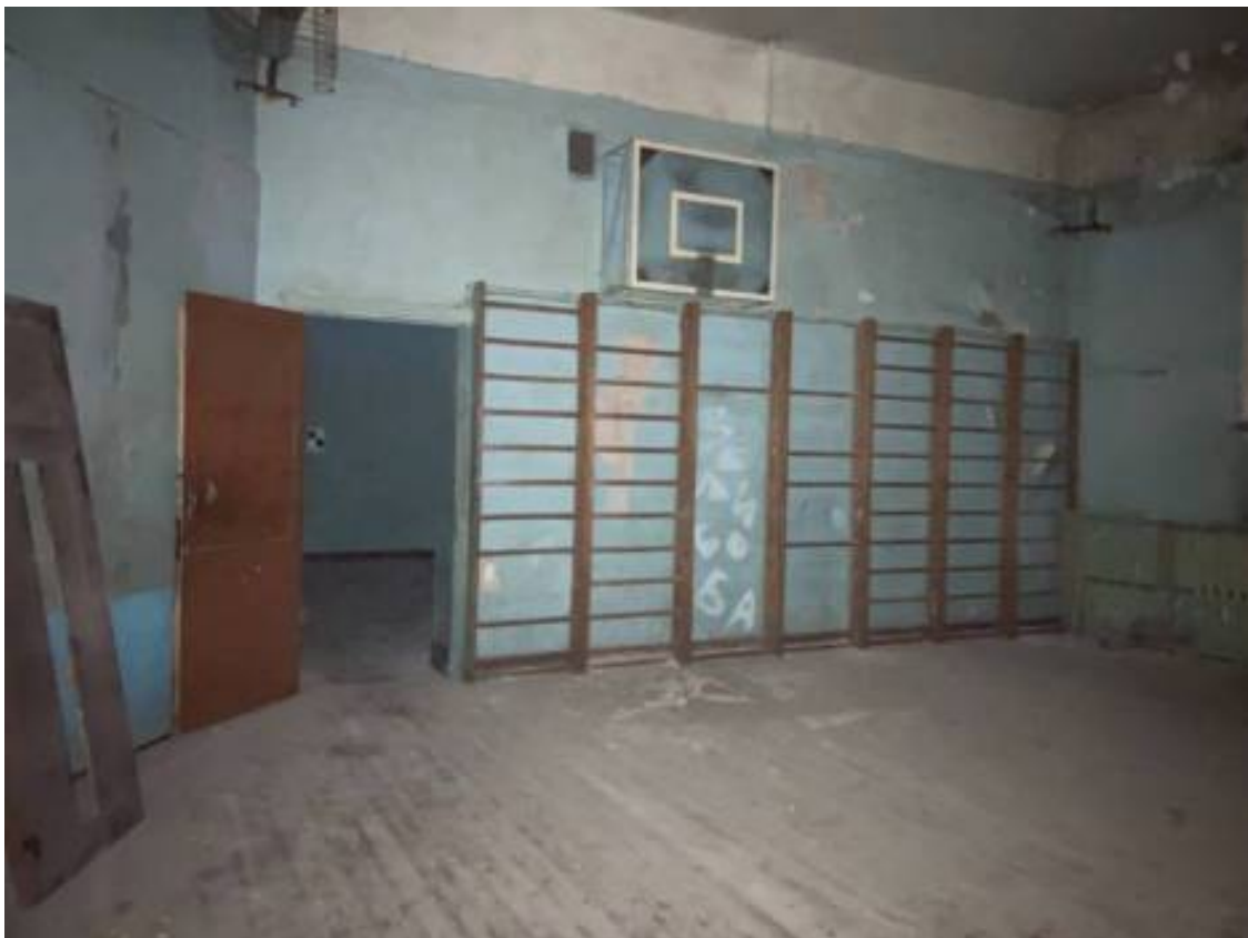
Фото 195. Интерьер пятого этажа объекта культурного наследия регионального значения «Дом Первого Российского страхового общества»
