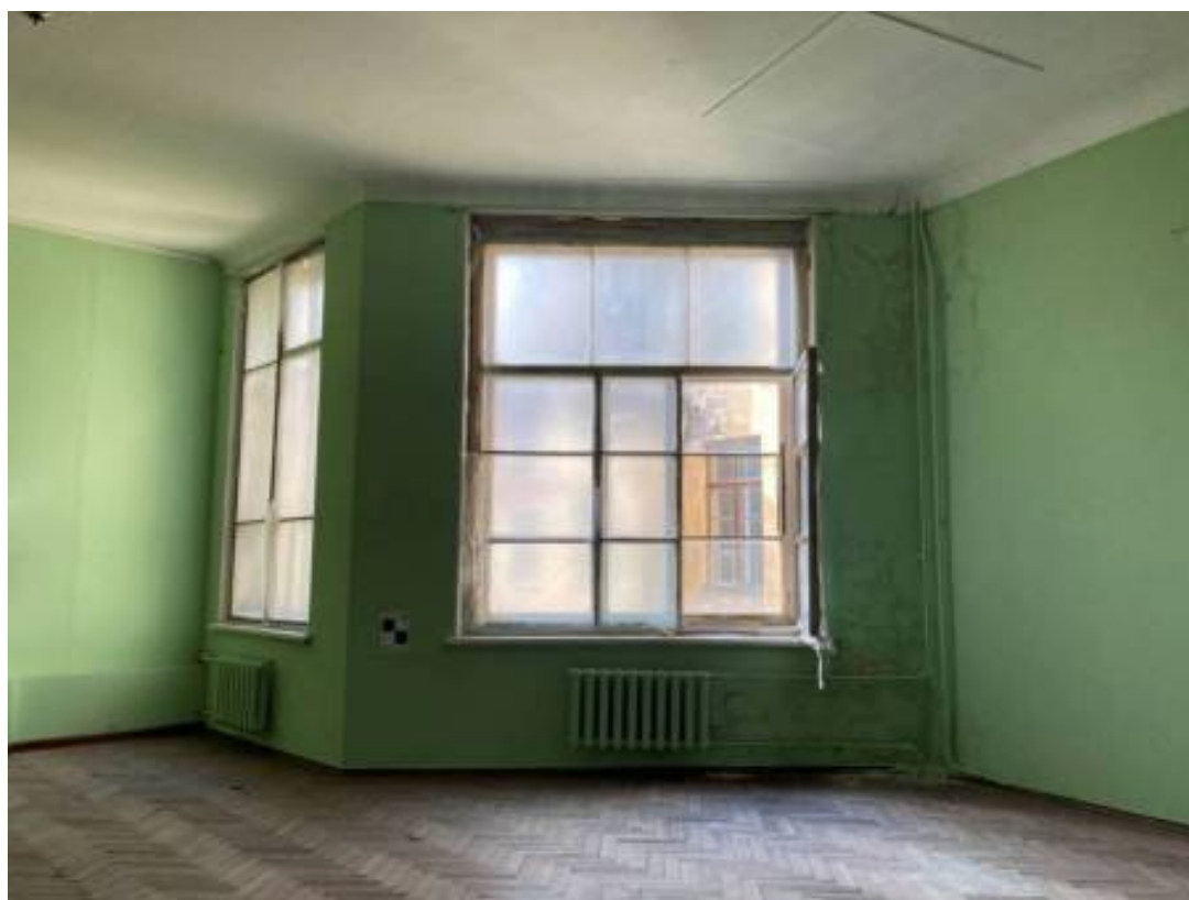
Фото 116. Интерьер третьего этажа объекта культурного наследия регионального значения «Дом Первого Российского страхового общества»
