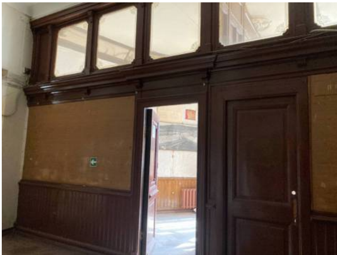
Фото 131. Интерьер третьего этажа объекта культурного наследия регионального значения «Дом Первого Российского страхового общества»
