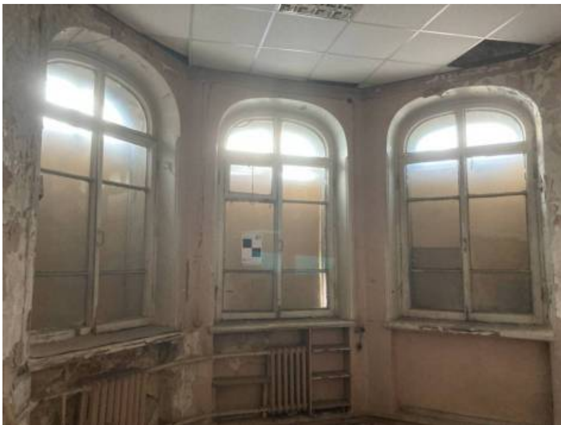
Фото 199. Интерьер пятого этажа объекта культурного наследия регионального значения «Дом Первого Российского страхового общества»
