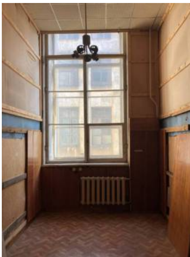
Фото 134. Интерьер третьего этажа объекта культурного наследия регионального значения «Дом Первого Российского страхового общества»
