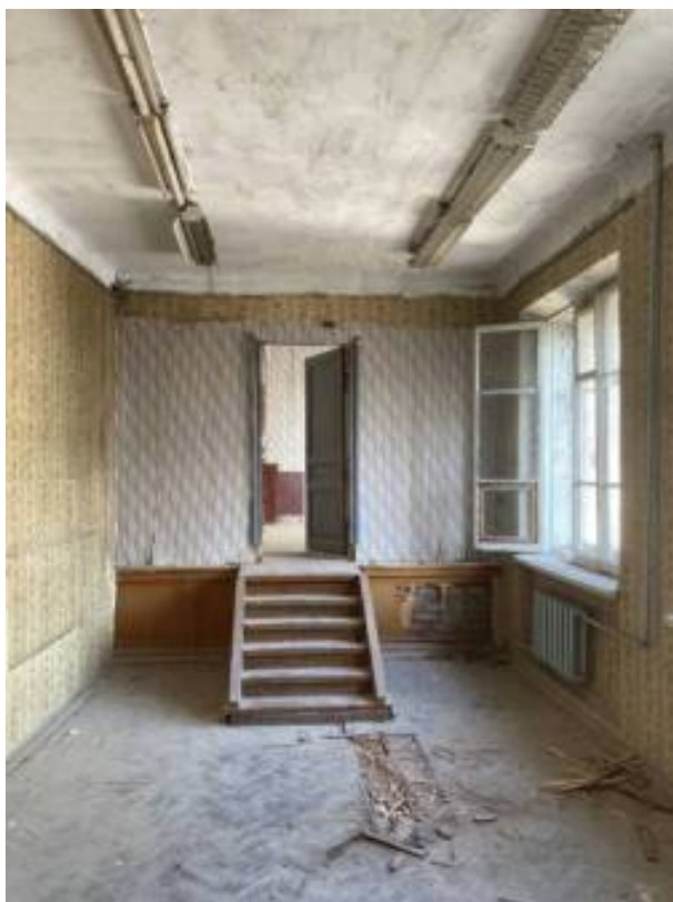
Фото 203. Интерьер пятого этажа объекта культурного наследия регионального значения «Дом Первого Российского страхового общества»
