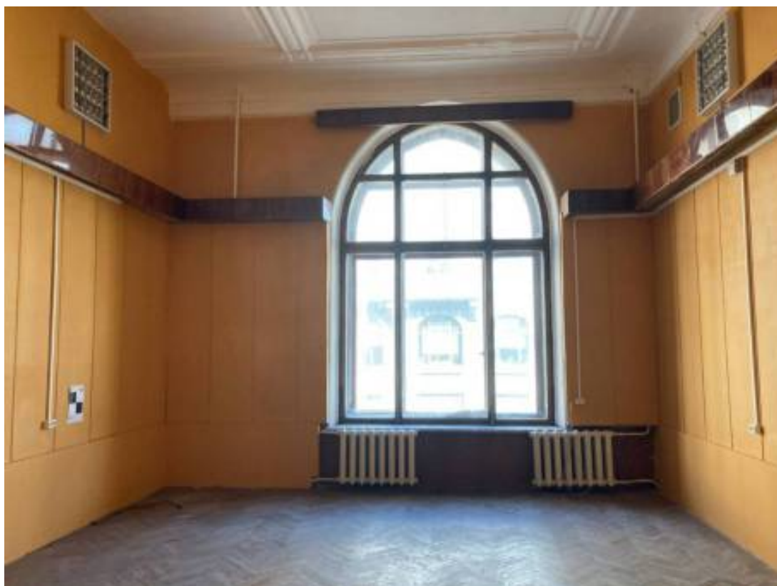
Фото 121. Интерьер третьего этажа объекта культурного наследия регионального значения «Дом Первого Российского страхового общества»
