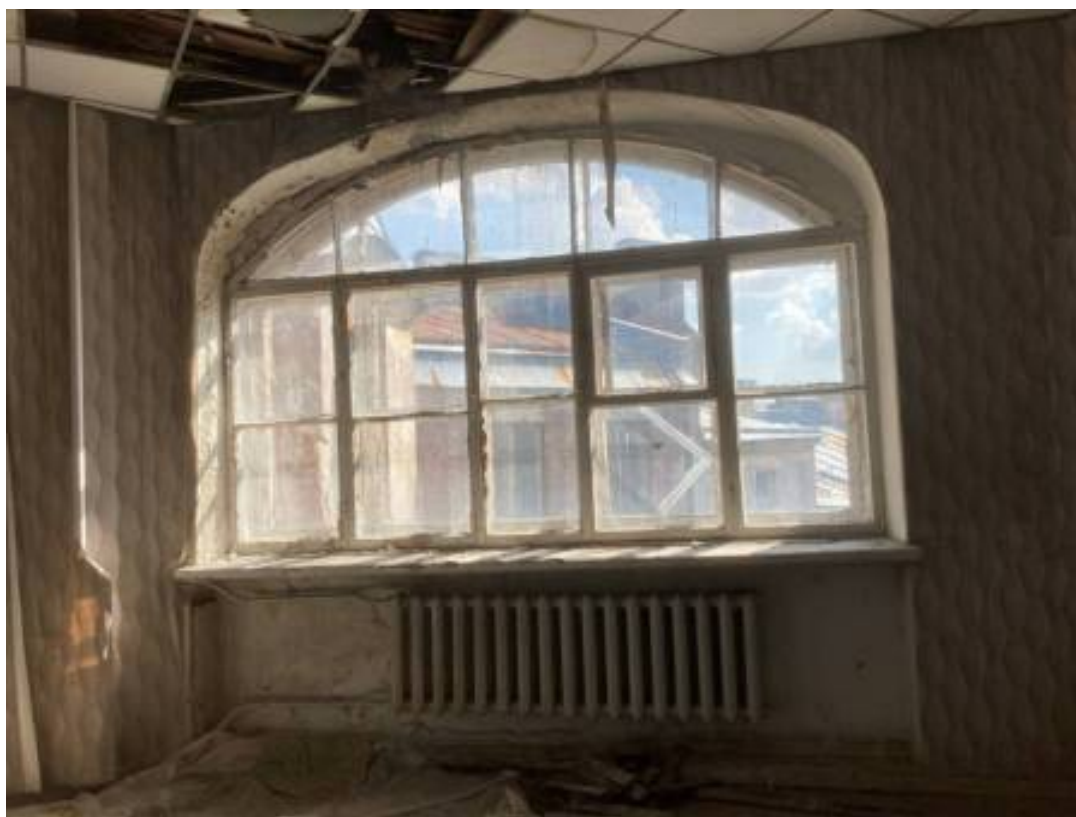
Фото 200. Интерьер пятого этажа объекта культурного наследия регионального значения «Дом Первого Российского страхового общества»
