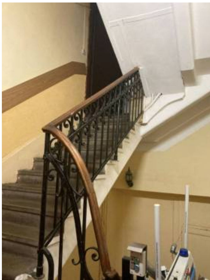
Фото 187. Интерьер пятого этажа объекта культурного наследия регионального значения «Дом Первого Российского страхового общества»
