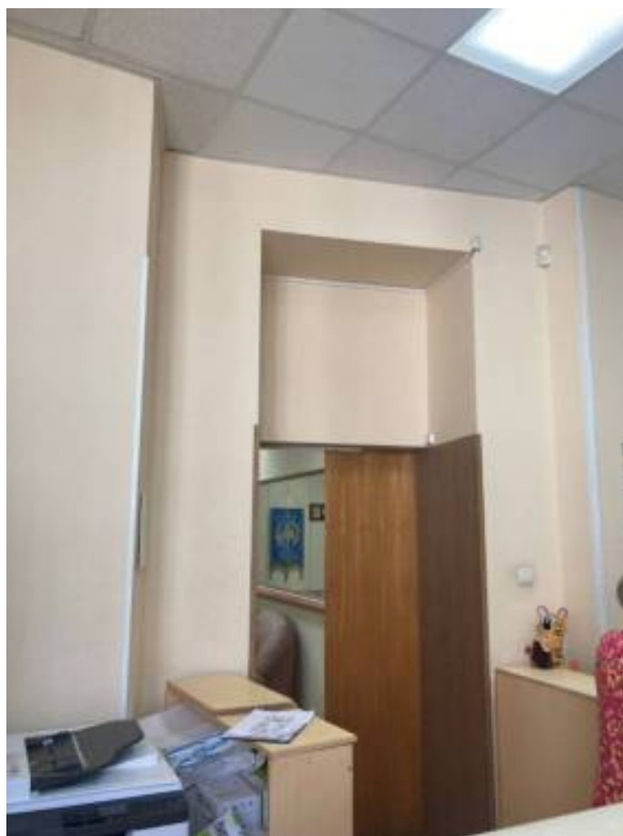
Фото 103. Интерьер третьего этажа объекта культурного наследия регионального значения «Дом Первого Российского страхового общества»
