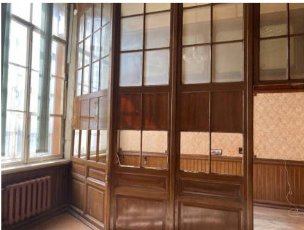
Фото 129. Интерьер третьего этажа объекта культурного наследия регионального значения «Дом Первого Российского страхового общества»
