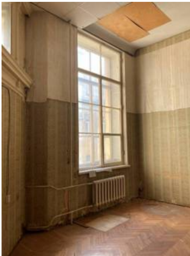
Фото 133. Интерьер третьего этажа объекта культурного наследия регионального значения «Дом Первого Российского страхового общества»
