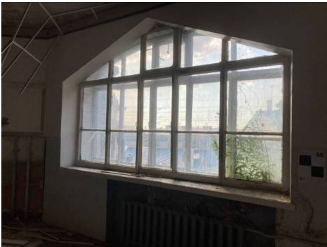
Фото 191. Интерьер пятого этажа объекта культурного наследия регионального значения «Дом Первого Российского страхового общества»
