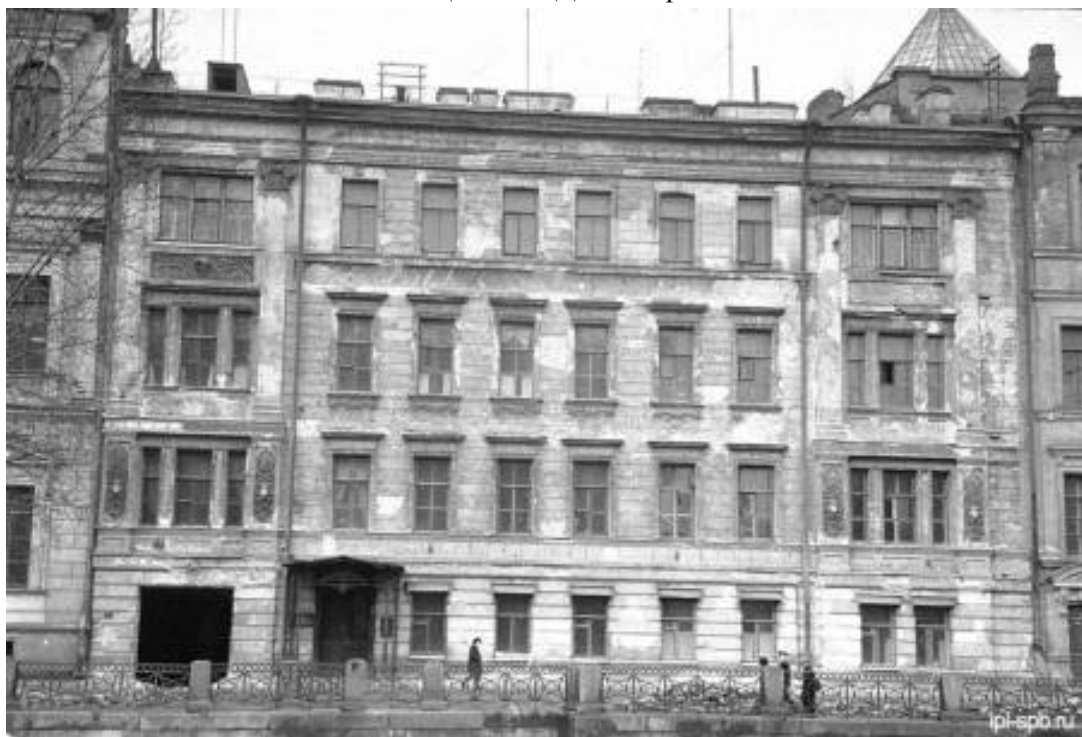
16. Здание Управления пожарной охраны до ремонта. 1950 г. — «PastVu» – ретро-фотографии стран и городов [Электронный ресурс]. URL: https://pastvu.com/p/1036367 .
