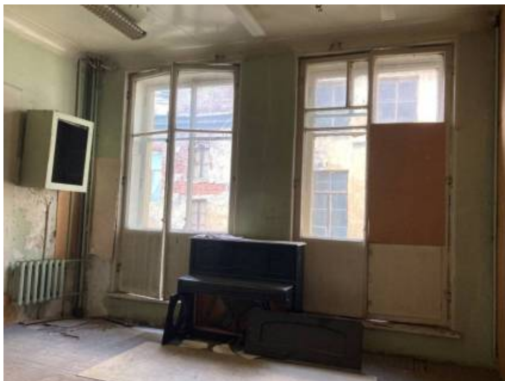
Фото 114. Интерьер третьего этажа объекта культурного наследия регионального значения «Дом Первого Российского страхового общества»
