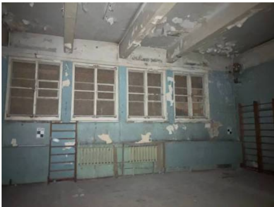
Фото 194. Интерьер пятого этажа объекта культурного наследия регионального значения «Дом Первого Российского страхового общества»
