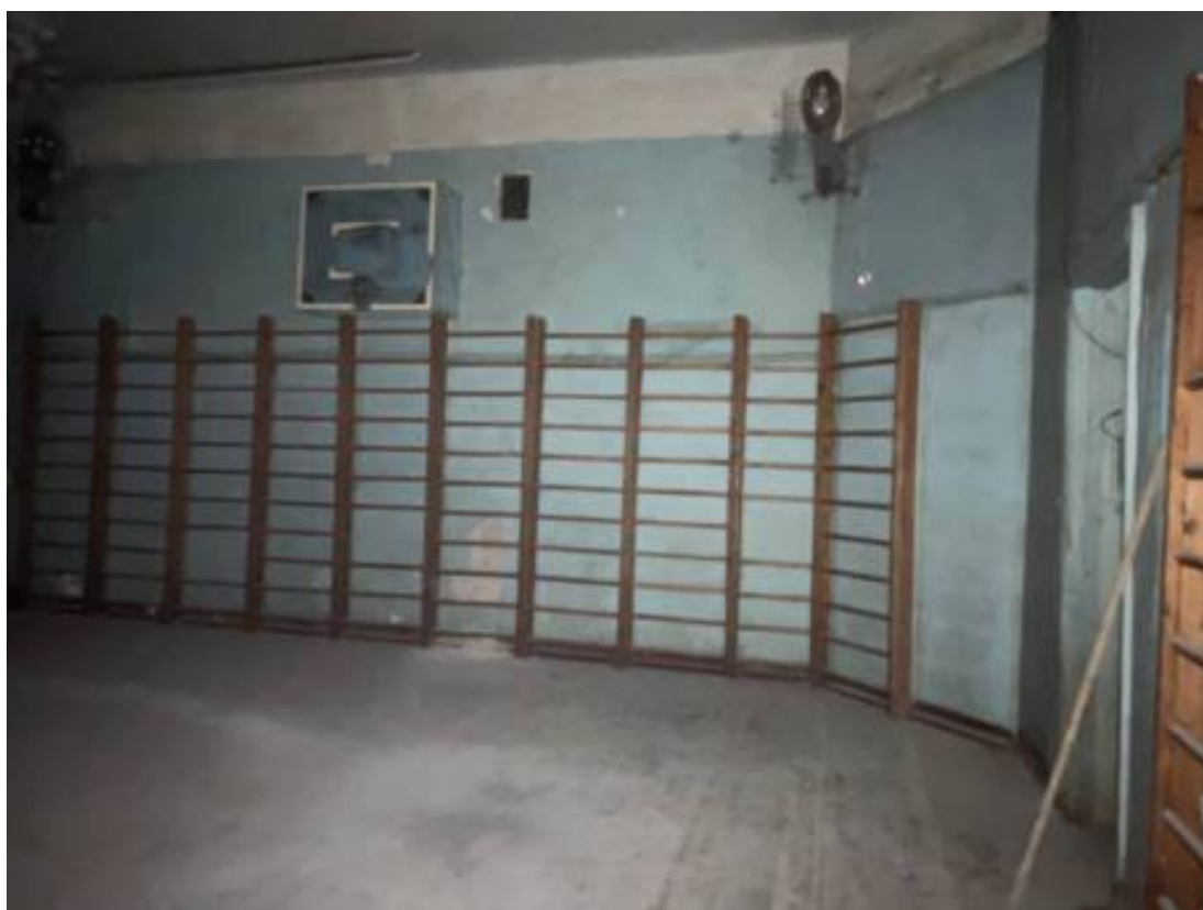
Фото 196. Интерьер пятого этажа объекта культурного наследия регионального значения «Дом Первого Российского страхового общества»
