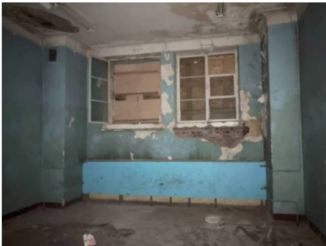
Фото 197. Интерьер пятого этажа объекта культурного наследия регионального значения «Дом Первого Российского страхового общества»
