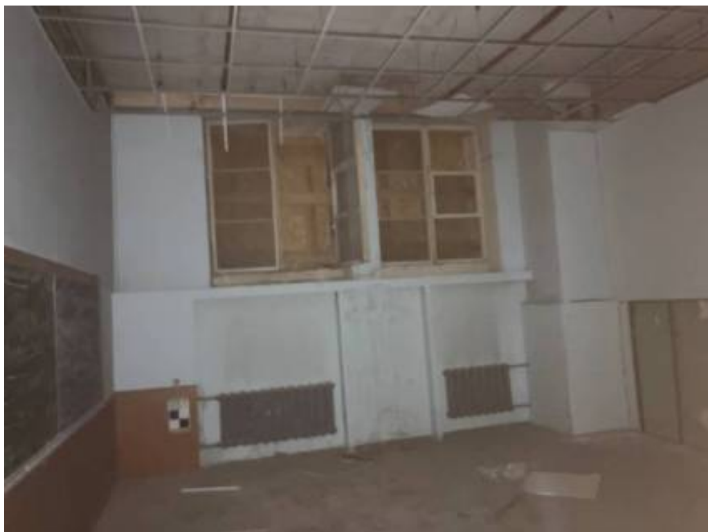
Фото 193. Интерьер пятого этажа объекта культурного наследия регионального значения «Дом Первого Российского страхового общества»
