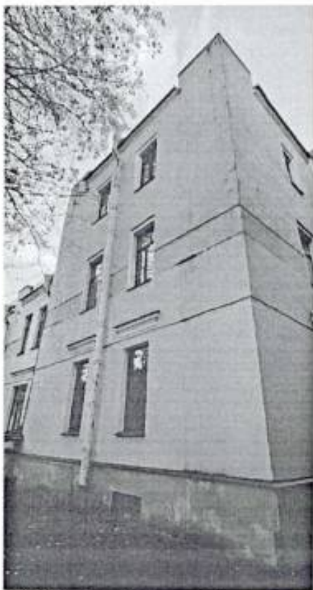
10. Северный фасад. Фрагмент.
