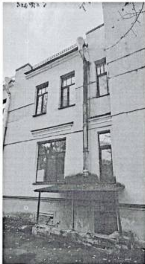
11. Северный фасад. Фрагмент.
