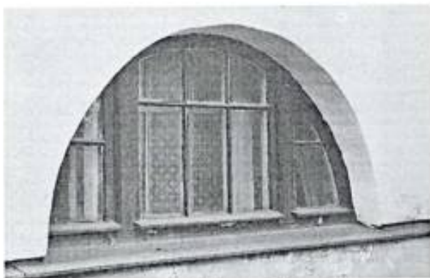
6. Восточный фасад. Фрагмент.
