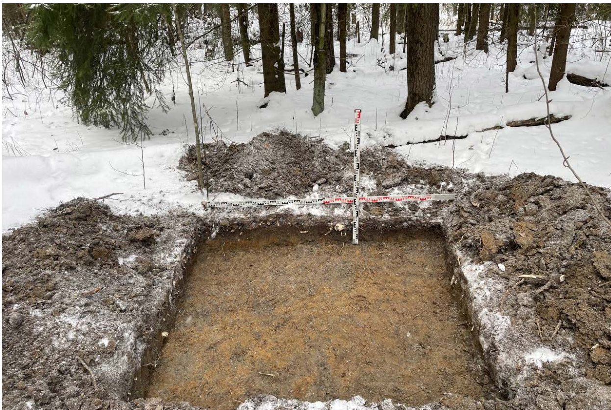
Рис. 20. СПБ-2026. Выборгский район. Земельный участок по объекту «Проектирование нового автобусного парка в производственной зоне «Каменка»». Шурф 1. Общий вид выкопанного шурфа. Вид с юга.
