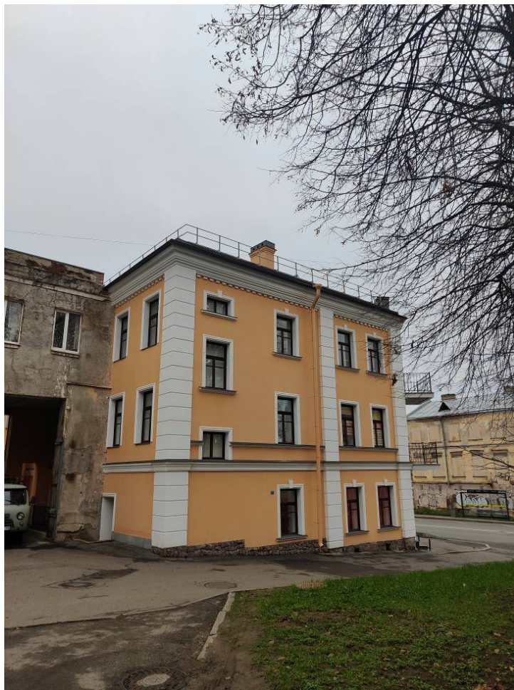
Фото 7 Фрагмент южного фасада и восточный фасад выявленного объекта культурного наследия «Жилой дом» расположенного по адресу: Санкт-Петербург, город Ломоносов, Дворцовый проспект, дом 14/9, литера А
