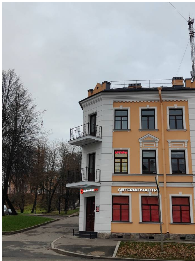
Фото 5 Фрагмент северного фасада выявленного объекта культурного наследия «Жилой дом» расположенного по адресу: Санкт-Петербург, город Ломоносов, Дворцовый проспект, дом 14/9, литера А
