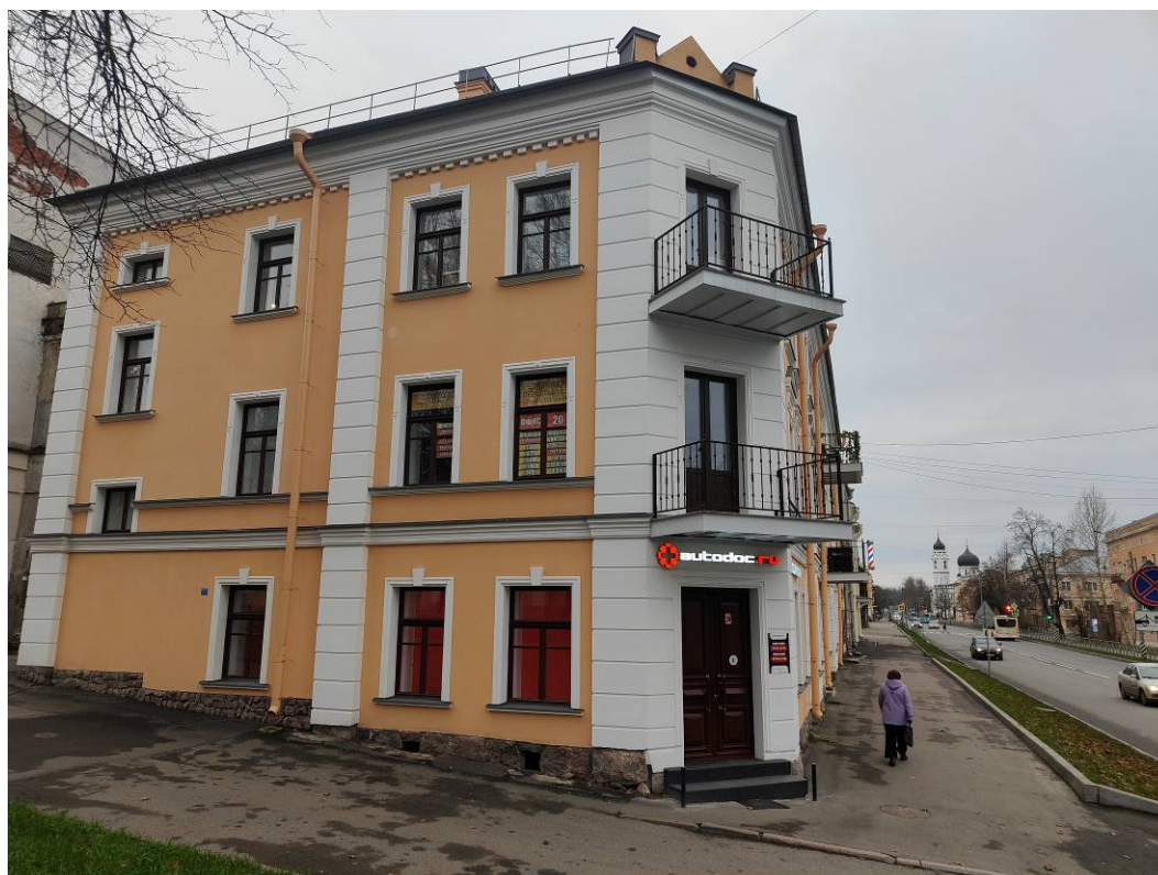
Фото 4 Фрагменты северного и восточного фасадов выявленного объекта культурного наследия «Жилой дом» расположенного по адресу: Санкт-Петербург, город Ломоносов, Дворцовый проспект, дом 14/9, литера А
