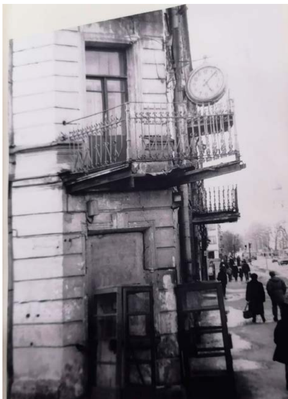
29. СПб., г. Ломоносов, Дворцовый пр., д.14/9 (пр. Юного Ленинца). Фрагмент углового фасада -1-ый и 2-ой этажи. Технический отчет. Инженерное обследование здания. Кн.1, Сбс «Стройбытсервис», 1993г. // Архив КГИОП, п-616-Г-6, пр.-138.
