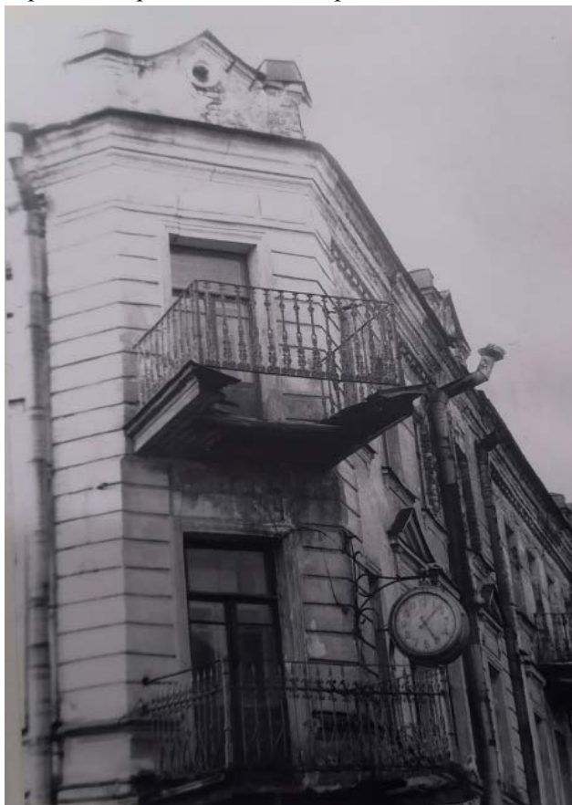
28. СПб., г. Ломоносов, Дворцовый пр., д.14/9 (пр. Юного Ленинца). Фрагмент углового фасада -2-ой и 3-ий этажи. Технический отчет. Инженерное обследование здания. Кн.1, Сбс «Стройбытсервис», 1993г.// Архив КГИОП, п-616-Г-6, пр.-138.
