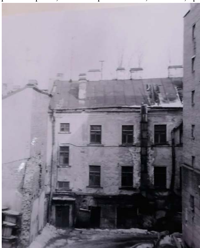
30. СПб., г. Ломоносов, Дворцовый пр., д.14/9 (пр. Юного Ленинца). Дворовый фасад. Технический отчет. Инженерное обследование здания. Кн.1, Сбс «Стройбытсервис», 1993г. // Архив КГИОП, п-616-Г-6, пр.-138.
