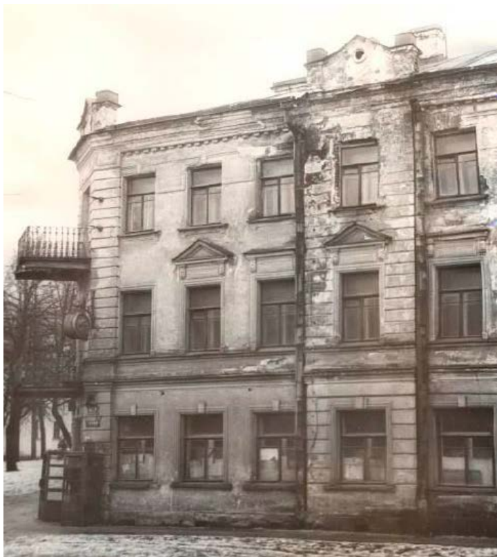
25. СПб., г. Ломоносов, Дворцовый пр., д.14/9 (пр. Юного Ленинца). Фрагмент лицевого фасада по Дворцовому проспекту (световые оси 1-5). Технический отчет. Инженерное обследование здания. Кн.1, Сбс «Стройбытсервис», 1993г. // Архив КГИОП, п-616-Г-6, пр.-138.
