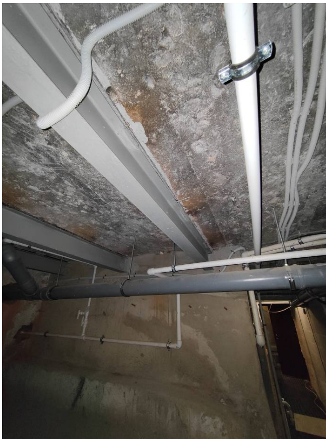
Фото 25 Интерьер выявленного объекта культурного наследия «Жилой дом» расположенного по адресу: Санкт-Петербург, город Ломоносов, Дворцовый проспект, дом 14/9, литера А (подвал)
