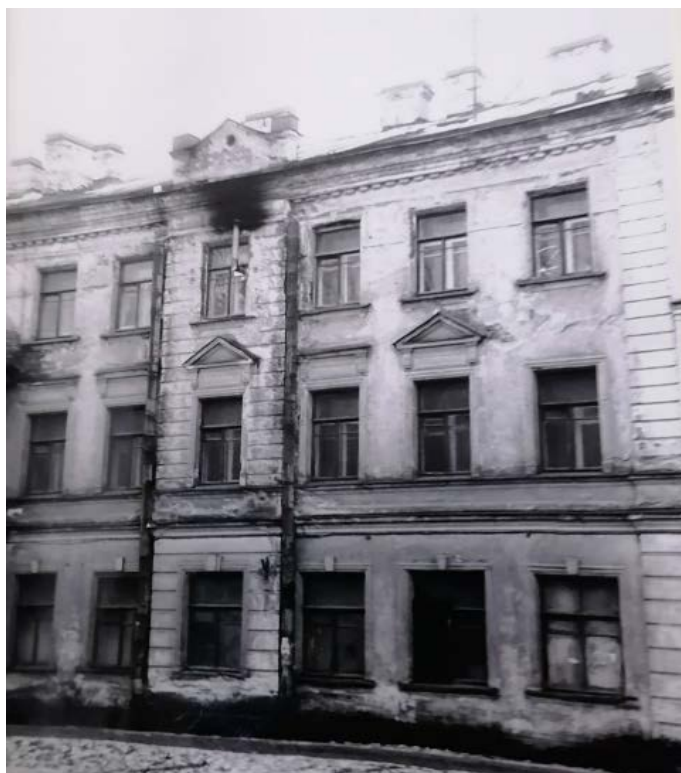
27. СПб., г. Ломоносов, Дворцовый пр., д.14/9 (пр. Юного Ленинца). Фрагмент лицевого фасада по Дворцовому проспекту (световые оси 8-13). Технический отчет. Инженерное обследование здания. Кн.1, Сбс «Стройбытсервис», 1993г. // Архив КГИОП, п-616-Г-6, пр.-138.
