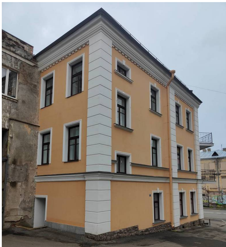
Фото 8 Фрагмент южного фасада и восточный фасад выявленного объекта культурного наследия «Жилой дом» расположенного по адресу: Санкт-Петербург, город Ломоносов, Дворцовый проспект, дом 14/9, литера А
