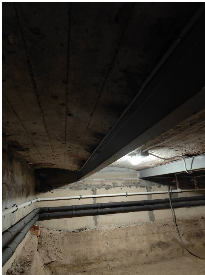
Фото 26 Интерьер выявленного объекта культурного наследия «Жилой дом» расположенного по адресу: Санкт-Петербург, город Ломоносов, Дворцовый проспект, дом 14/9, литера А (подвал)
