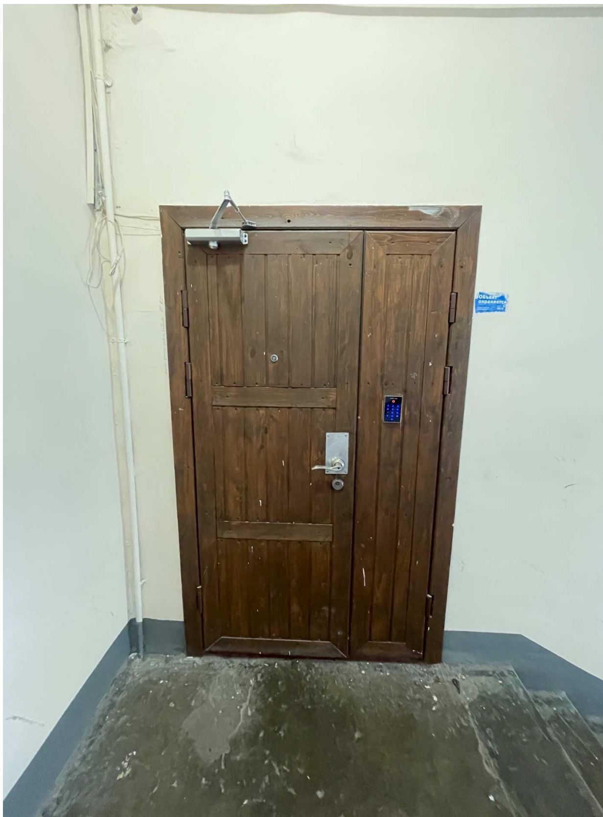
3. Входная дверь в квартиру №9.
