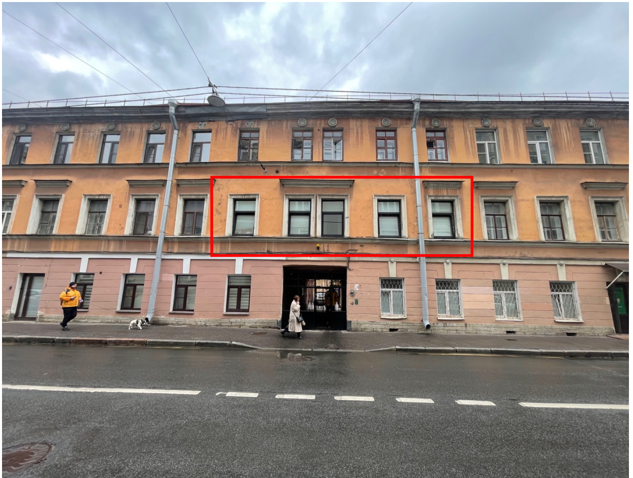
1. Вид на лицевой фасад. Красной линией отмечены оконные проемы квартиры №9.
