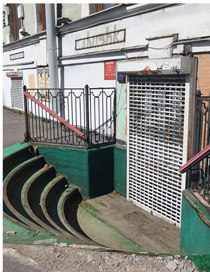
5. Юго- восточный лицевой фасад объекта культурного наследия регионального значения «Дом Ф.А. Голицына (Э. Паннаша)», расположенный по адресу: г. Санкт-Петербург, 16-я линия В.О., д. 1/33, литера А. Фрагмент. 27.05.2026
