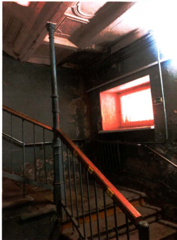
13. Лестница лицевого корпуса объекта культурного наследия. Фото выполнено 18.07.2024
