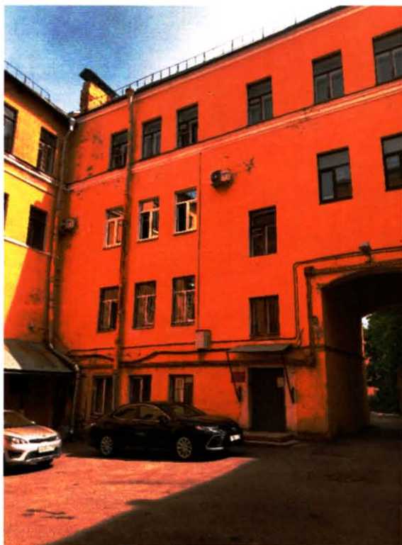
10. Фрагмент восточного дворового фасада объекта культурного наследия. Фото выполнено 18.07.2024
