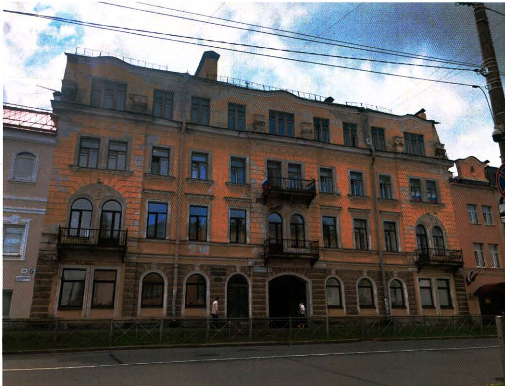
1. Северный фасад объекта культурного наследия. Фото выполнено 18.07.2024.
