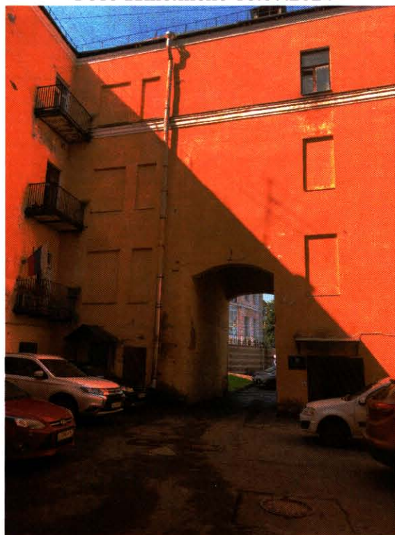
8. Фрагмент западного дворового фасада объекта культурного наследия. Фото выполнено 16.08.2024
