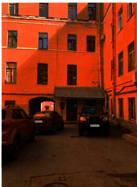
7. Фрагмент северного дворового фасада объекта культурного наследия. Фото выполнено 16.08.2024
