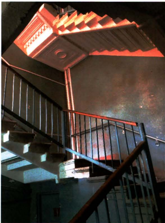
12. Лестница лицевого корпуса объекта культурного наследия. Фото выполнено 18.07.2024
