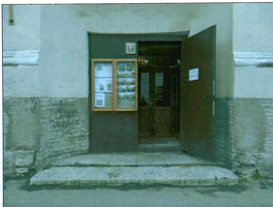
4. Северный фасад. Крыльцо.
