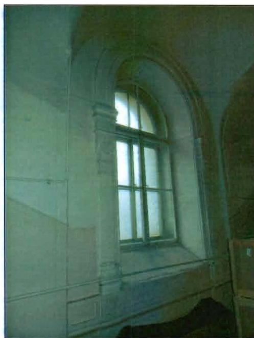
7. Центральный оконный проем парадной лестницы.
