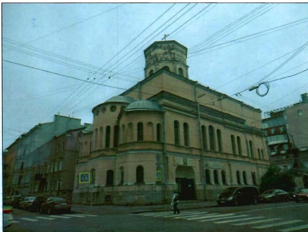
1. Общий вид с северо-востока.
