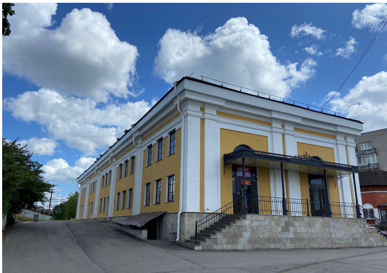
1. Общий вид на здание с Привокзальной площади.
