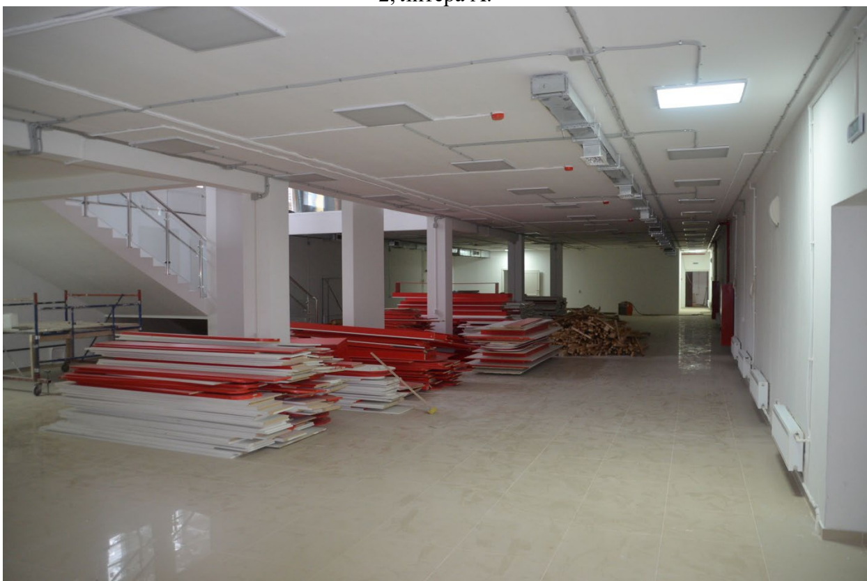
12. Общий вид подвального этажа выявленного объекта культурного наследия «Жилой дом», расположенного по адресу: Санкт-Петербург, г. Ломоносов, Кронштадтская ул., д. 2, литера А.
