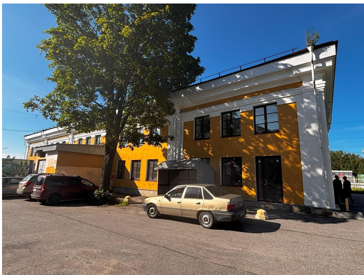
4. Южный фасад здания.
