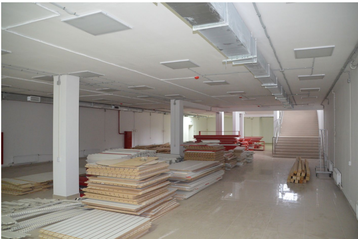
11. Общий вид подвального этажа выявленного объекта культурного наследия «Жилой дом», расположенного по адресу: Санкт-Петербург, г. Ломоносов, Кронштадтская ул., д. 2, литера А.
