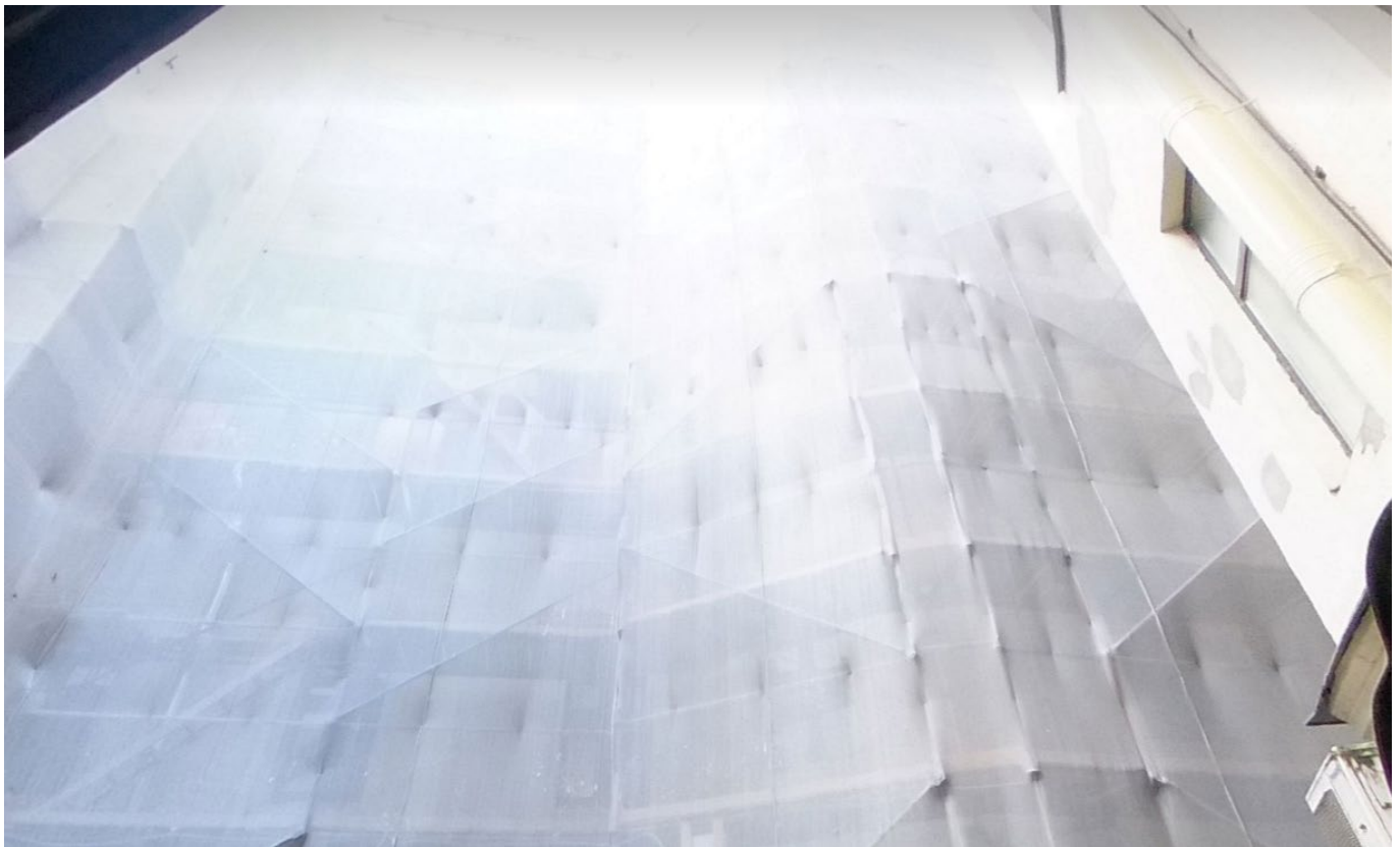
Фото 5. Фрагмент дворового фасада
