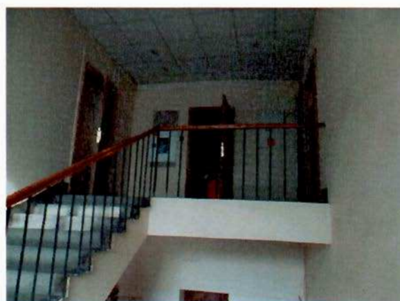
23. Лестничная клетка 4Н (36)
