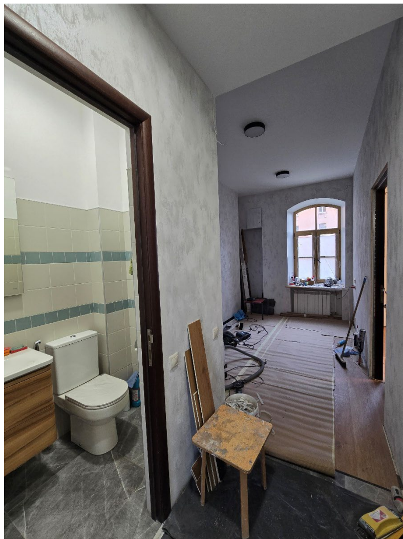
Фото 13. «Жилой дом Азовско-Донского коммерческого банка (с курдонером)», Санкт-Петербург, улица Профессора Попова, дом 41/5, литера А. Помещение 2-Н, уборная и кабинеты на втором уровне.
