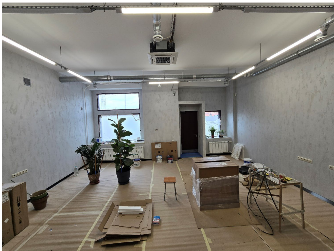
Фото 9. «Жилой дом Азовско-Донского коммерческого банка (с курдонером)», Санкт-Петербург, улица Профессора Попова, дом 41/5, литера А. Помещение 2-Н, вход в помещение со стороны лицевого фасада по улице Профессора Попова, кабинет (пом. 3 согласно проекту).
