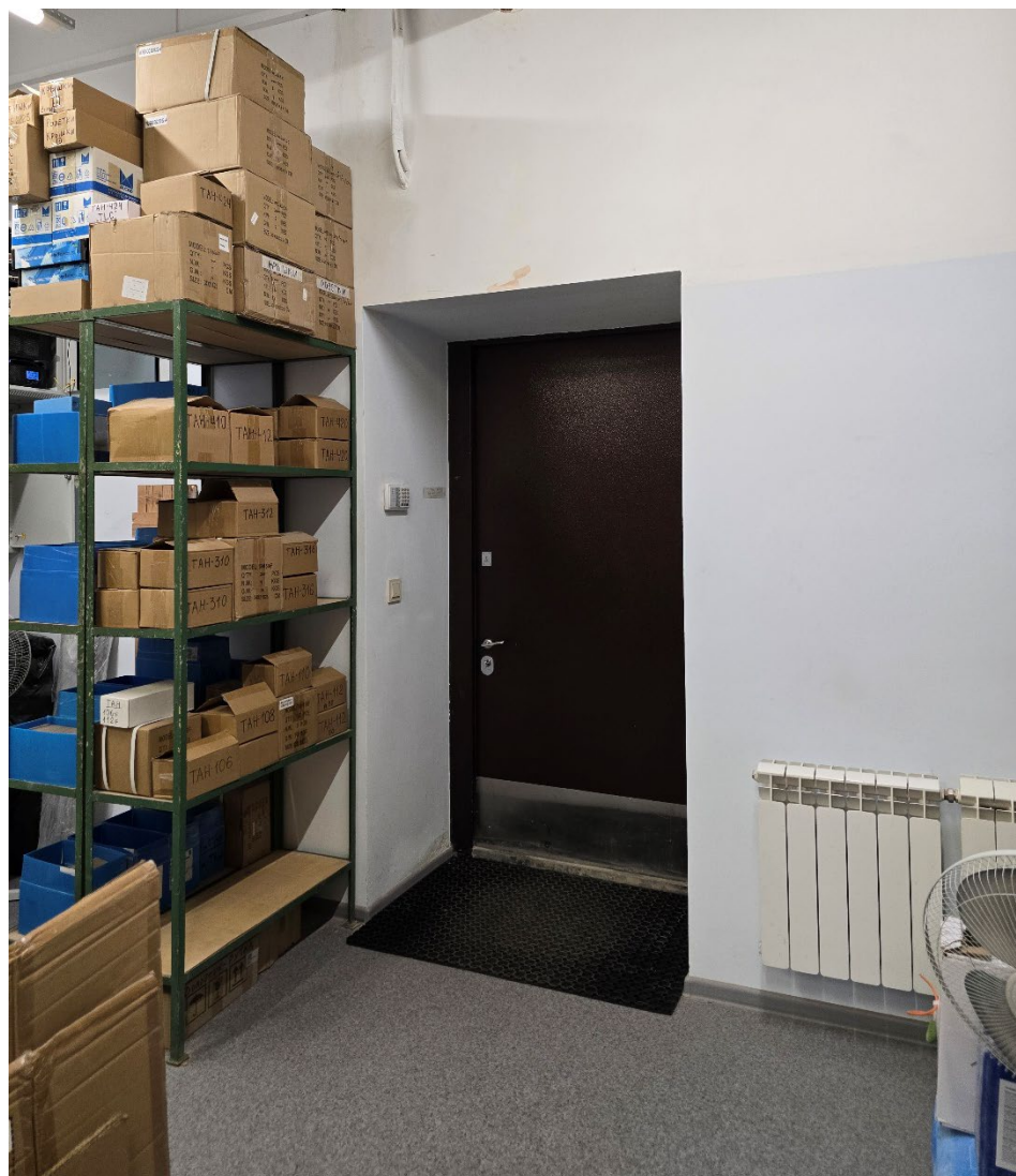
Фото 7. «Жилой дом Азовско-Донского коммерческого банка (с курдонером)», Санкт-Петербург, улица Профессора Попова, дом 41/5, литера А. Помещение 2-Н, эвакуационный выход во двор.
