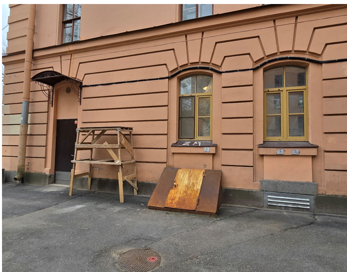
Фото 4. «Жилой дом Азовско-Донского коммерческого банка (с курдонером)», расположенного по адресу: г. Санкт-Петербург, улица Профессора Попова, дом 41/5, литера А. Фрагмент дворового фасада 1 этажа лицевого корпуса (северного), вход и два окна помещения 2-Н.
