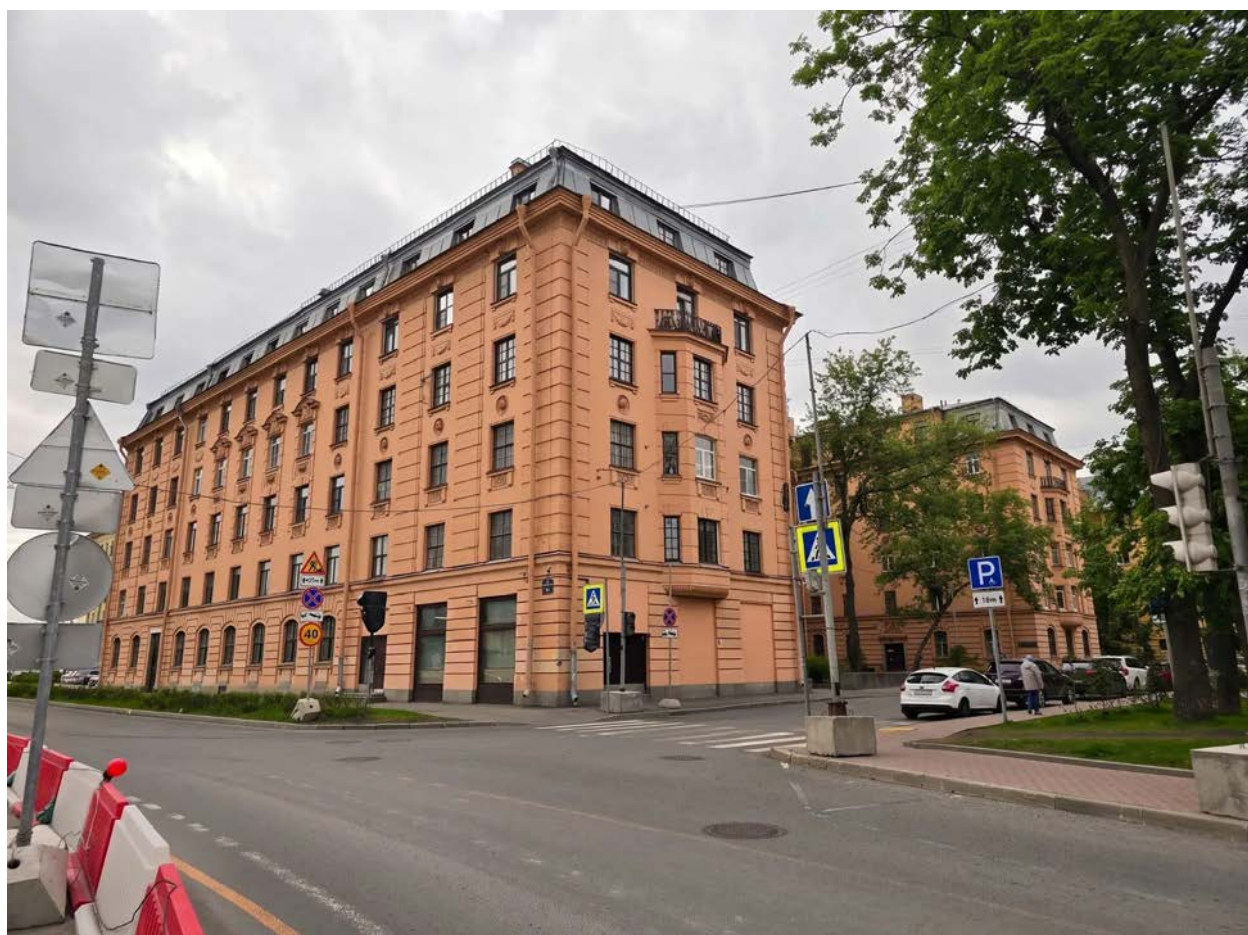
Фото 1. «Жилой дом Азовско-Донского коммерческого банка (с курдонером)», Санкт-Петербург, улица Профессора Попова, дом 41/5, литера А. Общий вид дома на пересечении улиц Профессора Попова и Грота.
