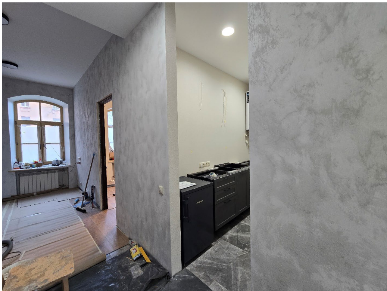
Фото 11. «Жилой дом Азовско-Донского коммерческого банка (с курдонером)», Санкт-Петербург, улица Профессора Попова, дом 41/5, литера А. Помещение 2-Н, кабинеты и хозяйственная комната на втором уровне (пом. 5, 7, 8 согласно проекту).
