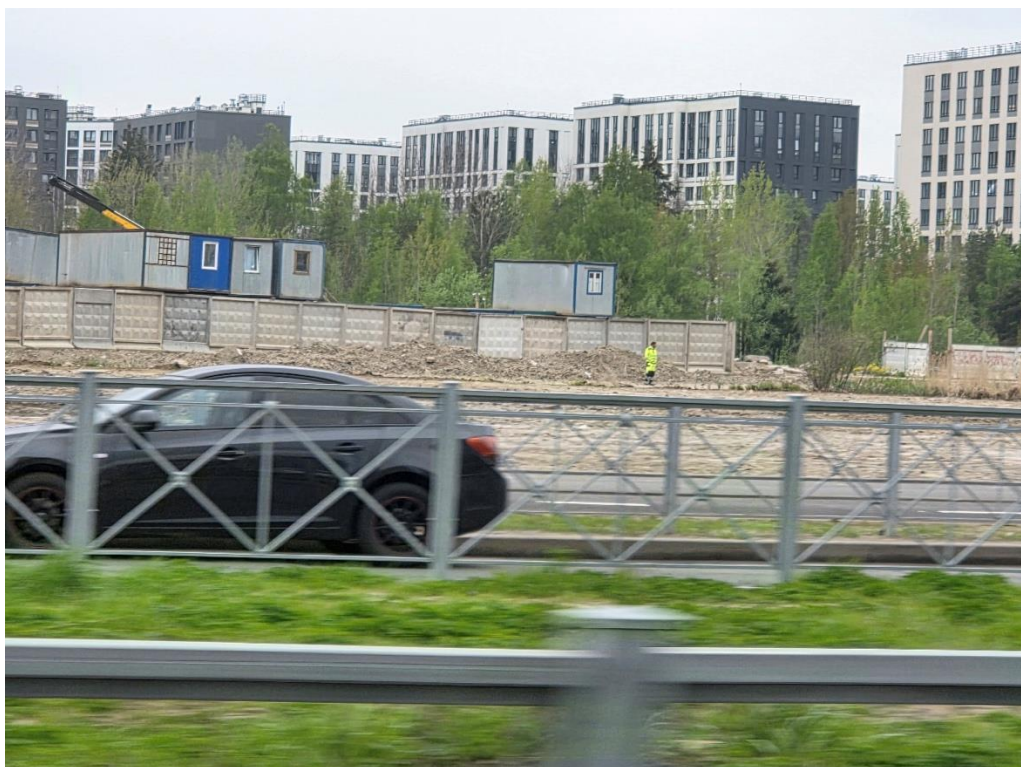
Рис. 12. СПб-2026. Приморский район. Выполнение проектно-изыскательских работ по строительству канализационного коллектора по продолжению пр. Авиаконструкторов от дороги на «Каменку» до Плесецкой ул. Общий вид участка обследования. Точка фотофиксации 2. Вид с востока.
