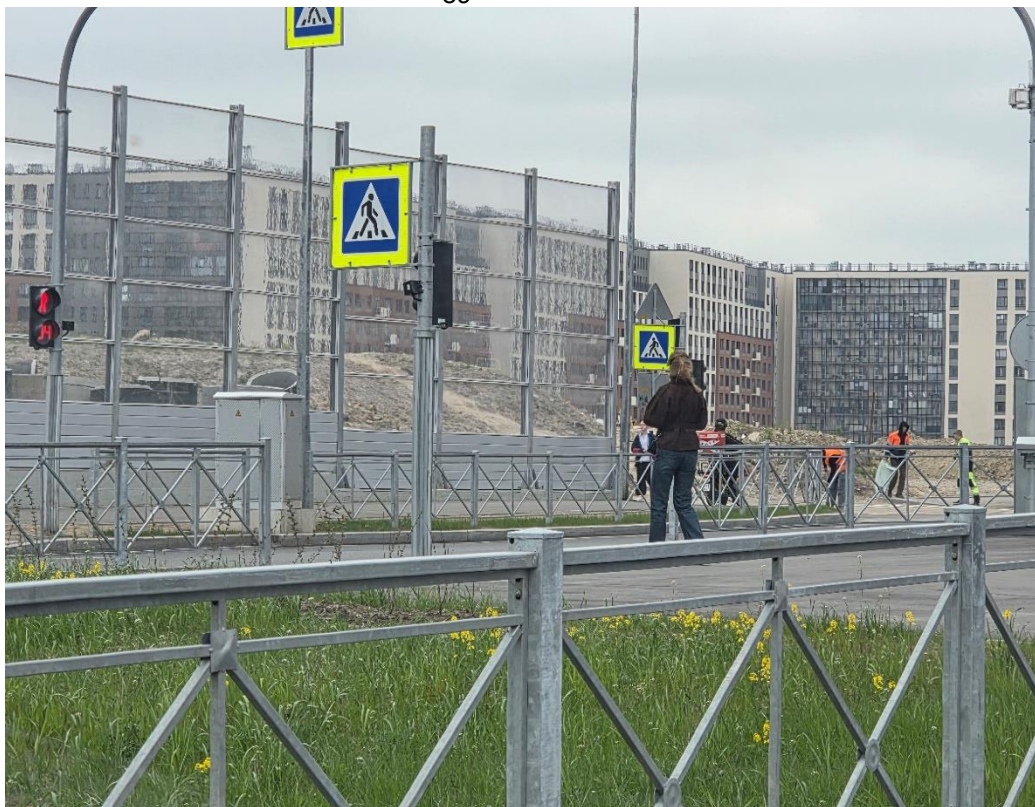
Рис. 11. СПб-2026. Приморский район. Выполнение проектно-изыскательских работ по строительству канализационного коллектора по продолжению пр. Авиаконструкторов от дороги на «Каменку» до Плесецкой ул. Общий вид участка обследования. Точка фотофиксации 1. Вид с запада.
