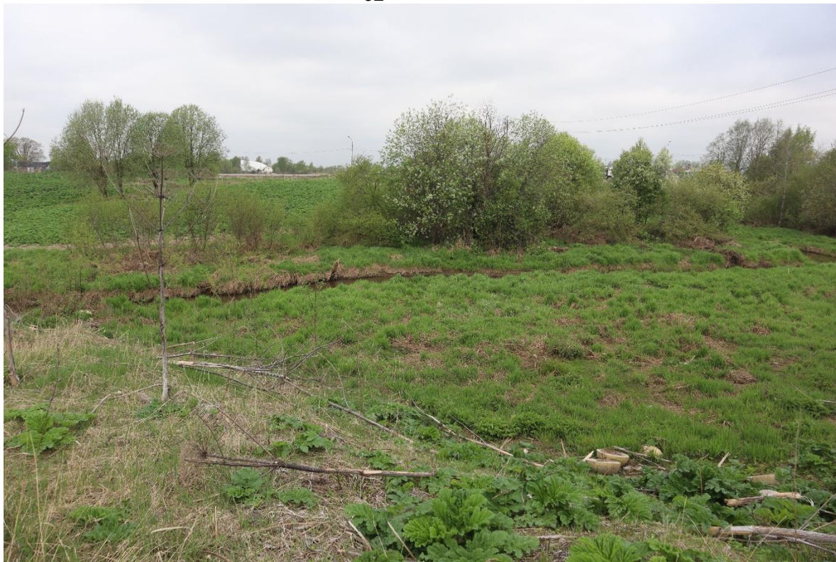
Рис. 17. СПб-2026. Приморский район. Выполнение проектно-изыскательских работ по строительству канализационного коллектора по продолжению пр. Авиаконструкторов от дороги на «Каменку» до Плесецкой ул. Общий вид участка обследования. Точка фотофиксации 7. Вид с востока.
