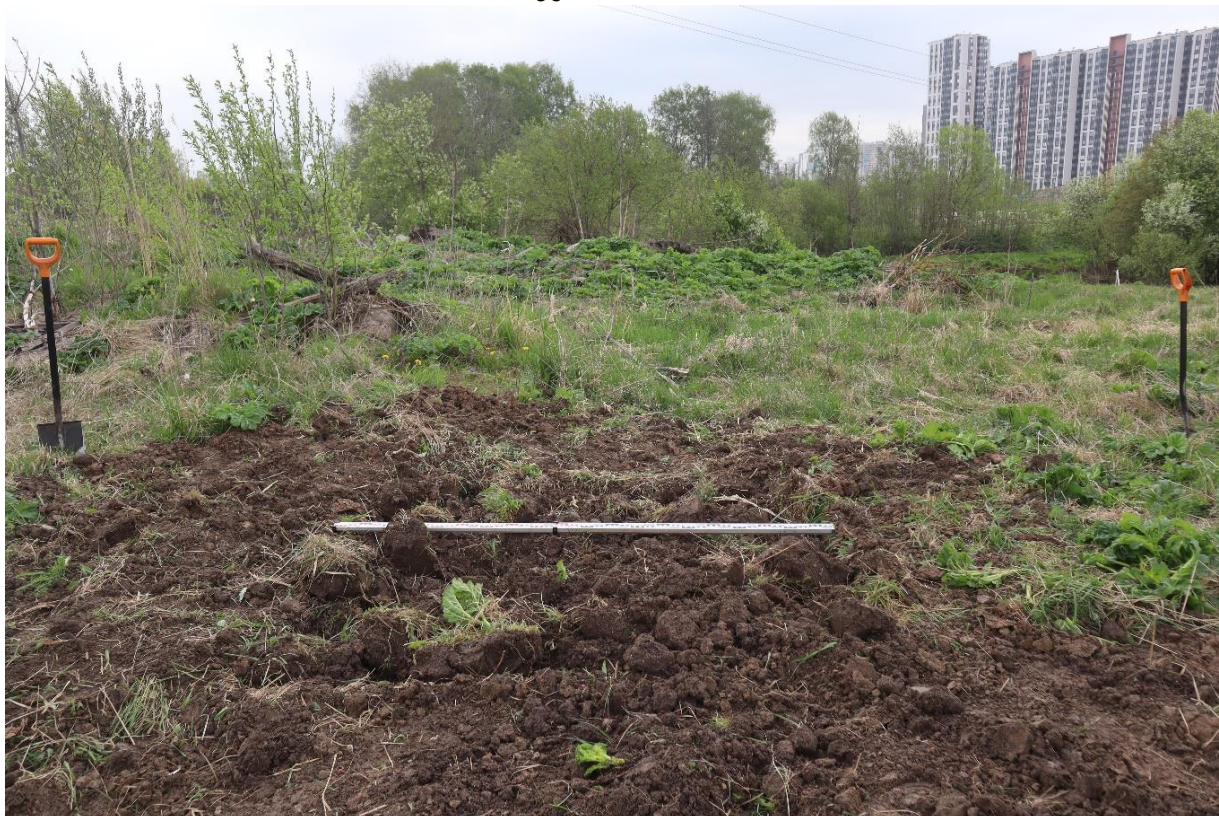
Рис. 25. СПб-2026. Приморский район. Выполнение проектно-изыскательских работ по строительству канализационного коллектора по продолжению пр. Авиаконструкторов от дороги на «Каменку» до Плесецкой ул. Шурф 1. Рекультивация. Вид с востока.
