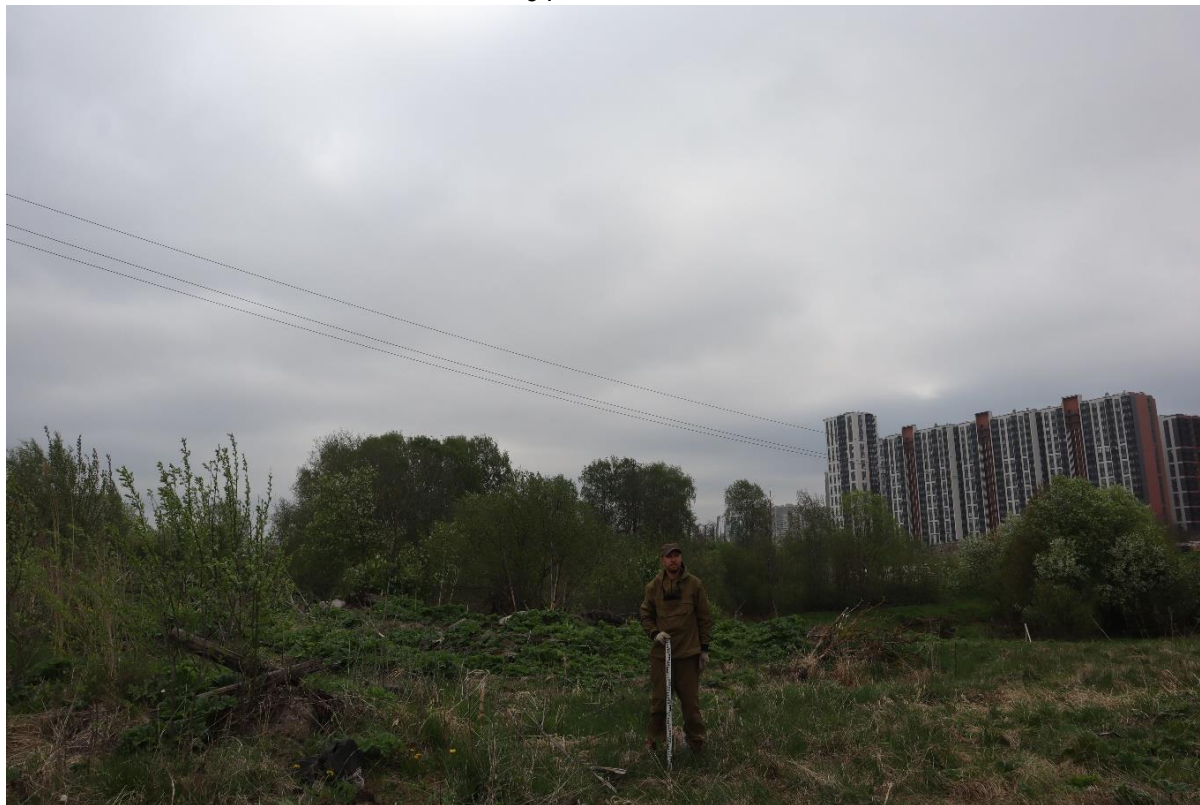
Рис. 21. СПб-2026. Приморский район. Выполнение проектно-изыскательских работ по строительству канализационного коллектора по продолжению пр. Авиаконструкторов от дороги на «Каменку» до Плесецкой ул. Шурф 1. Общий вид до начала работ. Вид с востока.
