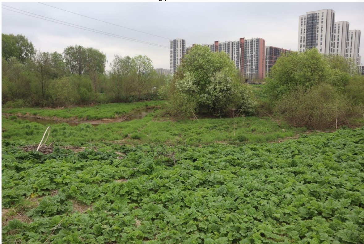
Рис. 15. СПб-2026. Приморский район. Выполнение проектно-изыскательских работ по строительству канализационного коллектора по продолжению пр. Авиаконструкторов от дороги на «Каменку» до Плесецкой ул. Общий вид участка обследования. Точка фотофиксации 5. Вид с востока.
