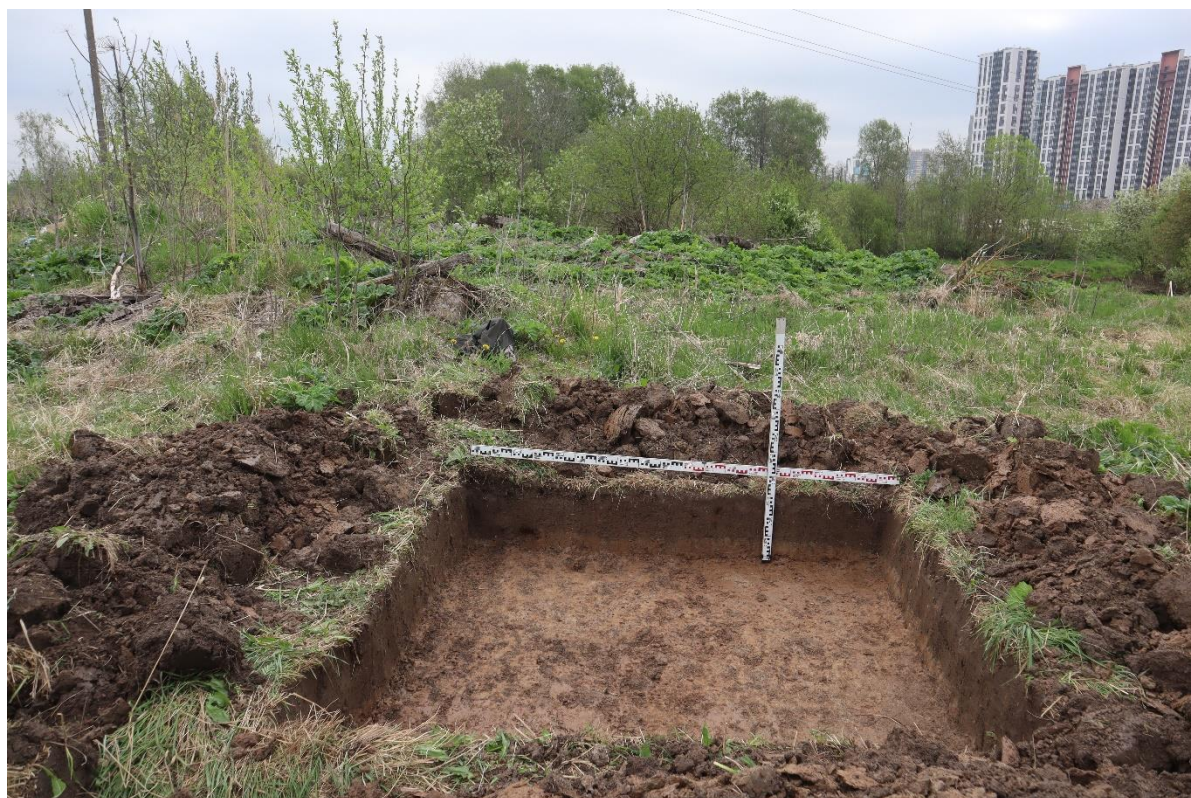
Рис. 22. СПб-2026. Приморский район. Выполнение проектно-изыскательских работ по строительству канализационного коллектора по продолжению пр. Авиаконструкторов от дороги на «Каменку» до Плесецкой ул. Шурф 1. Общий вид по окончанию работ. Вид с востока.
