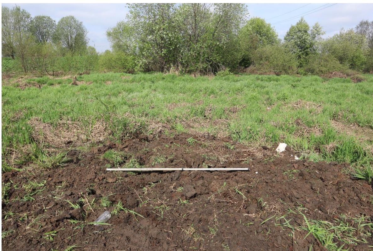
Рис. 30. СПб-2026. Приморский район. Выполнение проектно-изыскательских работ по строительству канализационного коллектора по продолжению пр. Авиаконструкторов от дороги на «Каменку» до Плесецкой ул. Шурф 2. Рекультивация. Вид с востока.
