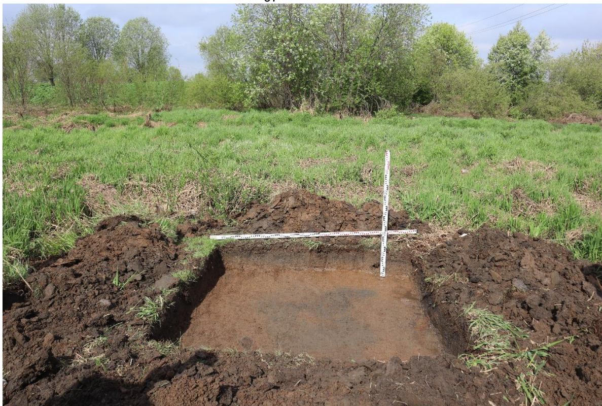
Рис. 27. СПб-2026. Приморский район. Выполнение проектно-изыскательских работ по строительству канализационного коллектора по продолжению пр. Авиаконструкторов от дороги на «Каменку» до Плесецкой ул. Шурф 2. Общий вид по окончанию работ. Вид с востока.
