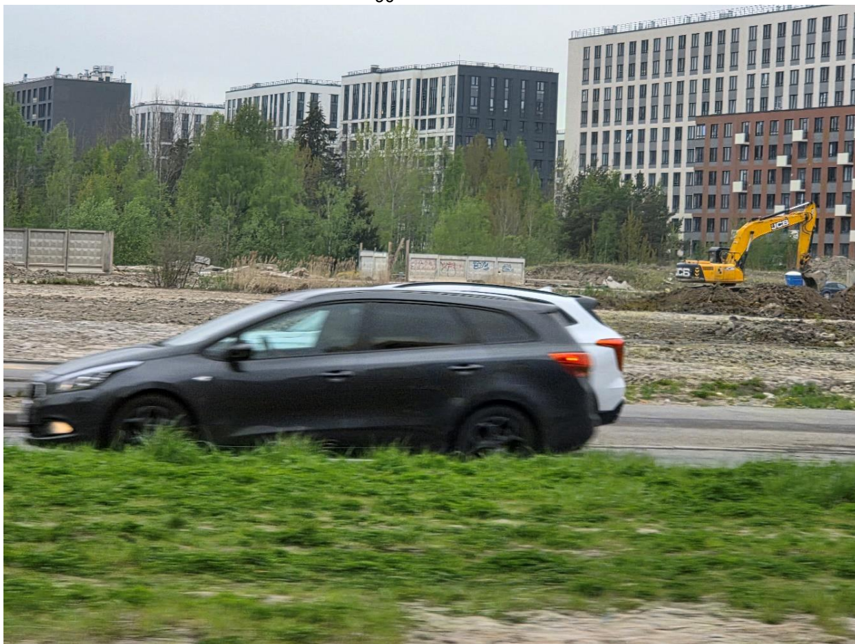
Рис. 13. СПб-2026. Приморский район. Выполнение проектно-изыскательских работ по строительству канализационного коллектора по продолжению пр. Авиаконструкторов от дороги на «Каменку» до Плесецкой ул. Общий вид участка обследования. Точка фотофиксации 3. Вид с востока.
