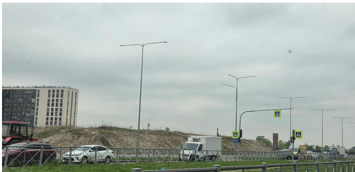
Рис. 14. СПб-2026. Приморский район. Выполнение проектно-изыскательских работ по строительству канализационного коллектора по продолжению пр. Авиаконструкторов от дороги на «Каменку» до Плесецкой ул. Общий вид участка обследования. Точка фотофиксации 4. Вид с запада.
