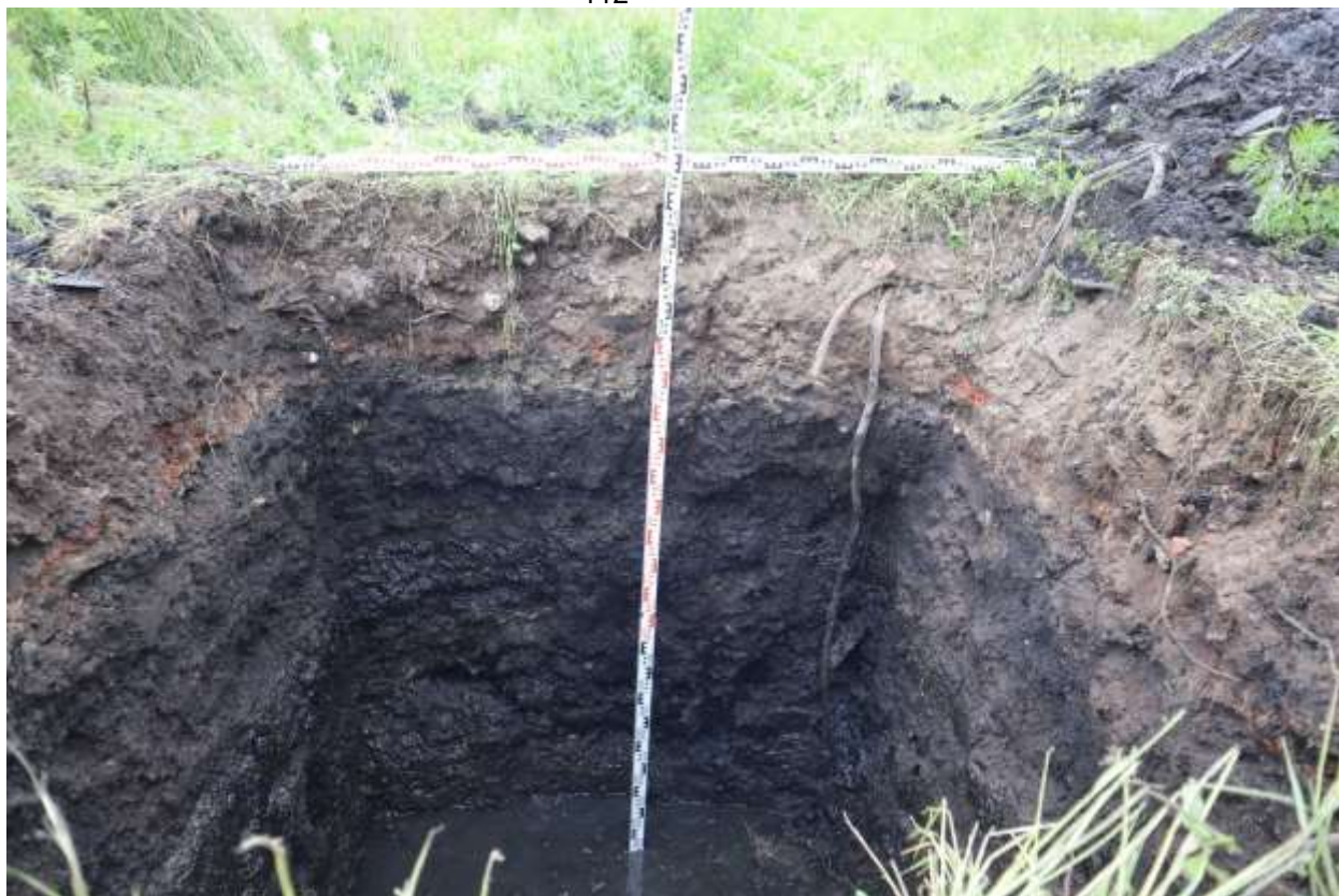
Рис. 28. СПб-2026. Адмиралтейский район, Малая Митрофаньевская ул., дом 9. Шурф 1. Северная стенка. Вид с Ю
