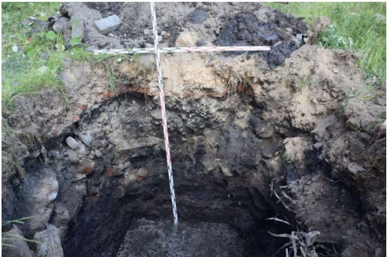
Рис. 38. СПб-2026. Адмиралтейский район, Малая Митрофаньевская ул., дом 9. Шурф 2. Южная стенка. Вид с С
