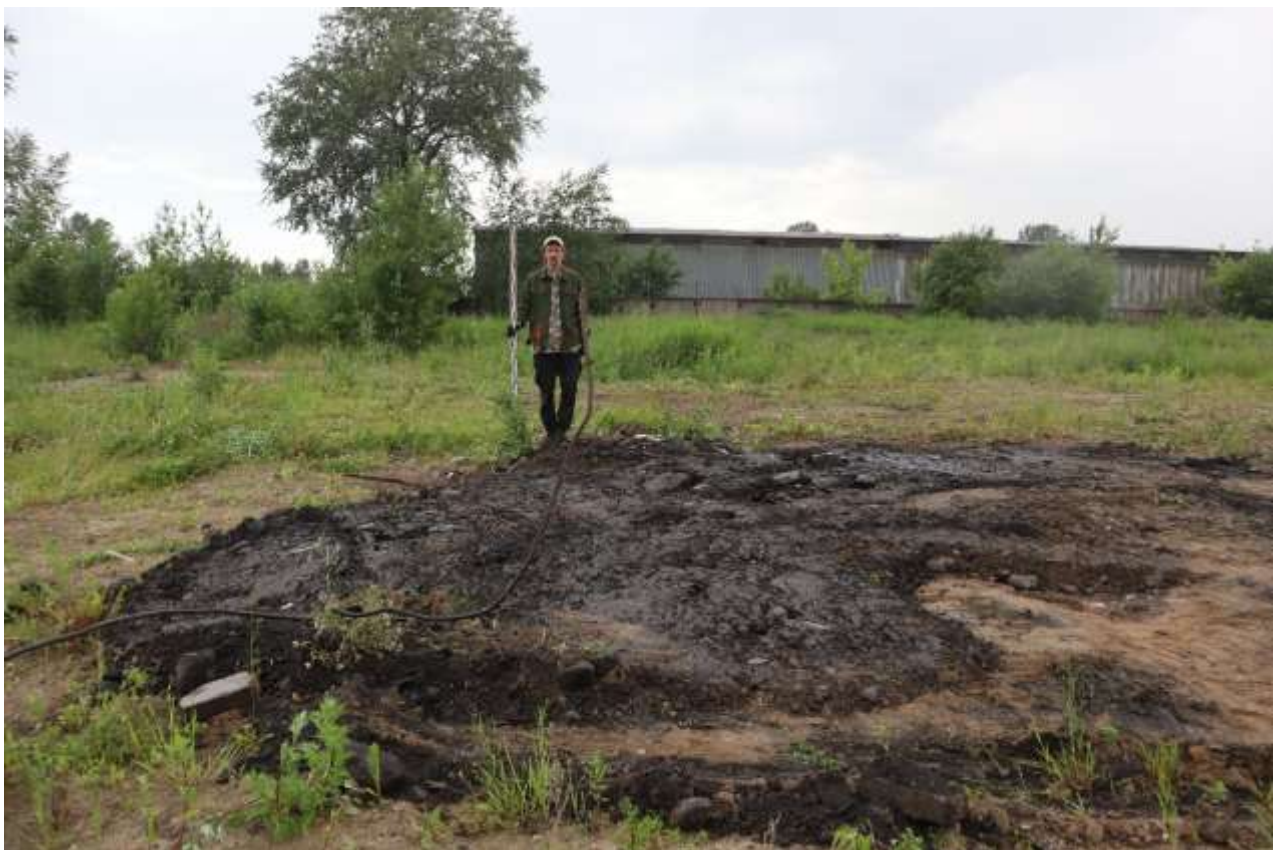
Рис. 47. СПб-2026. Адмиралтейский район, Малая Митрофаньевская ул., дом 9. Шурф 3. Рекультивация. Вид с Ю
