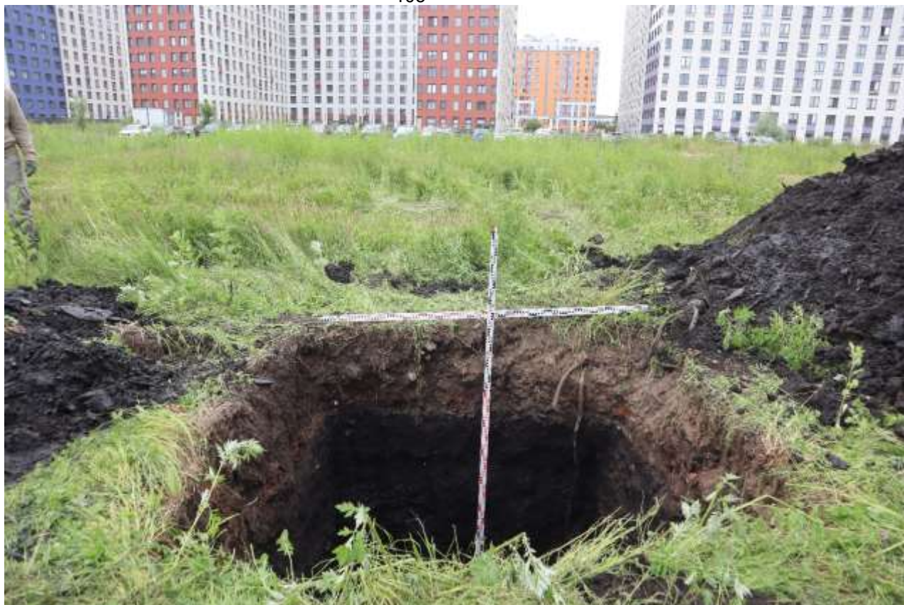
Рис. 20. СПб-2026. Адмиралтейский район, Малая Митрофаньевская ул., дом 9. Шурф 1 Фиксация материка. Вид с В
