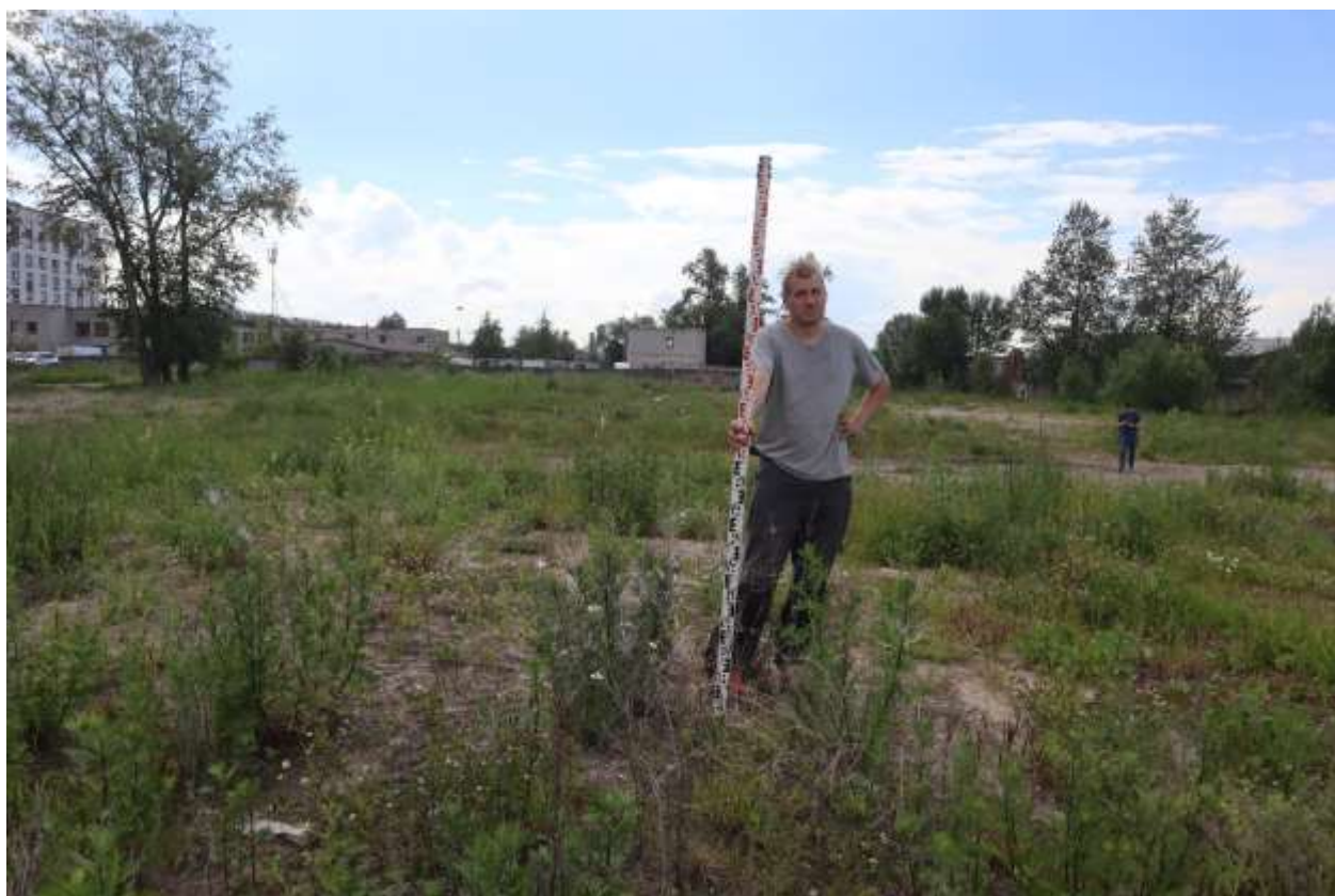
Рис. 41. СПб-2026. Адмиралтейский район, Малая Митрофаньевская ул., дом 9. Шурф 1. Общий вид участка обследования до начала работ. Вид с З
