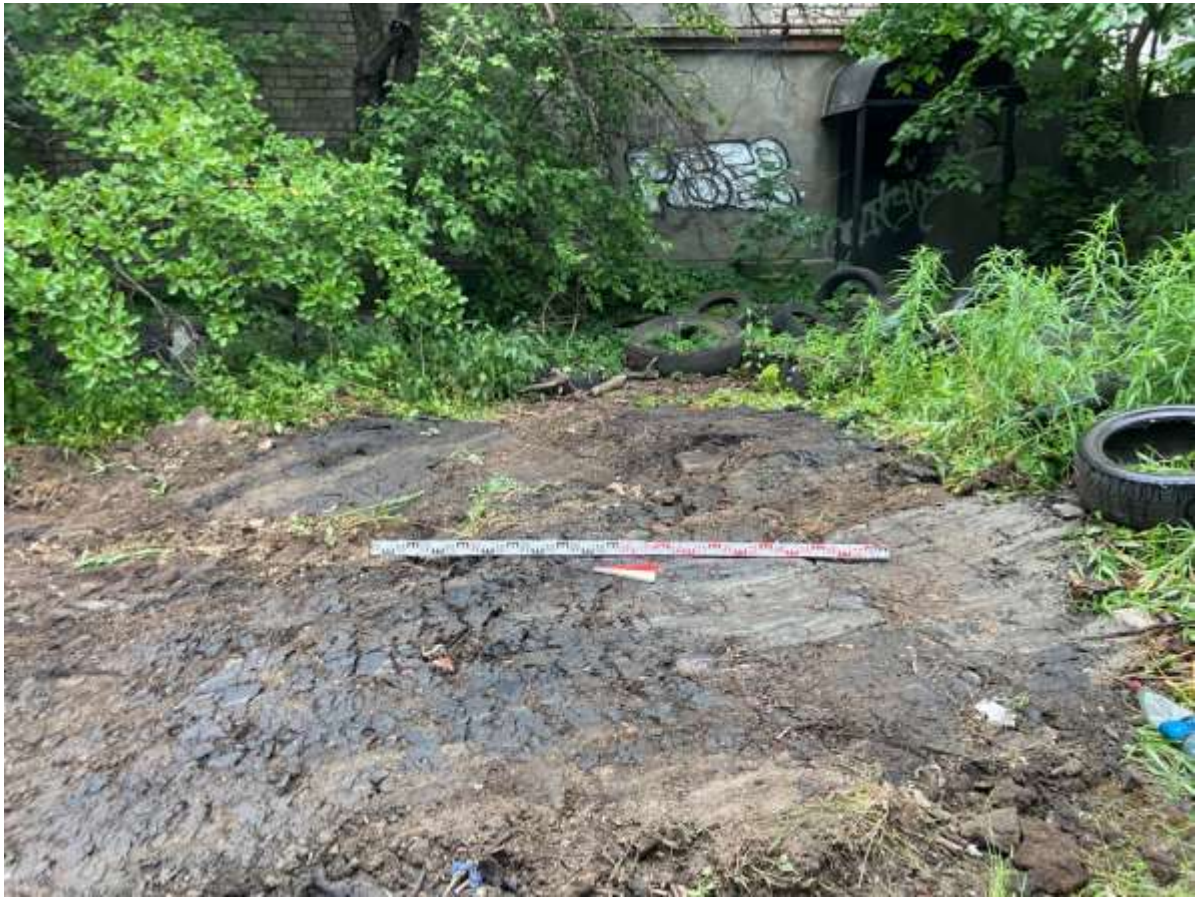
Рис. 56. СПб, Внутригородское муниципальное образование города федерального значения Санкт-Петербурга, муниципальный округ Измайловское, набережная Обводного канала, кад. номер 78:32:0750101:3319. Шурф 2. Рекультивация. Вид с юга.
