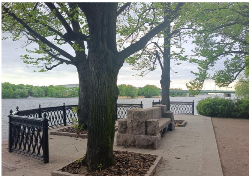
Фото 3. Вид на сооружение пристань с оградой, зеленые насаждения на территории ОКН. Объект культурного наследия регионального значения «Пристань с оградой».
