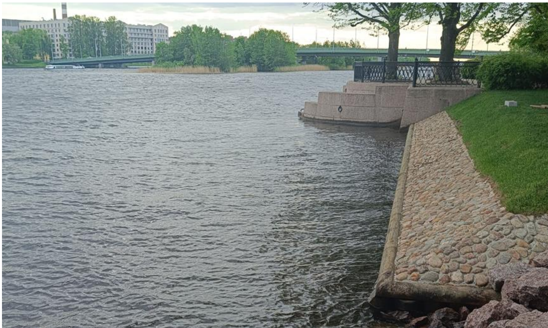
Фото 4. Вид на деревянное берегоукрепление и одернованный откос, зеленые насаждения, сооружение пристань с оградой на территории ОКН. Объекты культурного наследия регионального значения «Парк с гидротехническими сооружениями, двумя прудами и фрагментами ограды» и «Пристань с оградой» (Санкт-Петербург, Крестовский остров; Крестовский пр., 20, 22, 34), входящие в состав объекта культурного наследия регионального значения «Усадьба Белосельских-Белозерских» (Санкт-Петербург, Крестовский остров; Крестовский пр., 20, 22, 34).
