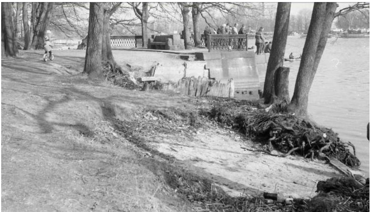
Илл. 17. В парке Белосельских-Белозерских на Крестовском острове. (берег рядом с пристанью укреплен шпунтовой стенкой, установленной в 1960-х гг.) Фотография Волкова А.С. 1988 г. (Детский сектор). – Интернет-источник: https://pastvu.com/p/122917
