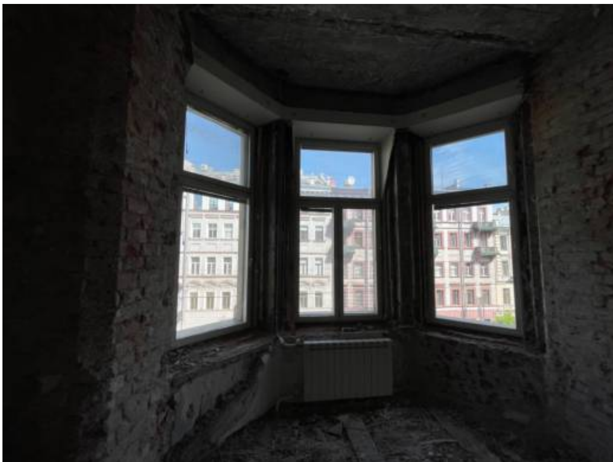
18. Помещение квартиры после демонтажа перегородок. Эркер со стороны лицевого фасада.
