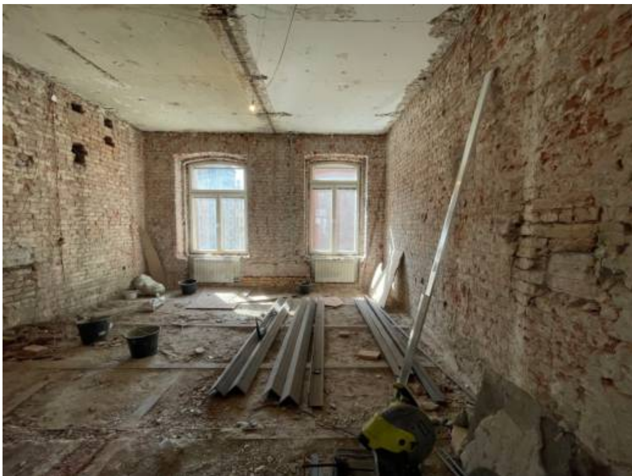
20. Помещение квартиры после демонтажа перегородок.
