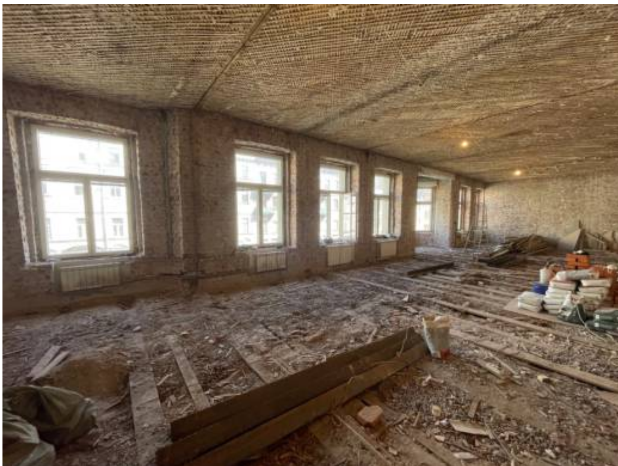
13. Помещение квартиры после демонтажа перегородок.
