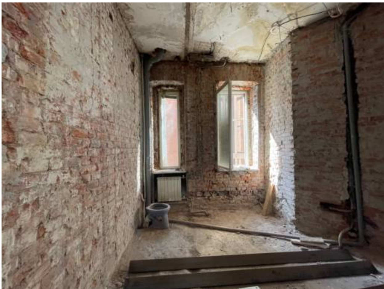
24. Помещение квартиры после демонтажа перегородок.
