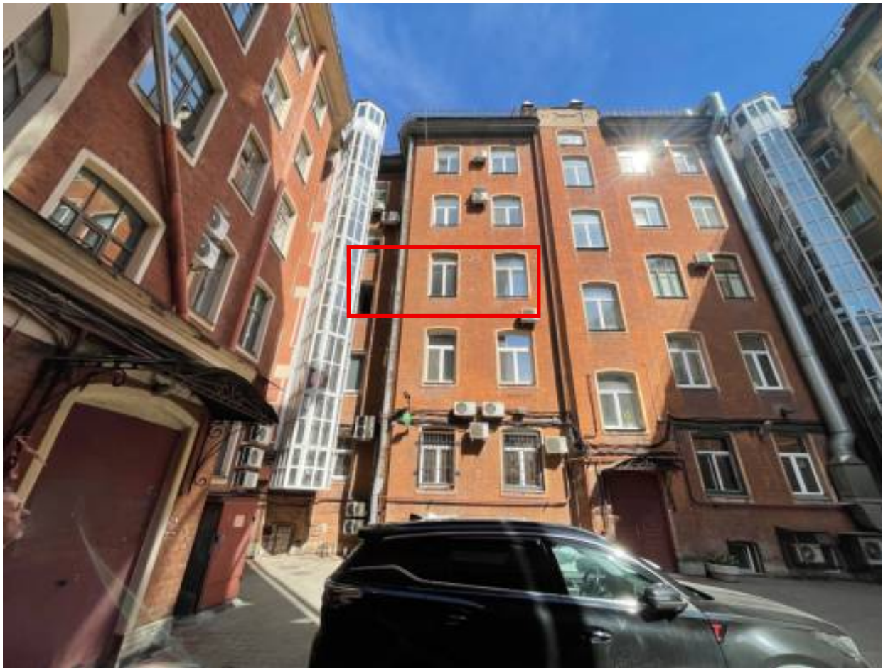
3. Дворовый фасад. Красной линией отмечены оконные проемы квартиры.
