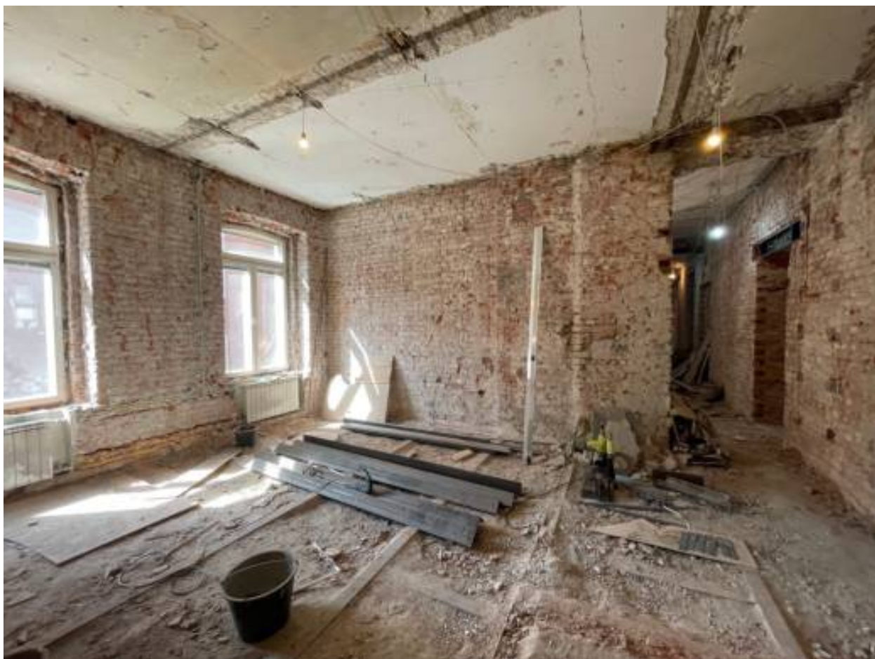
22. Помещение квартиры после демонтажа перегородок.
