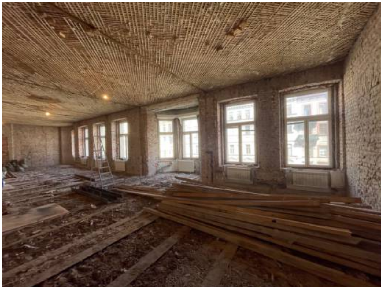
19. Помещение квартиры после демонтажа перегородок.
