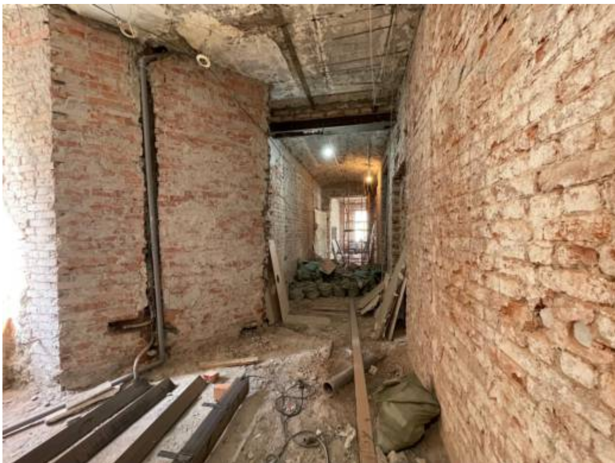
25. Помещение квартиры после демонтажа перегородок.
