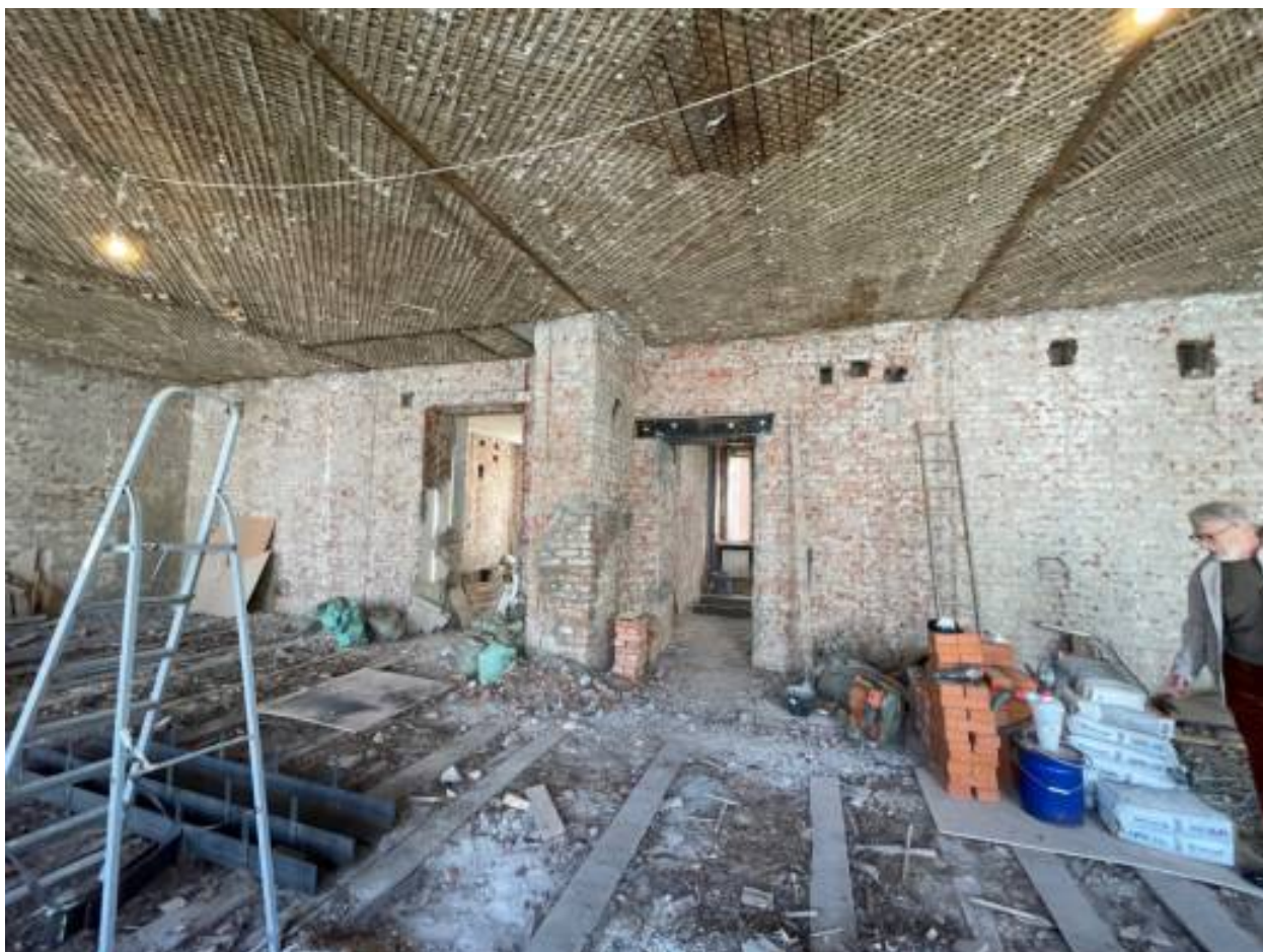
17. Помещение квартиры после демонтажа перегородок.
