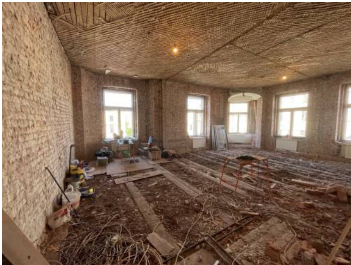
7. Помещение квартиры после демонтажа перегородок.
