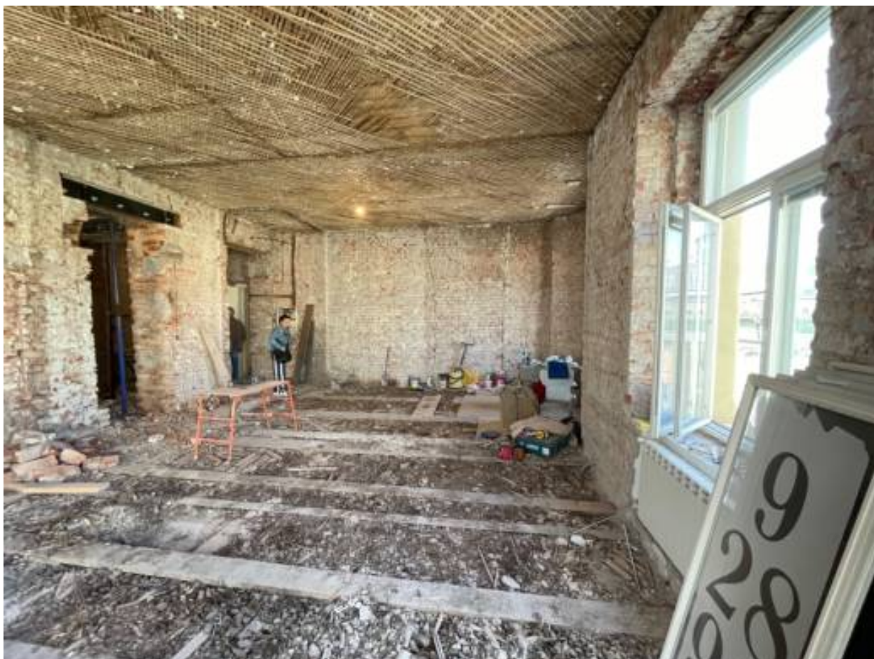
12. Помещение квартиры после демонтажа перегородок.
