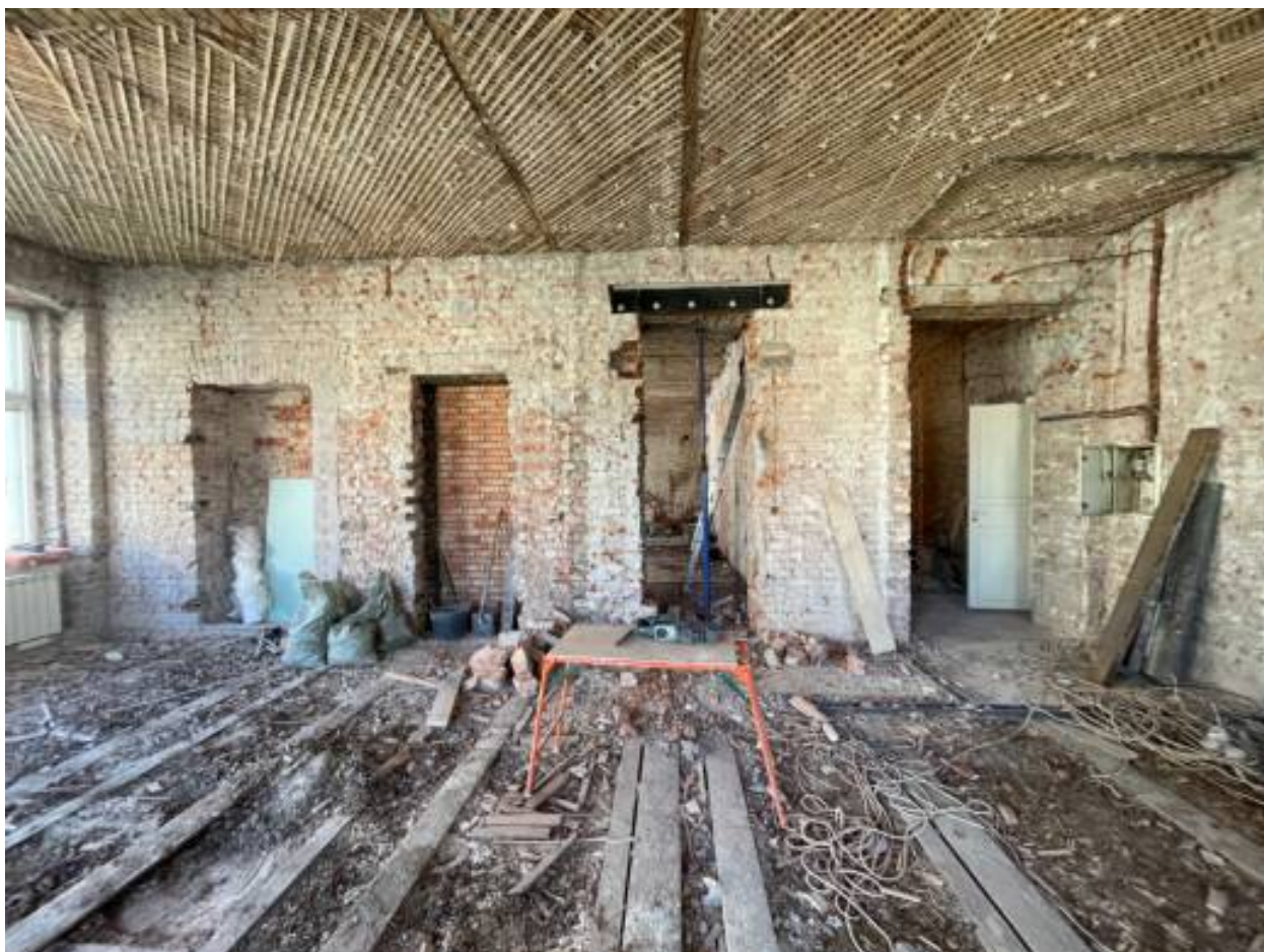
9. Помещение квартиры после демонтажа перегородок.
