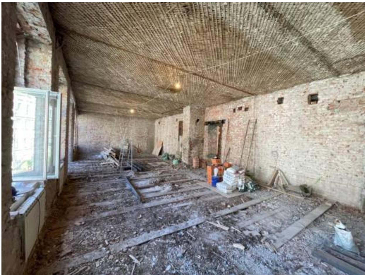
14. Помещение квартиры после демонтажа перегородок.
