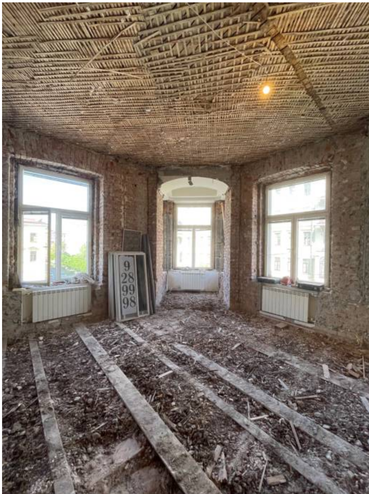
10. Помещение квартиры после демонтажа перегородок.
