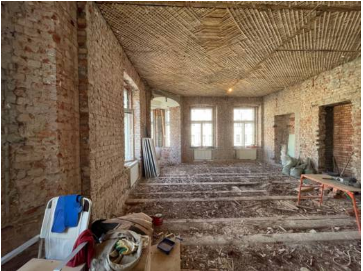
8. Помещение квартиры после демонтажа перегородок.
