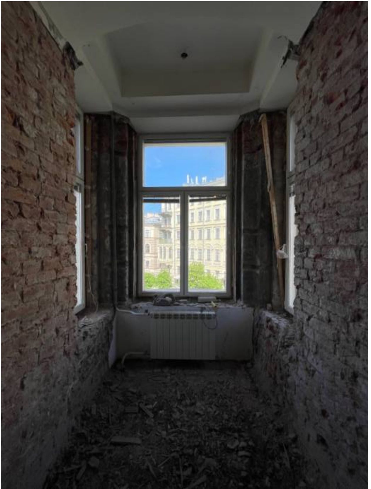
11. Помещение квартиры после демонтажа перегородок. Угловой эркер со стороны лицевого фасада.
