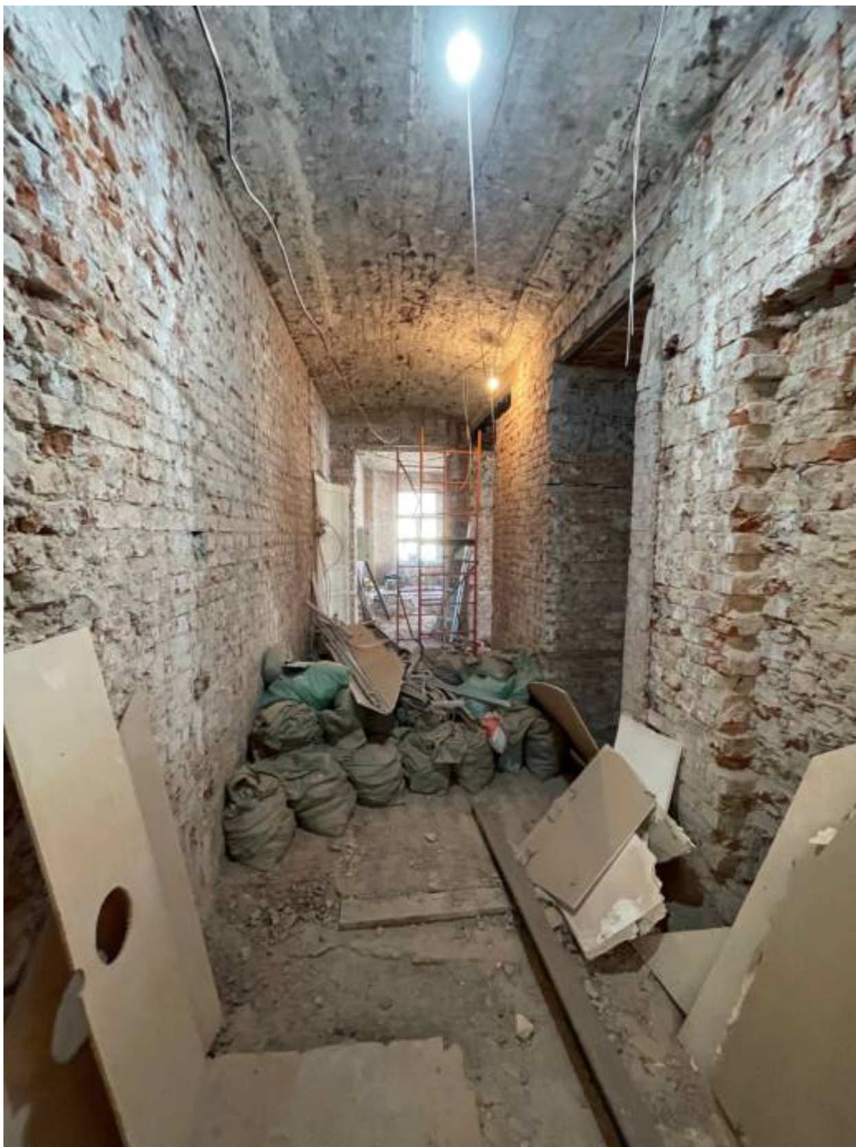
26. Помещение квартиры после демонтажа перегородок.
