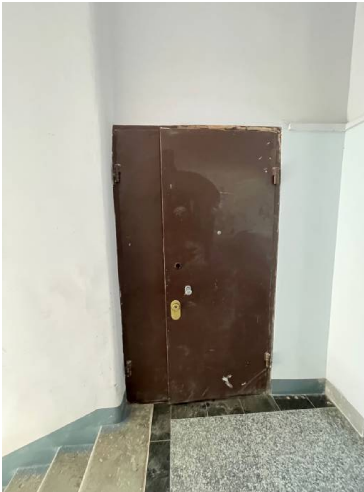
6. Входная дверь со стороны лестницы 14ЛК.
