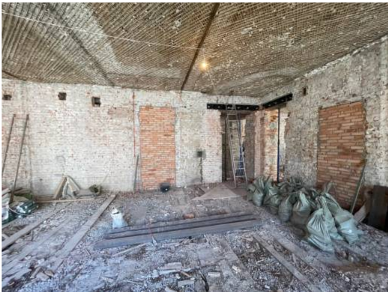
15. Помещение квартиры после демонтажа перегородок.
