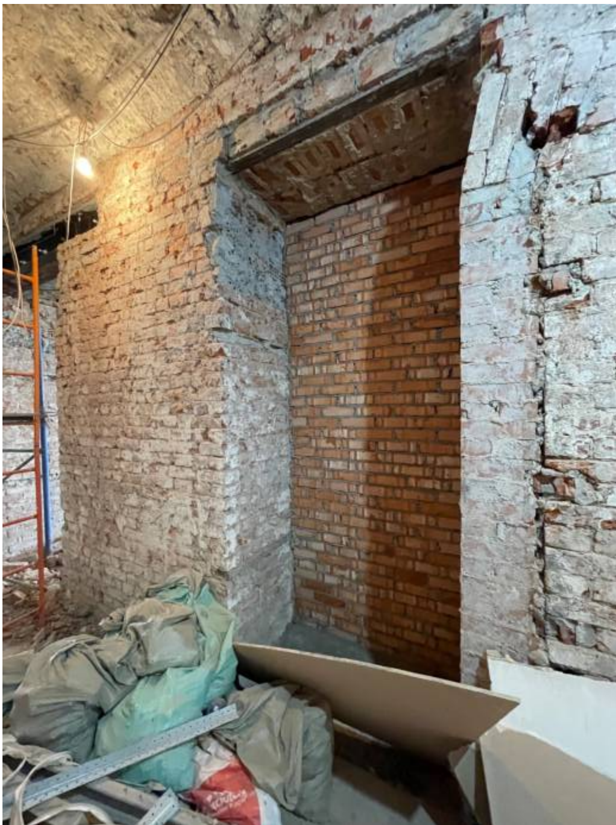
27. Помещение квартиры после демонтажа перегородок.
