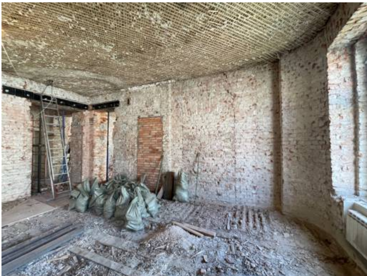
16. Помещение квартиры после демонтажа перегородок.
