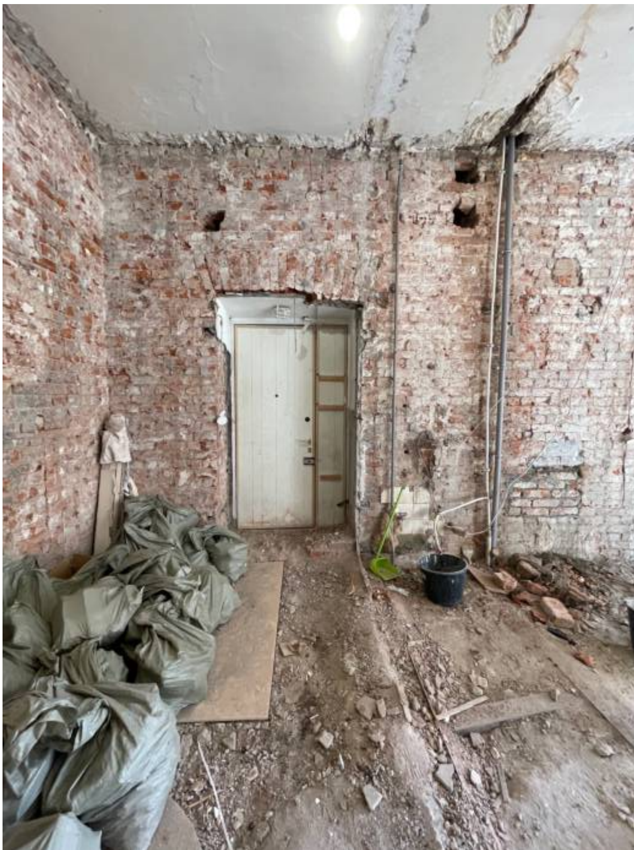
21. Помещение квартиры после демонтажа перегородок.
