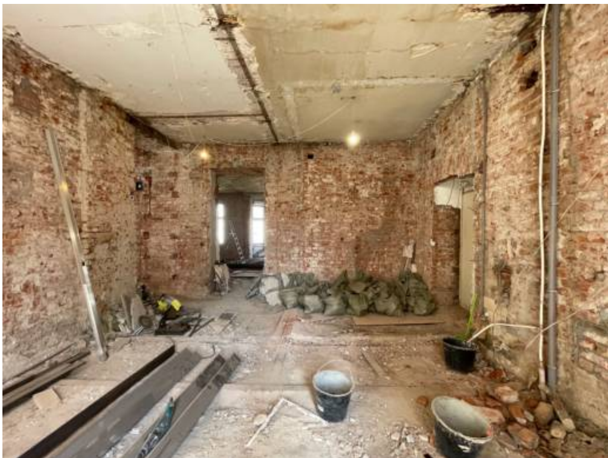
23. Помещение квартиры после демонтажа перегородок.
