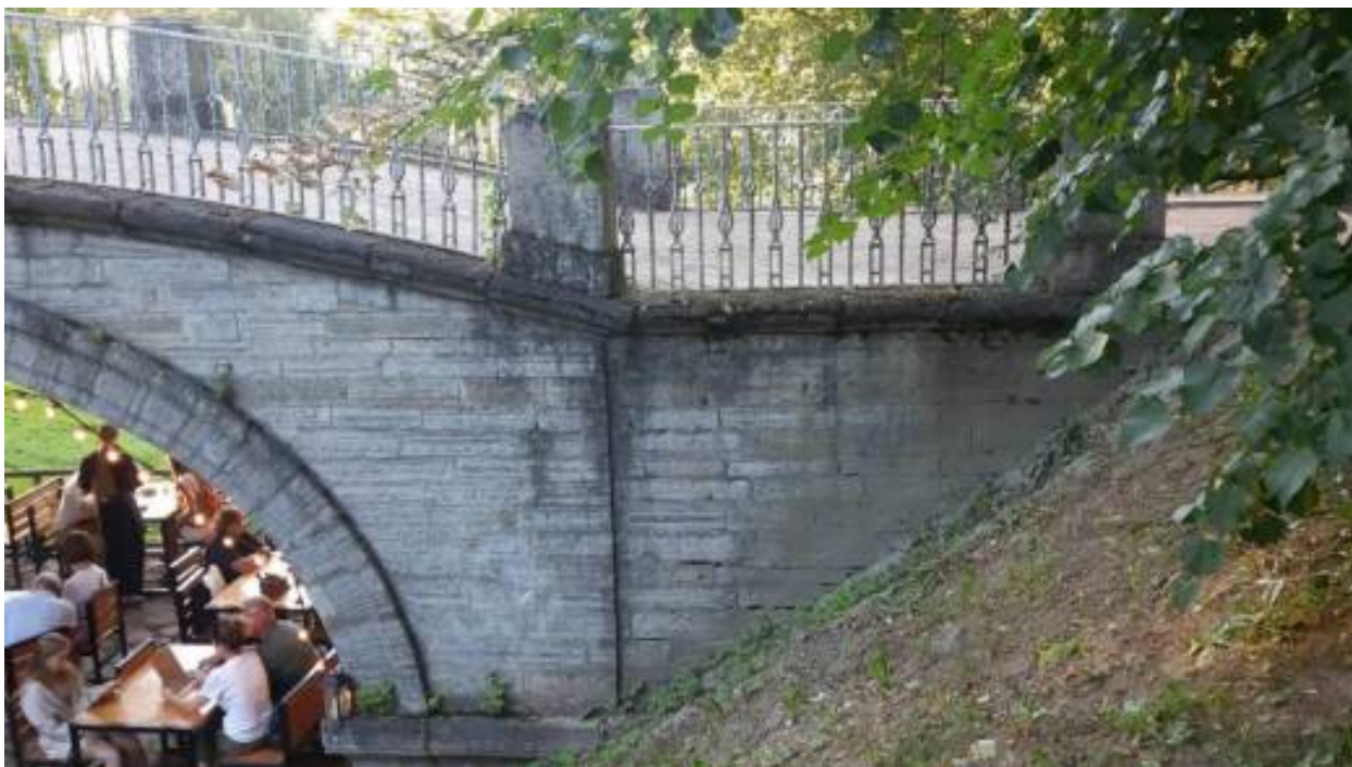
16. «Мост у северного корпуса дворца» (Санкт-Петербург, г. Павловск, Садовая ул., д. 20, лит. АТ). Вид на свод и устои моста у северного корпуса дворца со стороны дворца. Штиглиц М.С. 22.07.2026 г.
