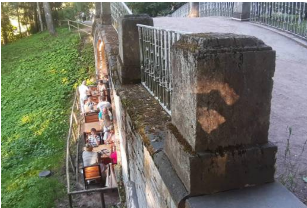
11. «Мост у северного корпуса дворца» (Санкт-Петербург, г. Павловск, Садовая ул., д. 20, лит. АТ). Вид на тумбы и ограждения Моста у северного корпуса дворца. Штиглиц М.С. 22.07.2026 г.
