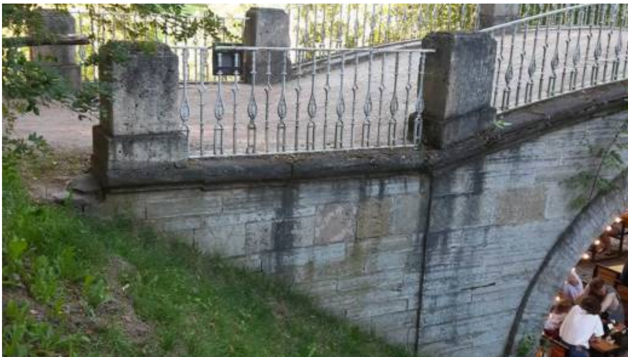
17. «Мост у северного корпуса дворца» (Санкт-Петербург, г. Павловск, Садовая ул., д. 20, лит. АТ). Вид на свод и устои моста у северного корпуса дворца со стороны дворца. Штиглиц М.С. 22.07.2026 г.
