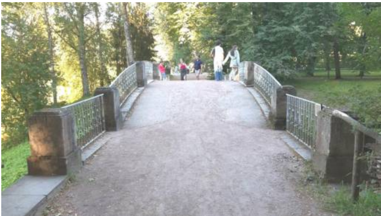
9. «Мост у северного корпуса дворца» (Санкт-Петербург, г. Павловск, Садовая ул., д. 20, лит. АТ). Общий вид на Мост у северного корпуса дворца с запада. Штиглиц М.С. 22.07.2026 г.
