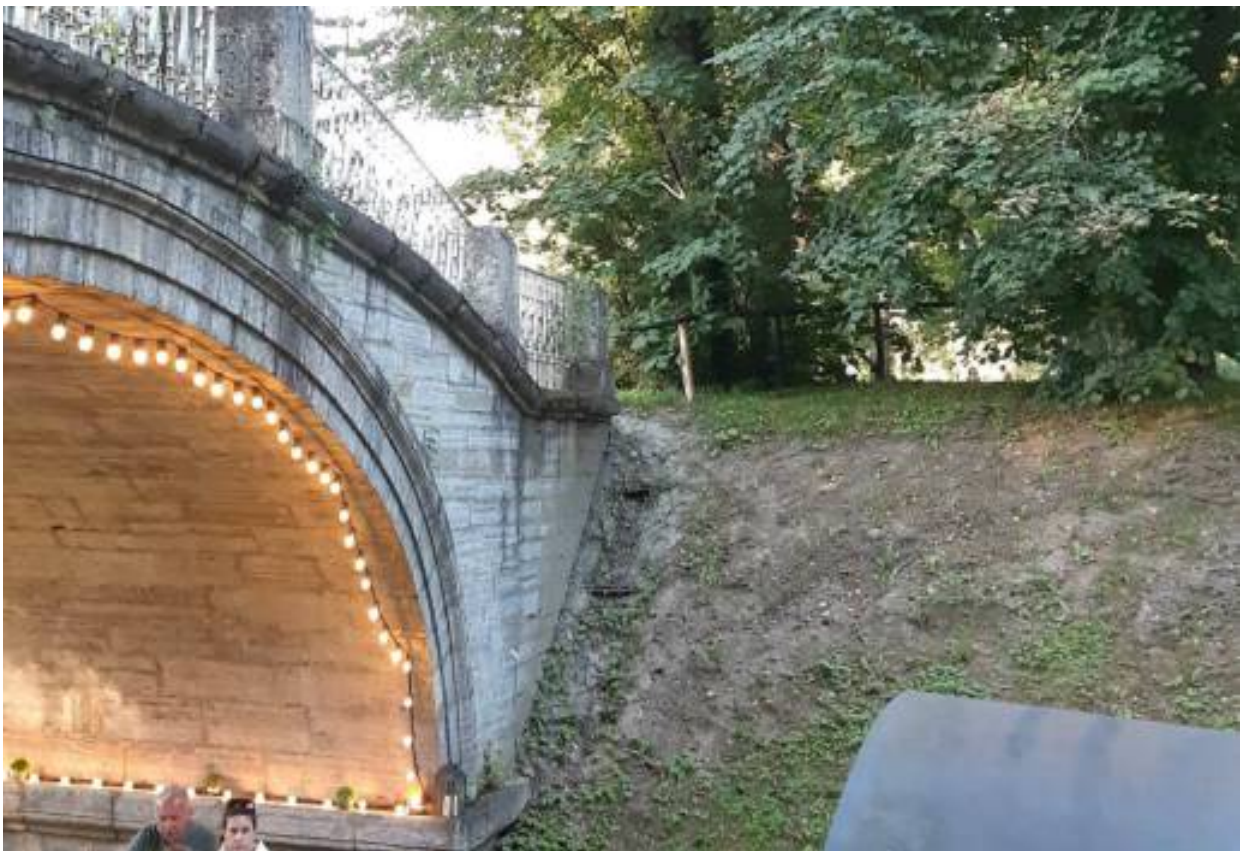
20. «Мост у северного корпуса дворца» (Санкт-Петербург, г. Павловск, Садовая ул., д. 20, лит. АТ). Вид на свод и устои моста у северного корпуса дворца со стороны дворца. Штиглиц М.С. 22.07.2026 г.
