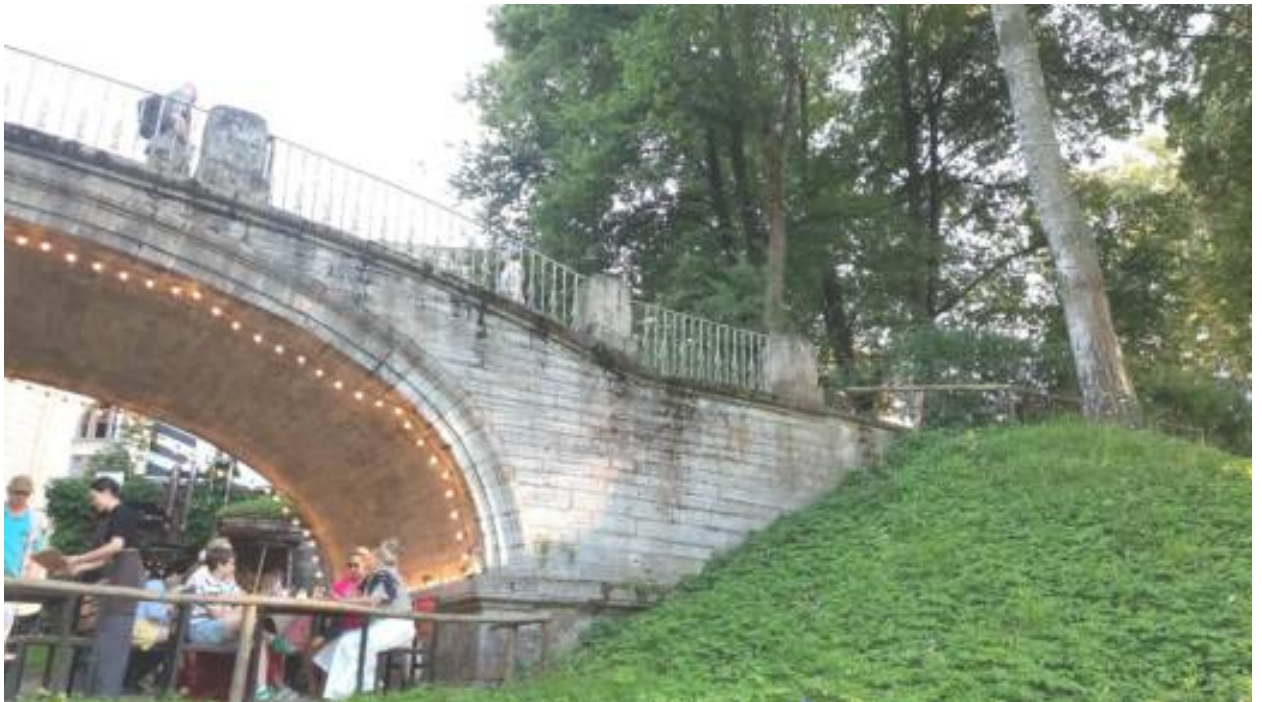
14. «Мост у северного корпуса дворца» (Санкт-Петербург, г. Павловск, Садовая ул., д. 20, лит. АТ). Вид на свод и устои моста у северного корпуса дворца со стороны р. Славянки. Штиглиц М.С. 22.07.2026 г.
