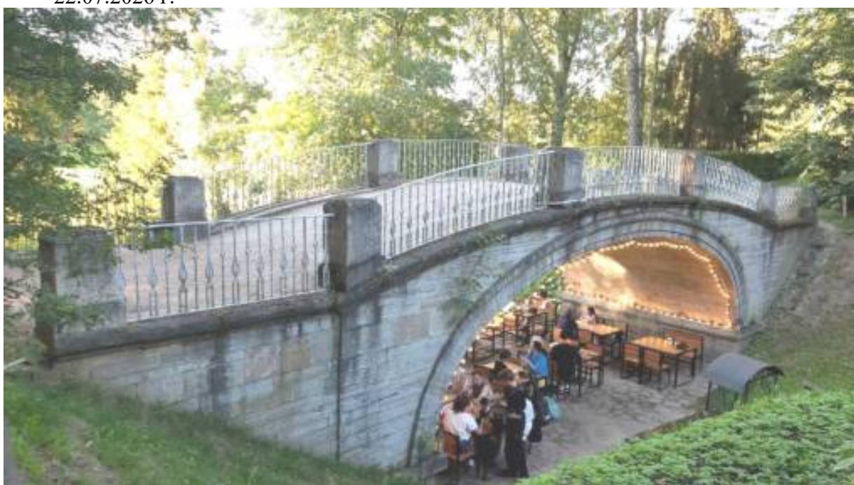
8. «Мост у северного корпуса дворца» (Санкт-Петербург, г. Павловск, Садовая ул., д. 20, лит. АТ). Общий вид на Мост у северного корпуса дворца с юга-запада. Штиглиц М.С. 22.07.2026 г.
