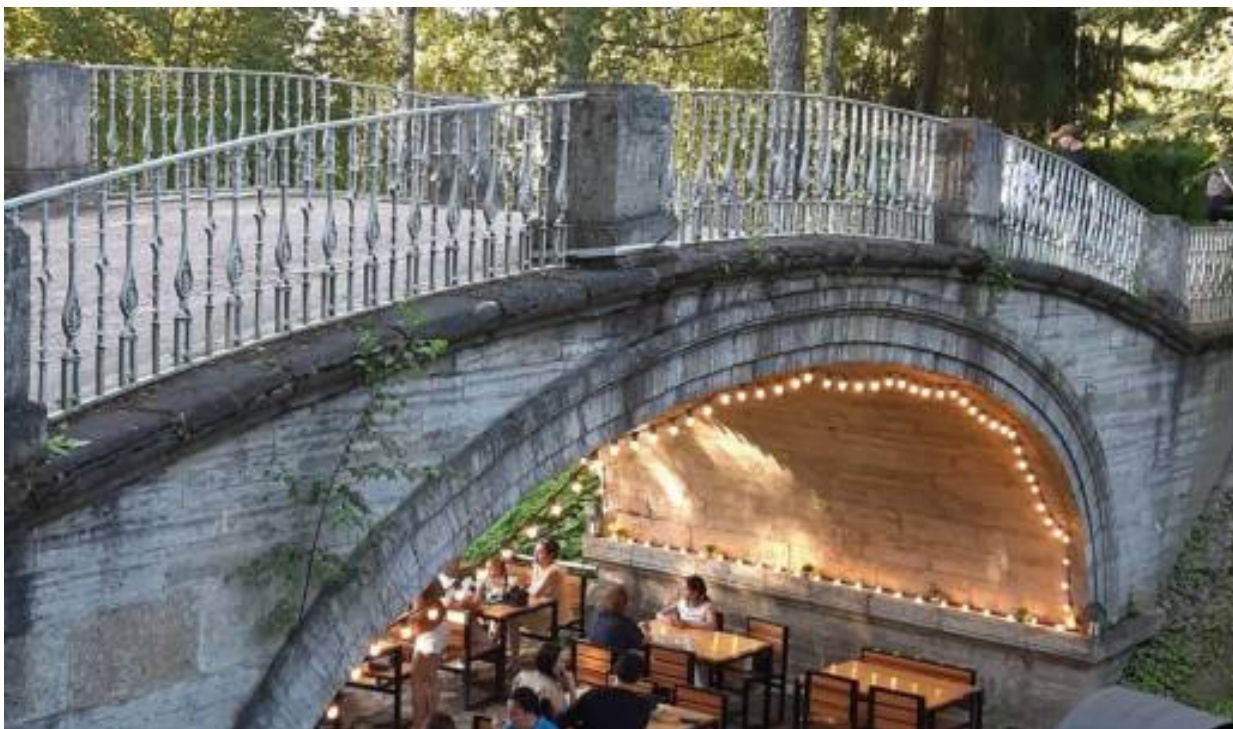
18. «Мост у северного корпуса дворца» (Санкт-Петербург, г. Павловск, Садовая ул., д. 20, лит. АТ). Вид на свод и устои моста у северного корпуса дворца со стороны дворца. Штиглиц М.С. 22.07.2026 г.
