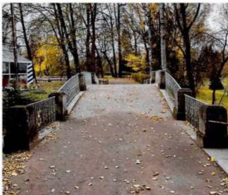
3. Состояние прохаживаемой части моста.
