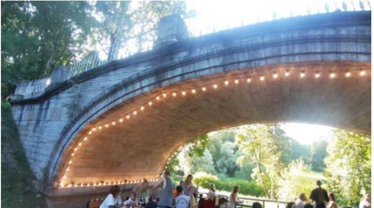
19. «Мост у северного корпуса дворца» (Санкт-Петербург, г. Павловск, Садовая ул., д. 20, лит. АТ). Вид на свод и устои моста у северного корпуса дворца со стороны дворца. Штиглиц М.С. 22.07.2026 г.
