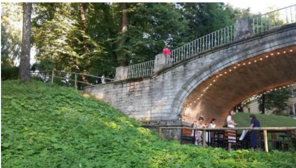
12. «Мост у северного корпуса дворца» (Санкт-Петербург, г. Павловск, Садовая ул., д. 20, лит. АТ). Вид на свод и устои моста у северного корпуса дворца со стороны р. Славянки. Штиглиц М.С. 22.07.2026 г.
