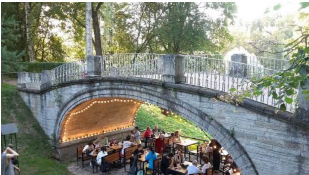
15. «Мост у северного корпуса дворца» (Санкт-Петербург, г. Павловск, Садовая ул., д. 20, лит. АТ). Вид на свод и устои моста у северного корпуса дворца со стороны дворца. Штиглиц М.С. 22.07.2026 г.
