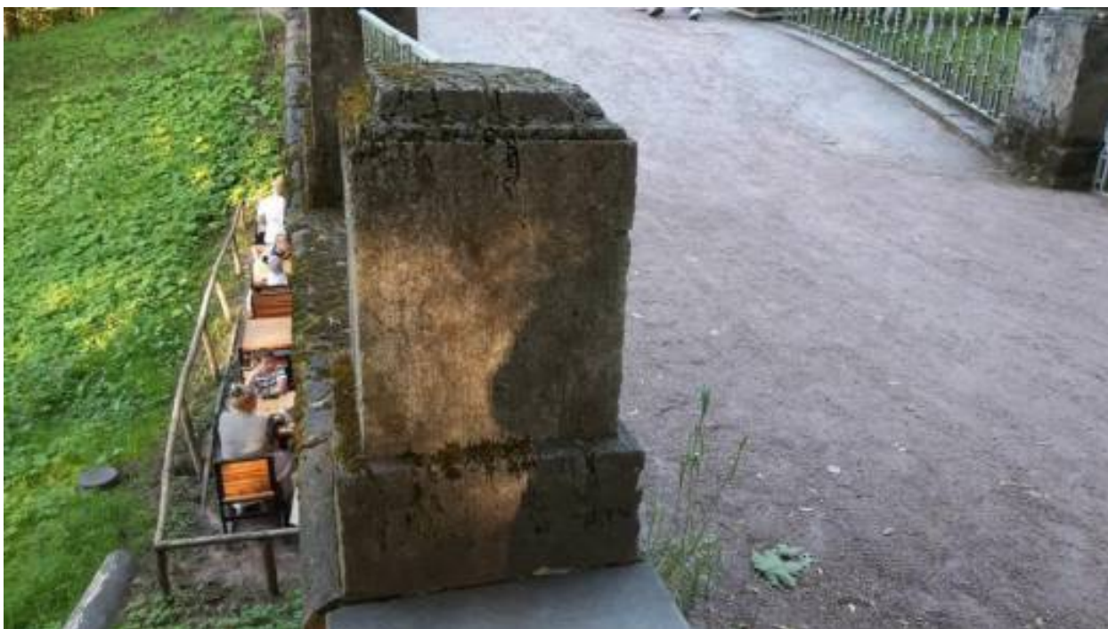
10. «Мост у северного корпуса дворца» (Санкт-Петербург, г. Павловск, Садовая ул., д. 20, лит. АТ). Вид на тумбы и ограждения Моста у северного корпуса дворца. Штиглиц М.С. 22.07.2026 г.
