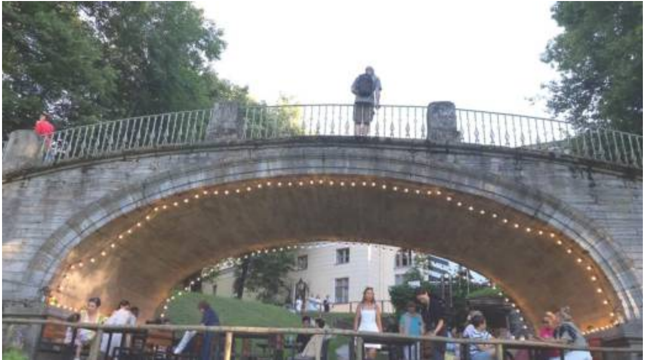
13. «Мост у северного корпуса дворца» (Санкт-Петербург, г. Павловск, Садовая ул., д. 20, лит. АТ). Вид на свод и устои моста у северного корпуса дворца со стороны р. Славянки. Штиглиц М.С. 22.07.2026 г.
