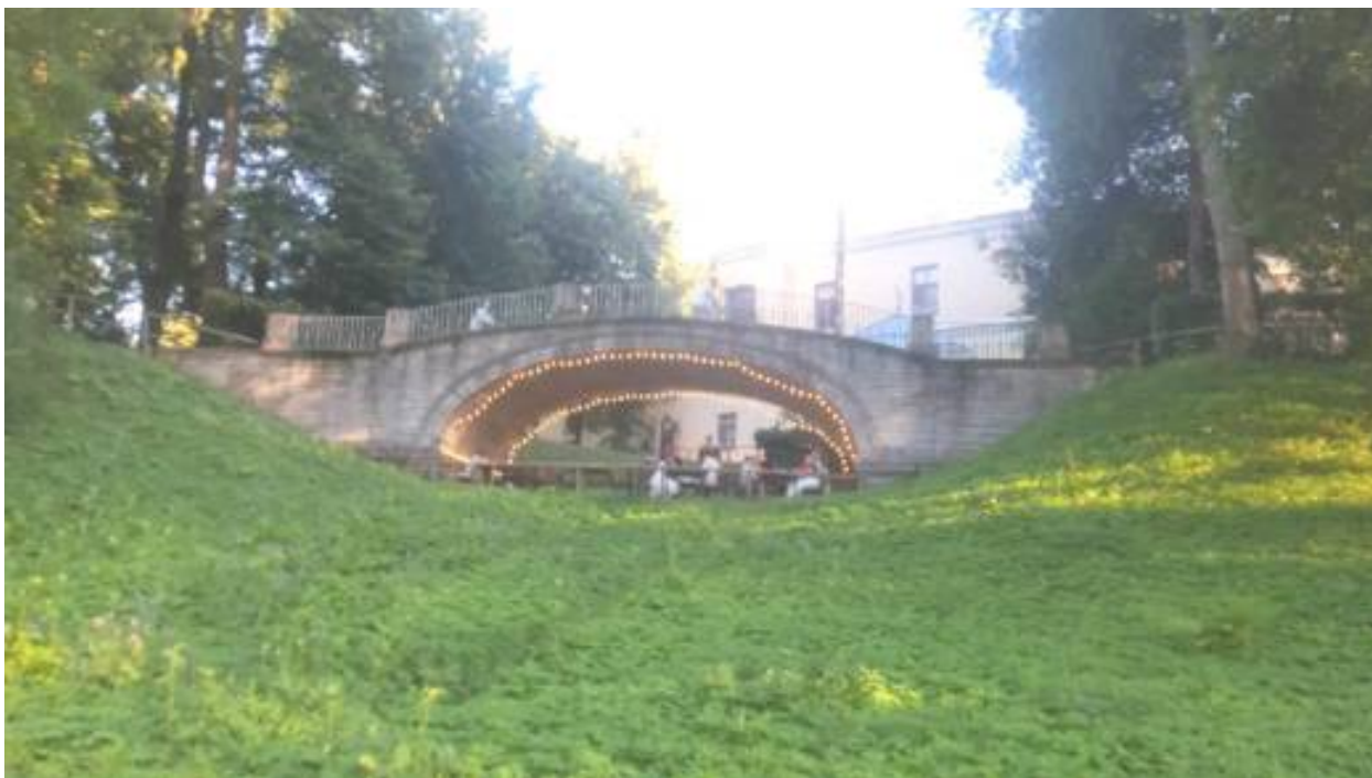
3. «Мост у северного корпуса дворца» (Санкт-Петербург, г. Павловск, Садовая ул., д. 20, лит. АТ). Общий вид на Мост у северного корпуса дворца с севера. Штиглиц М.С. 22.07.2026 г.
