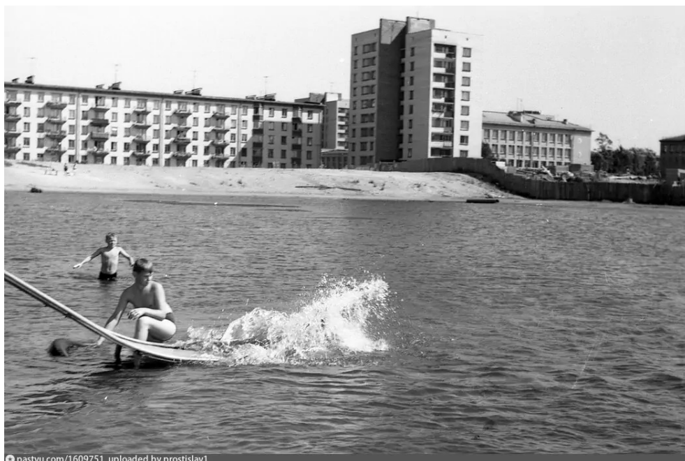
Илл.35. Архивная фотография Яшумовского карьера. Вид со стороны Светлановского пр. на карьер. В правом верхнем углу на территории карьера огорожена территория под строительство спортивной школы им. В.И. Алексеева. Около 1969-1971 года. Вид с СЗ.
