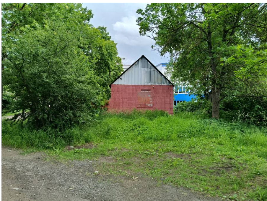
Илл.50. Земельный участок с кадастровым номером 78:36:0005362:3466. Точка фотофиксации №4. Северная часть участка. Вид с ЮЗ.
