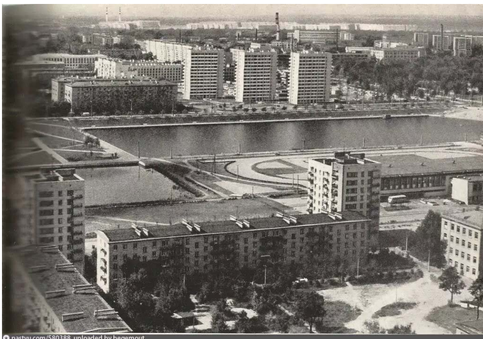
Илл.37. Архивная фотография Ольгинских прудов (бывшего Яшумовского карьера). Вид со стороны Тихорецкого проспекта на благоустройство территории карьера после строительства спортивной школы им. В.И. Алексеева. Около 1975-1976 года. Вид с В.
