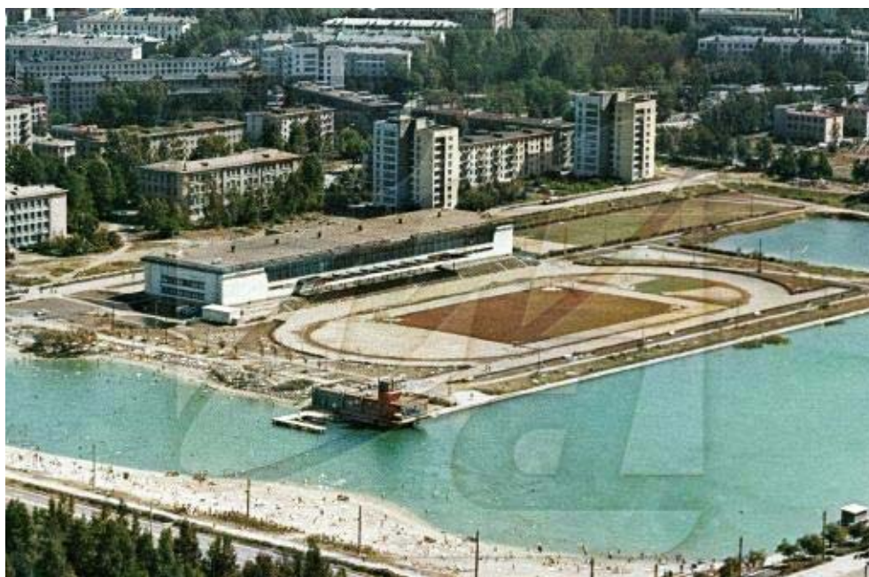
Илл.36. Архивная фотография Ольгинских прудов (бывшего Яшумовского карьера). Вид со стороны угла Светлановского пр. и ул. Жака Дюкло на благоустройство территории карьера после строительства спортивной школы им. В.И. Алексеева. Конец 1970-х годов. Вид с СЗ.
