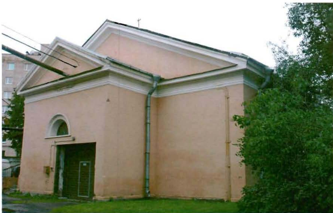
Фото №3. Вид на восточный фасад.
