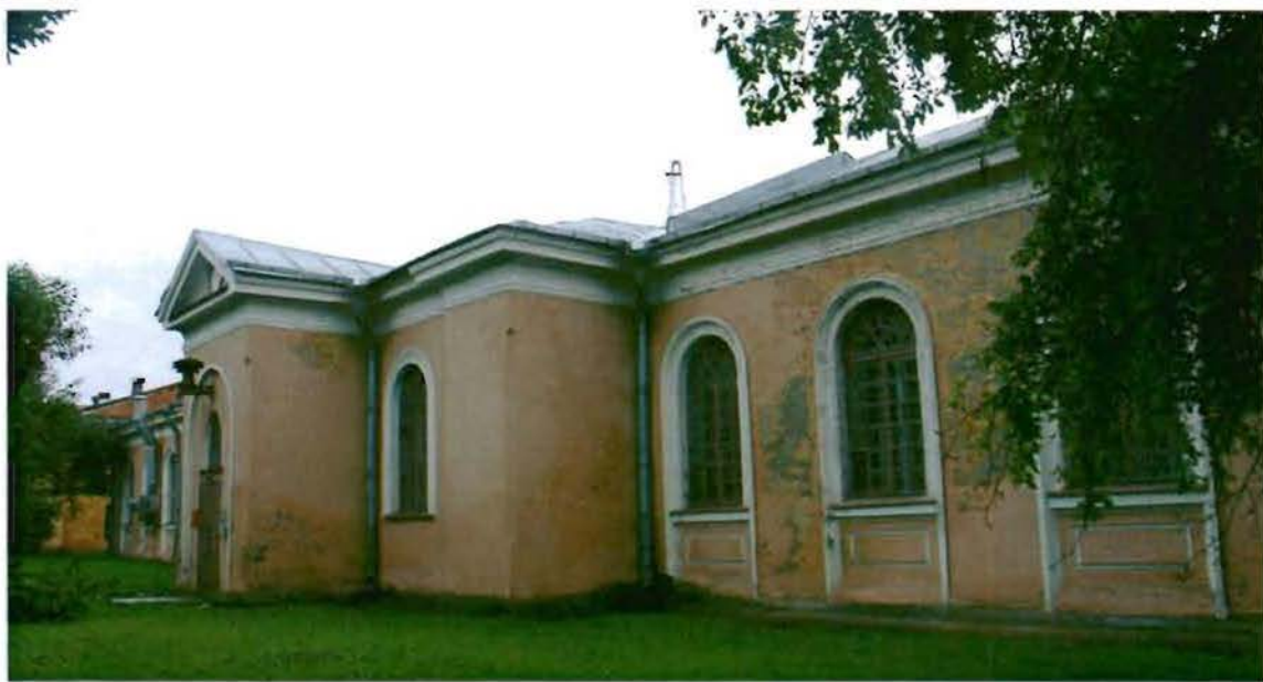
Фото №1. Вид на северный фасад.
