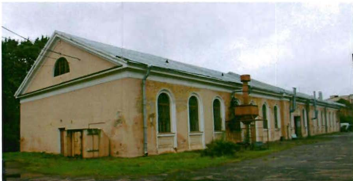
Фото №2. Вид на южный и западный фасады.
