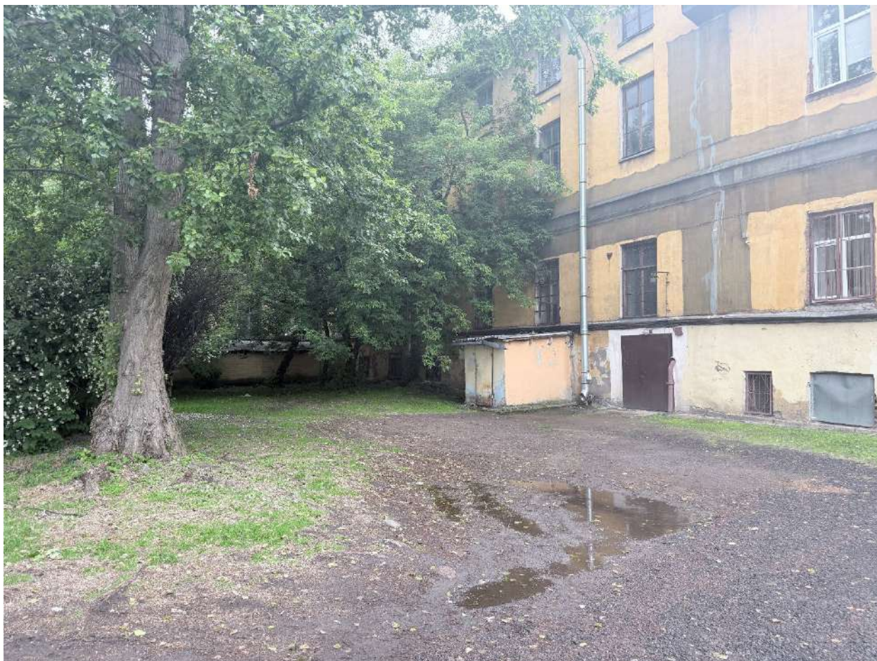
Фото 21. Общий вид на территорию объекта.
