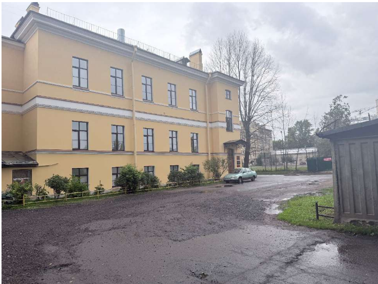
Фото 19. Общий вид на территорию объекта.
