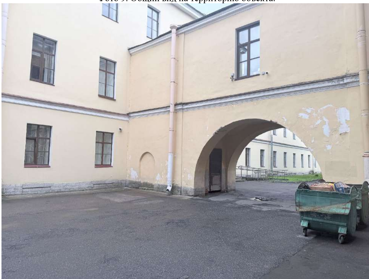
Фото 10. Общий вид на территорию объекта.
