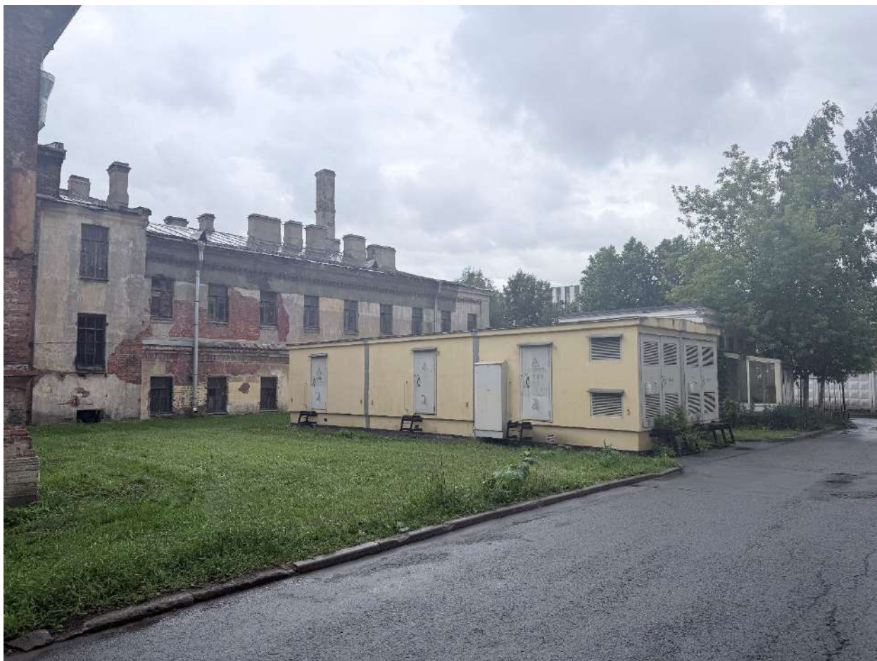
Фото 13. Общий вид на территорию объекта.
