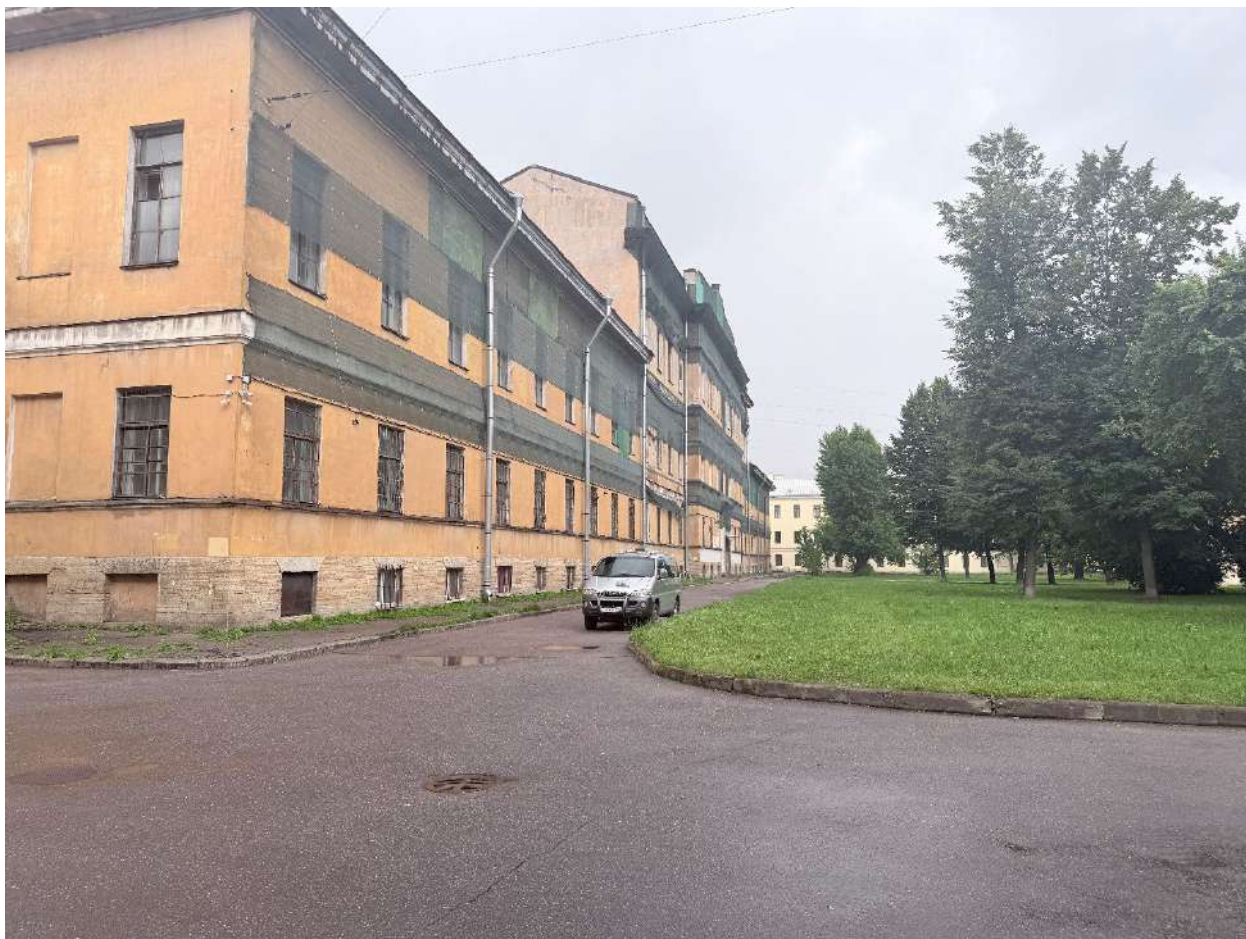
Фото 33. Общий вид на территорию объекта.
