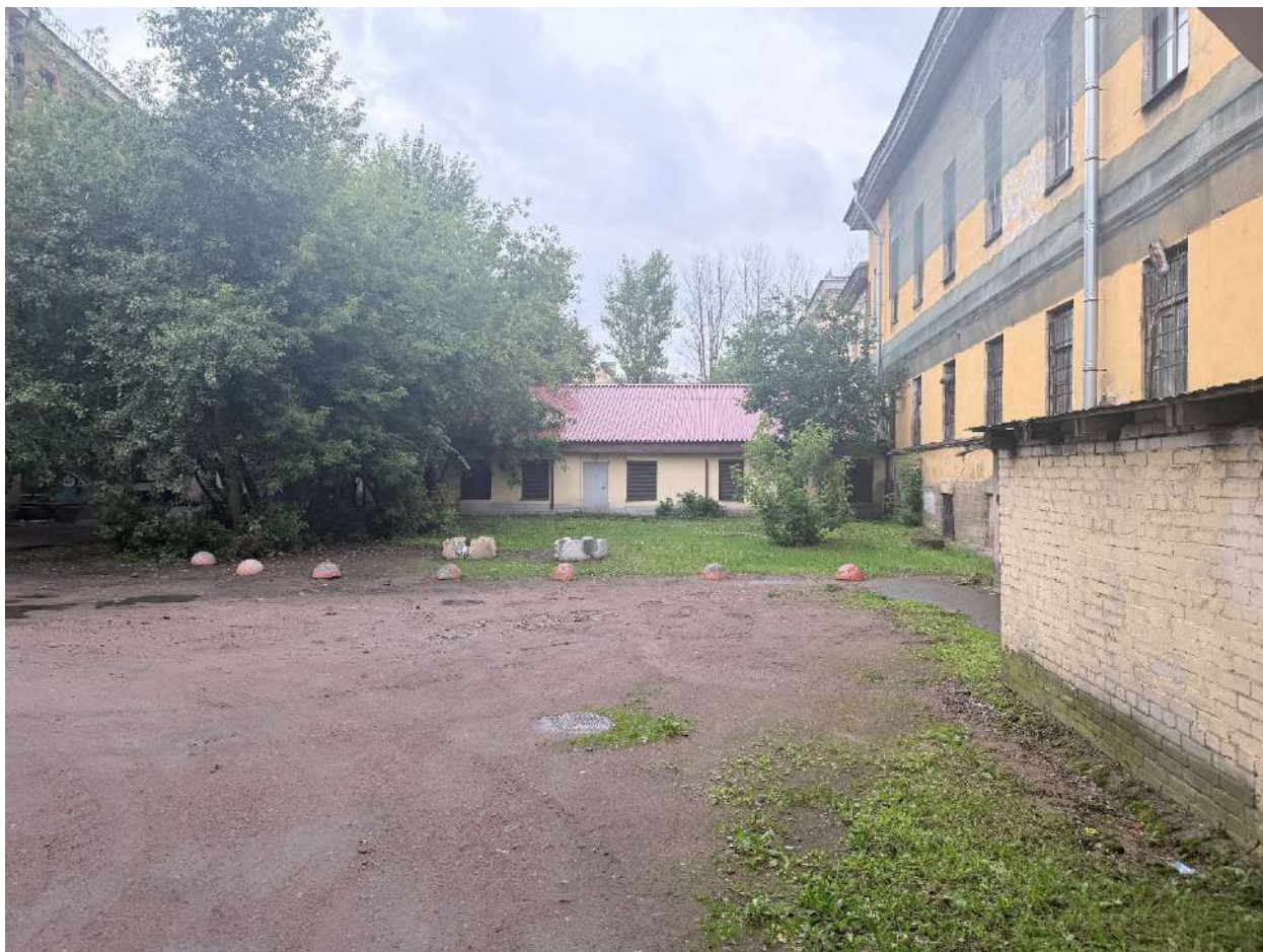
Фото 27. Общий вид на территорию объекта.
