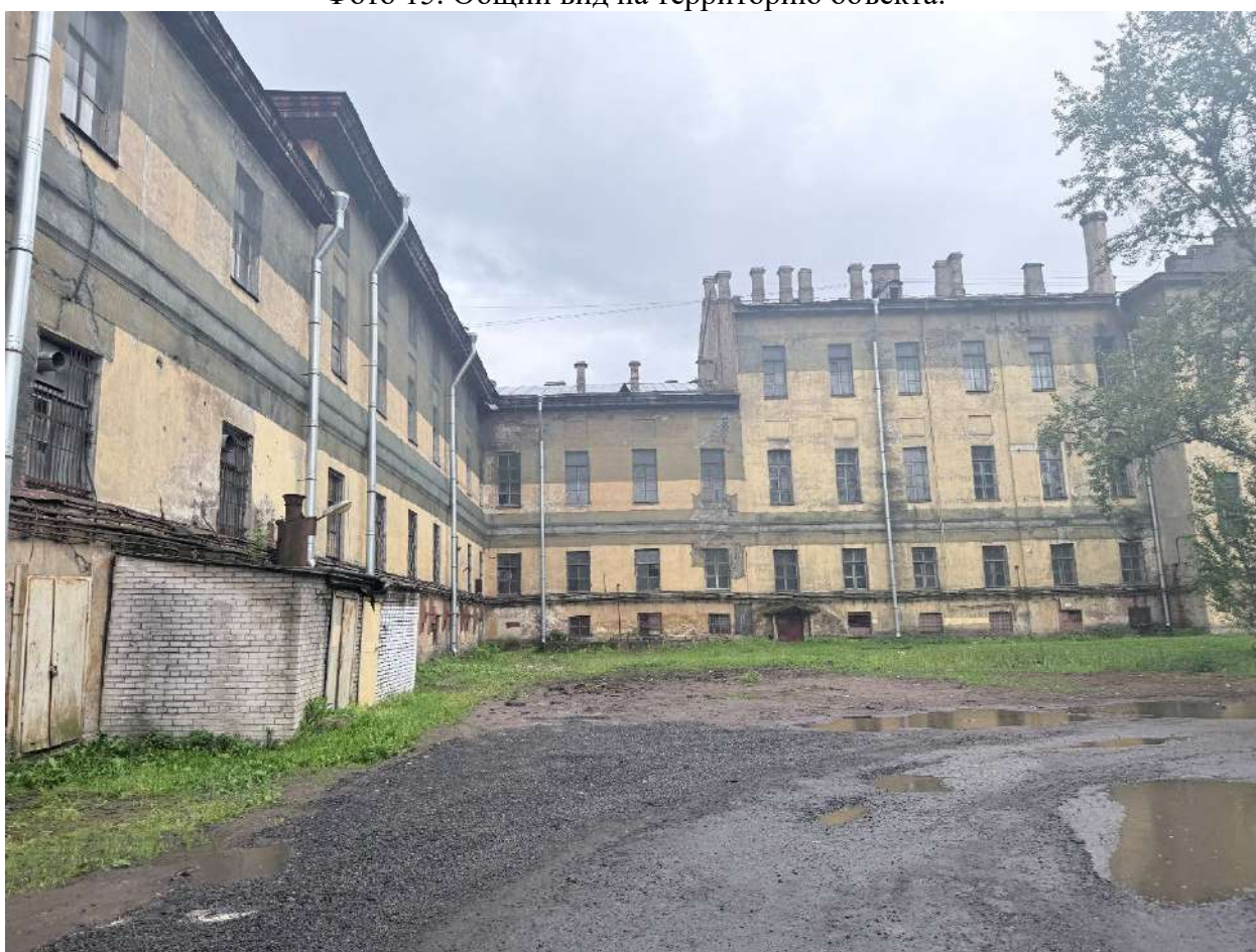
Фото 16. Общий вид на территорию объекта.
