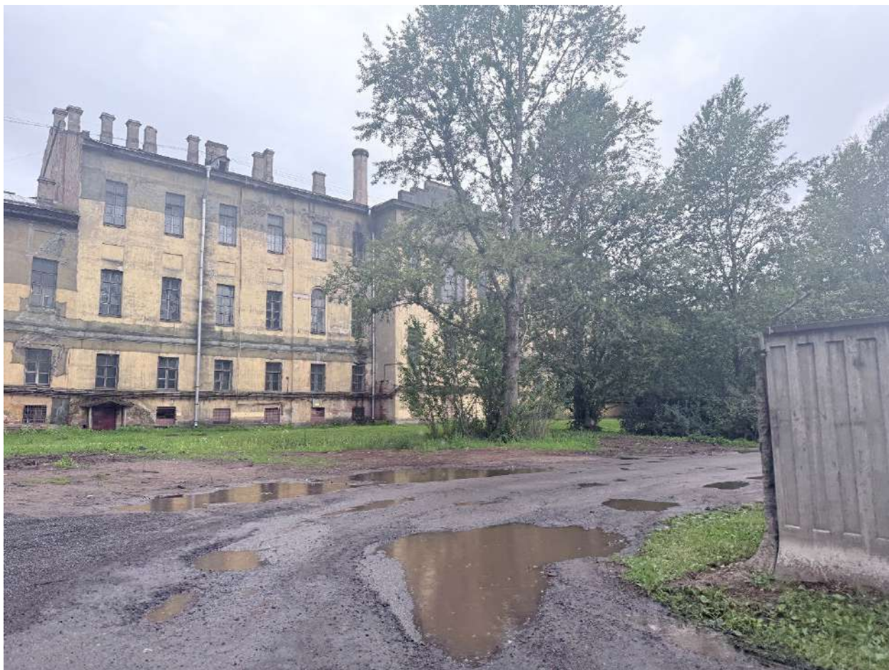
Фото 17. Общий вид на территорию объекта.
