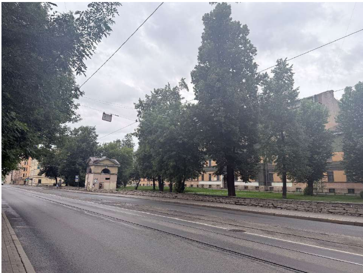
Фото 1. Общий вид на территорию объекта.
