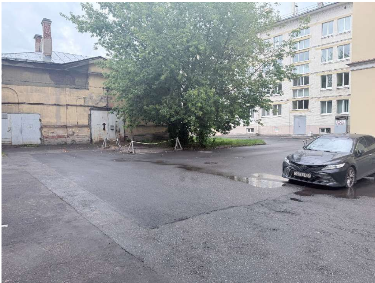
Фото 9. Общий вид на территорию объекта.
