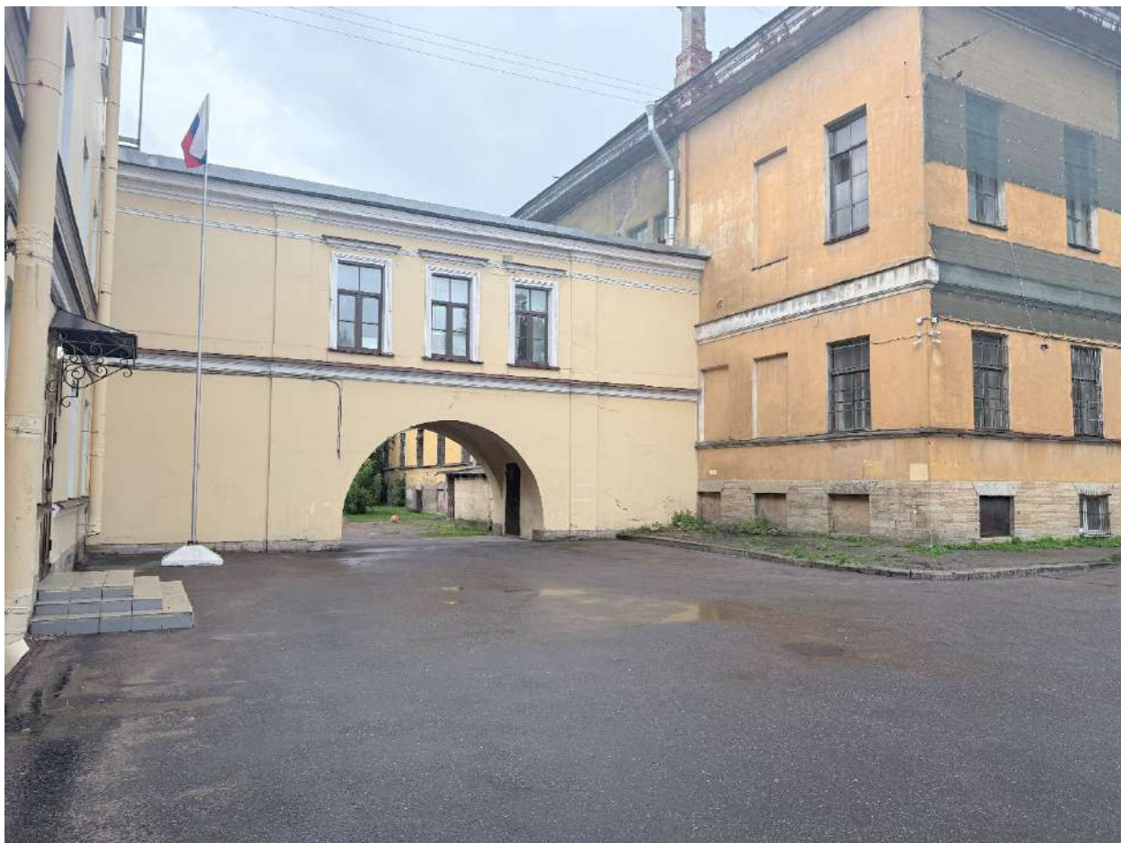
Фото 31. Общий вид на территорию объекта.
