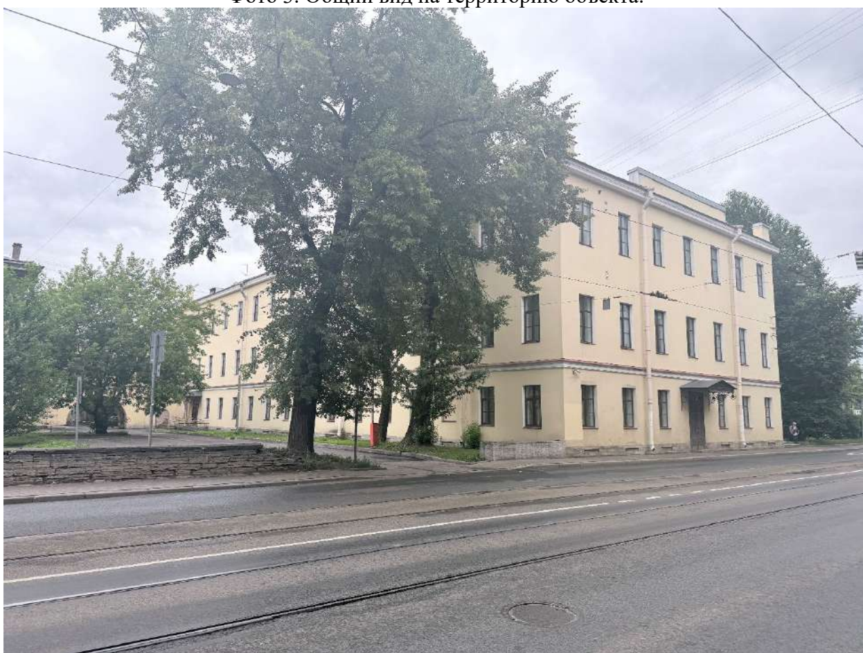
Фото 4. Общий вид на территорию объекта.
