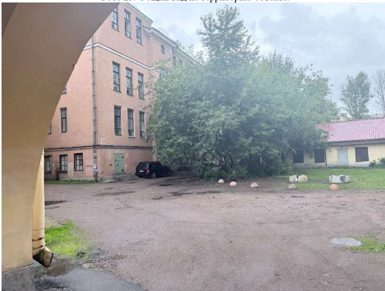
Фото 30. Общий вид на территорию объекта.
