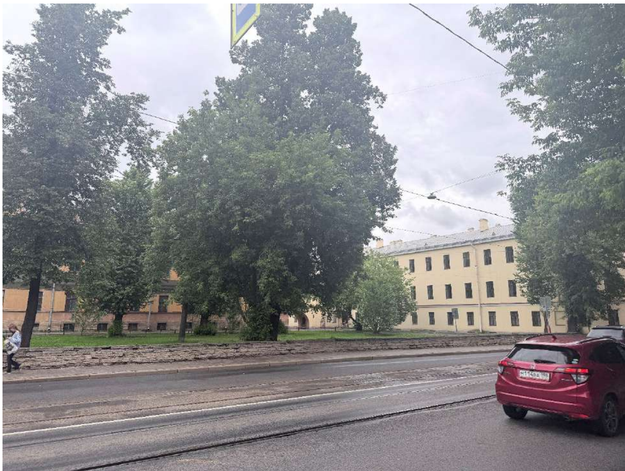
Фото 3. Общий вид на территорию объекта.
