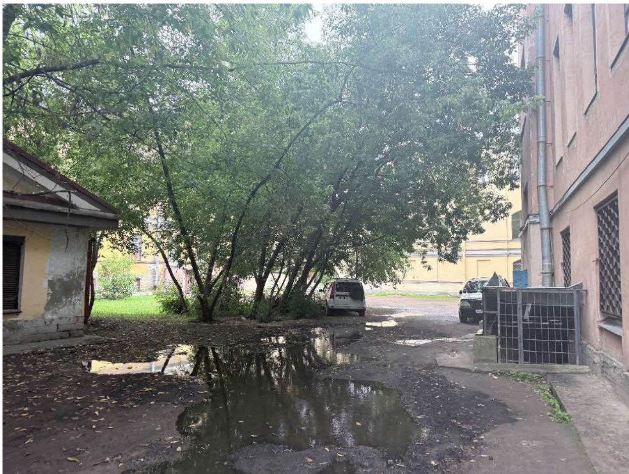
Фото 25. Общий вид на территорию объекта.
