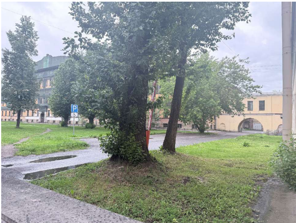
Фото 5. Общий вид на территорию объекта.
