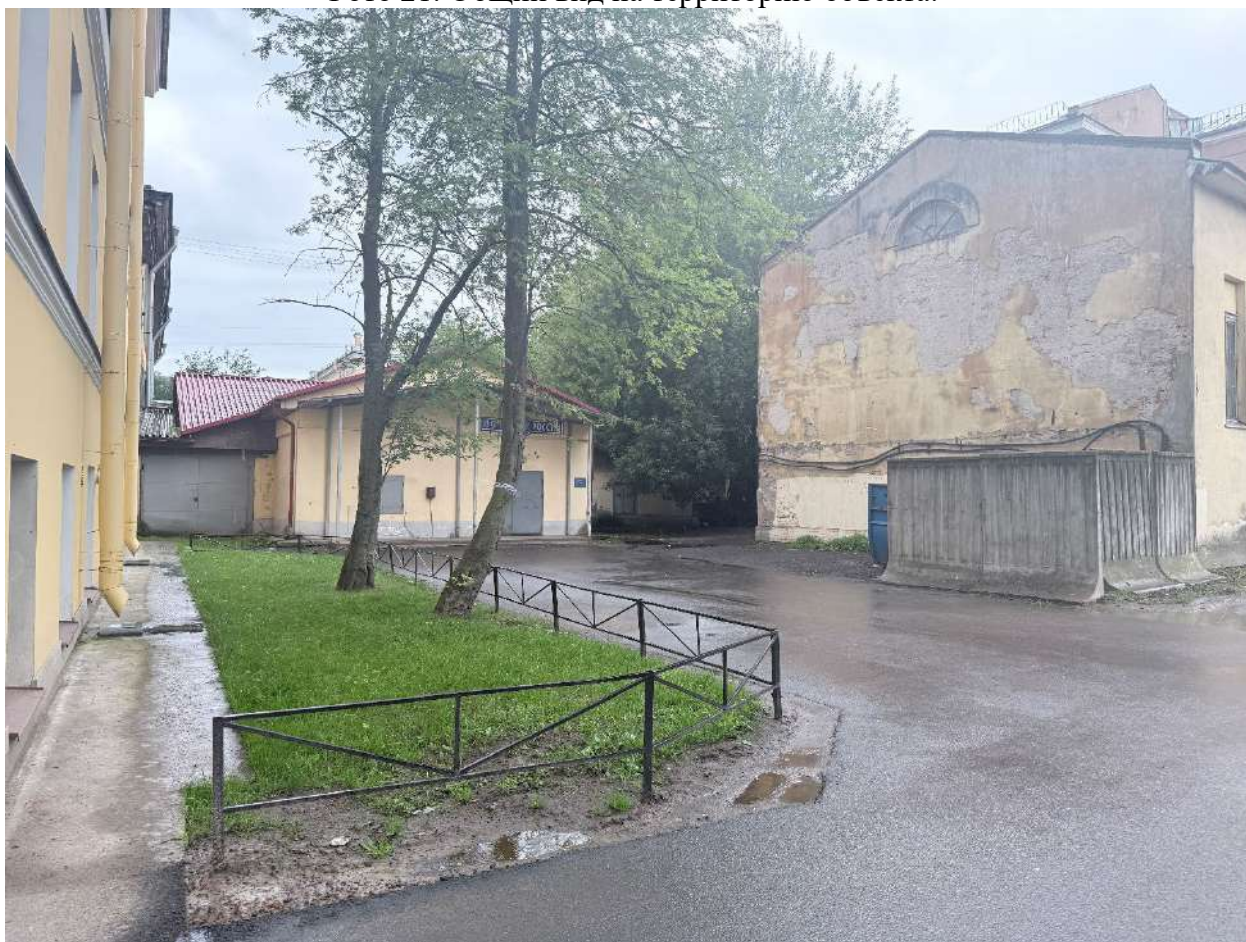
Фото 22. Общий вид на территорию объекта.
