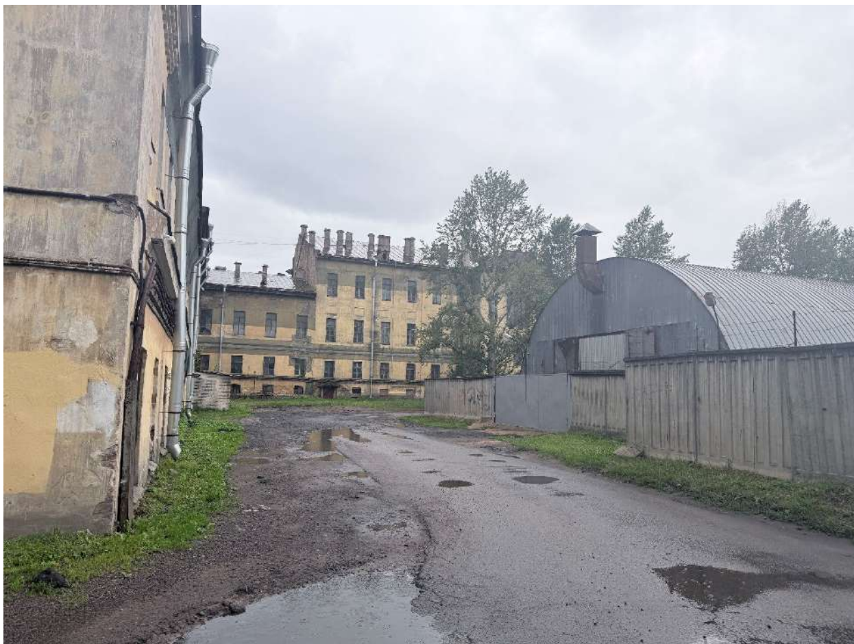
Фото 15. Общий вид на территорию объекта.
