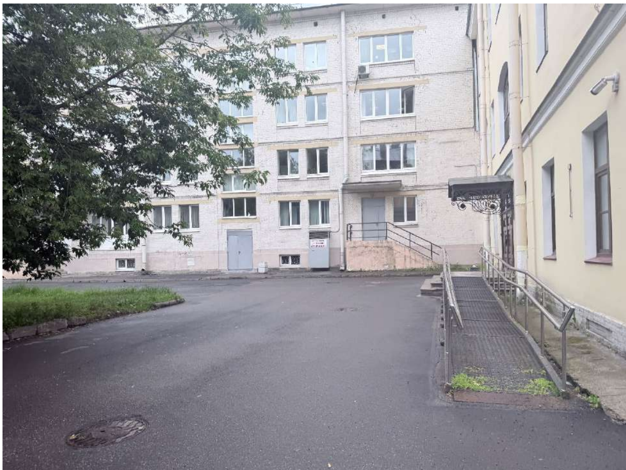
Фото 11. Общий вид на территорию объекта.
