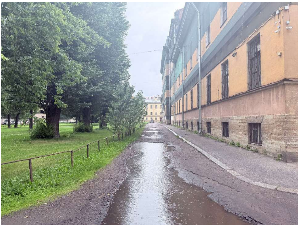
Фото 7. Общий вид на территорию объекта.
