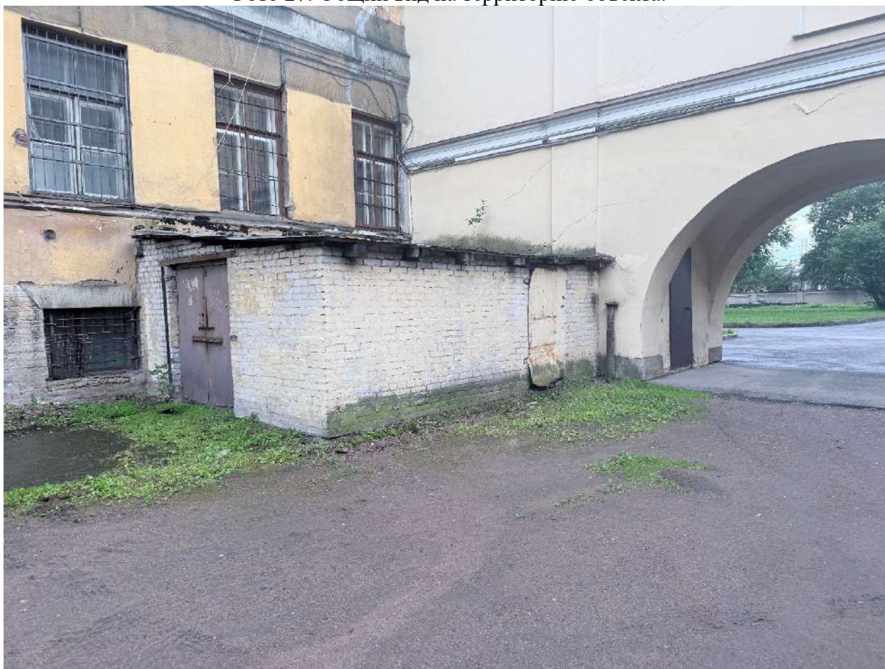
Фото 28. Общий вид на территорию объекта.
