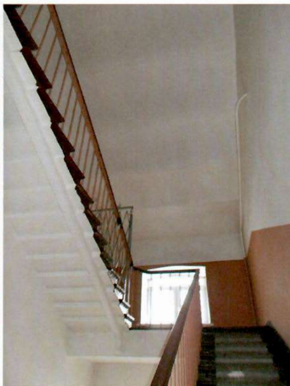
17. Лазарет (лестница 8-ЛК, перекрытия)
