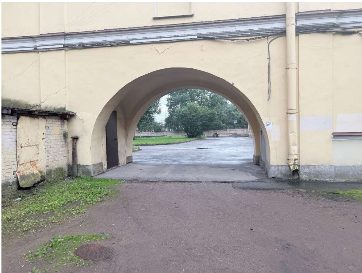
Фото 29. Общий вид на территорию объекта.
