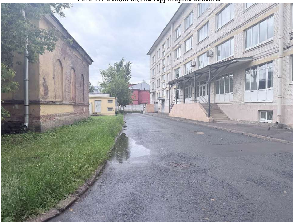
Фото 12. Общий вид на территорию объекта.
