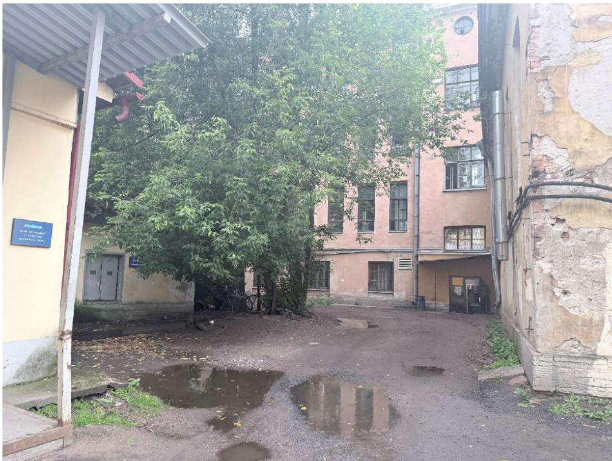
Фото 23. Общий вид на территорию объекта.
