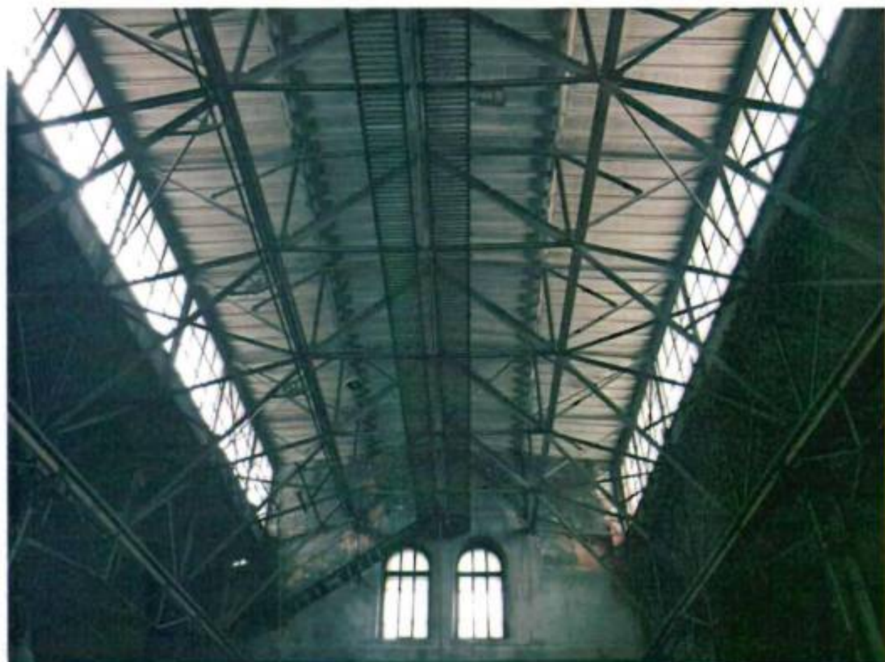
6. Металлические фермы перекрытия.
