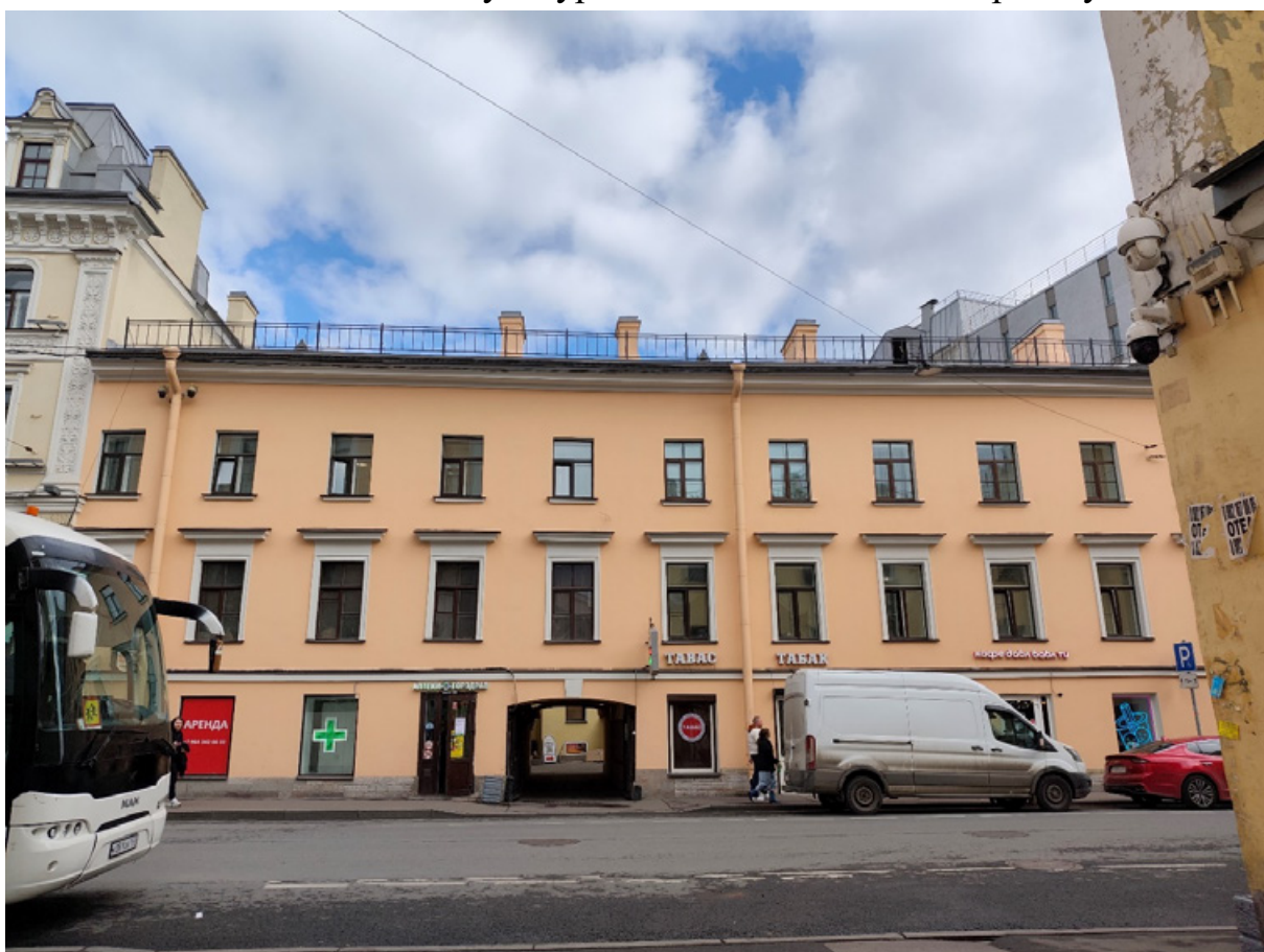
Фото 6. Фасад дома по Гончарной улице.
