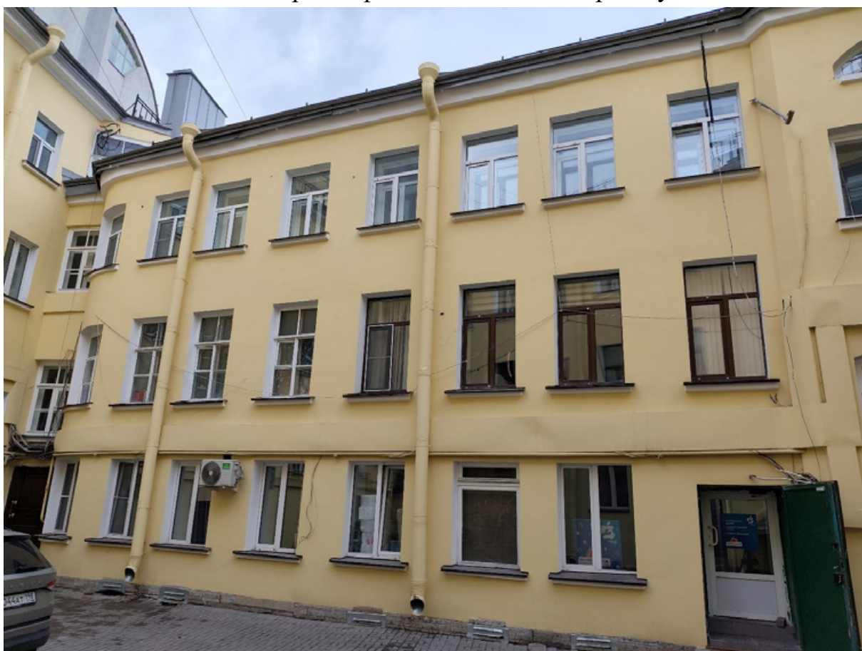
Фото 12. Фрагмент фасада дома по Гончарной улице.
