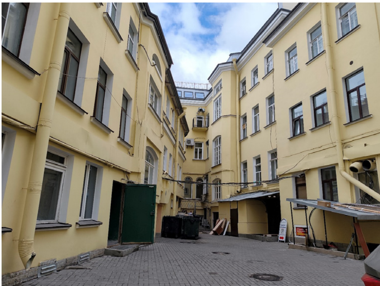
Фото 9. Общий вид двора.
