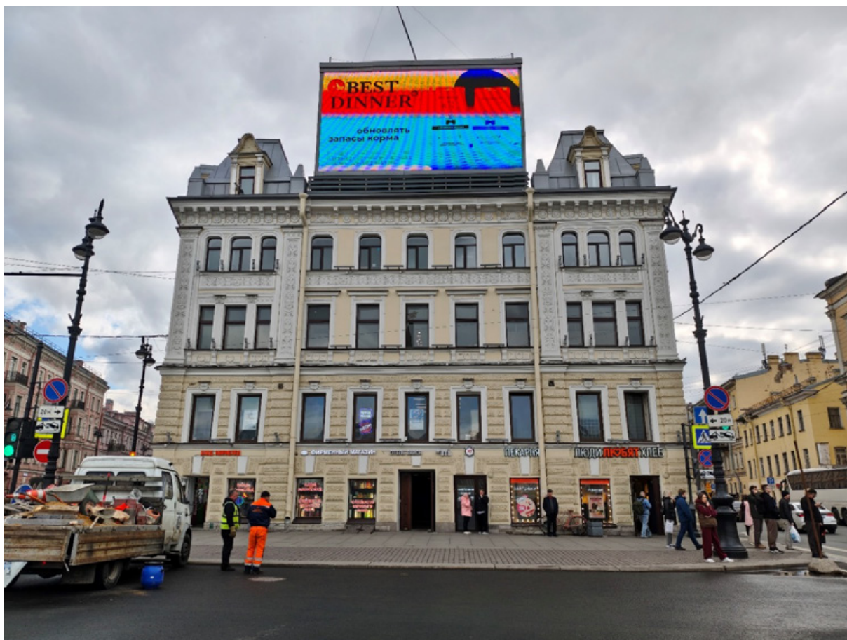
Фото 1. Фасад объекта культурного наследия с площади Восстания.
