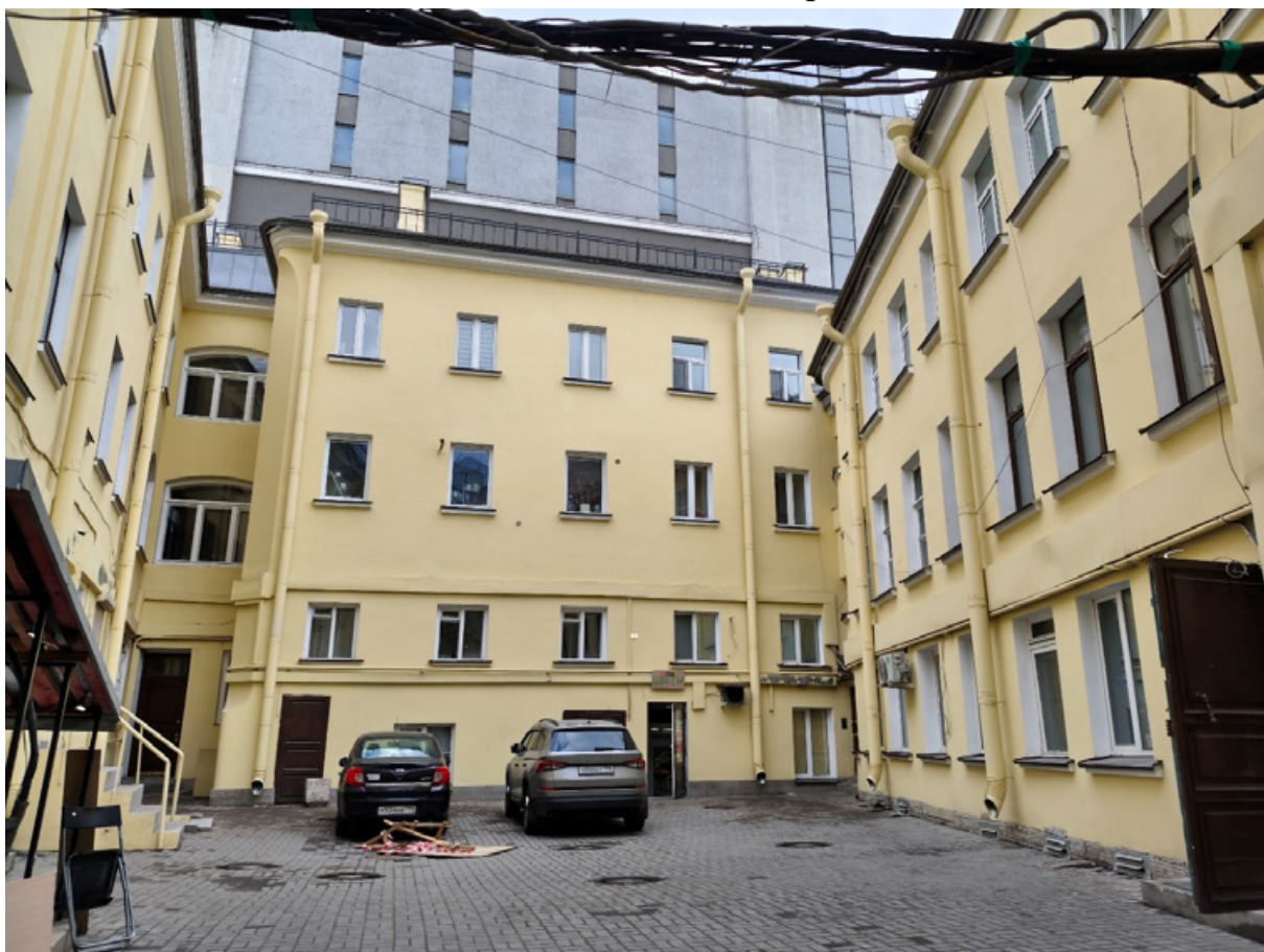
Фото 10. Западный фасад дворового флигеля.
