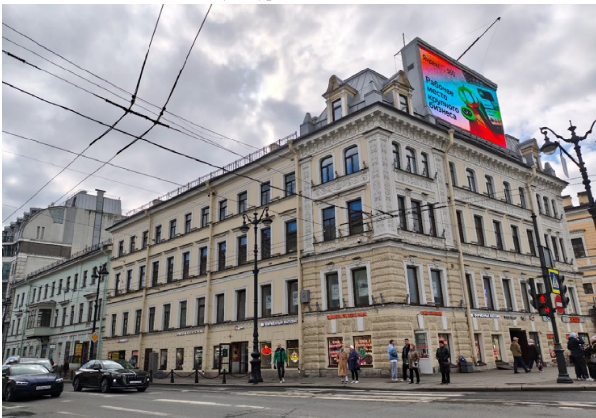
Фото 2. Общий вид с северо-запада.
