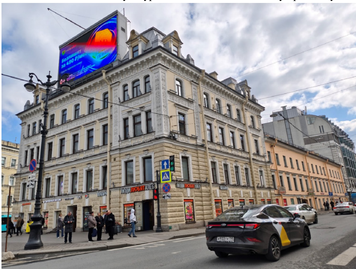
Фото 4. Общий вид с запада.
