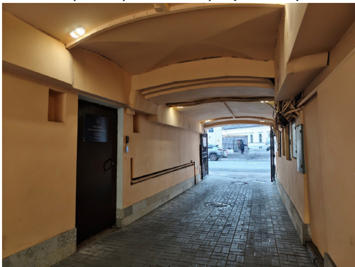
Фото 8. Проездная арка дома по Гончарной улице. Вид со двора.
