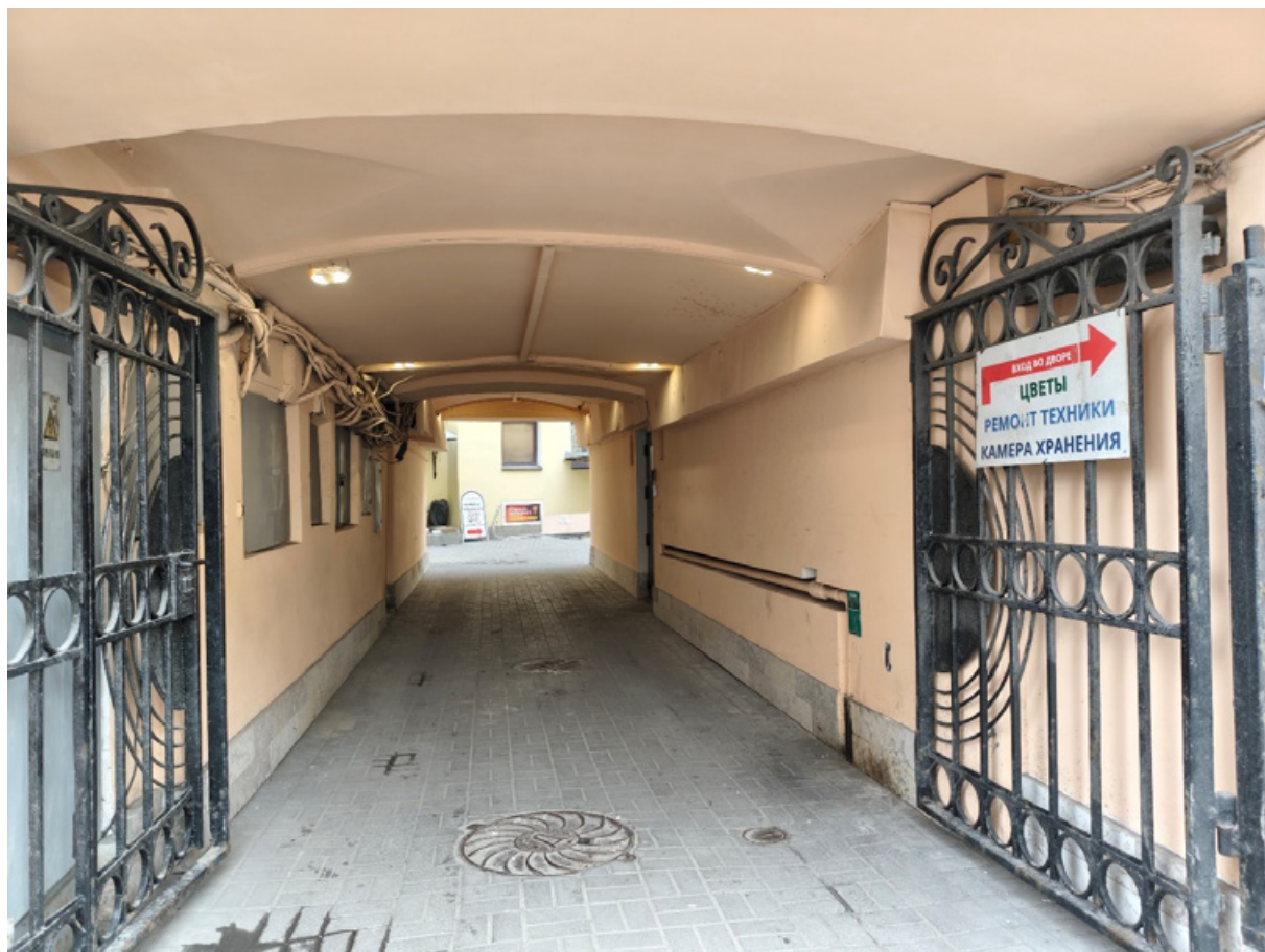
Фото 7. Проездная арка дома по Гончарной улице. Вид с улицы.
