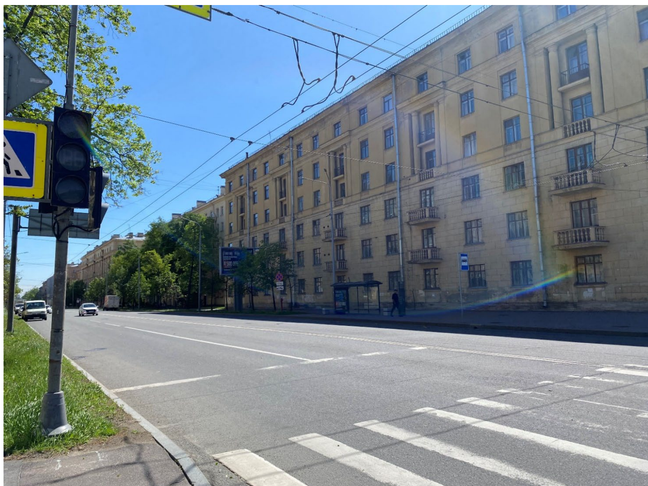
2. Вид на северо-восточные фасады зданий выявленного объекта культурного наследия «Комплекс жилых домов (18 зданий)» от зоны производства работ.
