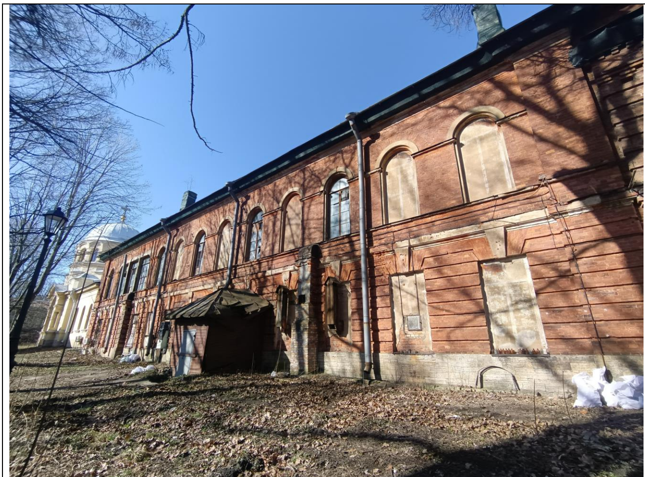
5. «Анатомический театр». Восточный (дворовый) фасад. Общий вид.
