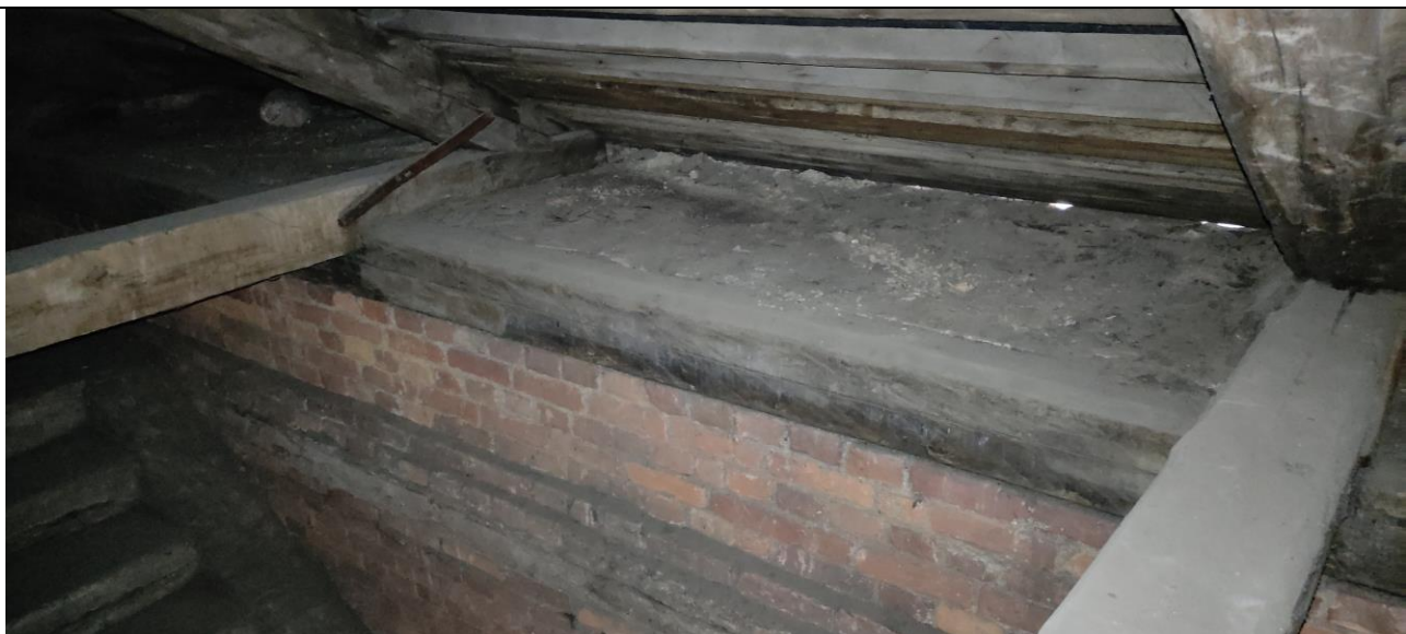
14.Анатомический театр». Стропильная система. Мауэрлат. Фрагмент.
