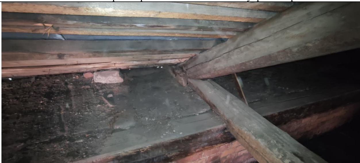
15.Анатомический театр». Стропильная система. Мауэрлат. Фрагмент.
