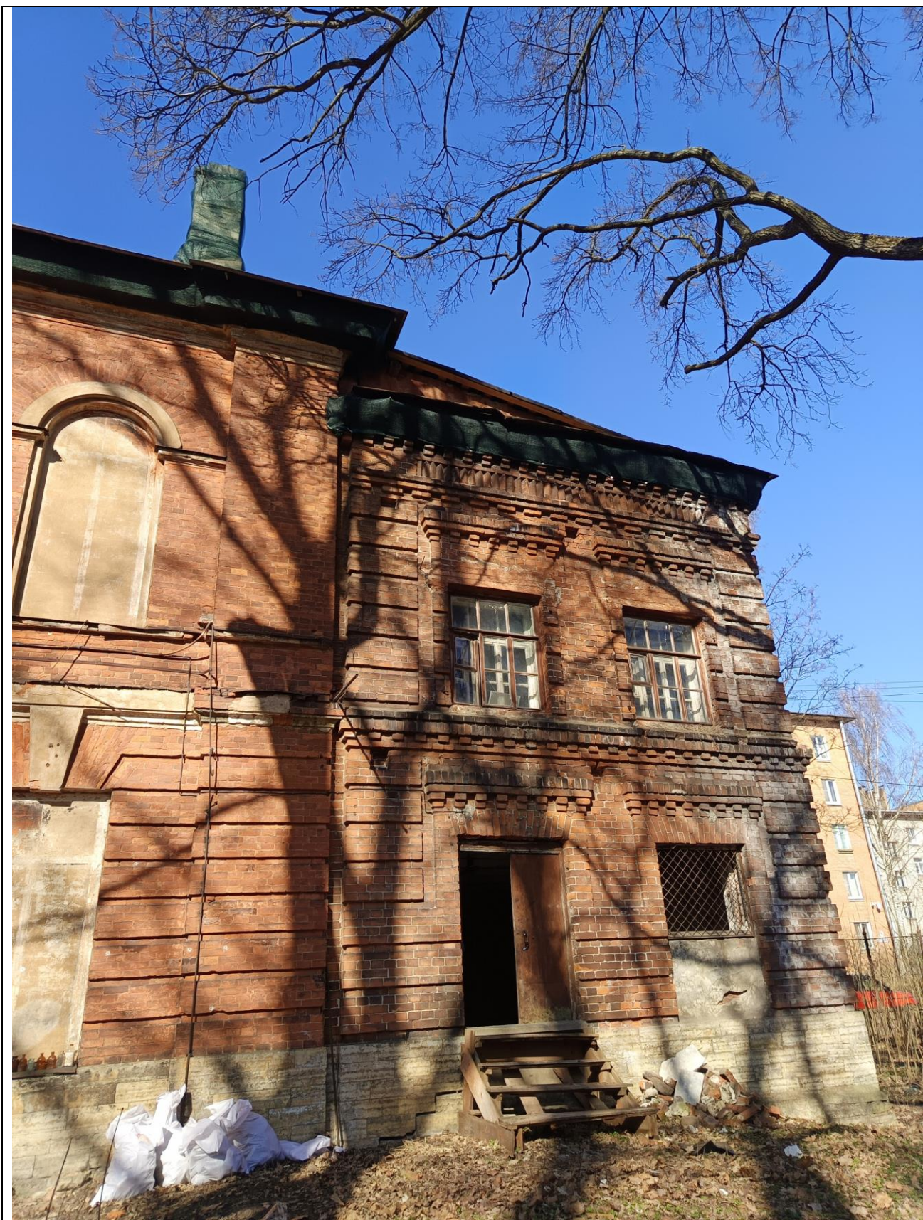
8. «Анатомический театр». Восточный (дворовый) фасад. Двухэтажная пристройка.
