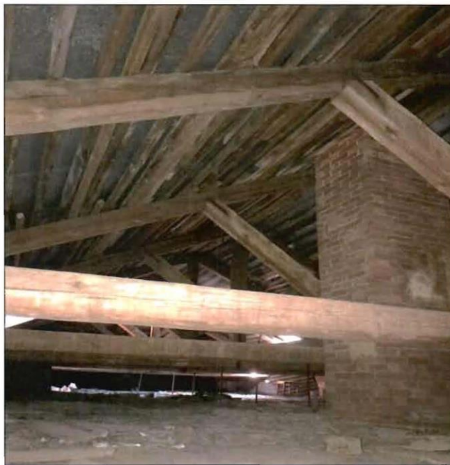
8. Фрагмент стропильной системы.
