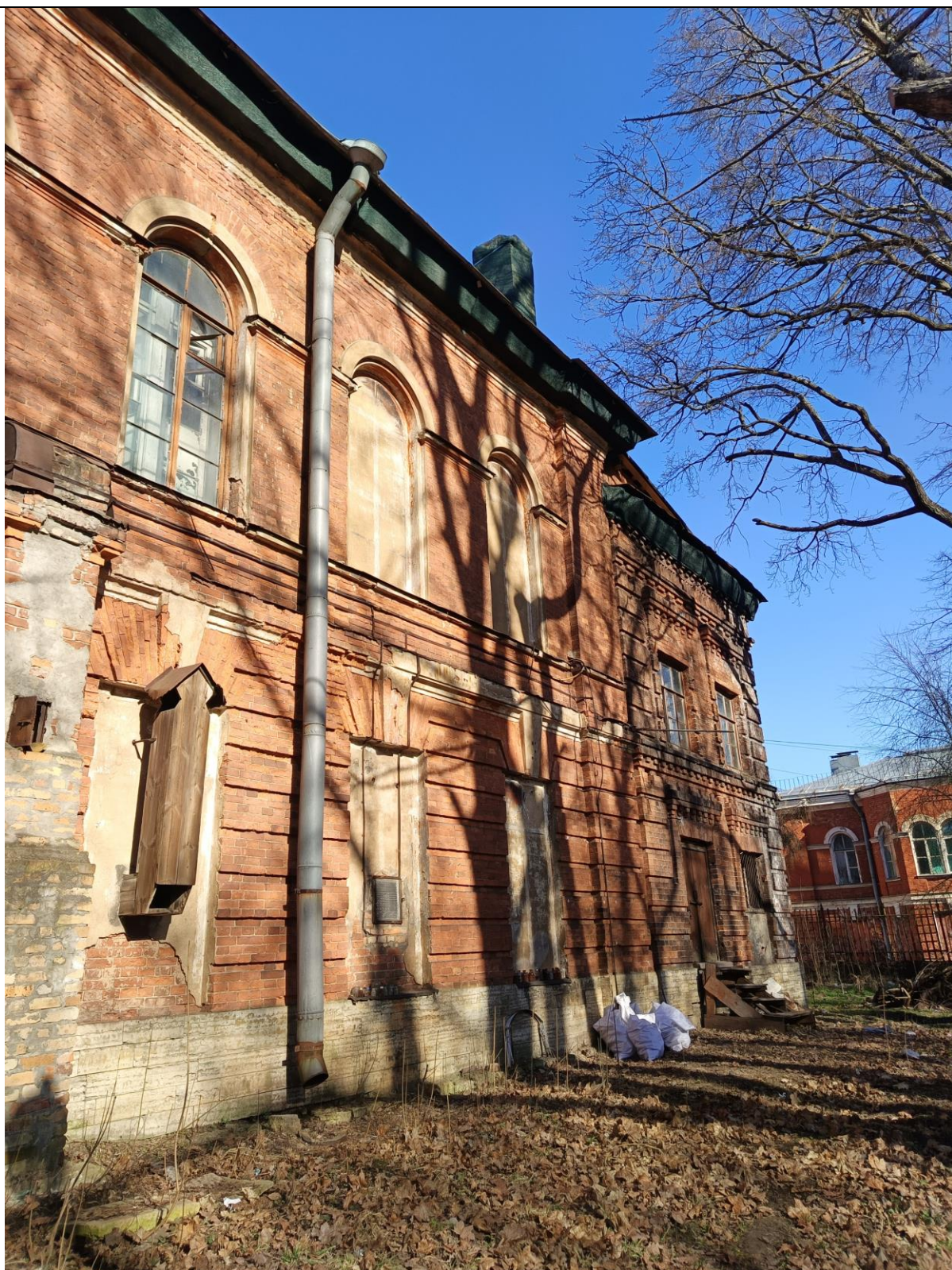
6. «Анатомический театр». Восточный (дворовый) фасад. Двухэтажная пристройка.
