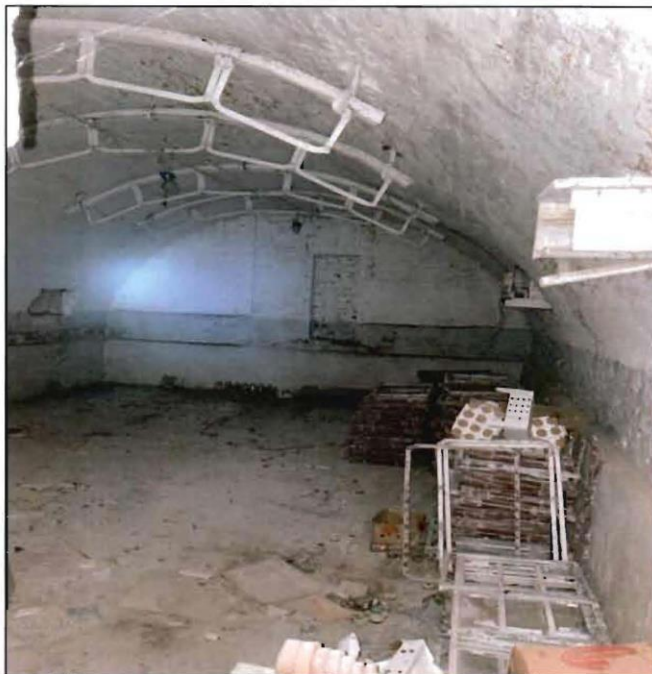
7. Фрагмент подвального помещения.
