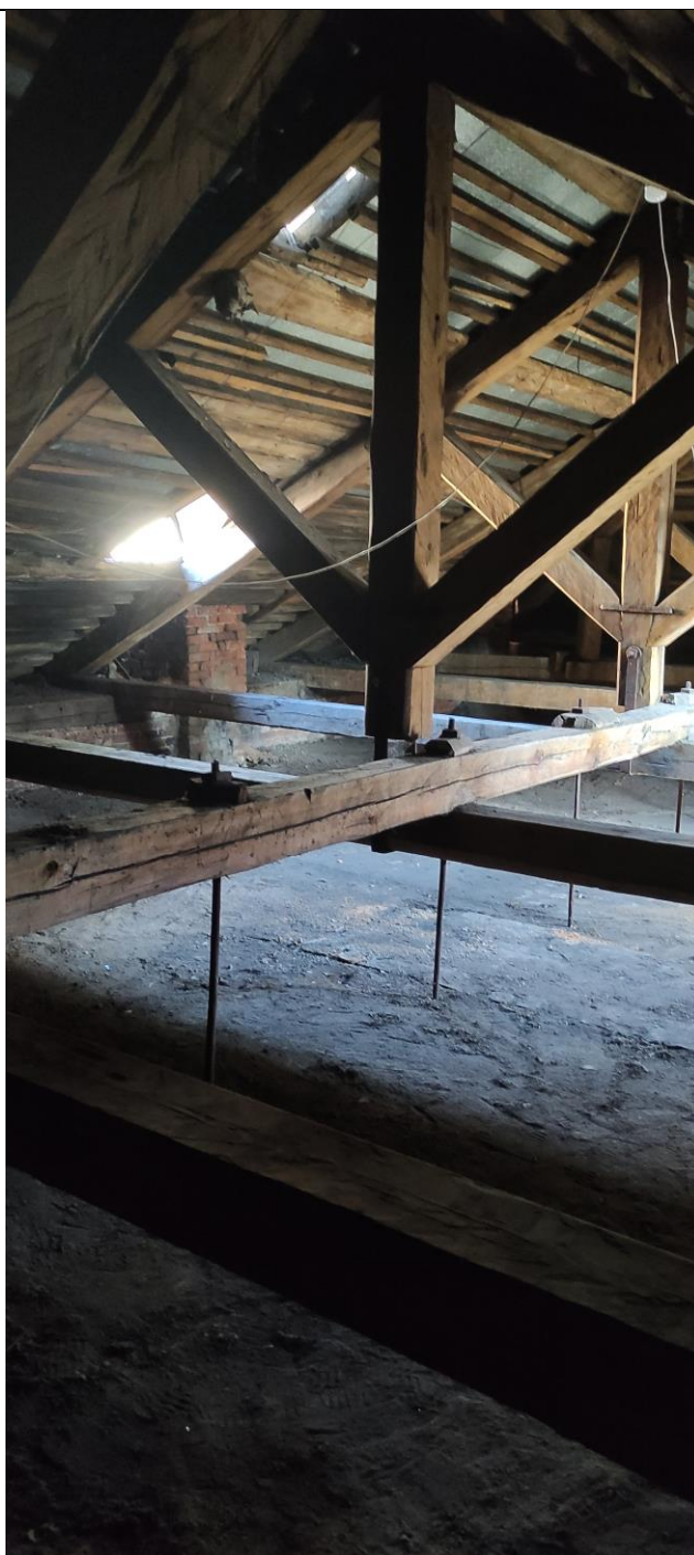
13.Анатомический театр». Стропильная система. Фрагмент.
