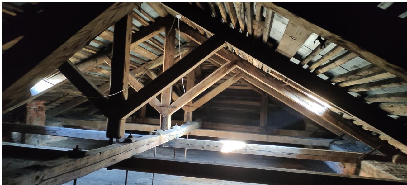
11. «Анатомический театр». Стропильная система. Общий вид.
