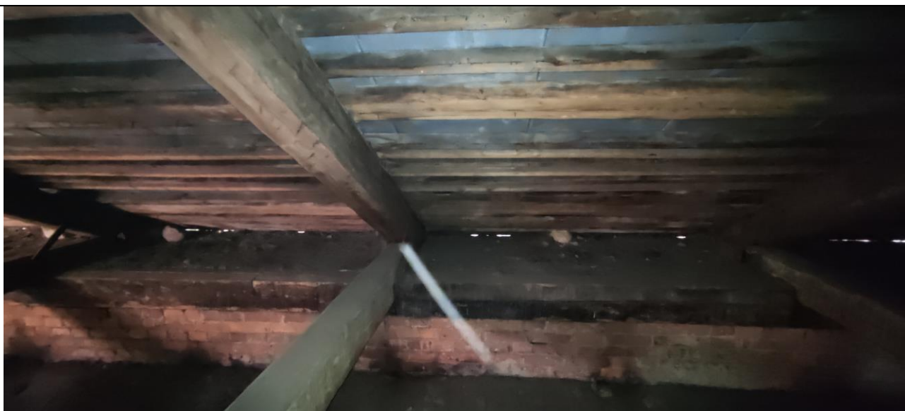
12. «Анатомический театр». Стропильная система. Фрагмент.
