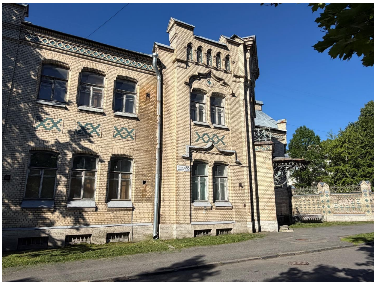
Фото 2. Вид со стороны Московской улицы на объект культурного наследия регионального значения «Усадебный дом А.В. Кокарева», по адресу: Санкт-Петербург, г. Пушкин, Московская ул., 55, лит. А
