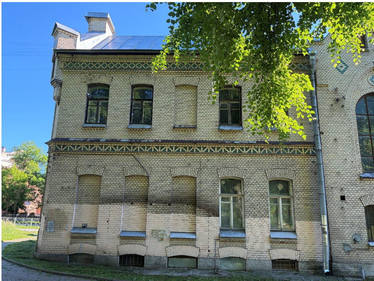
Фото 11. Вид со стороны двора на объект культурного наследия регионального значения «Усадебный дом А.В. Кокорева», по адресу: Санкт-Петербург, г. Пушкин, Московская ул., 55, лит. А
