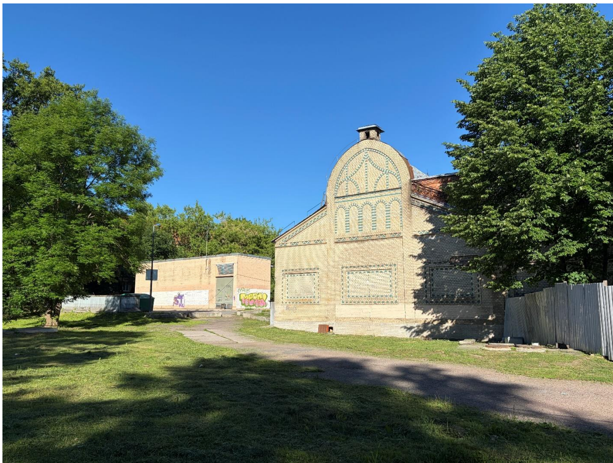
Фото 7. Вид со стороны двора на объект культурного наследия регионального значения «Усадебный дом А.В. Кокорева», по адресу: Санкт-Петербург, г. Пушкин, Московская ул., 55, лит. А
