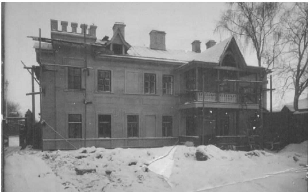
15. Усадьба. А.В. Кокорева. Новопостроенный дом. Фотография. 1902 г. ГМИ СПб. КП-59-588.
