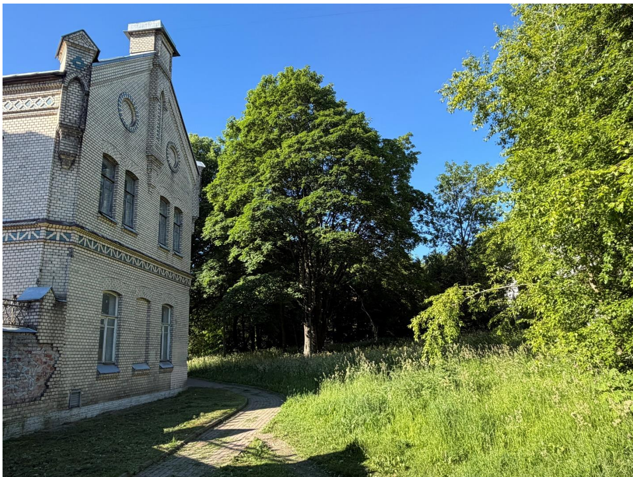
Фото 14. Вид объект культурного наследия регионального значения «Усадебный дом А.В. Кокарева», по адресу: Санкт-Петербург, г. Пушкин, Московская ул., 55, лит. А
