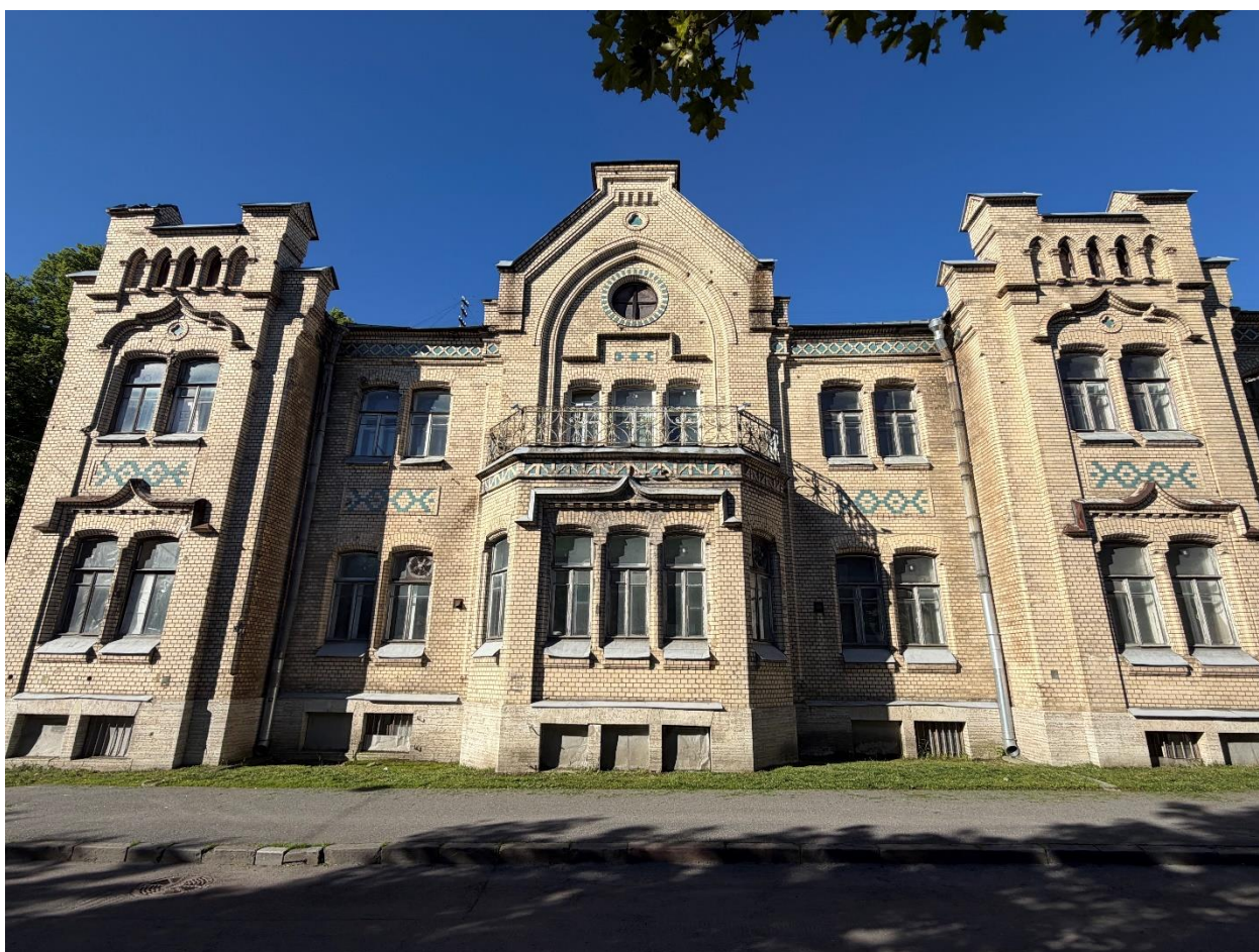
Фото 4. Вид со стороны Московской улицы на объект культурного наследия регионального значения «Усадьбный дом А.В. Кокорева», по адресу: Санкт-Петербург, г. Пушкин, Московская ул., 55, лит. А
