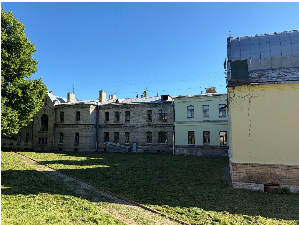
Фото 8. Вид со стороны двора на объект культурного наследия регионального значения «Усадебный дом А.В. Кокорева», по адресу: Санкт-Петербург, г. Пушкин, Московская ул., 55, лит. А
