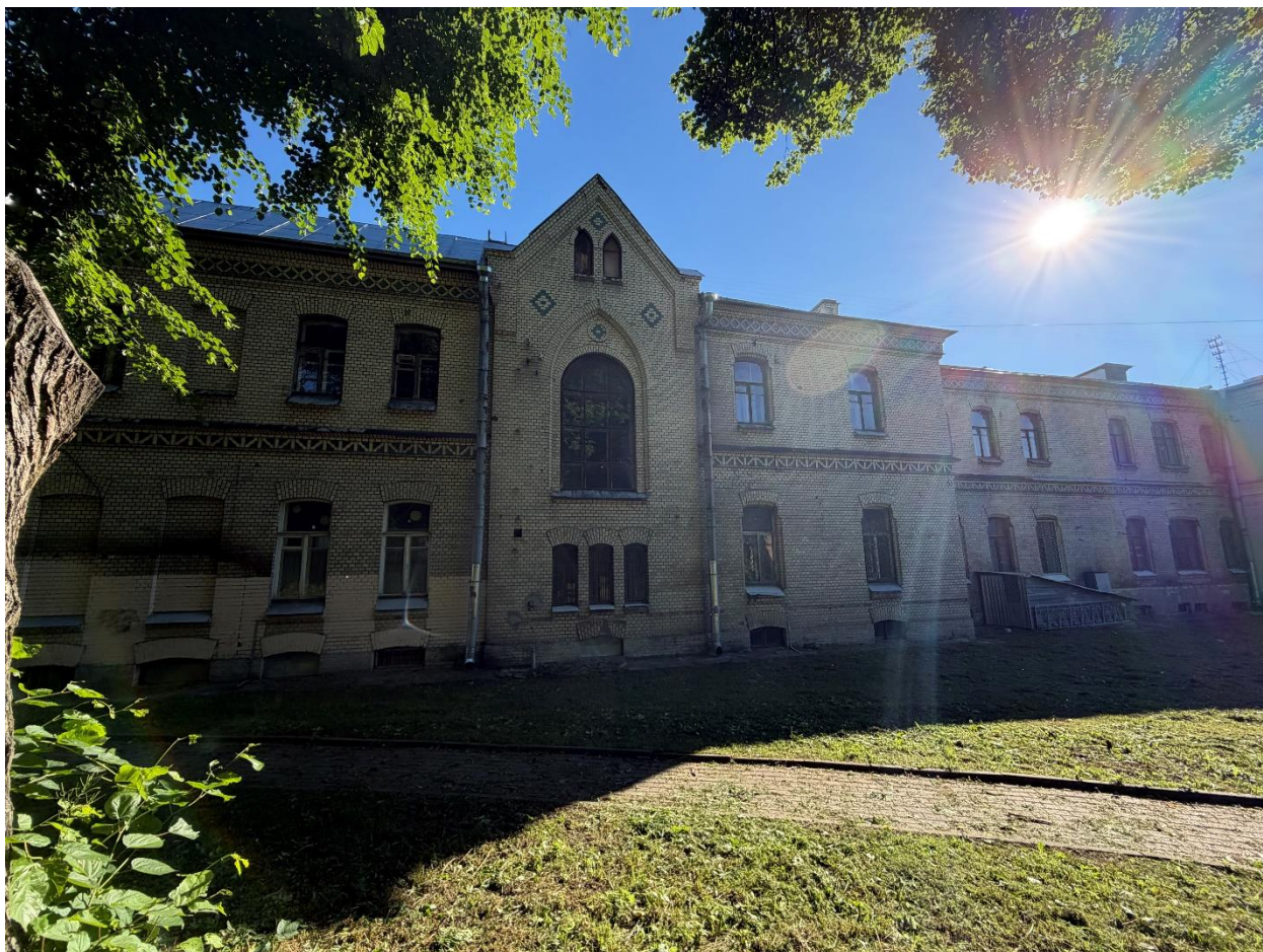
Фото 10. Вид со стороны двора на объект культурного наследия регионального значения «Усадебный дом А.В. Кокорева», по адресу: Санкт-Петербург, г. Пушкин, Московская ул., 55, лит. А
