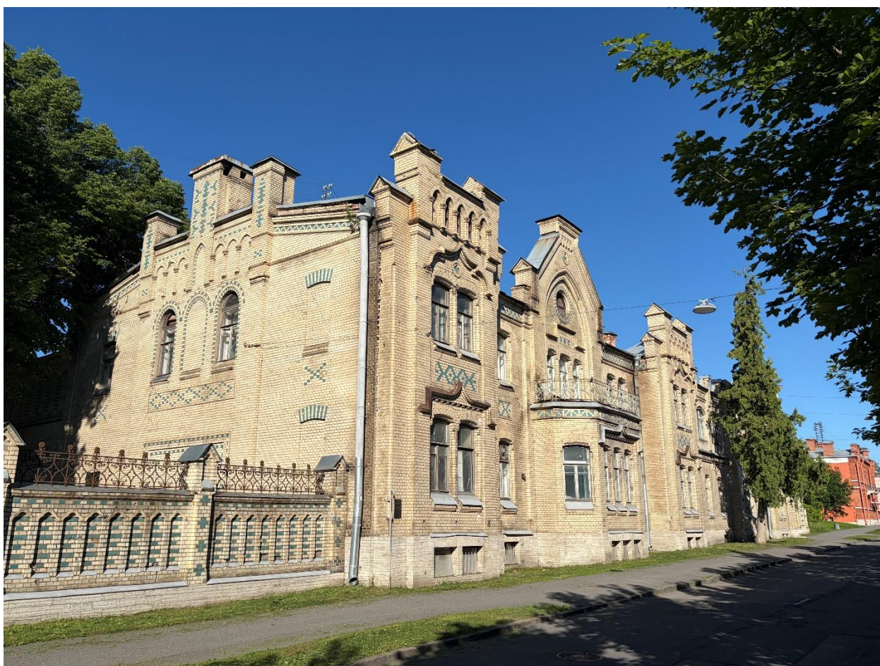
Фото 5. Вид со стороны Московской улицы на объект культурного наследия регионального значения «Усадебный дом А.В. Кокарева», по адресу: Санкт-Петербург, г. Пушкин, Московская ул., 55, лит. А
