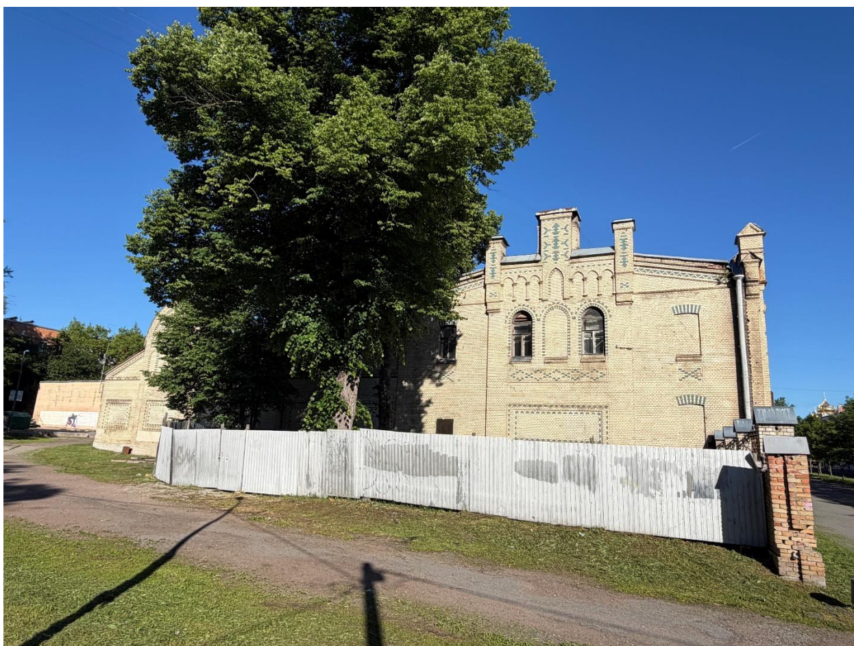
Фото 6. Вид со стороны двора на объект культурного наследия регионального значения «Усадебный дом А.В. Кокорева», по адресу: Санкт-Петербург, г. Пушкин, Московская ул., 55, лит. А
