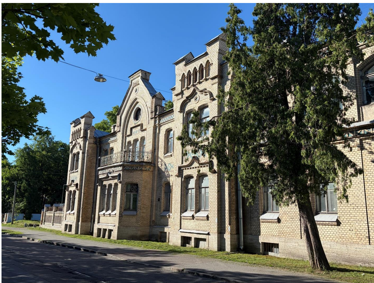
Фото 3. Вид со стороны Московской улицы на объект культурного наследия регионального значения «Усадьбный дом А.В. Кокарева», по адресу: Санкт-Петербург, г. Пушкин, Московская ул., 55, лит. А
