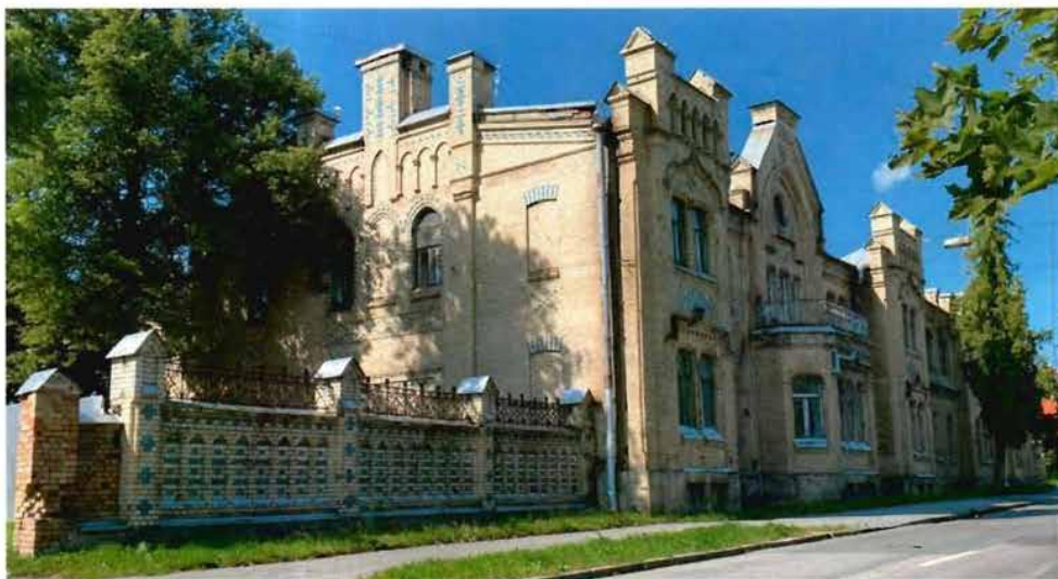
2. Общий вид на лицевой северо-восточный и торцевой юго-восточный фасады.
