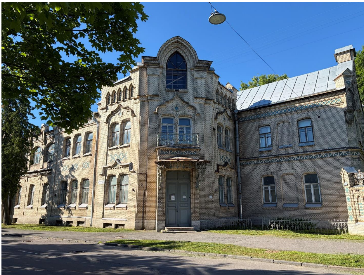
Фото 1. Вид со стороны Московской улицы на объект культурного наследия регионального значения «Усадебный дом А.В. Кокорева», по адресу: Санкт-Петербург, г. Пушкин, Московская ул., 55, лит. А
