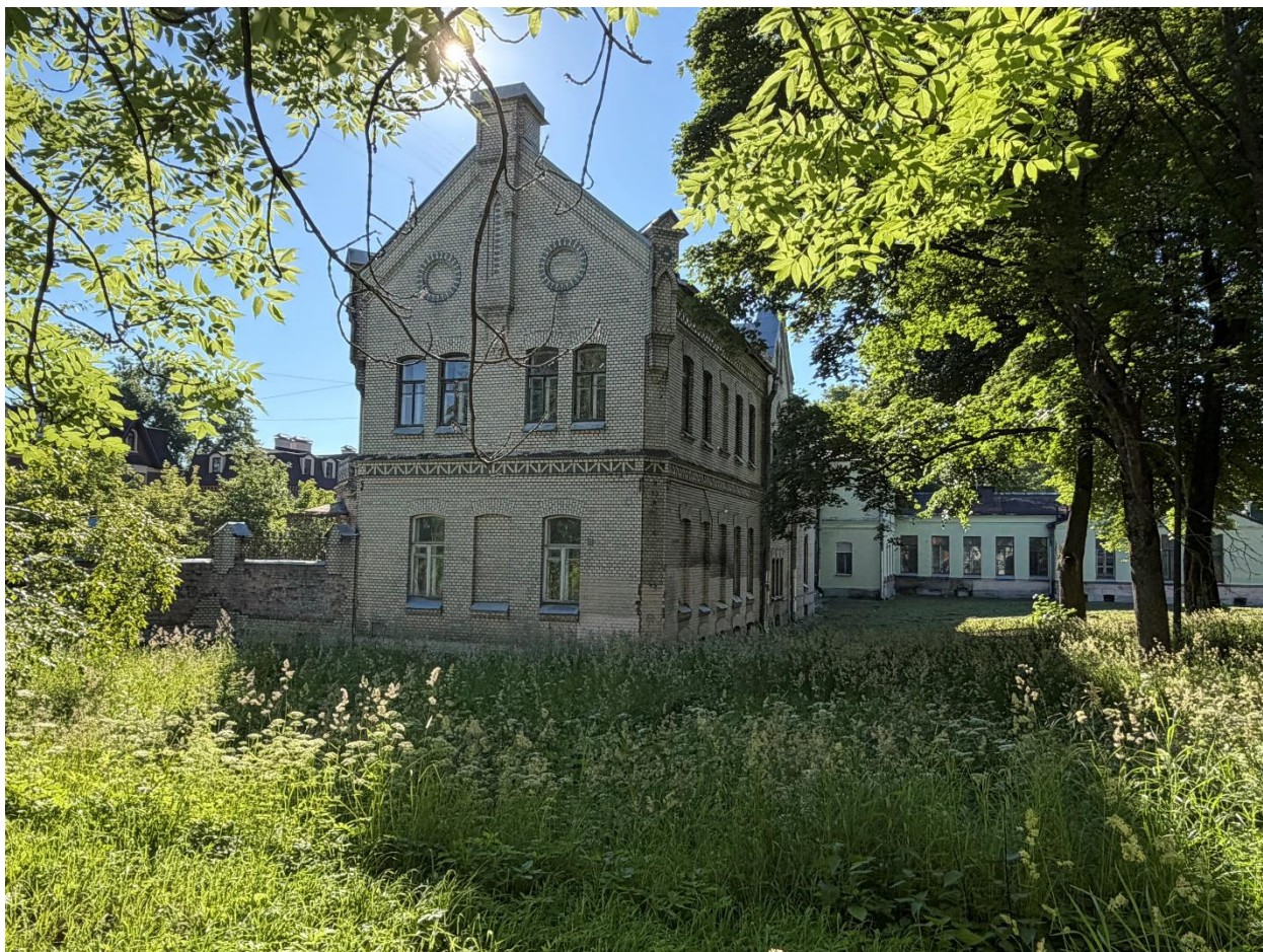
Фото 18. Вид со стороны двора на объект культурного наследия регионального значения «Усадебный дом А.В. Кокорева», по адресу: Санкт-Петербург, г. Пушкин, Московская ул., 55, лит. А
