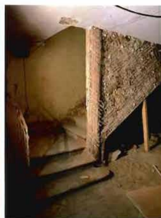
16. Лестница в подвал.
