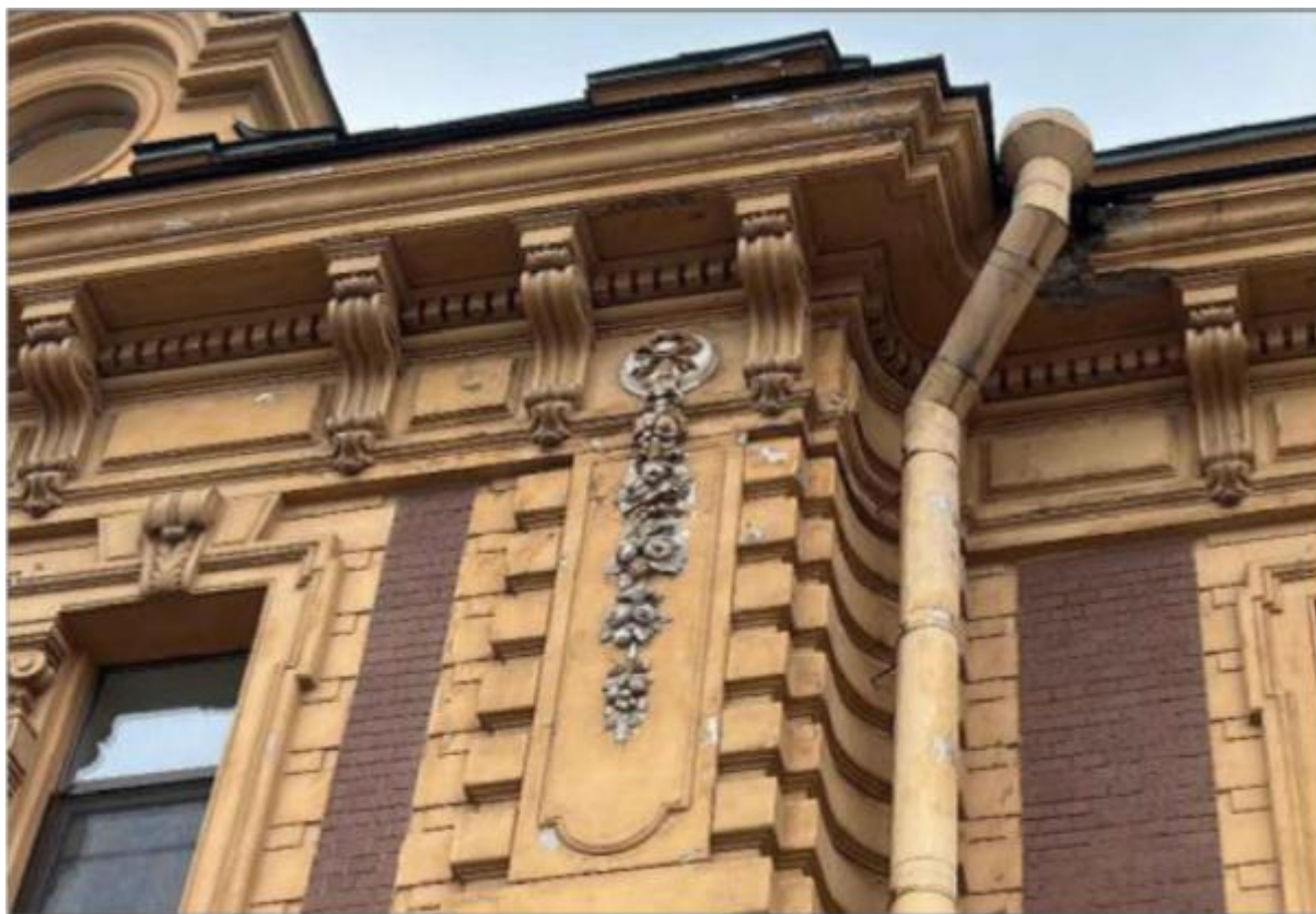
Фото 6. Объект культурного наследия регионального значения «Дом Товарищества русских паровых маслобоек с палисадником и оградой», расположенный по адресу: г. Санкт-Петербург, Курляндская, дом 41. Литера А. Лицевой фасад, венчающий профилированный раскрепованный карниз на каннелированных кронштейнах.
