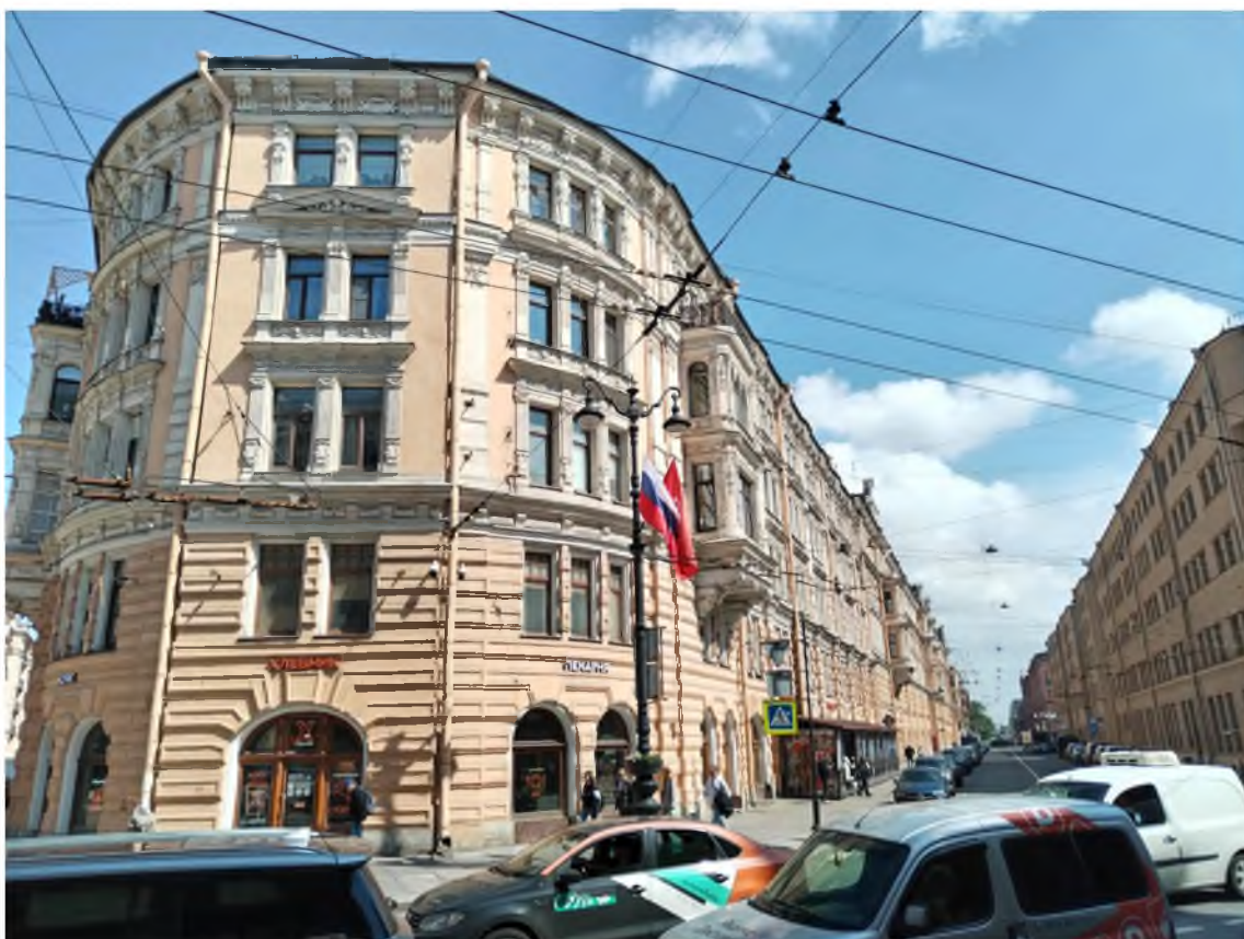
4. Вид на юго-восточный фасад здания с юго-запада.
