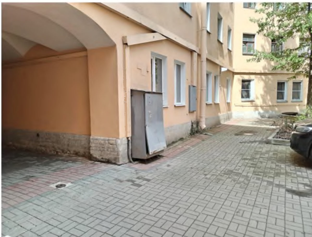
8. Вид на южную часть восточного фасада флигеля в уровне 1-го этажа с юго-востока.
