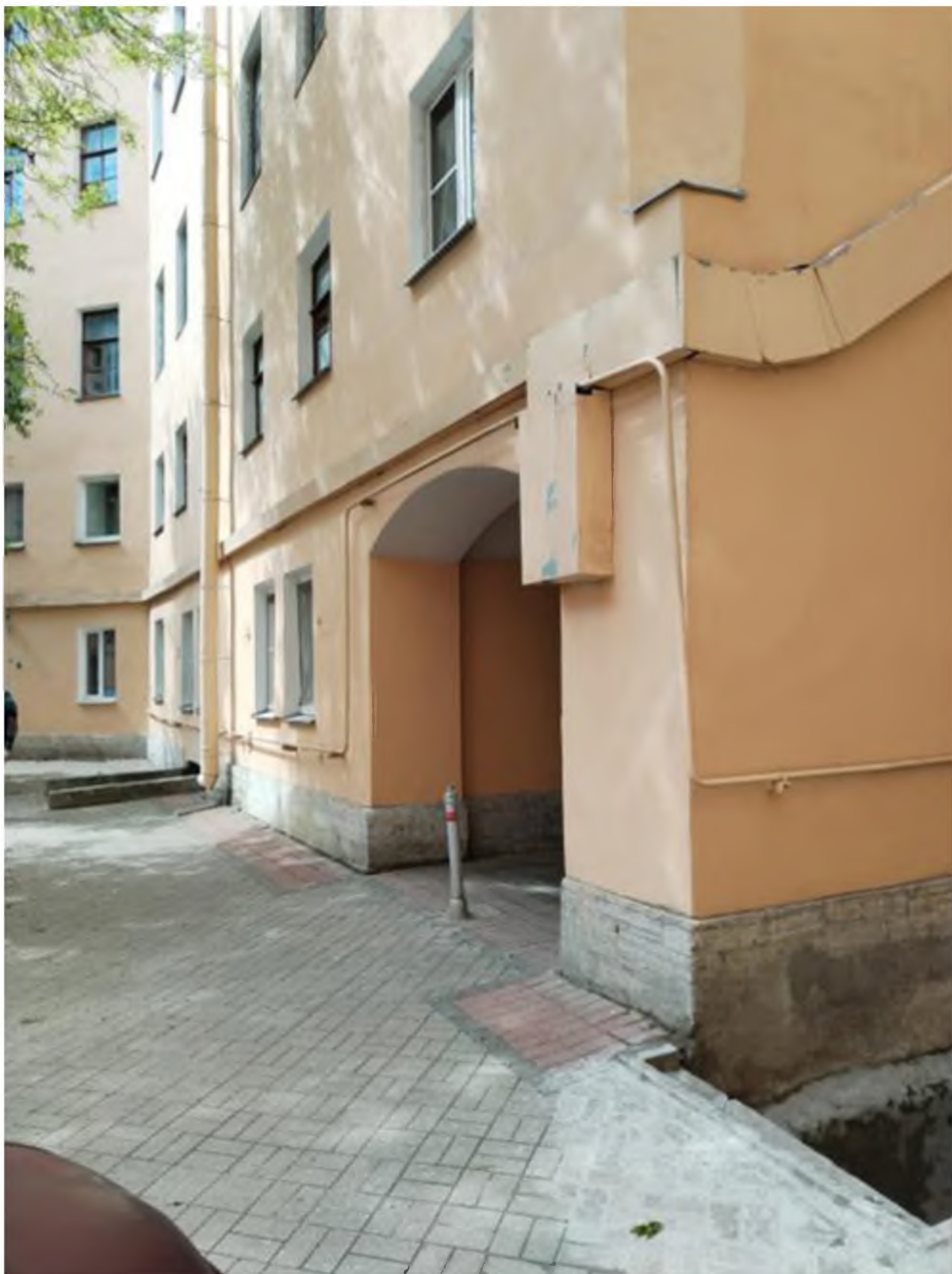
10. Вид на северную часть восточного фасада флигеля в уровне 1-го этажа с северо-востока.
