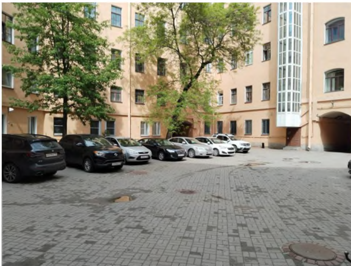
7. Вид на северо-западный угол восточного двора здания.
