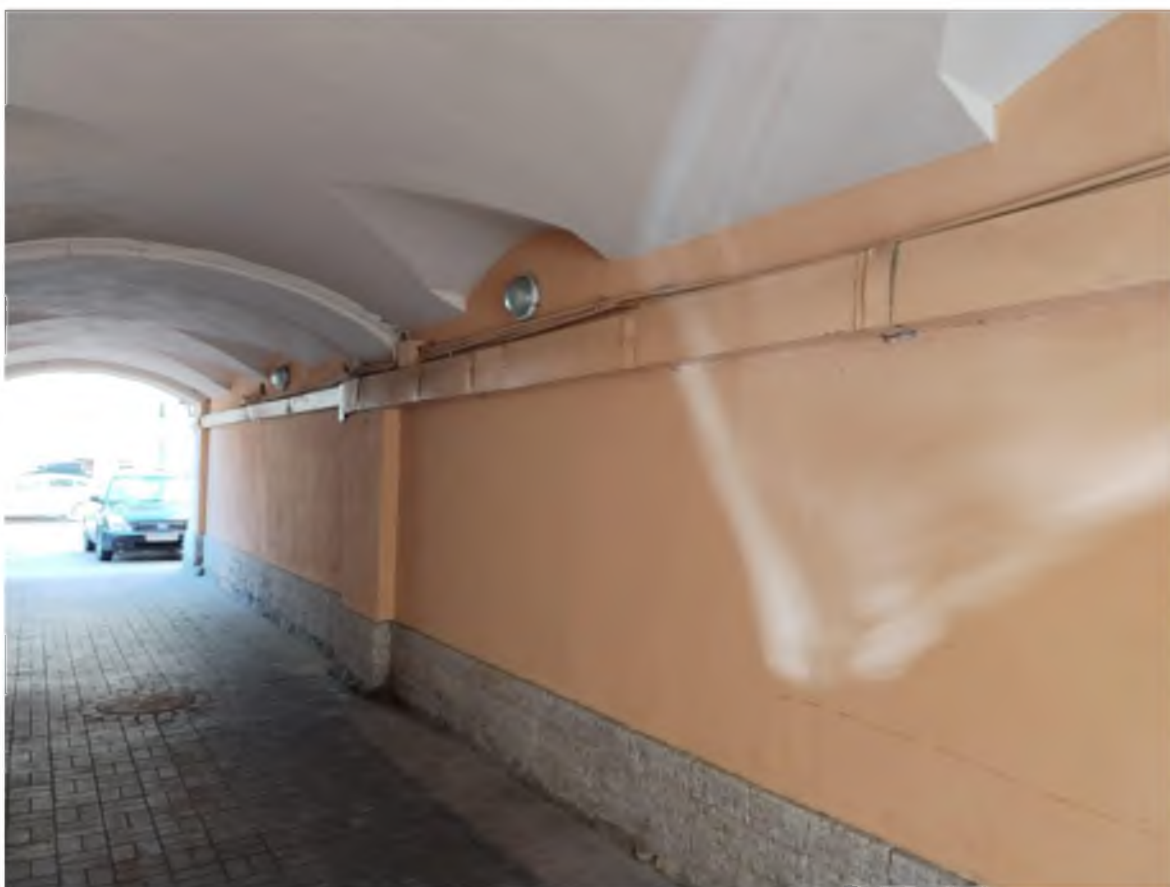
12. Вид на северную стенку северного проезда флигеля.
