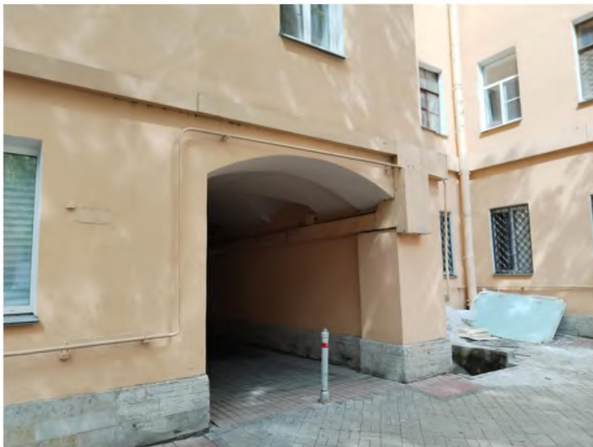
11. Вид на арку северного проезда флигеля.
