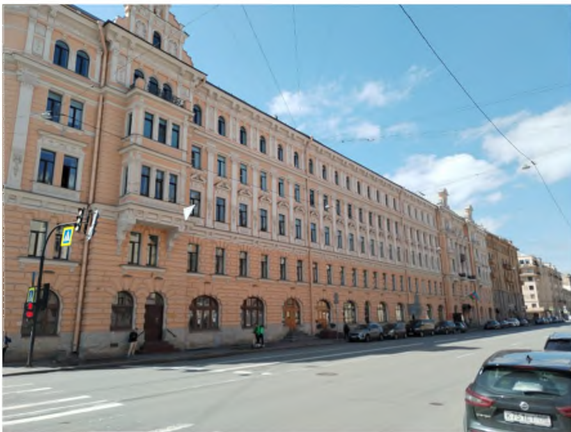
3. Вид на северо-восточный фасад здания с северо-востока.
