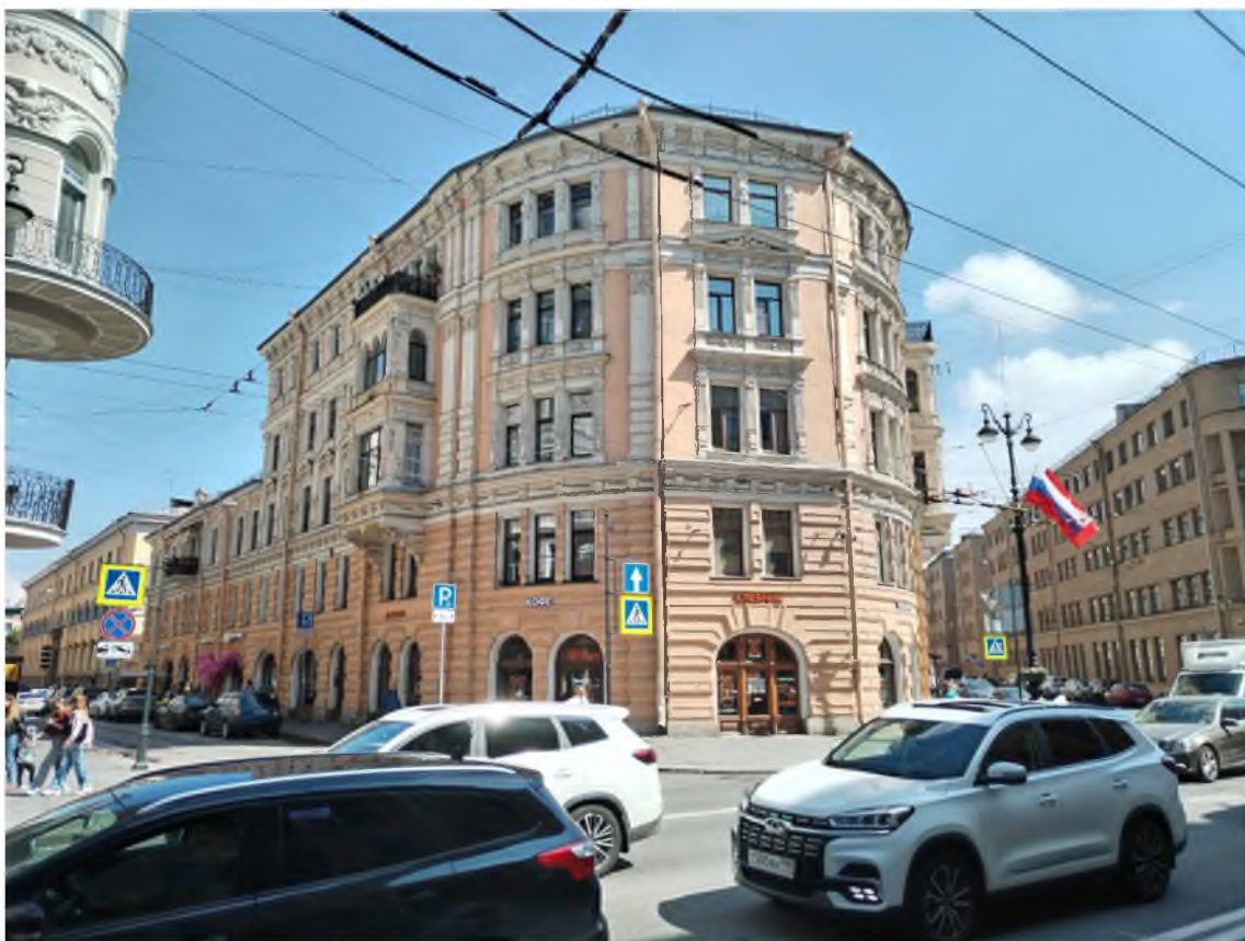
5. Вид на северо-западный фасад здания с юго-запада.
