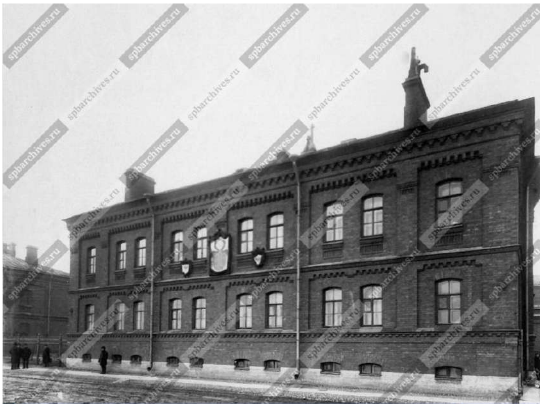
116. Фасад жилого дома для надзирателей (совр. лит. П). 1913 г. // ЦГА КФФД СПб. Фотодокументы. Оп. 1Е-11. Ед.хр.9767.
