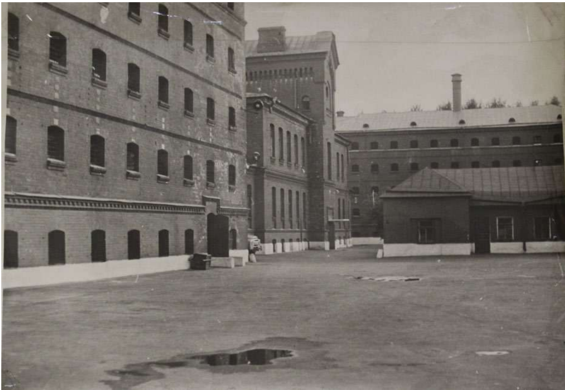
194. Вход на второй режимный корпус с внутреннего двора. Справа – домик хозяйственной части (совр. лит. Т). Б/д [2-я пол. XX в.]. Слева – часть первого режимного корпуса и дворовый фасад административного здания с церковью Св. Александра Невского. // Музей ФКУ СИЗО-1 УФСИН России по СПб и ЛО.
