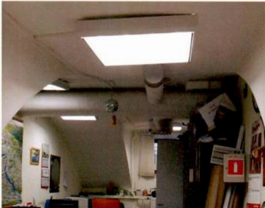
9. Своды подвальных помещений.
