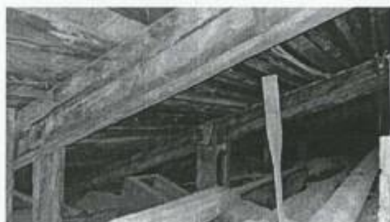
Вид деревянных конструкций кровли чердака
