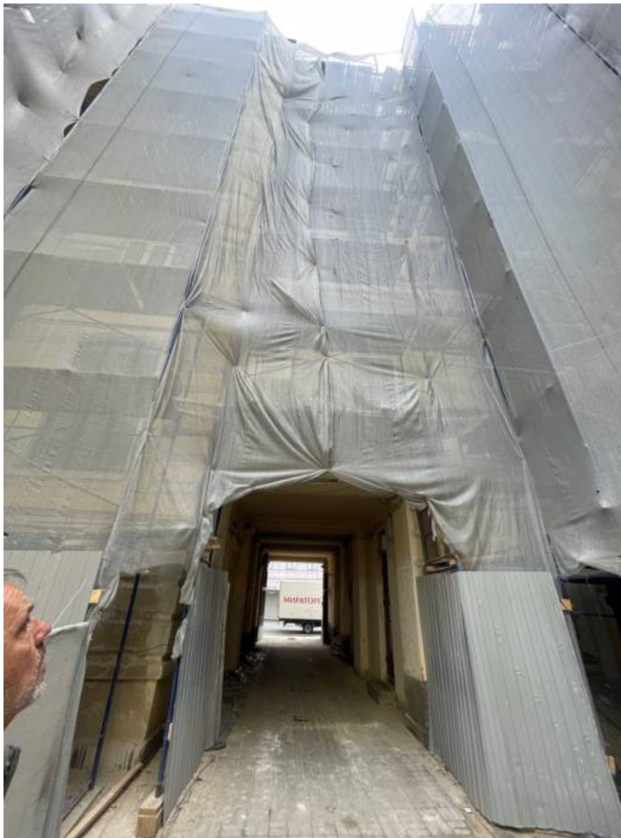
3. Фрагмент дворового фасада.
