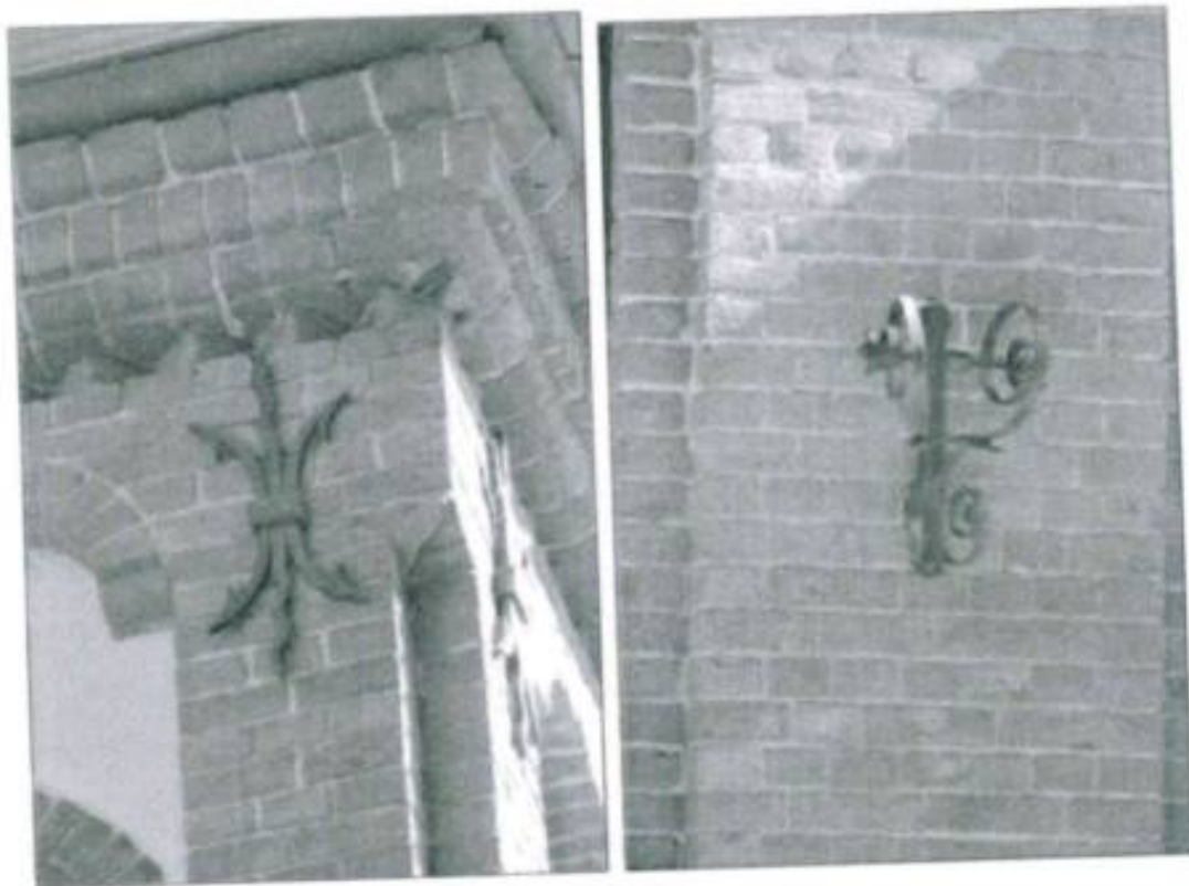
3-4. Главный фасад. Фрагмент. Металлодекор.
