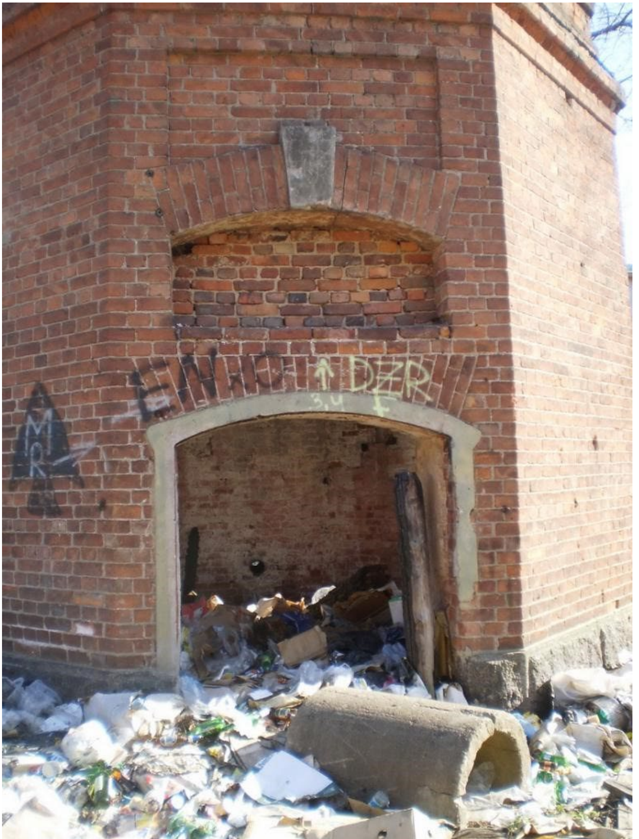
10. Частично заложённый дверной проем южного фасада. Фото 2011 г. https://www.citywalls.ru/house22859.html
