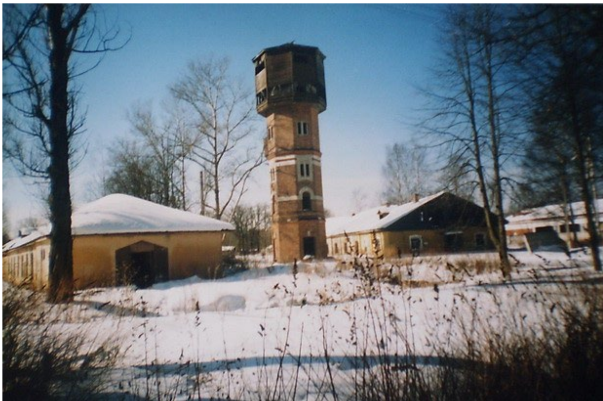
8. Вид на башню с востока. Присутствует деревянная обшивка 4-го яруса. Фото 2004 г. https://www.citywalls.ru/house22859.html
