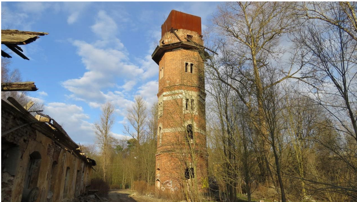
18. Вид на башню с юго-востока. Фото май 2017 г. https://www.citywalls.ru/house22859.html
