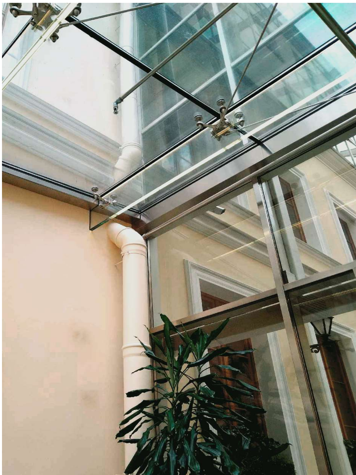
Фото 19. Фрагмент дворового фасада объекта.
