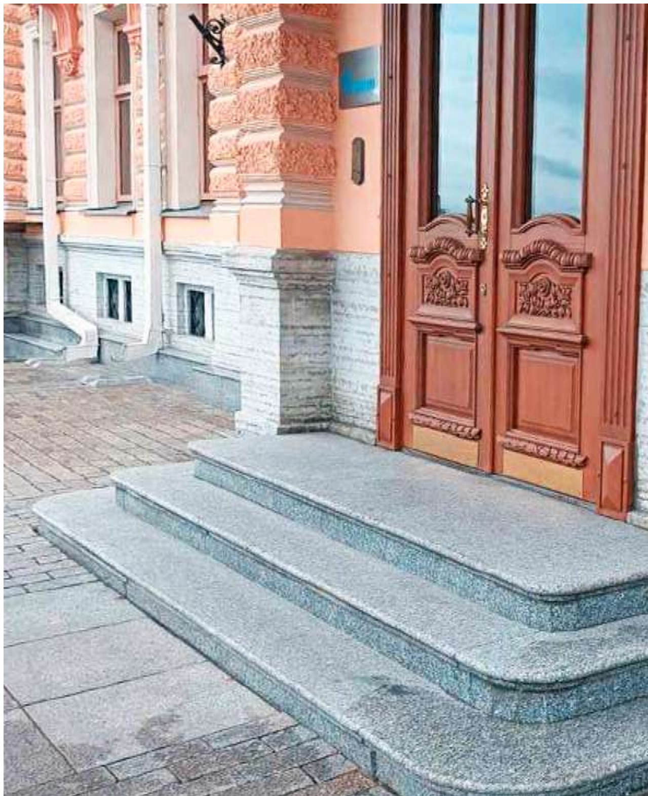
Фото 11. Фрагмент лицевого фасада объекта с Английской наб.
