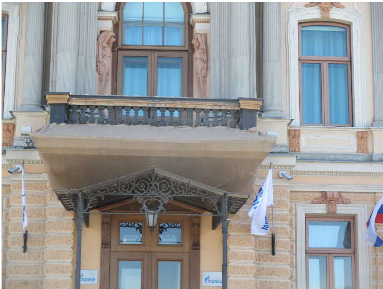
Фото 3. Фрагмент лицевого фасада объекта с Английской наб.
