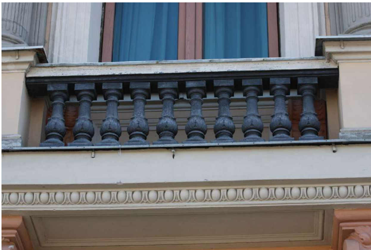
Фото 4. Фрагмент лицевого фасада объекта с Английской наб.
