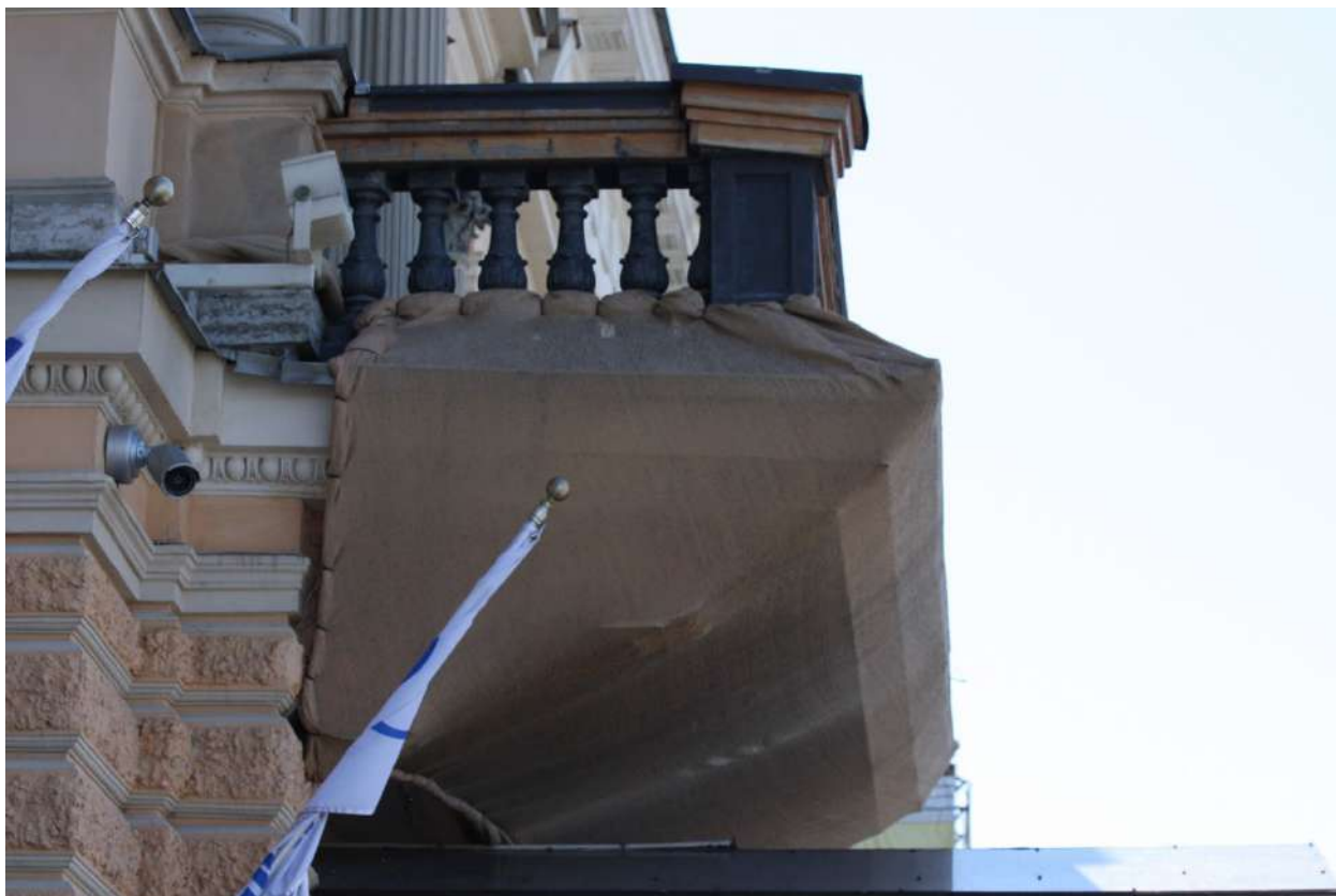
Фото 7. Фрагмент лицевого фасада объекта с Английской наб.
