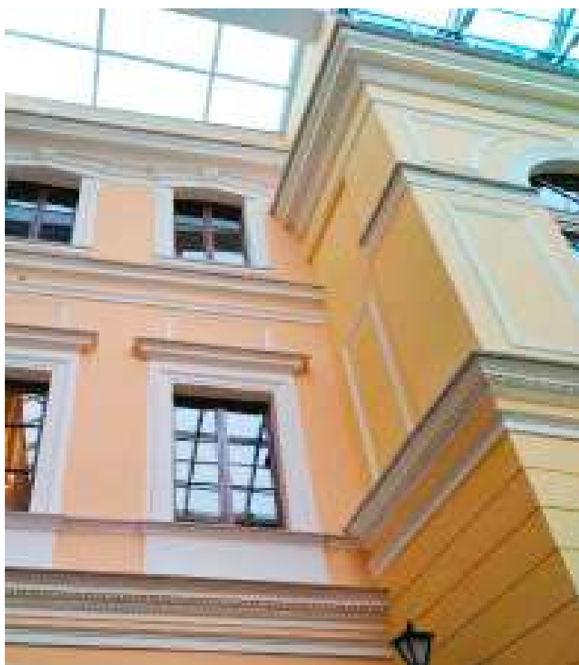
Фото 18. Фрагмент дворового фасада объекта.
