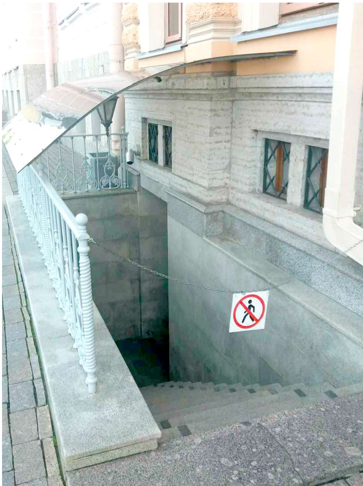
Фото 9. Фрагмент лицевого фасада объекта с Английской наб.
