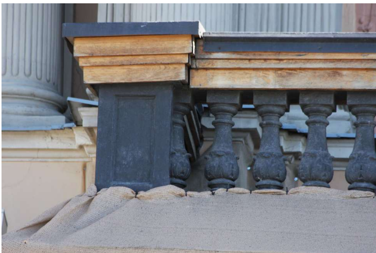
Фото 6. Фрагмент лицевого фасада объекта с Английской наб.
