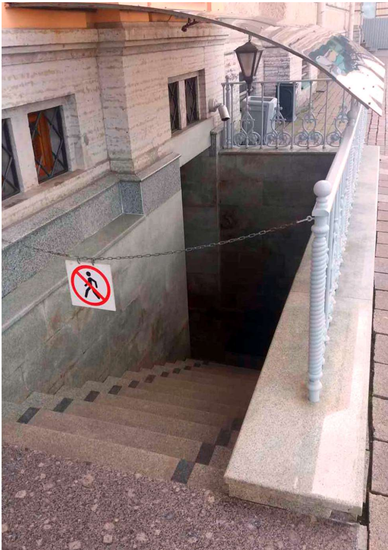
Фото 10. Фрагмент лицевого фасада объекта с Английской наб.
