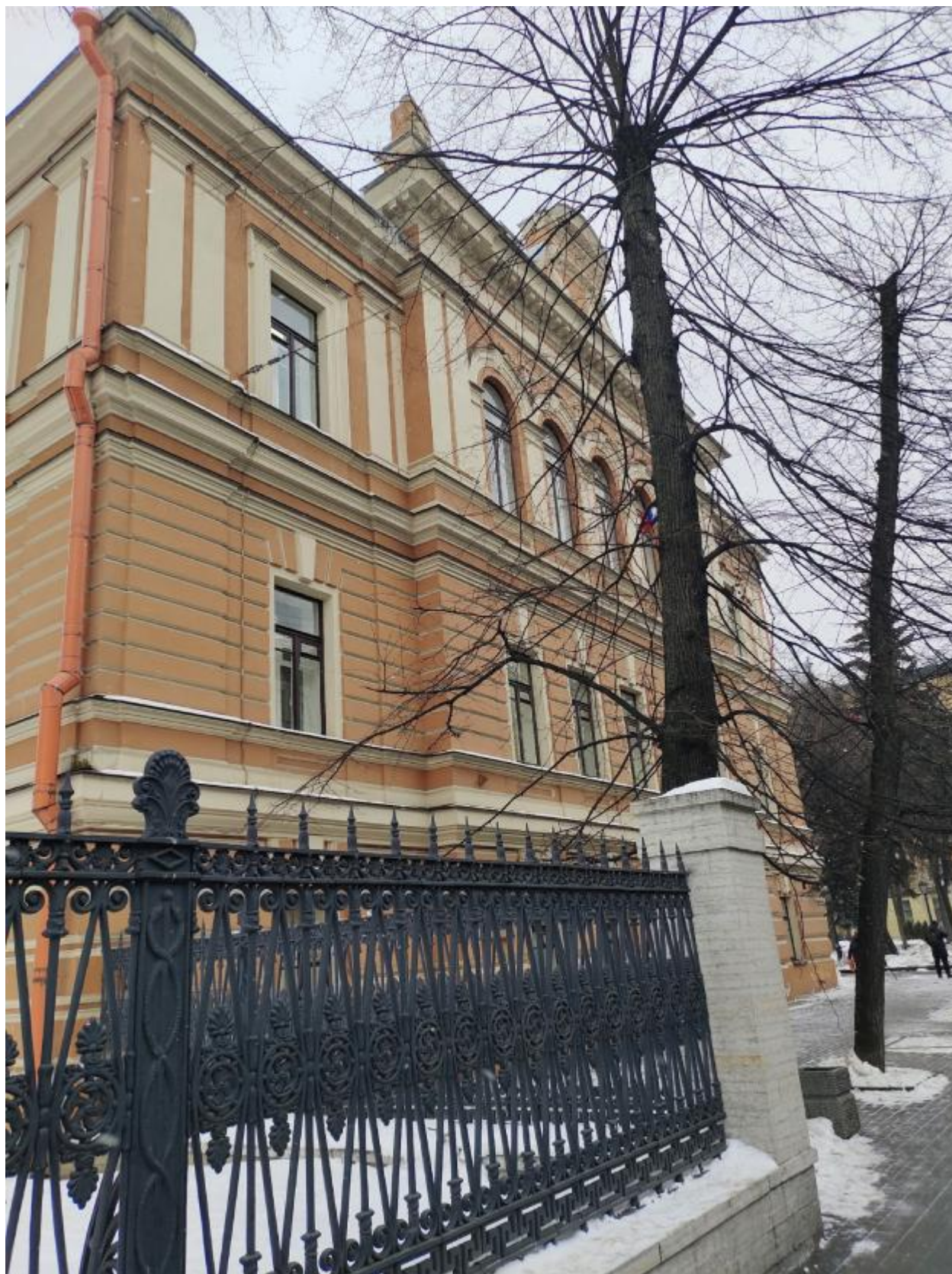
6. Объект культурного наследия, регионального значения «Правление и склад Общества спасения на водах», по адресу улица Садовая, дом 50б. Главный северный фасад, вид с северо-востока.
