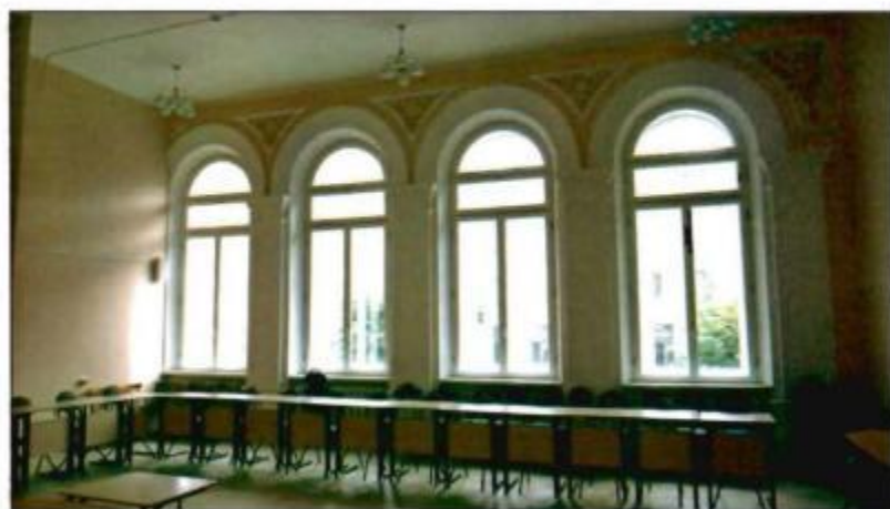
9. Оформление оконных проемов в помещении третьего этажа.
