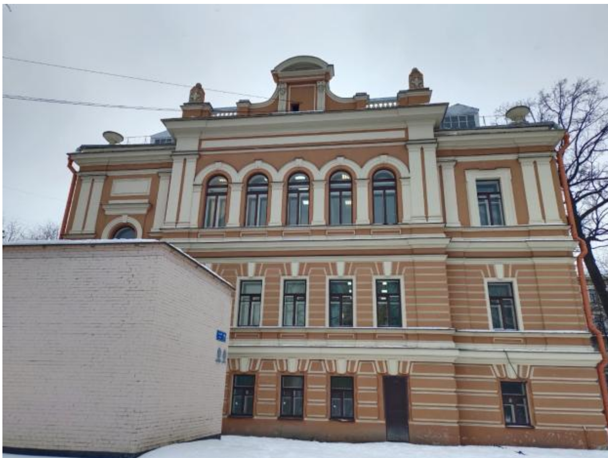
11. Объект культурного наследия, регионального значения «Правление и склад Общества спасения на водах», по адресу улица Садовая, дом 50б. Южный фасад, вид с юга.
