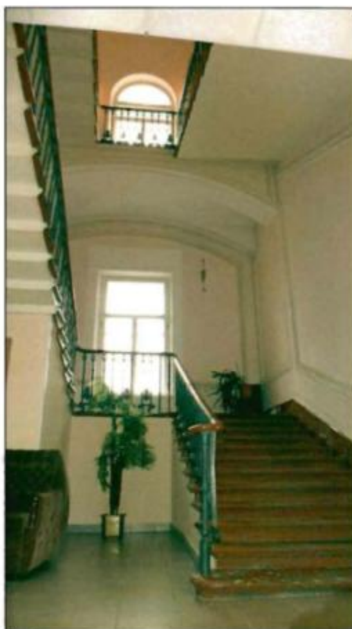
5. Парадная лестница в уровне первого этажа.
