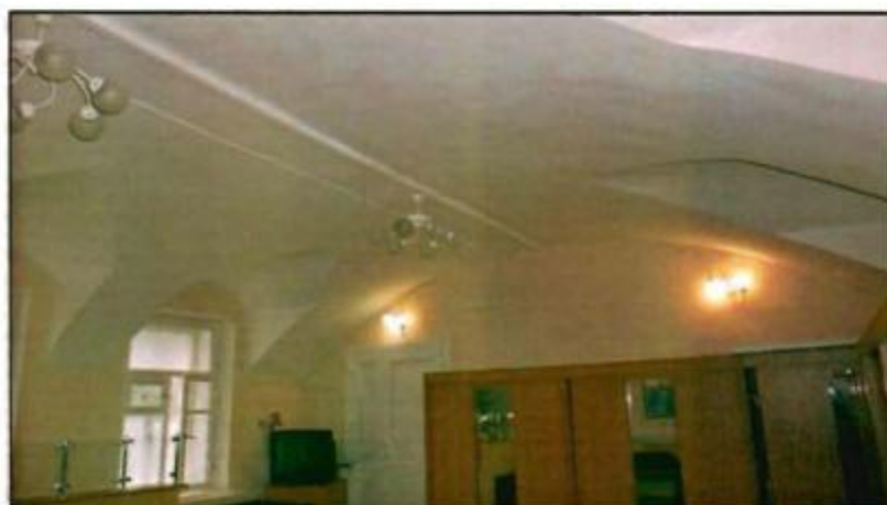
8. Сводчатые перекрытия в уровне первого этажа.
