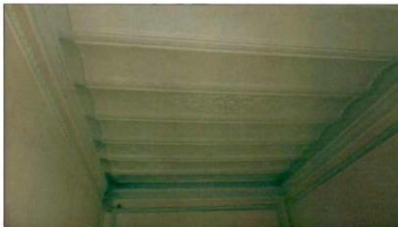
7. Лепное оформление потолка над парадной лестницей.
