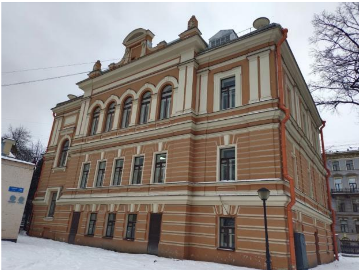
10. Объект культурного наследия, регионального значения «Правление и склад Общества спасения на водах», по адресу улица Садовая, дом 506. Южный и восточный фасады, вид с юго-востока.
