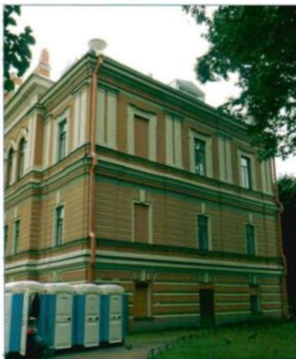
4. Северо-восточный фасад. Вид с востока.
