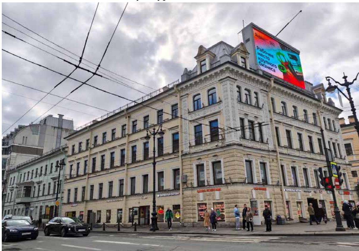
Фото 2. Общий вид с северо-запада.
