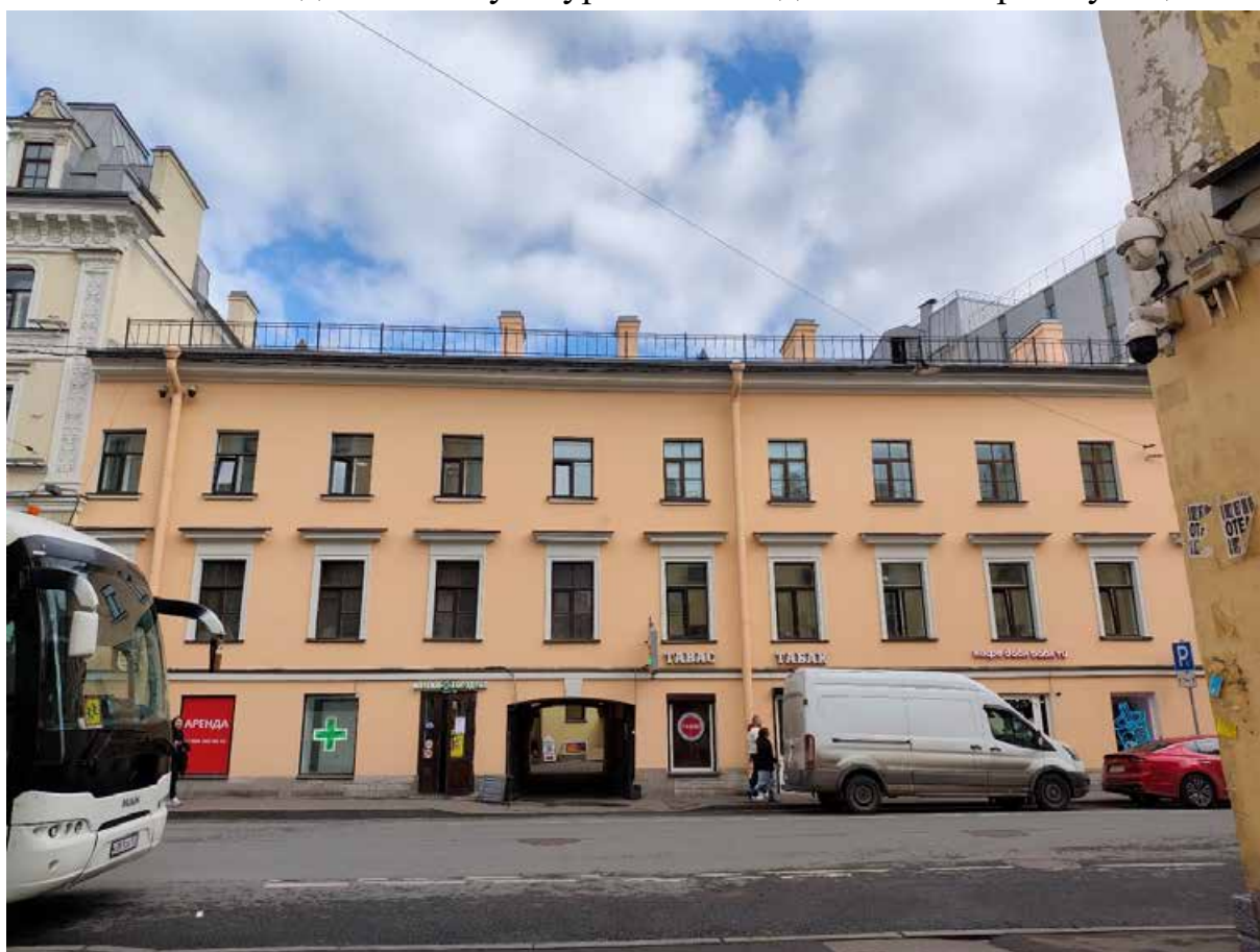
Фото 6. Фасад дома по Гончарной улице.
