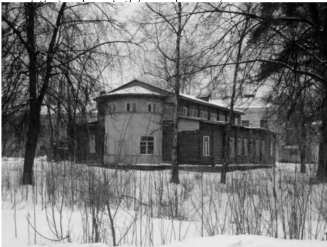
15. Фото храма на период начала 2000-х гг. — Церковь свт. Спиридона Тримифунтского // Citywalls.ru – архитектурный сайт Петербурга [Электронный ресурс]. URL: https://www.citywalls.ru/house23742.html .
