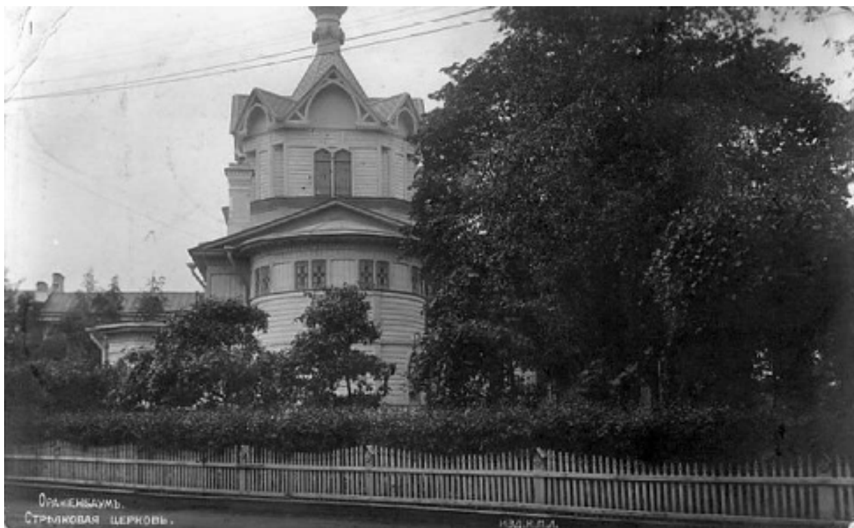
10. Церковь свт. Спиридона Тримифунтского. Фото 1900-х гг. — Церковь свт. Спиридона Тримифунтского // Citywalls.ru – архитектурный сайт Петербурга [Электронный ресурс]. URL: https://www.citywalls.ru/house23742.html .
