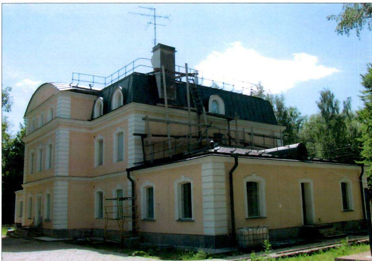
2. «Главный корпус хозяйственного двора». Общий вид с севера.
