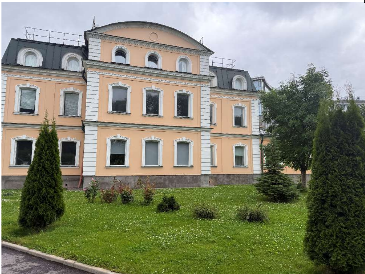
Фото 3. Общий вид на объект.
