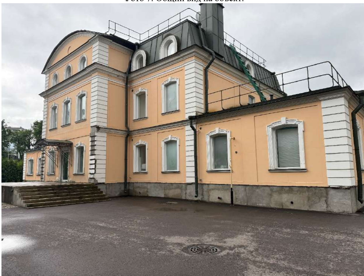
Фото 8. Общий вид на объект.
