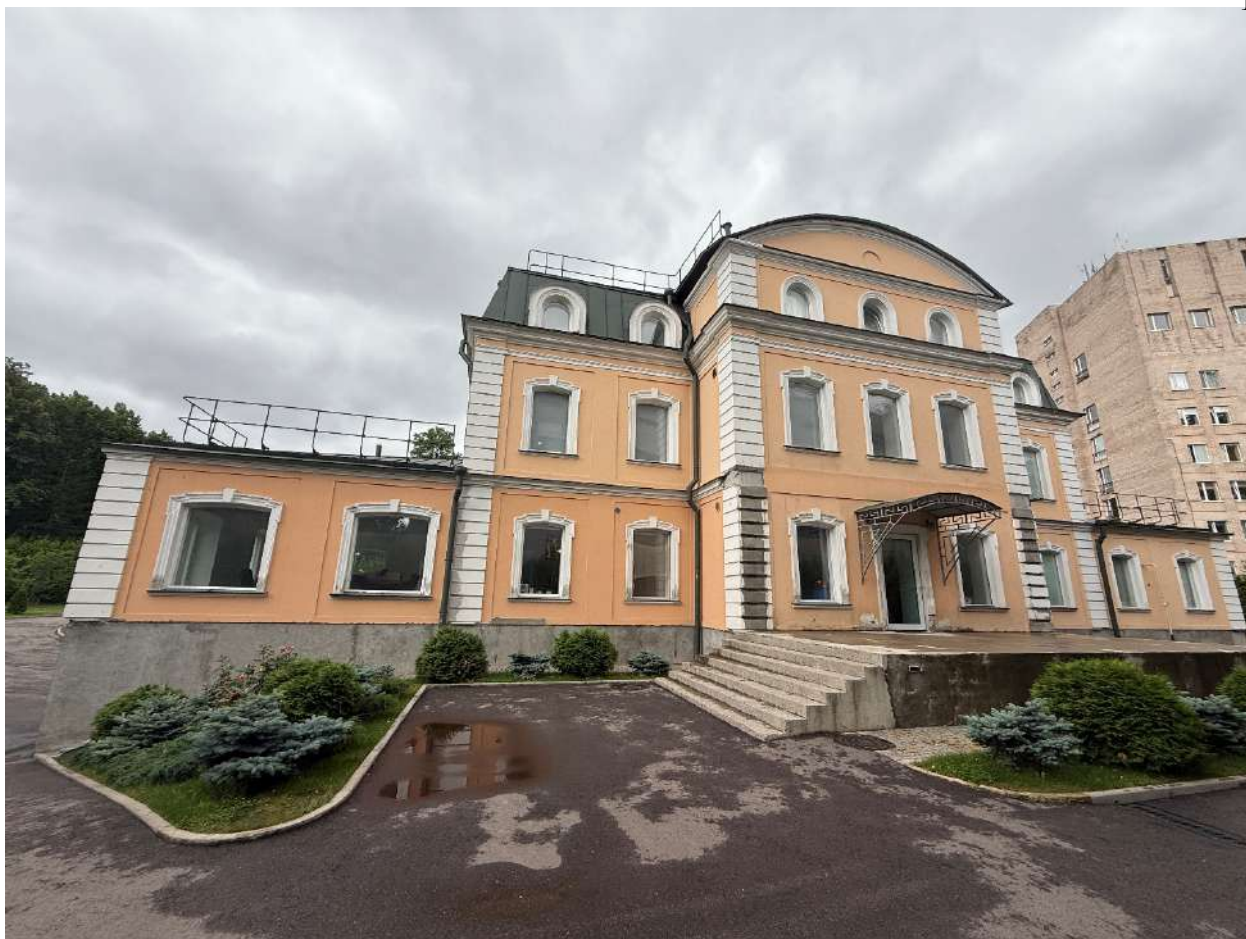
Фото 9. Общий вид на объект.
