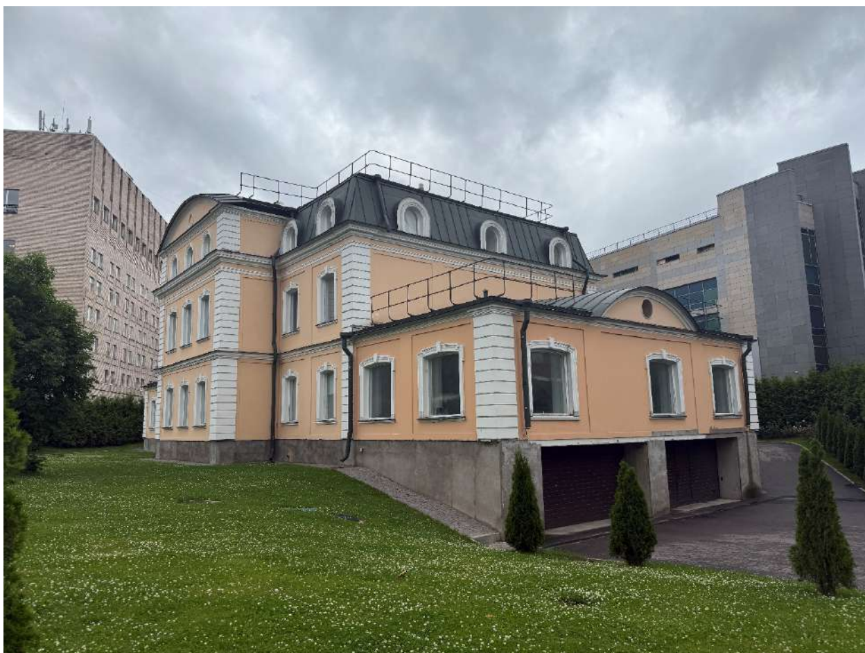
Фото 2. Общий вид на объект.
