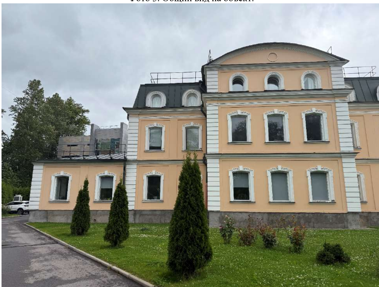
Фото 4. Общий вид на объект.
