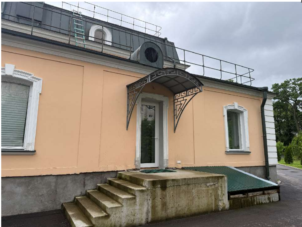
Фото 5. Общий вид на объект.
