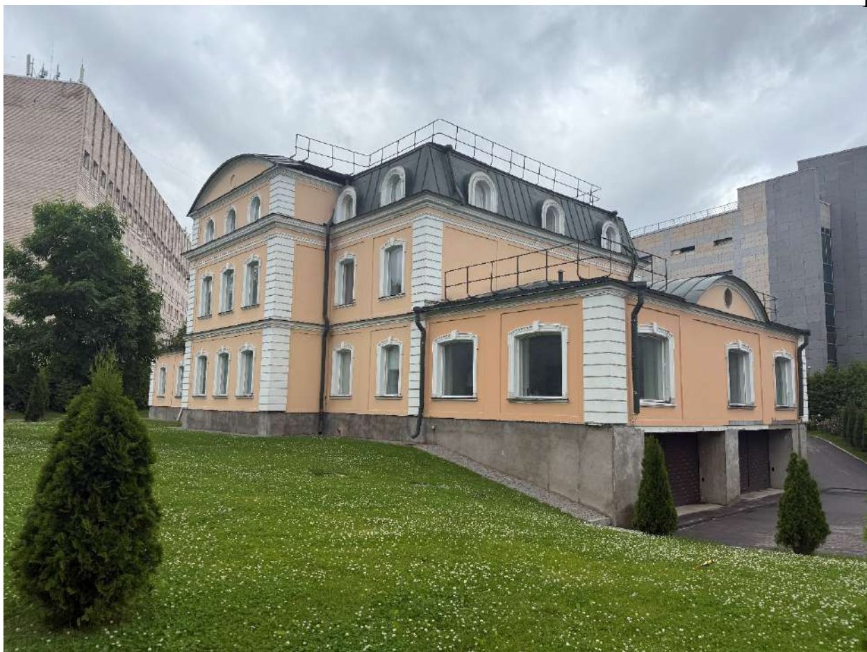
Фото 1. Общий вид на объект.
