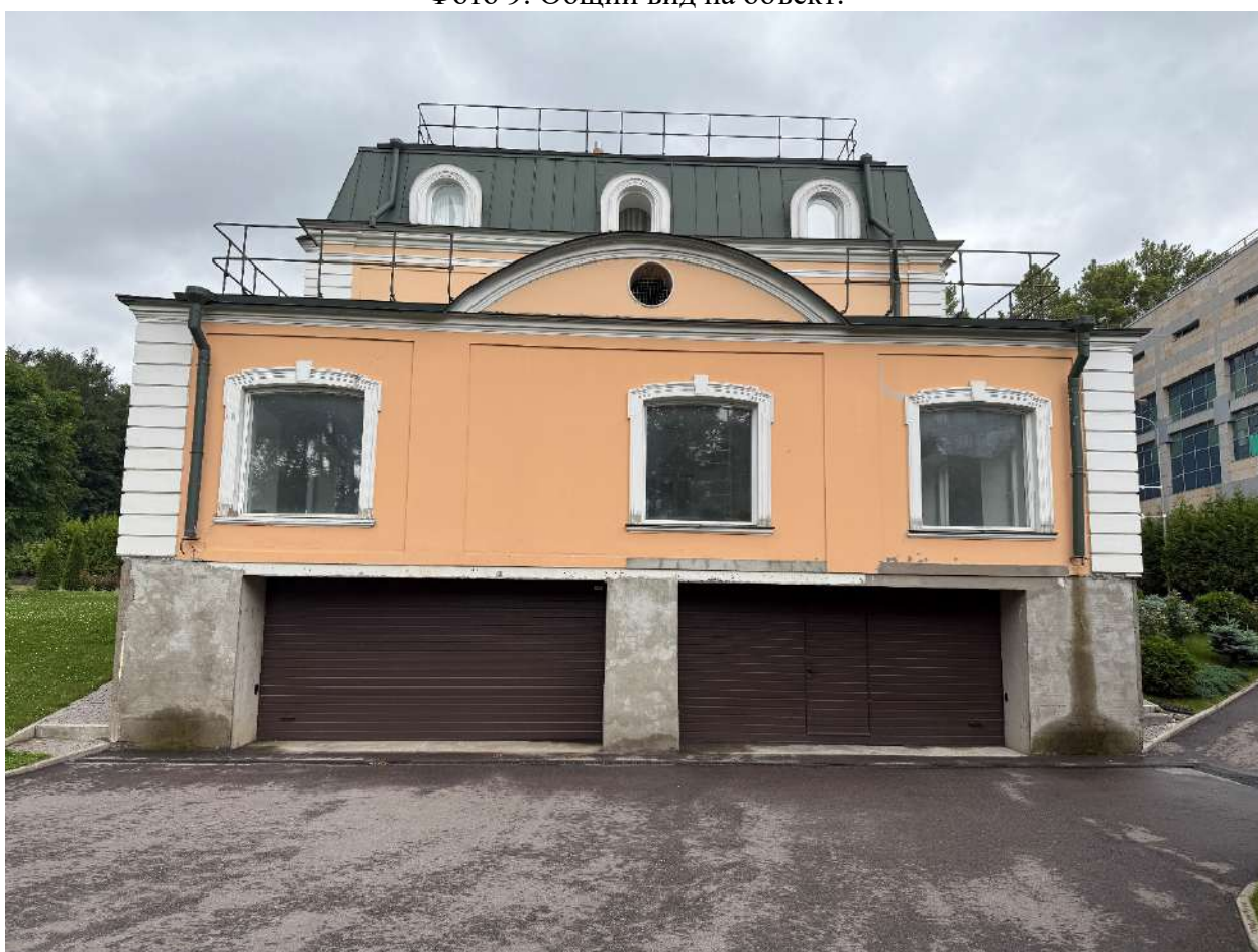
Фото 10. Общий вид на объект.
