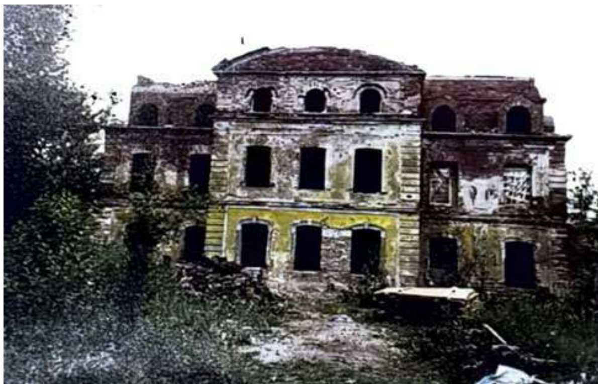
Илл. 17. Вид на главный фасад дома № 20 лит. Б на Крестовском проспекте. 1999 г. КГИОП П.621-2 Н-4594.
