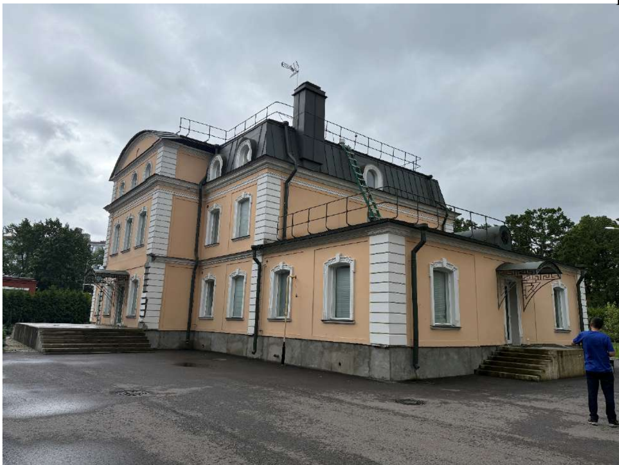
Фото 7. Общий вид на объект.
