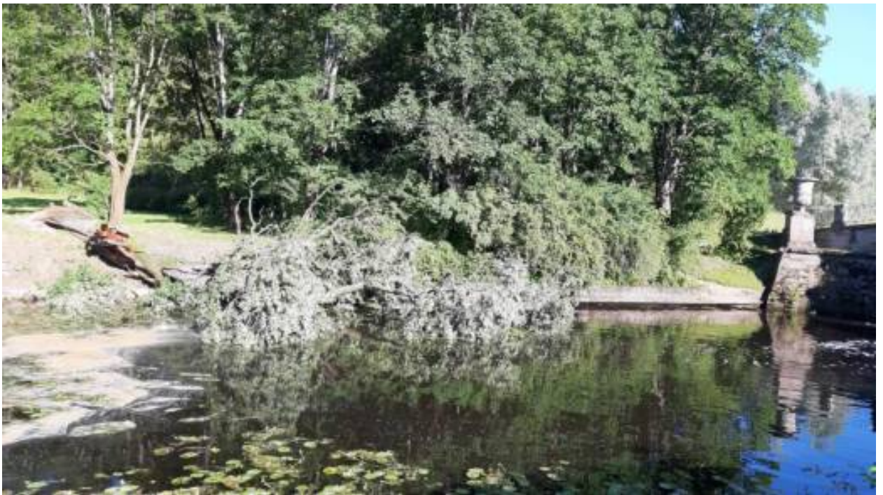
12. «Мост-плотина Висконтиев» (Санкт-Петербург, г. Павловск, Садовая ул., д. 20, лит. АК). Вид на берегоукрепление и устой с волнорезом-контрфорсом моста-плотины Висконтиев с нижнего бьефа с северо-запада. Штиглиц М.С. 22.07.2026 г.
