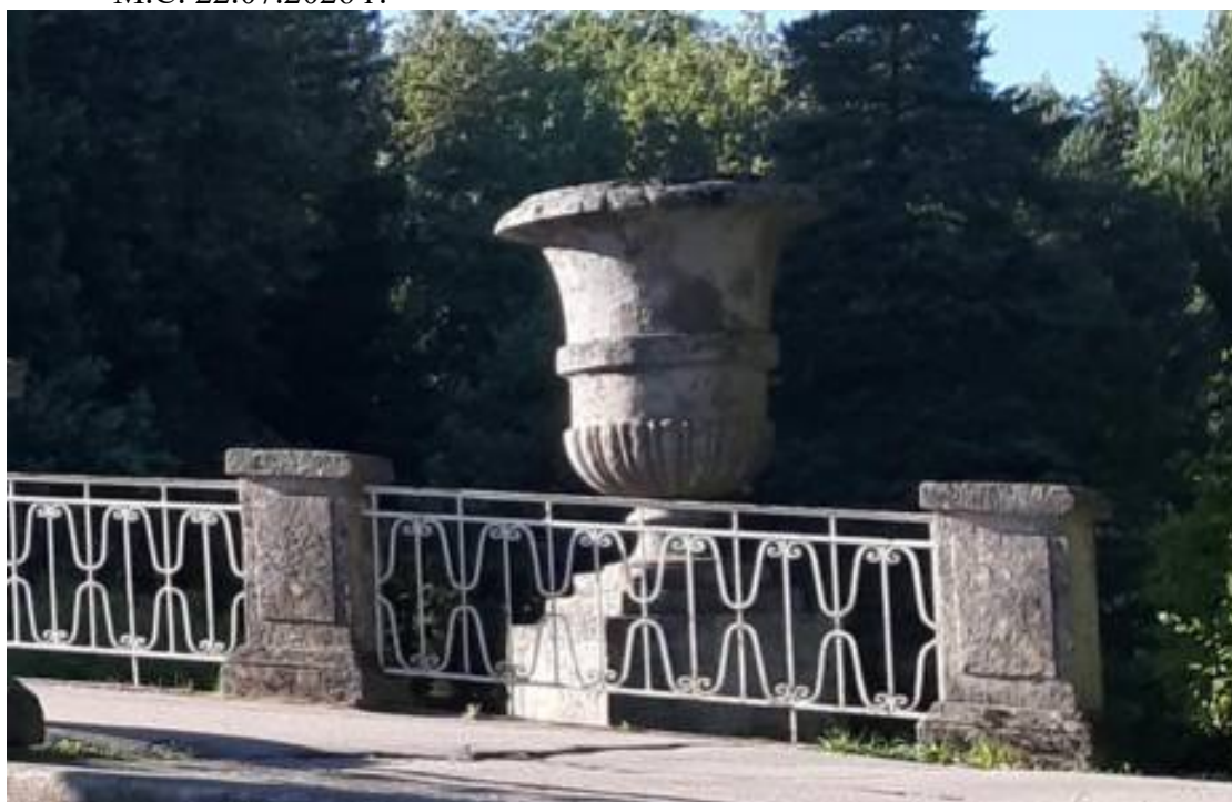
30. «Мост-плотина Висконтиев» (Санкт-Петербург, г. Павловск, Садовая ул., д. 20, лит. АК). Вид на перильное ограждение и вазы из пудожского известняка. Штиглиц М.С. 22.07.2026 г.
