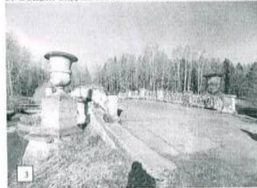
3. Общий вид на мостовое полотно.
