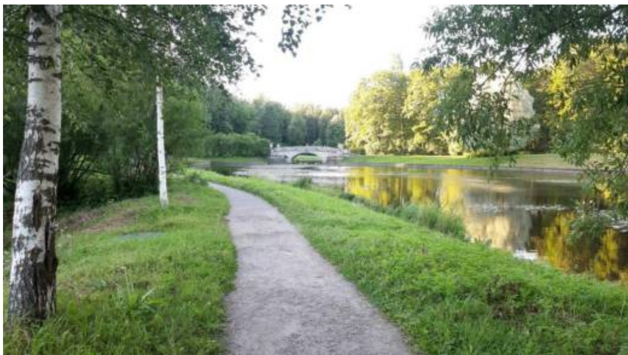
28. «Мост-плотина Висконтиев» (Санкт-Петербург, г. Павловск, Садовая ул., д. 20, лит. АК). Общий вид на мост-плотину Висконтиев с Михайловской аллеи по ходу движения от Чугунного моста. Штиглиц М.С. 22.07.2026 г.
