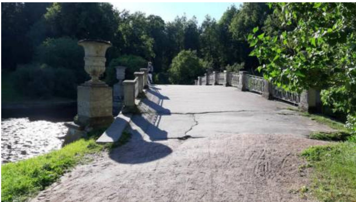
4. «Мост-плотина Висконтиев» (Санкт-Петербург, г. Павловск, Садовая ул., д. 20, лит. АК). Вид на дорожное покрытие пролетного строения моста-плотины Висконтиев с юга-востока. Штиглиц М.С. 22.07.2026 г.
