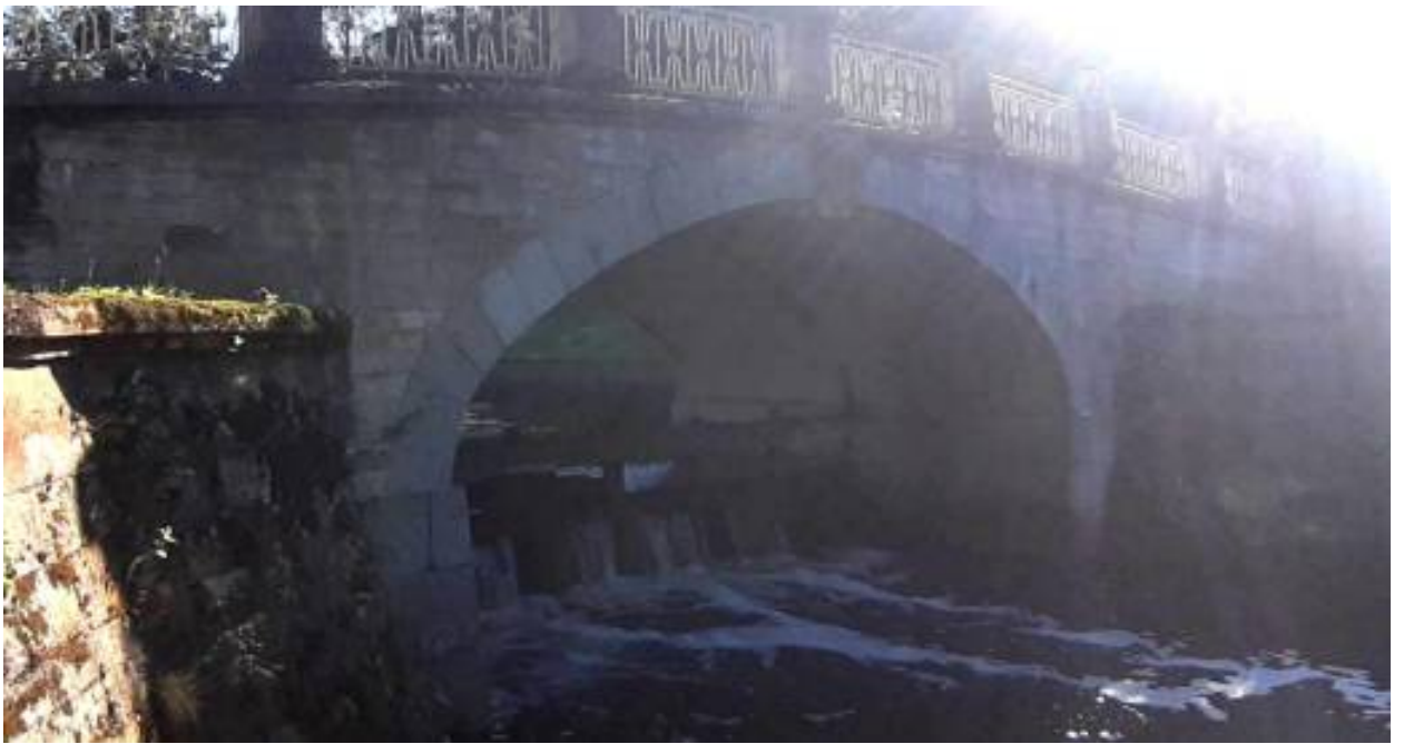
8. «Мост-плотина Висконтиев» (Санкт-Петербург, г. Павловск, Садовая ул., д. 20, лит. АК). Вид на пролетное строение моста-плотины Висконтиев с устоями и волнорезами-контрфорсами со стороны нижнего бьефа. Штиглиц М.С. 22.07.2026 г.
