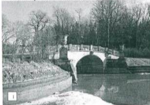
1. Южный фасад моста-плотины (со стороны ВБ).
