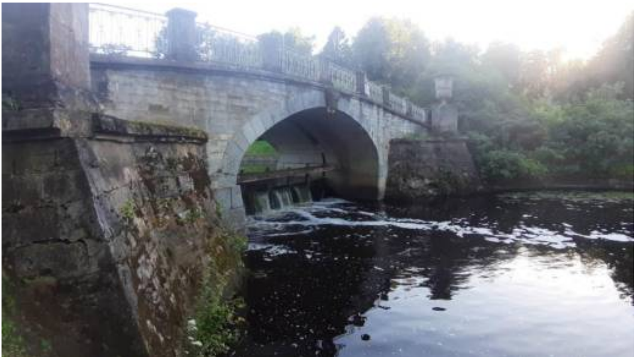
6. «Мост-плотина Висконтиев» (Санкт-Петербург, г. Павловск, Садовая ул., д. 20, лит. АК). Общий вид на мост-плотину Висконтиев с северо-востока со стороны нижнего бьефа. Штиглиц М.С. 22.07.2026 г.
