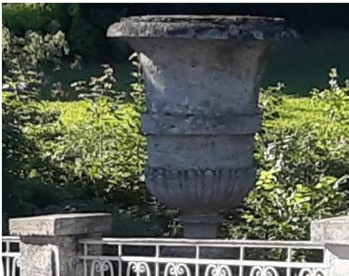
29. «Мост-плотина Висконтиев» (Санкт-Петербург, г. Павловск, Садовая ул., д. 20, лит. АК). Вид на перильное ограждение и вазы из пудожского известняка. Штиглиц М.С. 22.07.2026 г.
