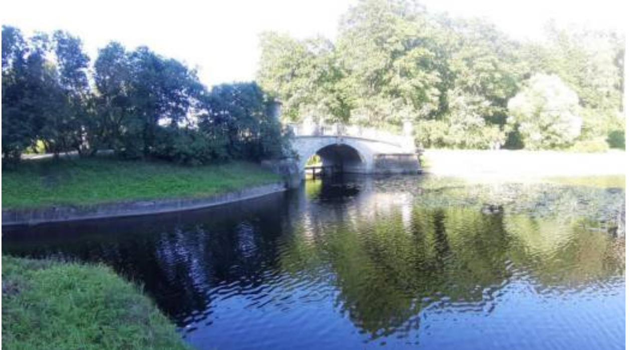
16. «Мост-плотина Висконтиев» (Санкт-Петербург, г. Павловск, Садовая ул., д. 20, лит. АК). Общий вид на мост-плотину Висконтиев с верхнего бьефа от протоки к Сиреневому мосту. Штиглиц М.С. 22.07.2026 г.
