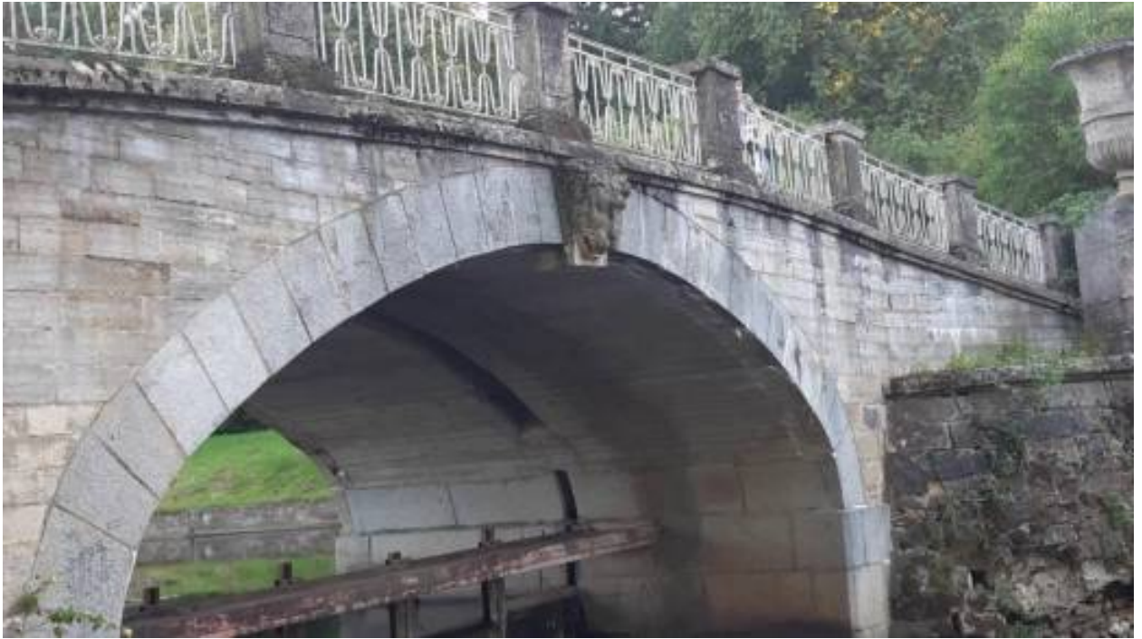
7. «Мост-плотина Висконтиев» (Санкт-Петербург, г. Павловск, Садовая ул., д. 20, лит. АК). Вид на нижнюю часть свода и маскарон льва со стороны нижнего бьефа. Моста-плотины Висконтиев. Штиглиц М.С. 22.07.2026 г.
