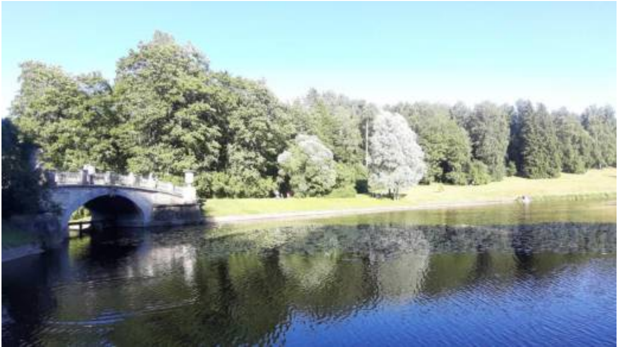
15. «Мост-плотина Висконтиев» (Санкт-Петербург, г. Павловск, Садовая ул., д. 20, лит. АК). Вид на берегоукрепление р. Славянка в районе моста-плотины Висконтиев в сторону Еленинской дороги в верхнем бьефе. Штиглиц М.С. 22.07.2026 г.
