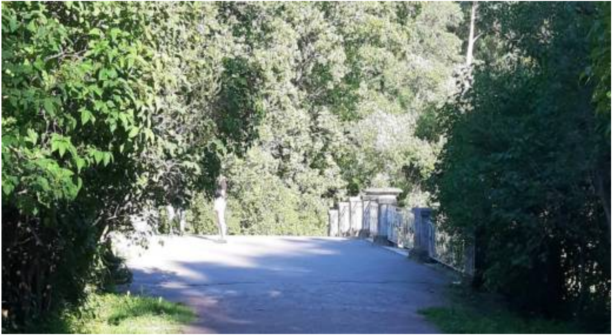
9. «Мост-плотина Висконтиев» (Санкт-Петербург, г. Павловск, Садовая ул., д. 20, лит. АК). Вид на дорожное покрытие пролетного строения моста-плотины Висконтиев с северо-запада. Штиглиц М.С. 22.07.2026 г.
