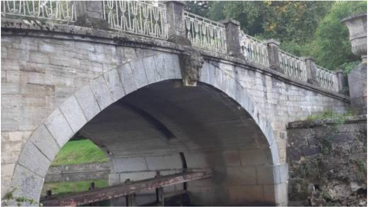
33. «Мост-плотина Висконтиев» (Санкт-Петербург, г. Павловск, Садовая ул., д. 20, лит. АК). Вид на мост-плотину Висконтиев после спуска воды с верхнего бьефа. Штиглиц М.С. 22.07.2026 г.
