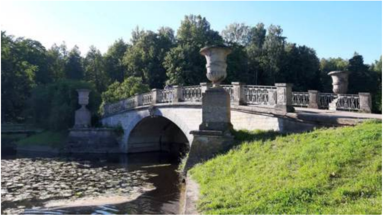
5. «Мост-плотина Висконтиев» (Санкт-Петербург, г. Павловск, Садовая ул., д. 20, лит. АК). Общий вид на мост-плотину Висконтиев с юго-востока со стороны верхнего бьефа. Штиглиц М.С. 22.07.2026 г.
