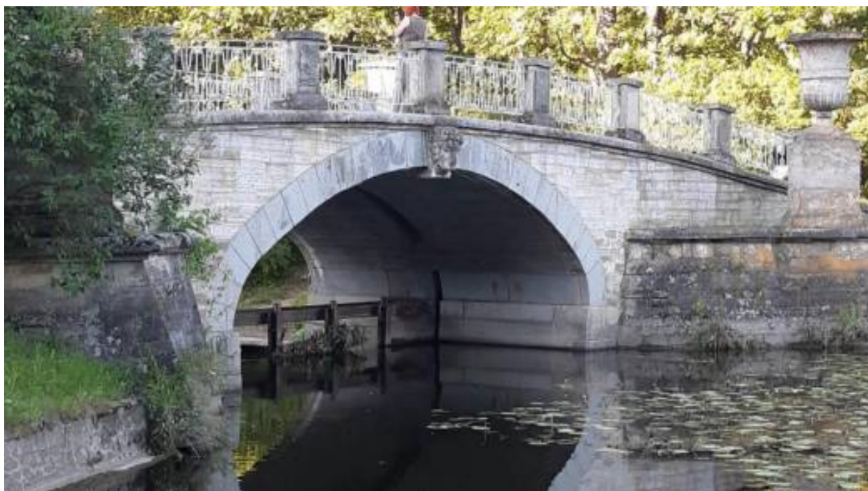
32. «Мост-плотина Висконтиев» (Санкт-Петербург, г. Павловск, Садовая ул., д. 20, лит. АК). Вид на спуск воды через мост-плотину Висконтиев с нижнего бьефа. Штиглиц М.С. 22.07.2026 г.
