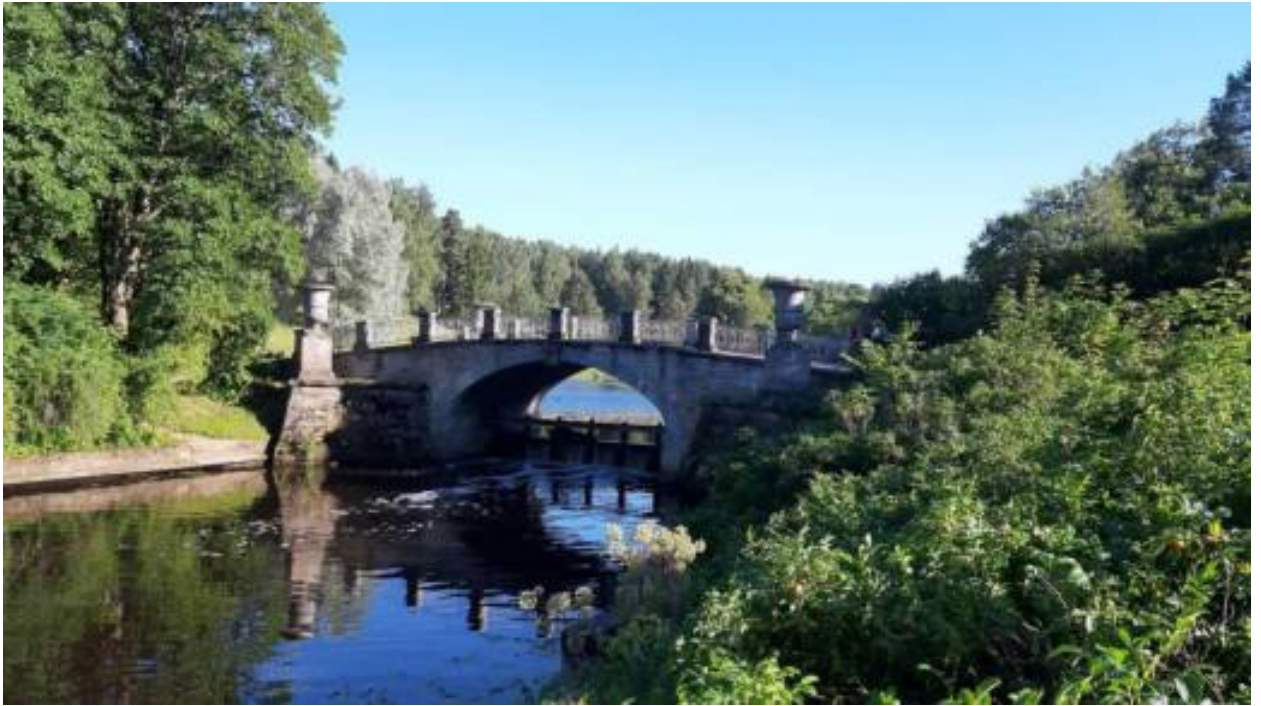
11. «Мост-плотина Висконтиев» (Санкт-Петербург, г. Павловск, Садовая ул., д. 20, лит. АК). Общий вид на мост-плотину Висконтиев со стороны нижнего бьефа. Штиглиц М.С. 22.07.2026 г.
