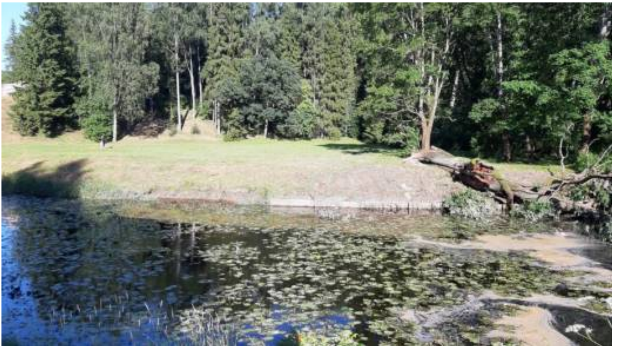
14. «Мост-плотина Висконтиев» (Санкт-Петербург, г. Павловск, Садовая ул., д. 20, лит. АК). Вид на берегоукрепление р. Славянка в районе моста-плотины Висконтиев от Михайловской аллеи в нижнем бьефе. Штиглиц М.С. 22.07.2026 г.
