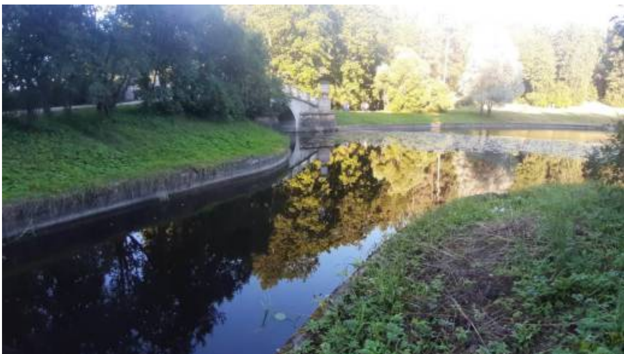
17. «Мост-плотина Висконтиев» (Санкт-Петербург, г. Павловск, Садовая ул., д. 20, лит. АК). Вид на мост-плотину Висконтиев через протоку от Сиреневого моста. Штиглиц М.С. 22.07.2026 г.
