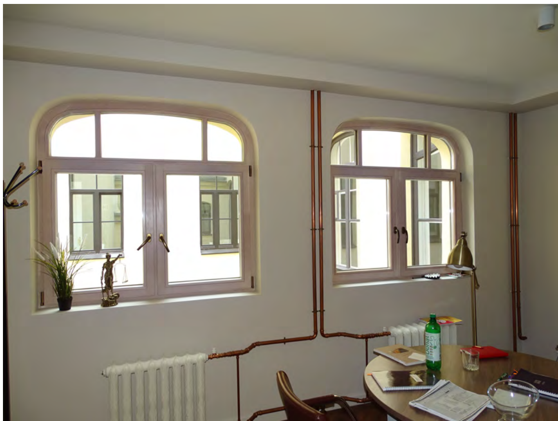
27. 2-й этаж. Пом. 3/14,0. Съемка 04.05.2026 г. Трушковский В.Э.
