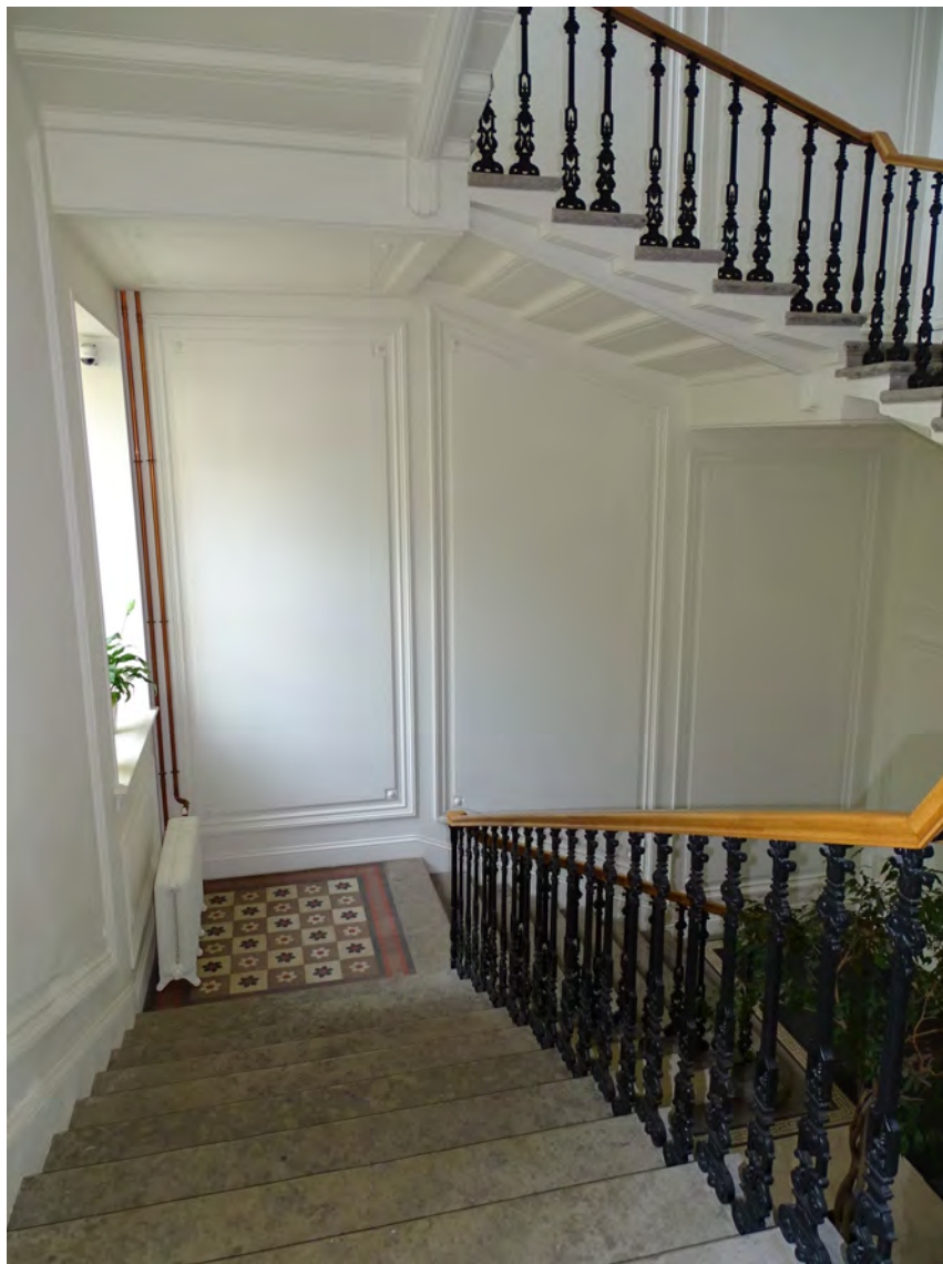
16. Лестница Л-1. Вид с междуэтажной площадки между 1-м и 2-м этажом. Съемка 04.05.2026 г. Трушковский В.Э.
