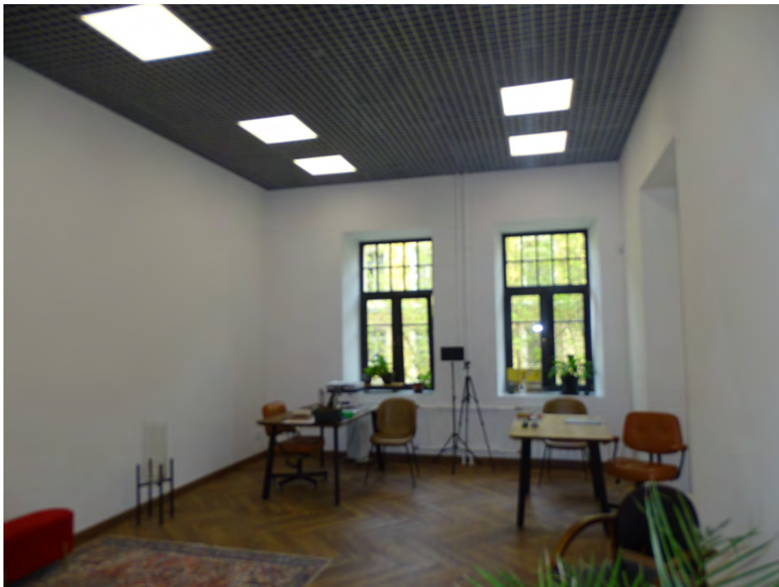
30. 2-й этаж. Пом. 5/12,2; 6/23,6. Съемка 04.05.2026 г. Трушковский В.Э.
