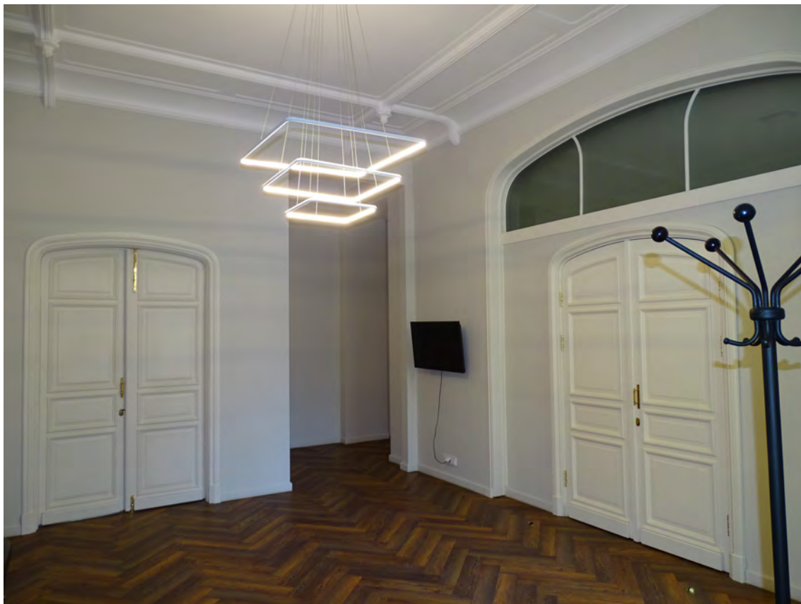
18. 2-й этаж. Пом. 8/14,4; 5/27,1. Съемка 04.05.2026 г. Трушковский В.Э.
