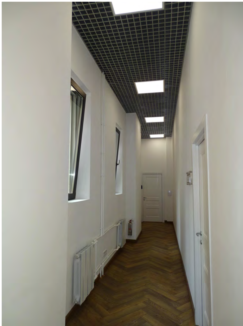
29. 2-й этаж. Пом. 8/26,8. Съемка 04.05.2026 г. Трушковский В.Э.
