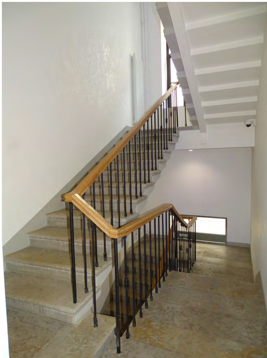
26. Лестница Л-2. 2-й этаж. Съемка 04.05.2026 г. Трушковский В.Э.
