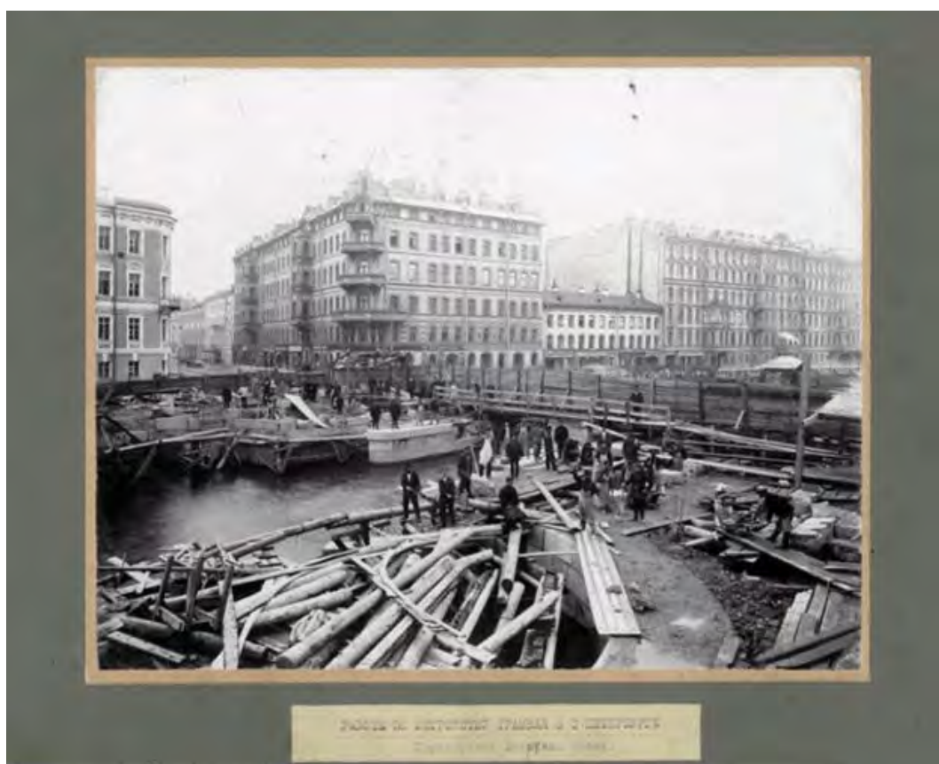
4. Работы по устройству трамвайных путей. Перестройка Аларчина моста через Екатерининский канал, фото 1906-1907. Автор Феофанов Е.Ф. Источник - https://pastvu.com/p/2163054 .
