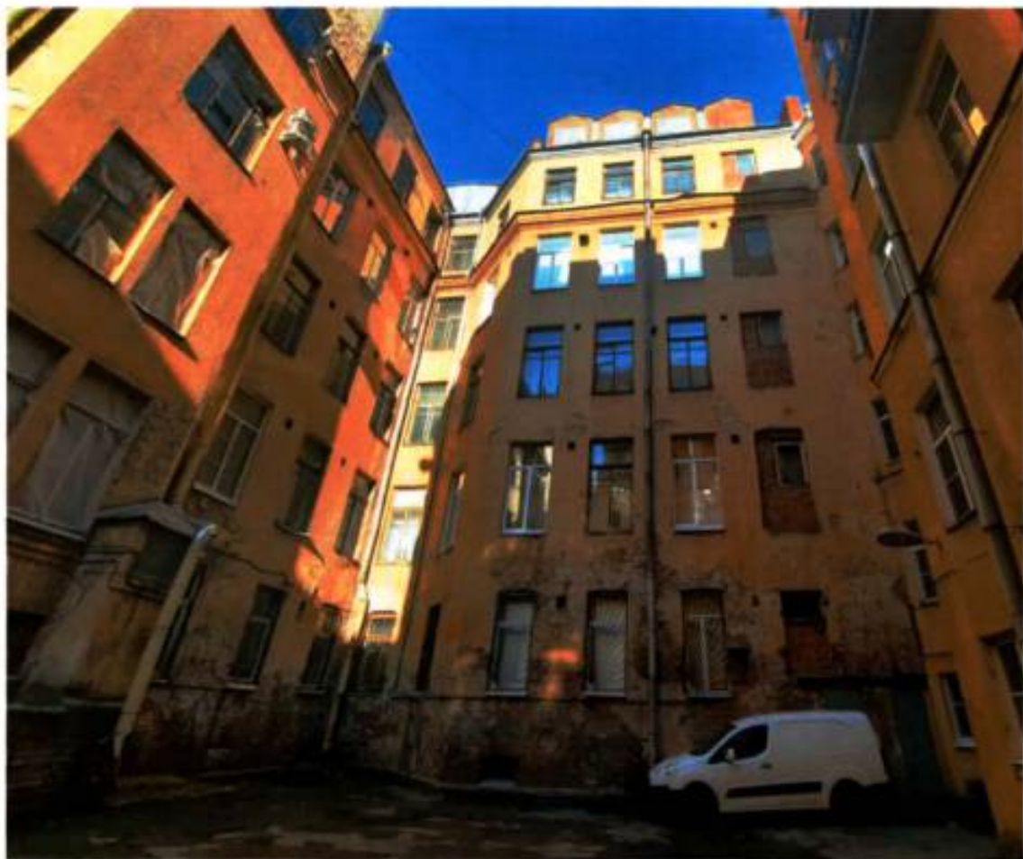
3. Общий вид на дворовый юго-восточный фасад здания (30.09.2024)
