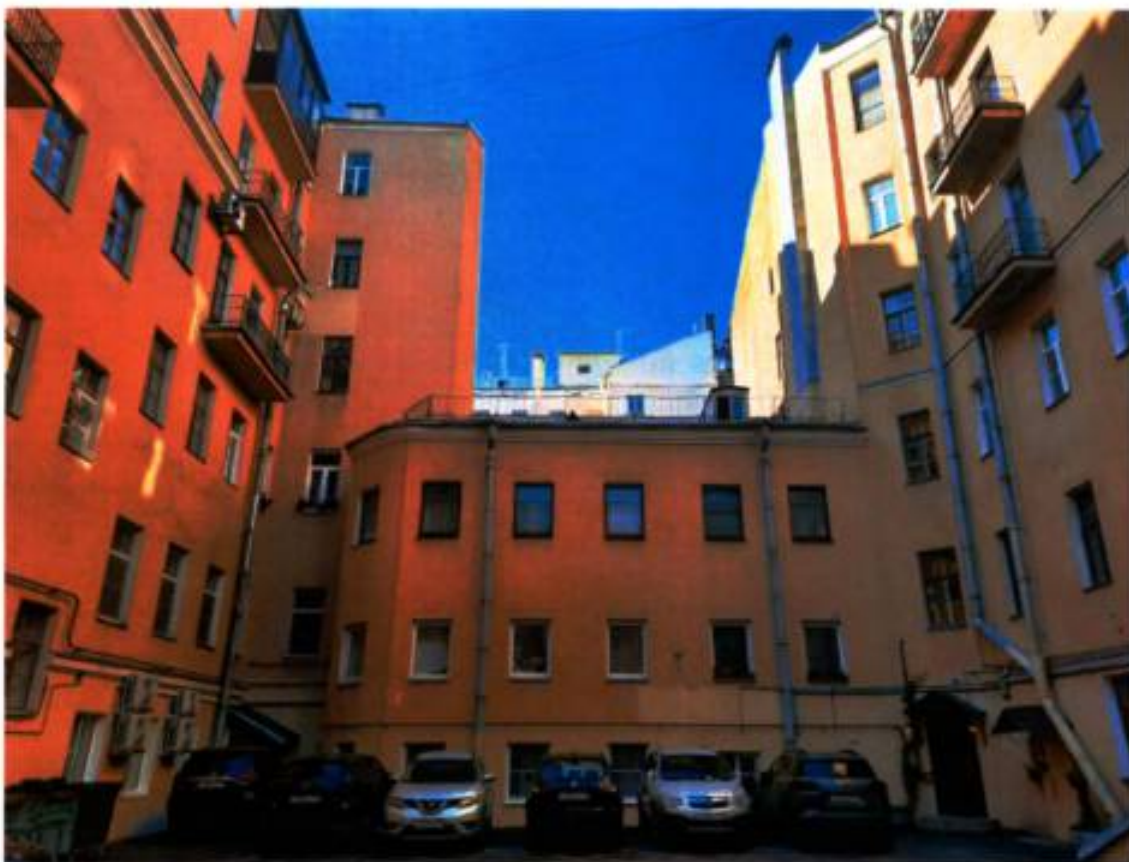
9. Общий вид на дворовый юго-западный фасад здания (южный двор) (30.09.2024)
