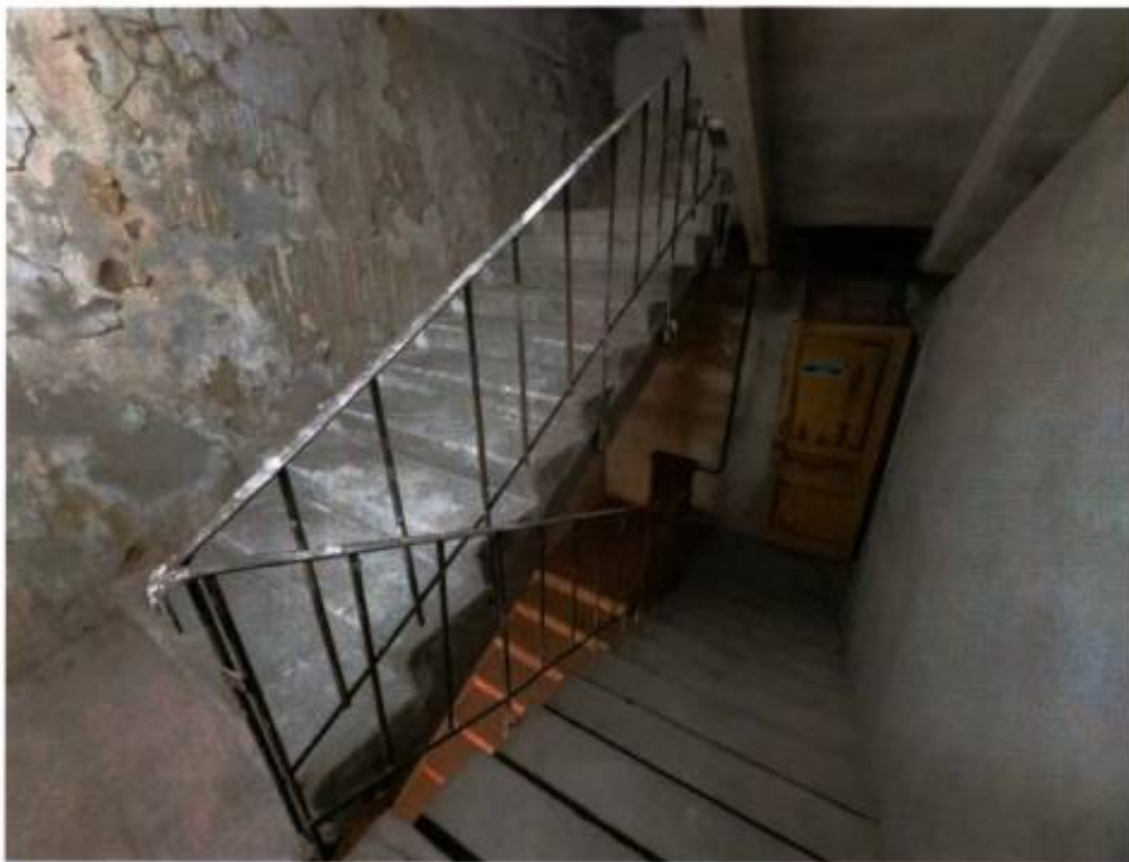
5. Лестница Л-1 здания (27.09.2024)
