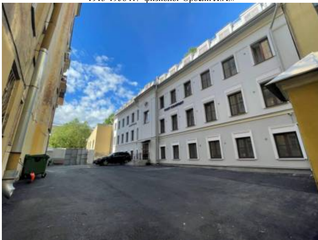
Фото 6. Фрагмент фасада здания по адресу Английский пр., дом 30, лит. Б (участок работ), примыкающее к объекту культурного наследия федерального значения «Здания, где в 1897-1919 гг. находились Высшие курсы физического образования (курсы Лесгафта). Здесь жили и работали: в 1897-1909 гг.- основатель курсов Лесгафт П.Ф., в 1907-1941гг.- революционер Морозов Н.А., в 1913-1958 гг.- физиолог Орбели Л.А.»
