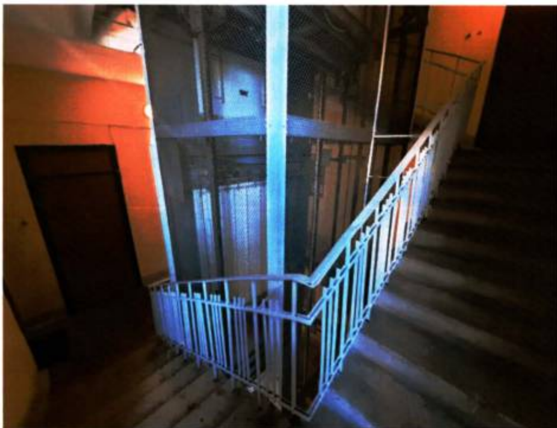
18. Лестница Л-3 здания (30.09.2024)
