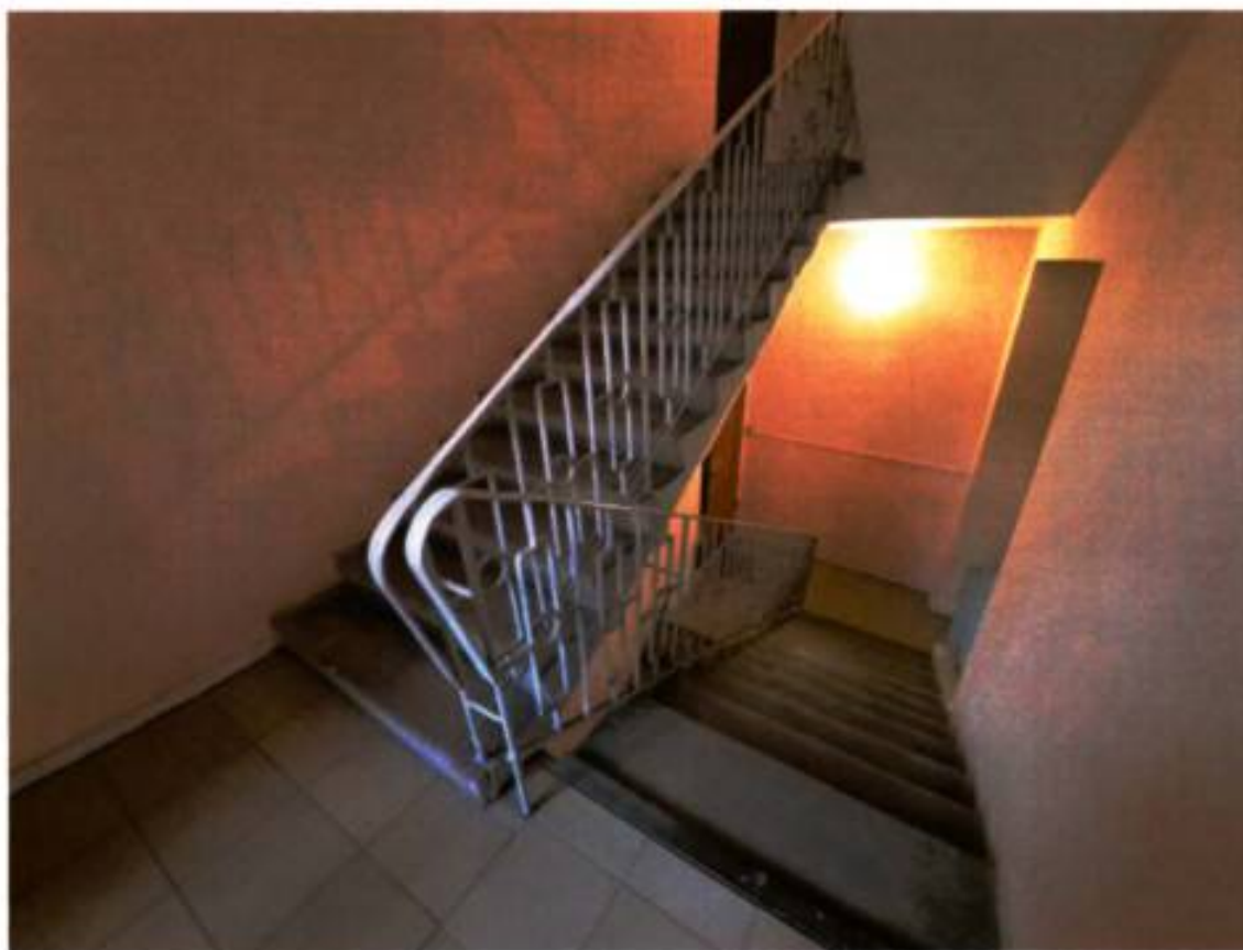
19. Лестница Л-4 здания (03.10.2024)
