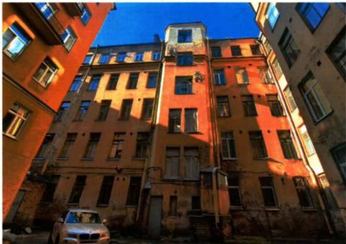
2. Общий вид на дворовый северо-восточный фасад здания (30.09.2024)
