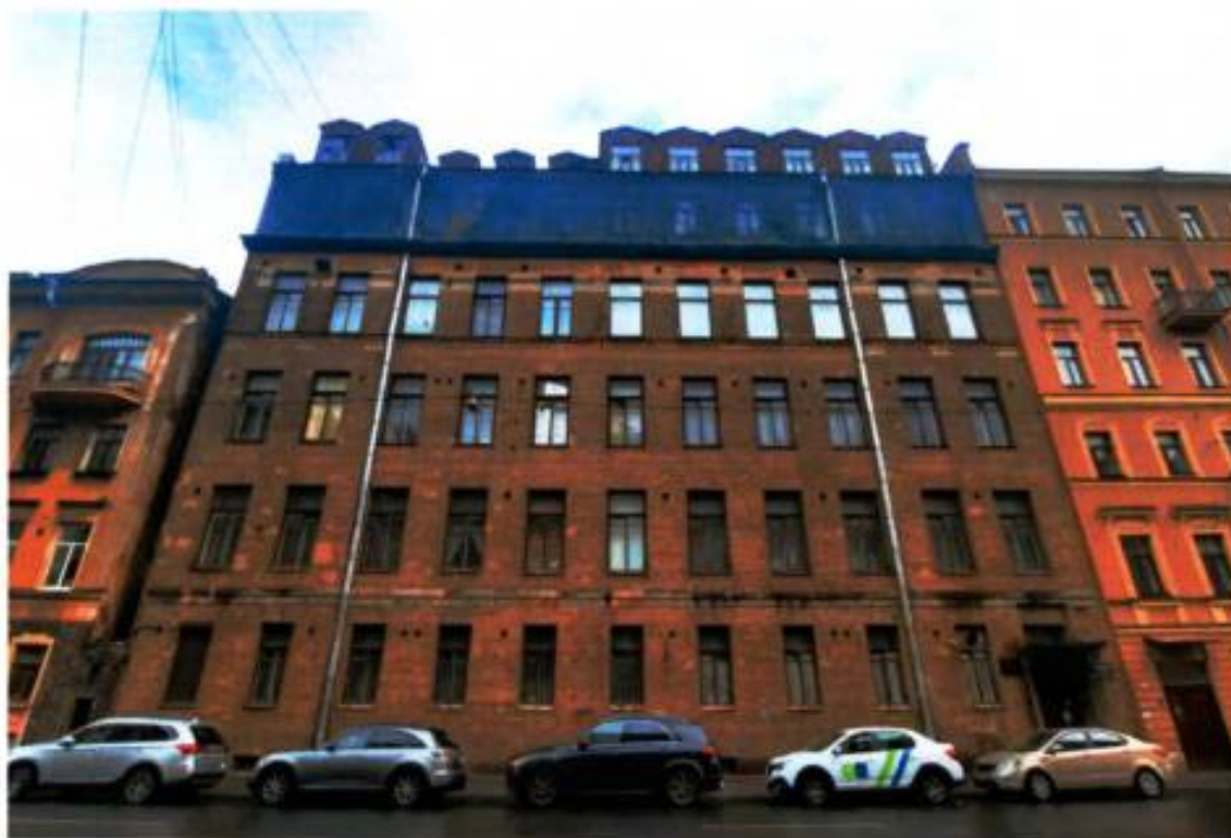
I. Общий вид на юго-западный фасад здания (27.09.2024)
