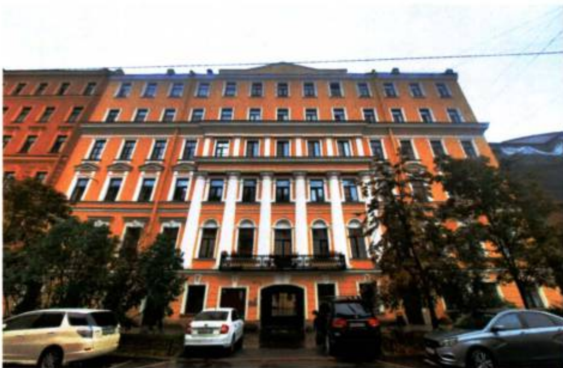
7. Общий вид на юго-восточный фасад здания (04.10.2024)
