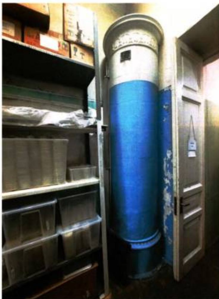
4. Печь в помещениях 3 этажа здания (27.09.2024)
