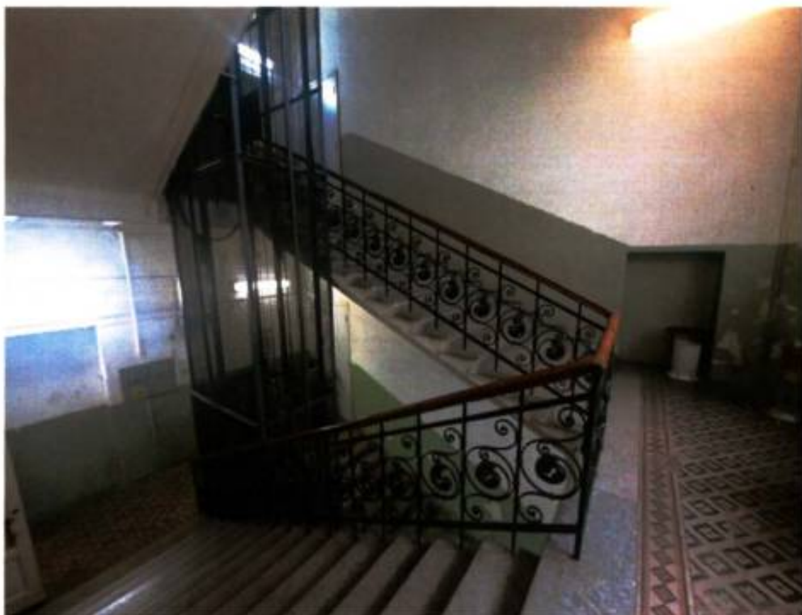
6. Центральная лестница здания (27.09.2024)
