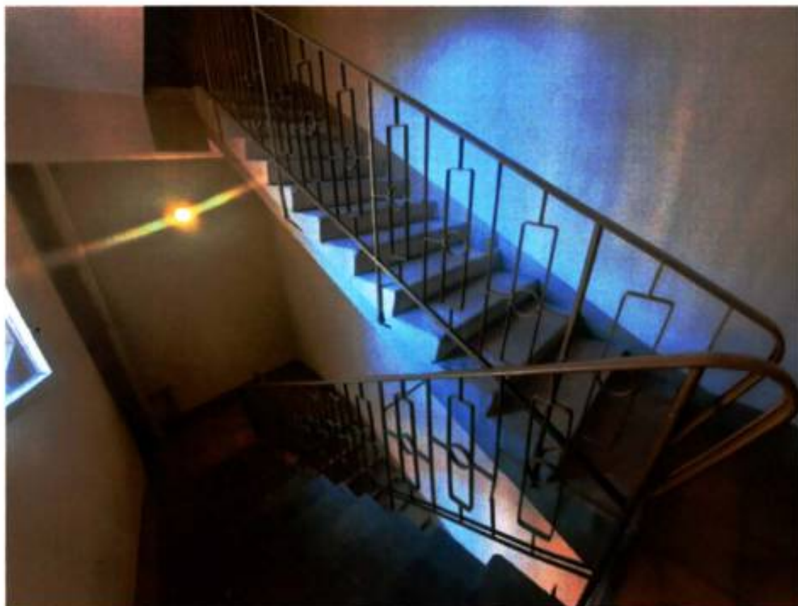
17. Лестница Л-2 здания (30.09.2024)
