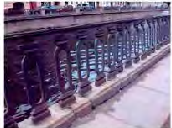
2. Решетка перильного ограждения
