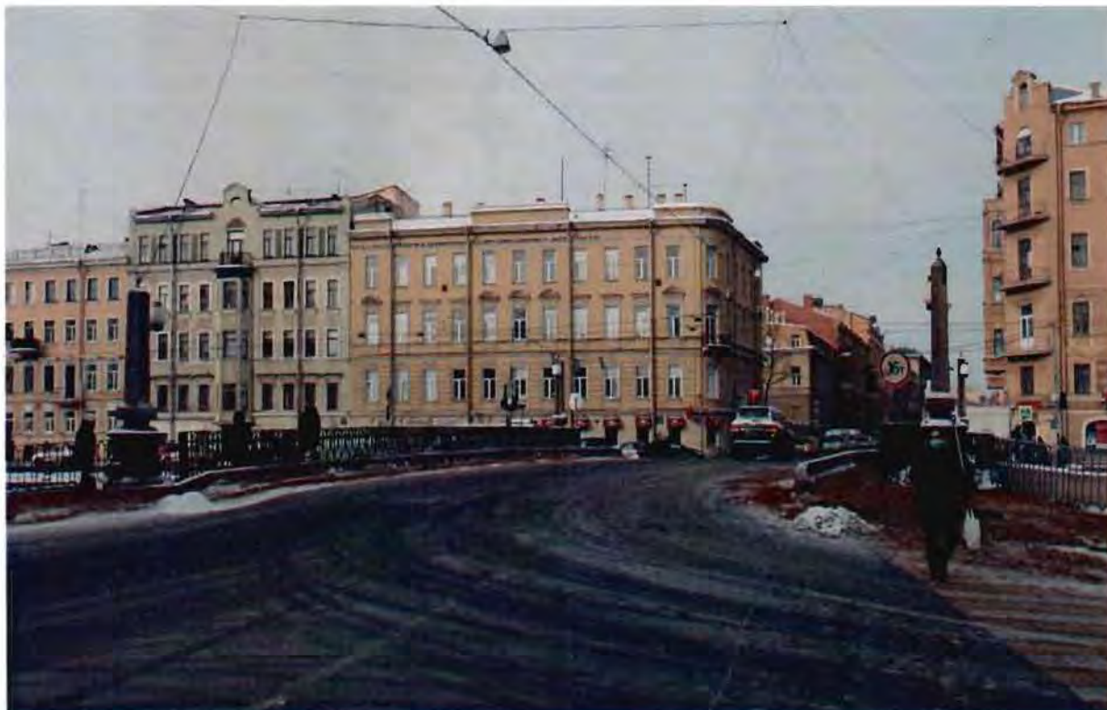
1. Общий вид объекта культурного наследия
