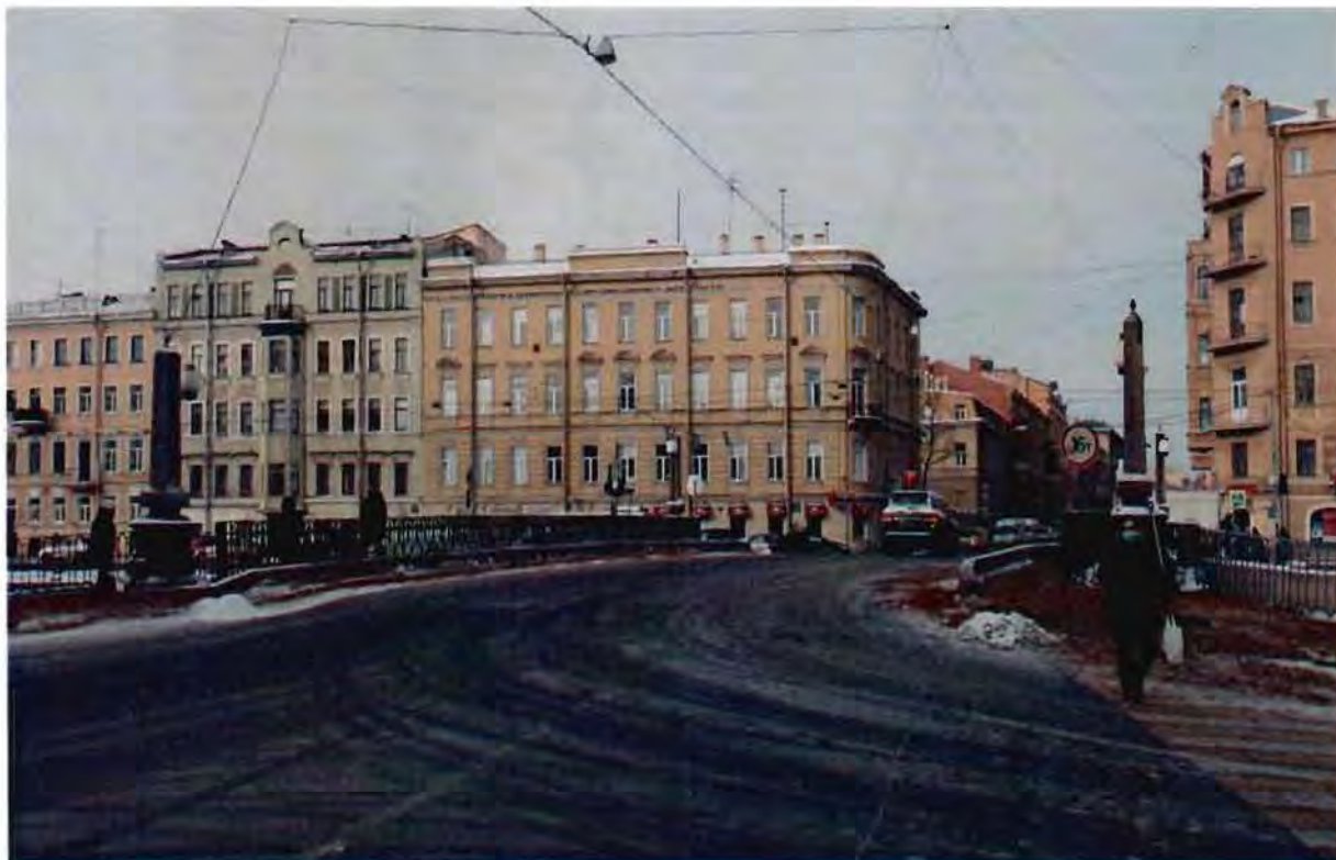
1. Общий вид объекта культурного наследия
