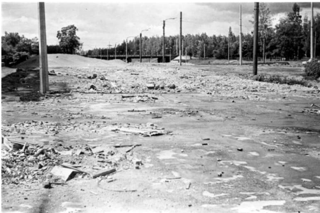
Илл. 38 Строительство Светановской площади. 1973 г.
