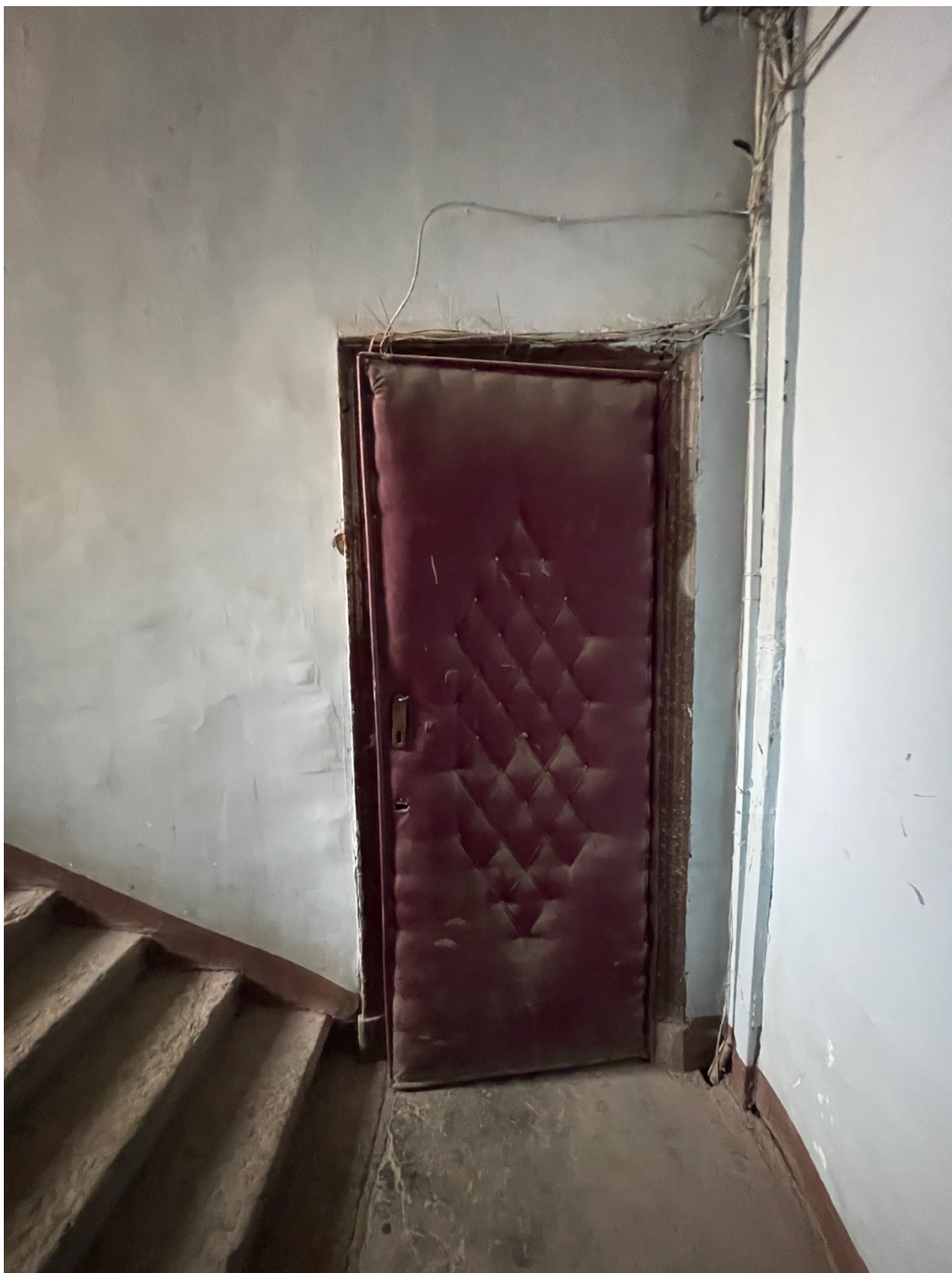
17. Общий вид входной двери.
