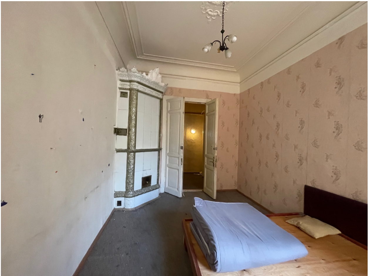
28. Печь в помещении 4.
