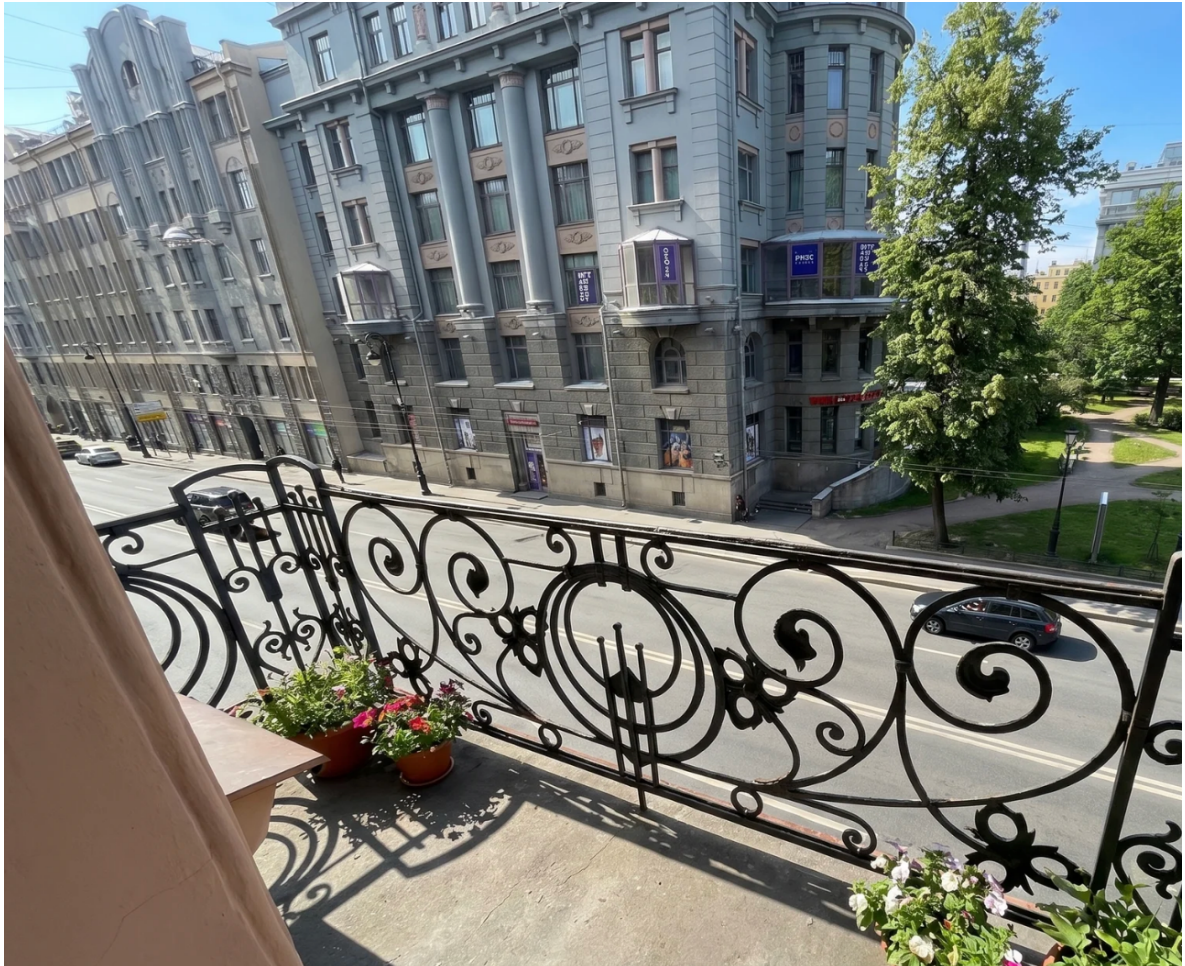
6. Общий вид балкона.
