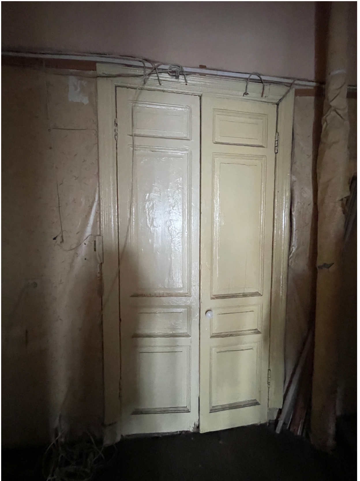
4. Общий вид входной двери со стороны квартиры. Помещение 5.
