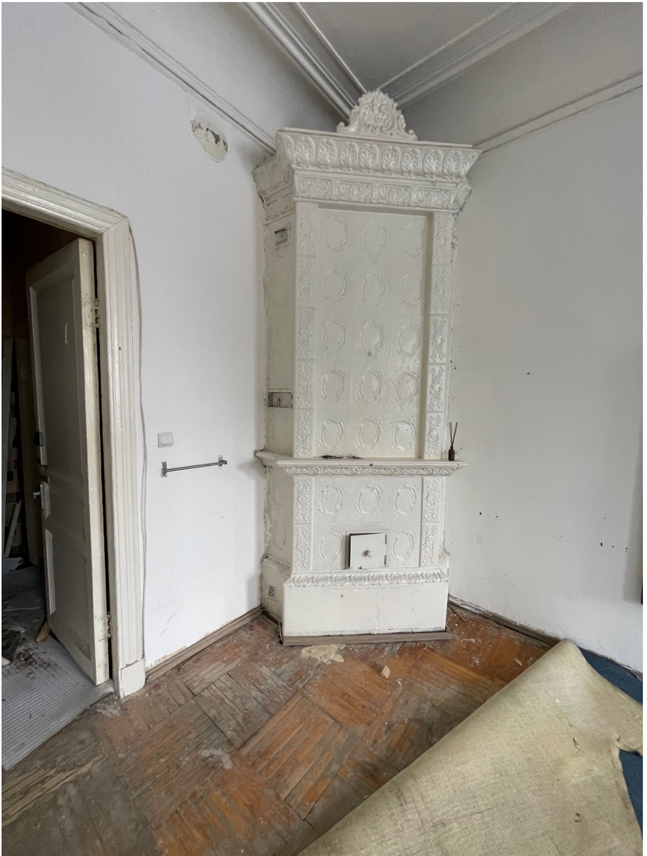
14. Печь в помещении 8.
