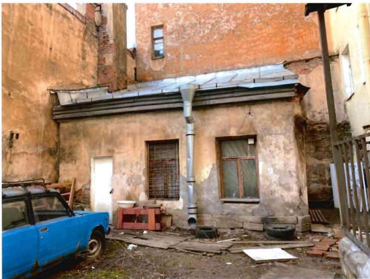
1. Юго-западный фасад объекта культурного наследия.
