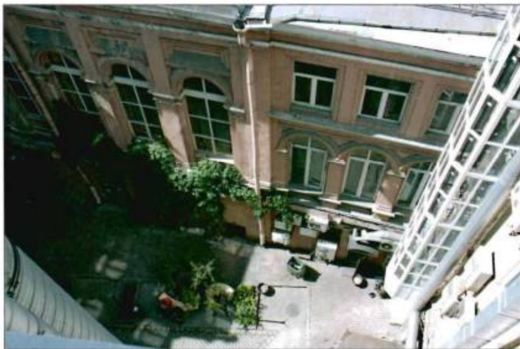
Фото №20. Северный внутренний двор.
