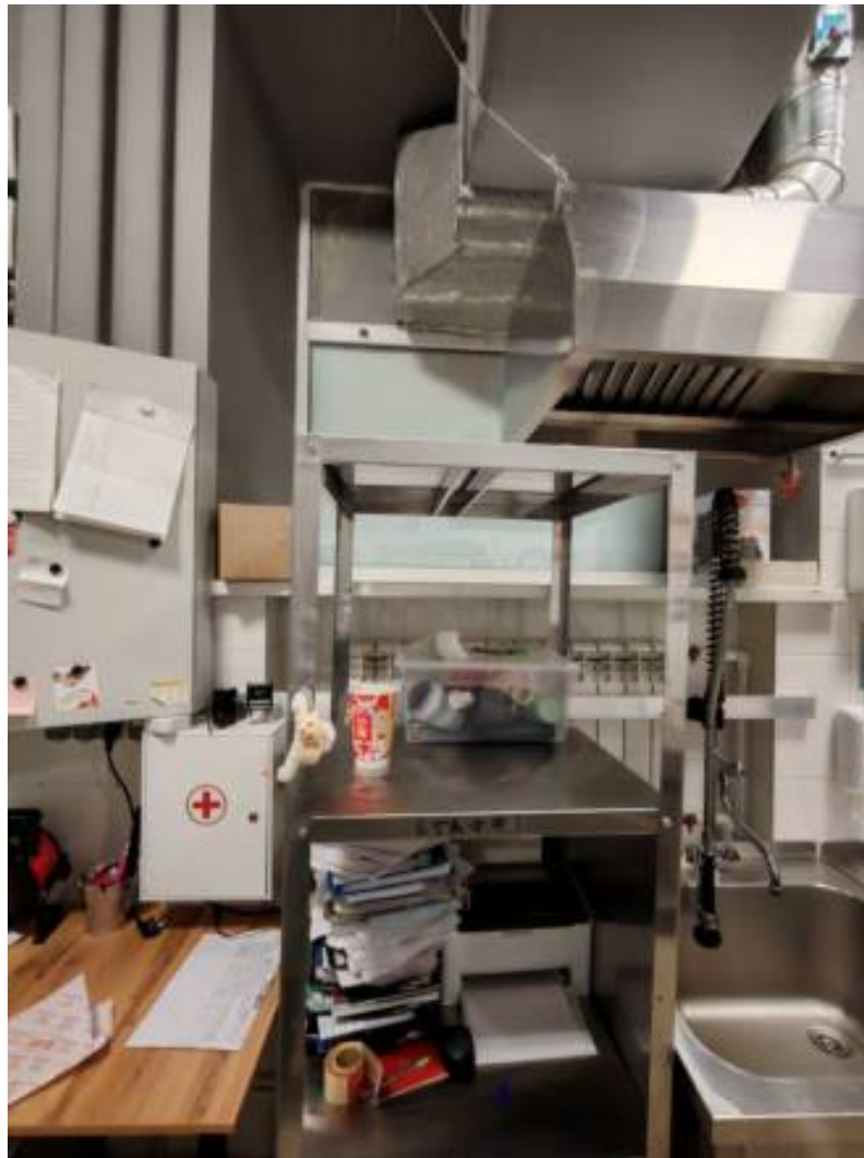
24. Вид в интерьере помещения 4-Н (окно со стороны двора) (дата съемки – 09.03.2026 г.).
