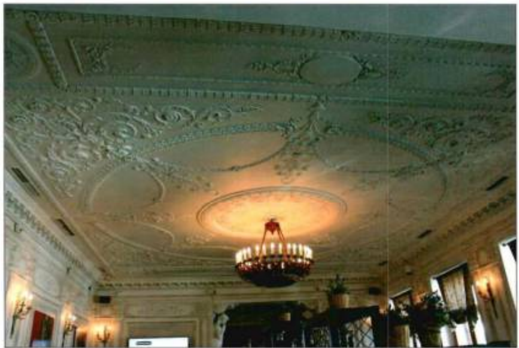
Фото №3, 4. Помещение 58-Н (1) 2-го этажа.
