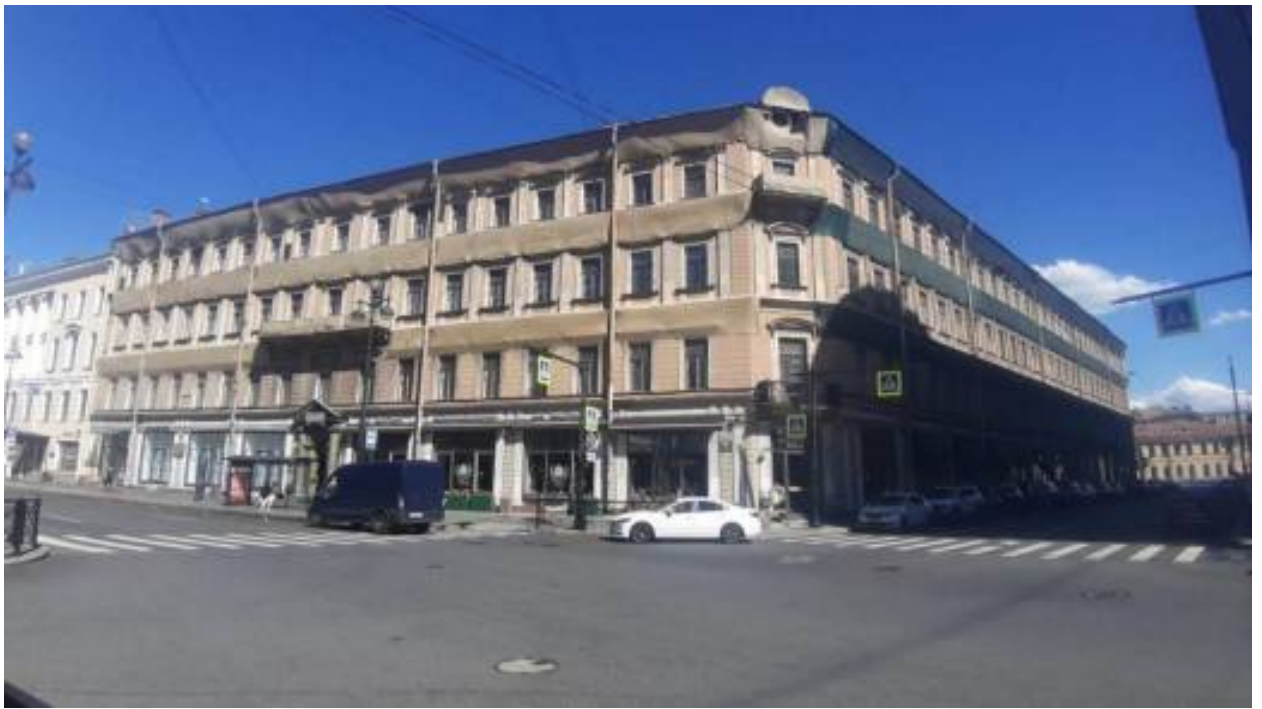
39. «Дом. Здесь в конце 1906 г. проходили заседания ЦК и ПК РСДРП» (наб. реки Мойки, д. 61, лит. А). Общий вид. Штиглиц М.С. 12.06.2026.
