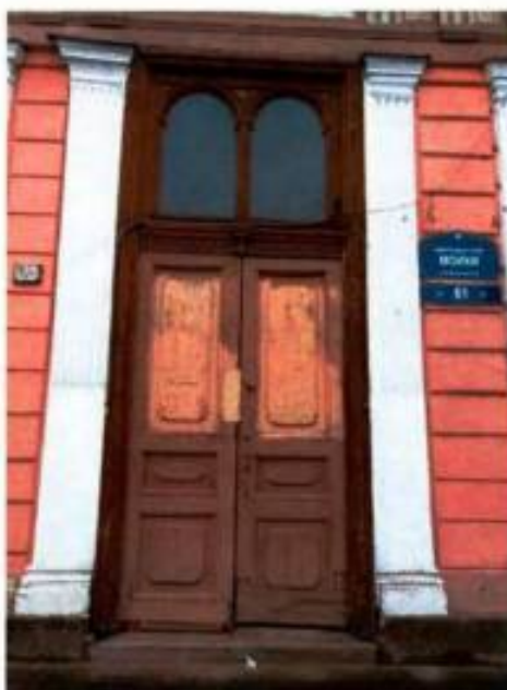
13. Фрагмент юго-восточного лицевого фасада объекта культурного наследия. (фото от 27.02.2025)
