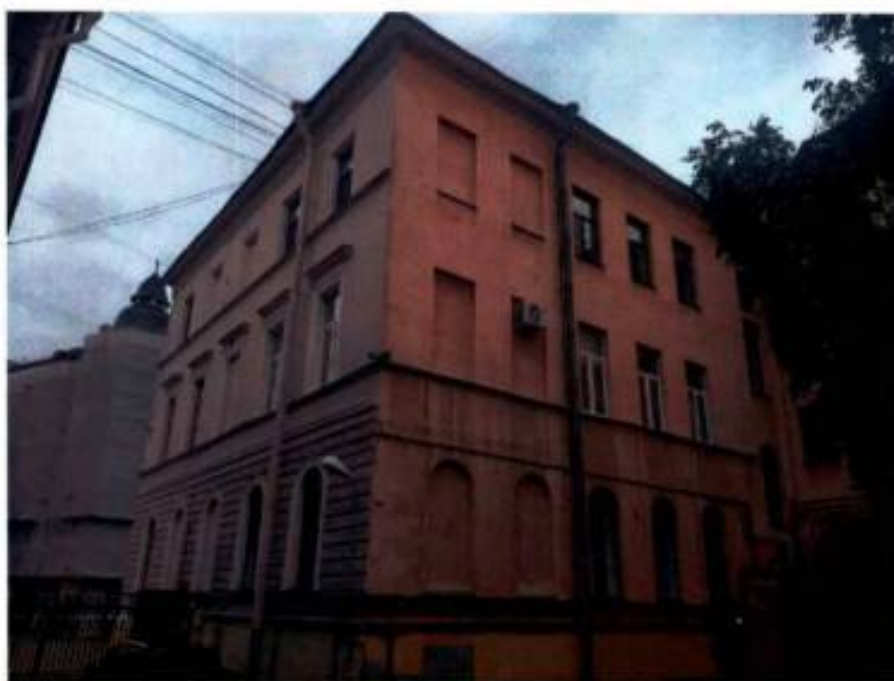
Фото 26. Вид на южный и восточный фасады объекта культурного наследия (дата съемки 27.06.2025).
