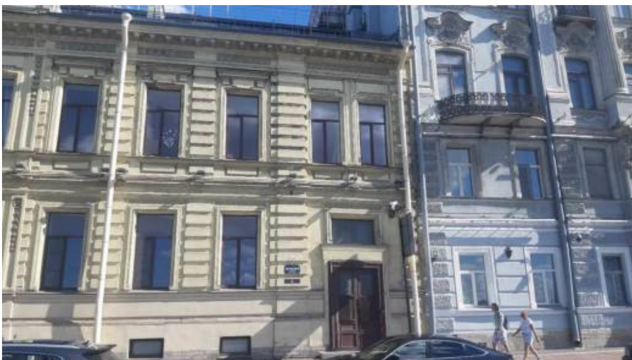
44. «Особняк по Дворцовой набережной» (в составе «Особняк и доходный дом Г.А. Чертова») (Миллионная ул., д. 23, лит. А). Лицевой фасад. Фрагмент. Фото мест установки оборудования и прокладки кабельных трасс. Штиглиц М.С. 12.06.2026.
