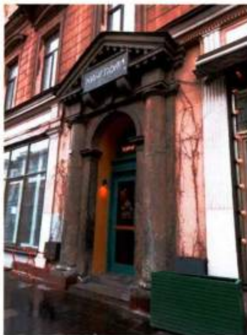
15. Фрагмент северо-западного лицевого фасада объекта культурного наследия. (фото от 25.02.2025)
