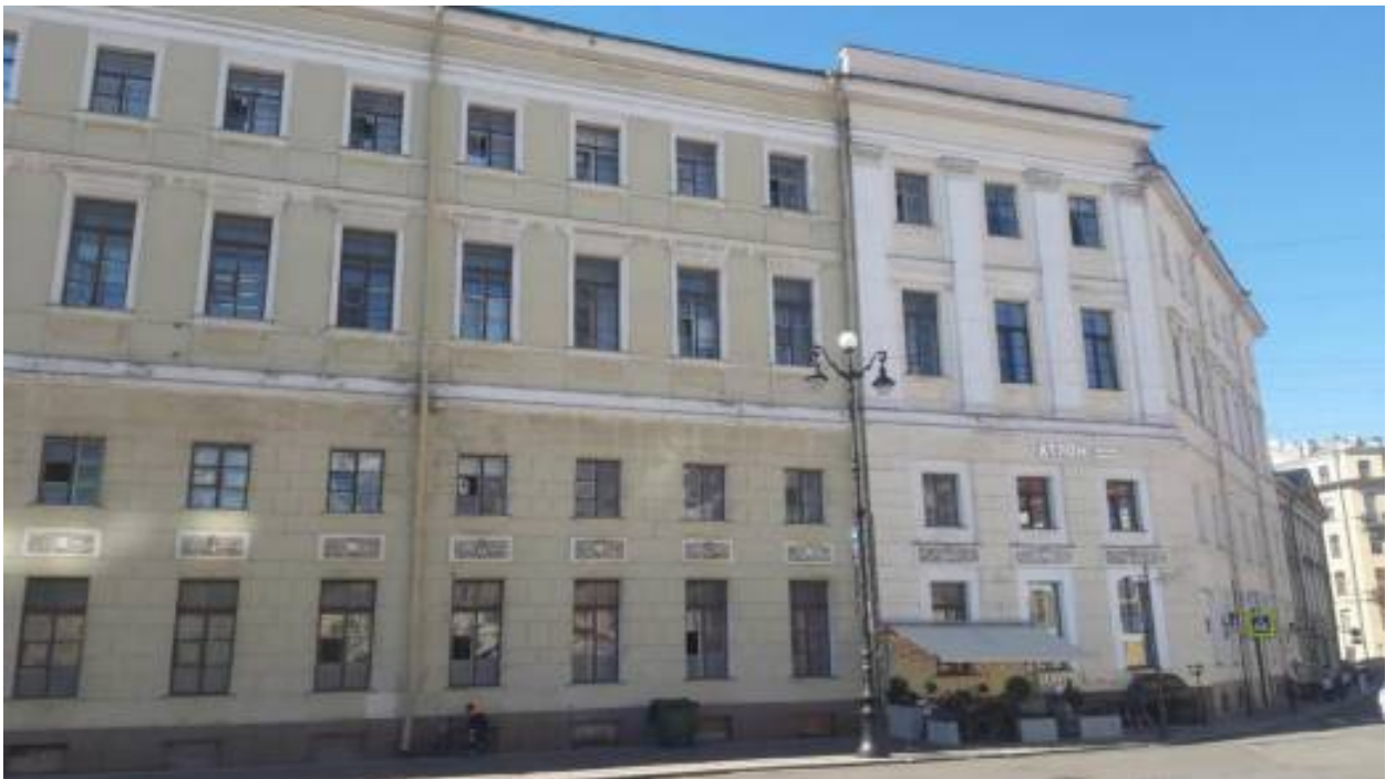
30. «Штаб Гвардейского корпуса» (Дворцовая пл., д. 4, лит. А). Лицевой фасад. Фрагмент. Фото мест установки оборудования и прокладки кабельных трасс. Штиглиц М.С. 12.06.2026.
