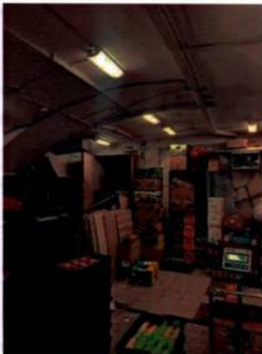
Фото 9. Общий вид подвального помещения 13-Н (ч.п. 14) объекта культурного наследия.
