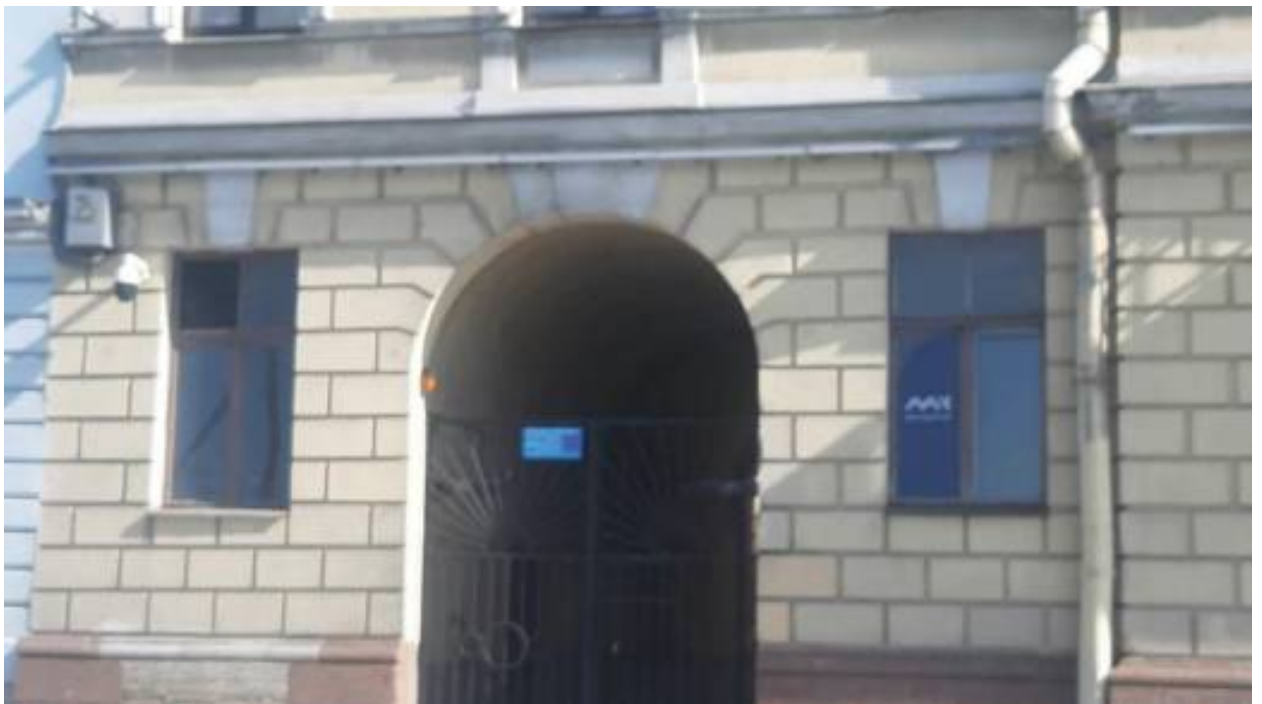
38. «Дом М.И. Скалон» (наб. Кутузова, д. 32, лит. А). Лицевой фасад. Фрагмент. Фото мест установки оборудования и прокладки кабельных трасс. Штиглиц М.С. 12.06.2026.
