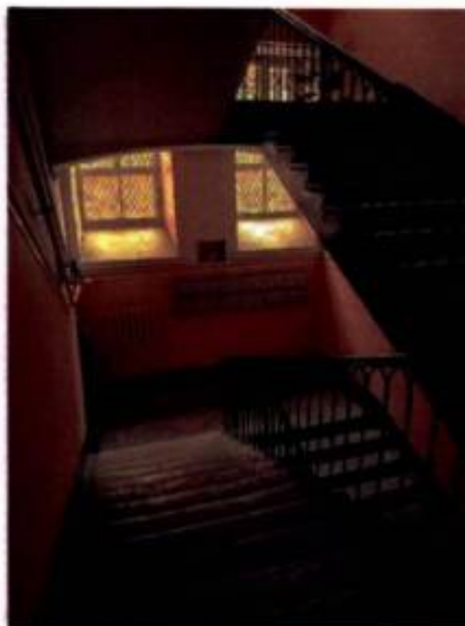
Фото 6. Лестничная клетка 5ЛК объекта культурного наследия.
