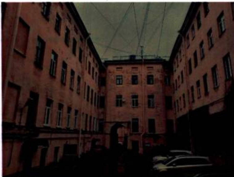
Фото 13. Общий вид на северную часть внутреннего двора объекта культурного наследия.
