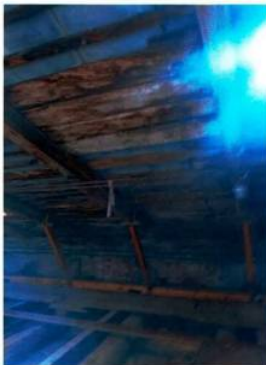
28. Чердачное пространство объекта культурного наследия (фото от 25.02.2025).
