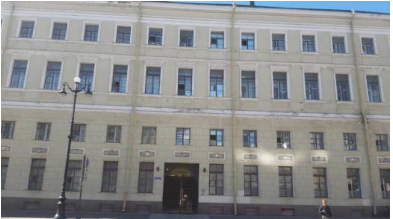
29. «Штаб Гвардейского корпуса» (Дворцовая пл., д. 4, лит. А). Лицевой фасад. Фрагмент. Фото мест установки оборудования и прокладки кабельных трасс. Штиглиц М.С. 12.06.2026.
