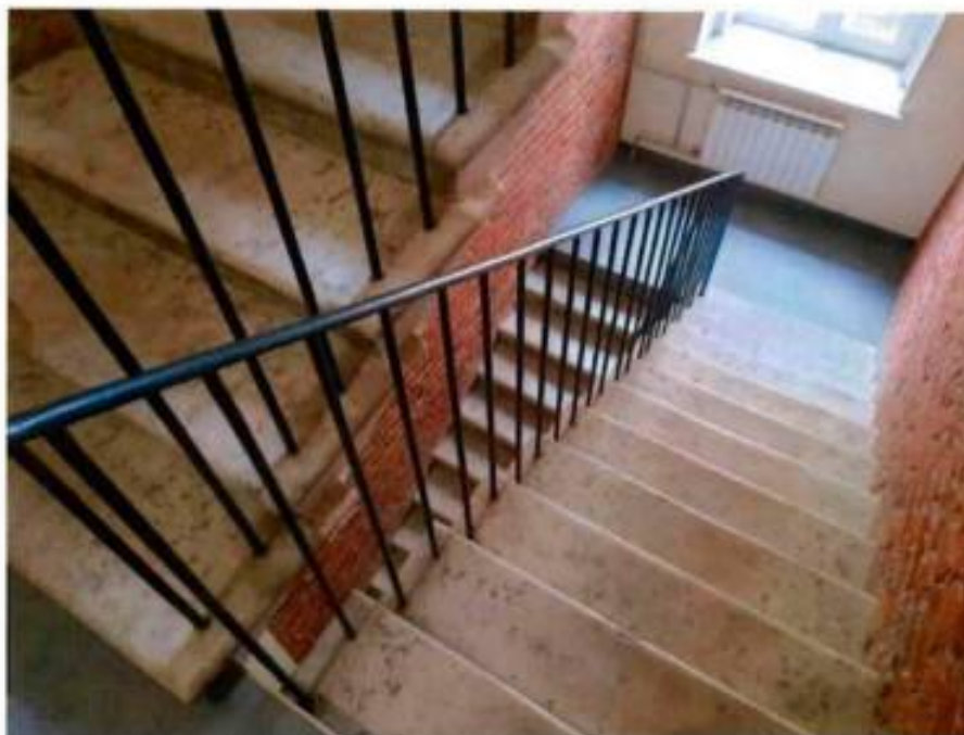
4. Лестница Л-1 объекта культурного наследия
