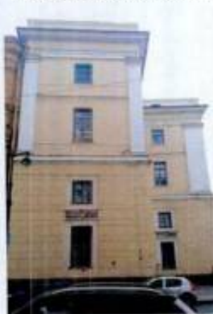
6. Северный фасад здания
