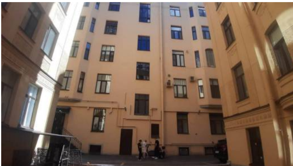
23. «Дом М.Н. и Н.А. Мельцеров» (Большая Конюшенная ул., д. 19/8, лит. А). Дворовый фасад. Фото мест установки оборудования и прокладки кабельных трасс. Штиглиц М.С. 12.06.2026.
