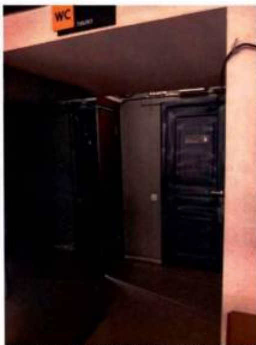
Фото 29. Общий вид помещения 14-Н (ч.п. 4) (дата съемки 10.04.2025).
