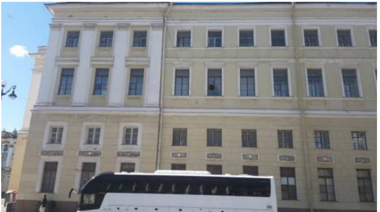
28. «Штаб Гвардейского корпуса» (Дворцовая пл., д. 4, лит. А). Лицевой фасад. Фрагмент. Фото мест установки оборудования и прокладки кабельных трасс. Штиглиц М.С. 12.06.2026.
