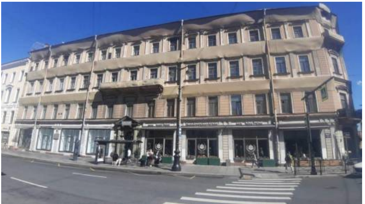
40. «Дом. Здесь в конце 1906 г. проходили заседания ЦК и ПК РСДРП» (наб. реки Мойки, д. 61, лит. А). Лицевой фасад. Штиглиц М.С. 12.06.2026.
