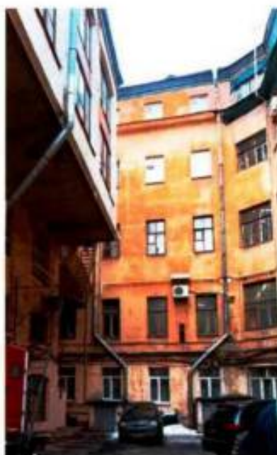
11. Общий вид северной части юго-восточного дворового фасада объекта культурного наследия. (фото от 25.02.2025)
