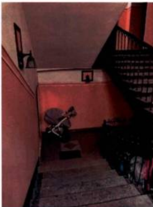
Фото 14. Лестничная клетка 5ЛК (дата съемки 10.04.2025).
