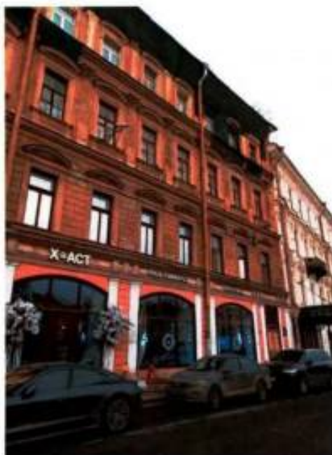
12. Фрагмент юго-восточного лицевого фасада объекта культурного наследия. (фото от 25.02.2025)
