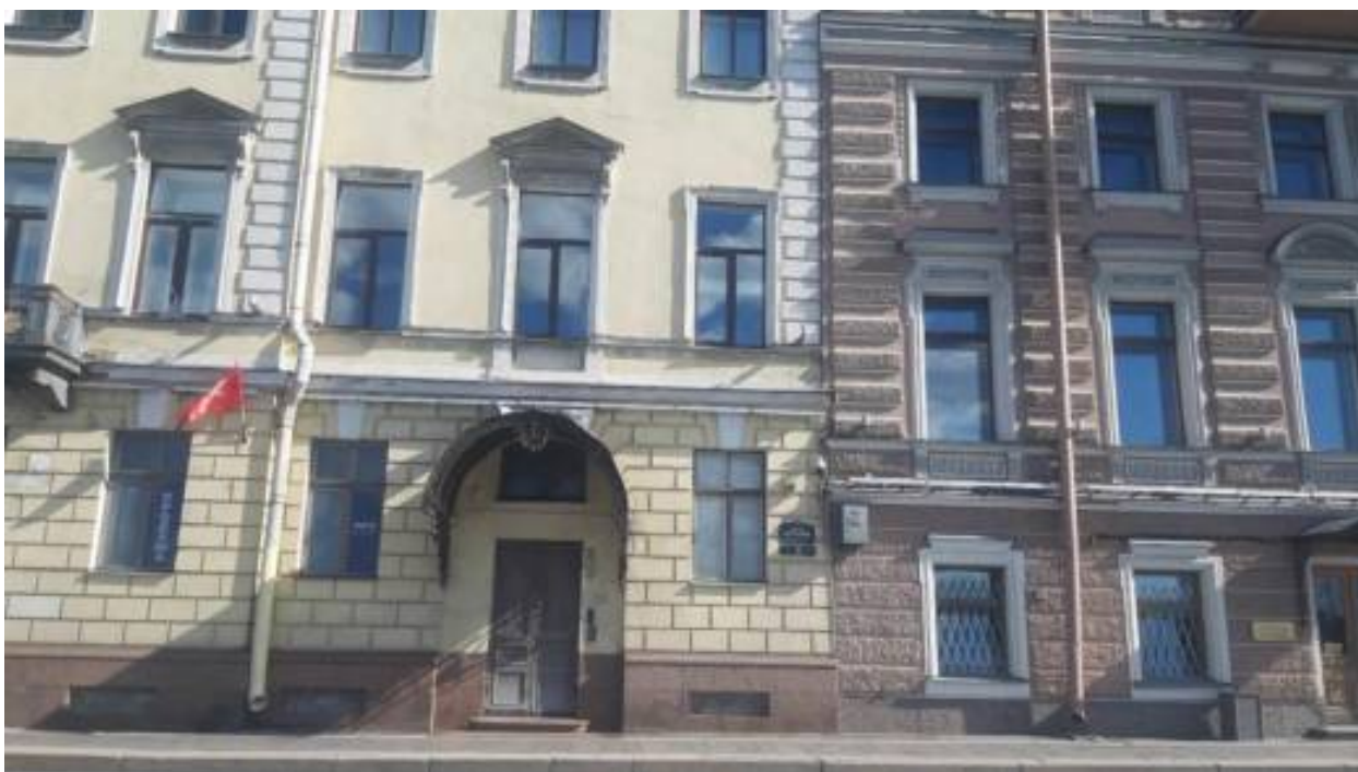
36. «Дом М.И. Скалон» (наб. Кутузова, д. 32, лит. А). Лицевой фасад. Фрагмент. Фото мест установки оборудования и прокладки кабельных трасс. Штиглиц М.С. 12.06.2026.
