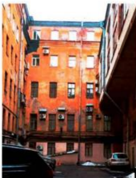
7. Общий вид северной части северо-западного дворового фасада объекта культурного наследия. (фото от 25.02.2025)
