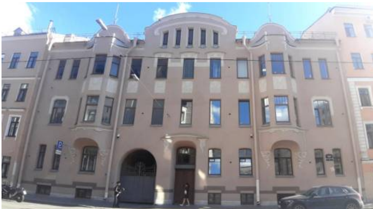
1. «Дом А.И. Ерошенко» (Басков пер., д. 5, лит. А). Лицевой фасад. Штиглиц М.С. 12.06.2026.
