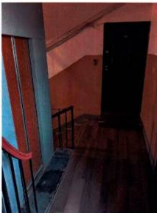
Фото 18. Лестничная клетка 7ЛК (дата съемки 10.04.2025).
