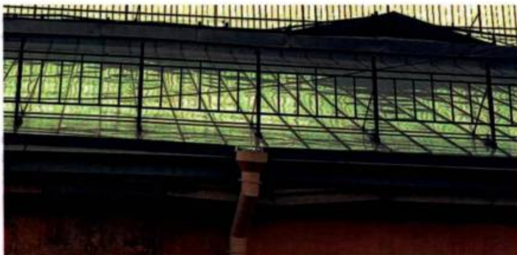
Фото 11. Вид на кровлю объекта культурного наследия.
