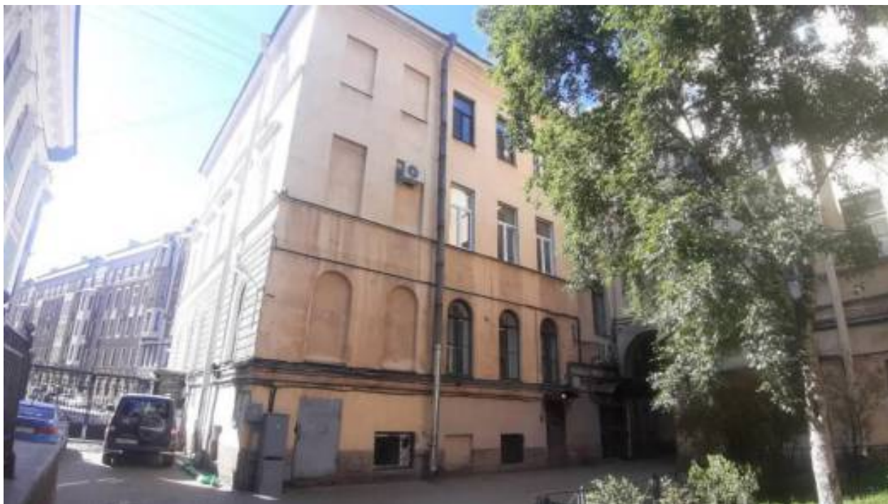
15. «Дома Евангелической лютеранской церкви св. Марии» (Большая Конюшенная ул., д. 4-6-8, лит. В). Дворовый фасад. Фото мест установки оборудования и прокладки кабельных трасс. Штиглиц М.С. 12.06.2026.
