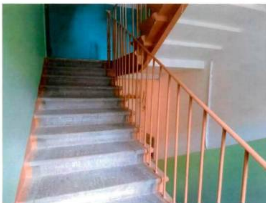
7. Лестница Л-3 объекта культурного наследия
