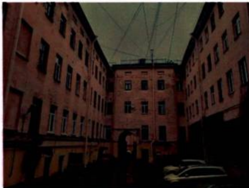
Фото 2. Общий вид на северную часть внутреннего двора объекта культурного наследия.
