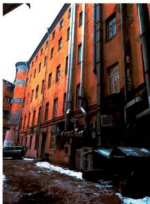
9. Общий вид северо-восточного дворового фасада объекта культурного наследия. (фото от 25.02.2025)
