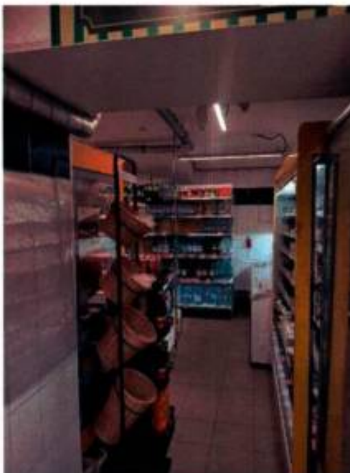
Фото 10. Общий вид помещения 13-Н (ч.п. 8) (дата съемки 10.04.2025).
