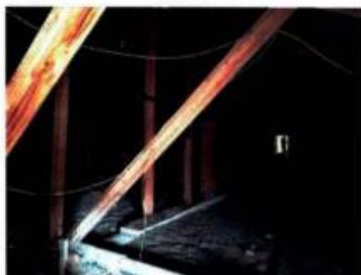
Фото 34. Конструкция крыши (дата съемки 10.04.2025).
