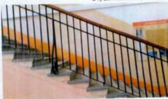
24, 25. Лестница 12Н с металлическими кронштейнами
