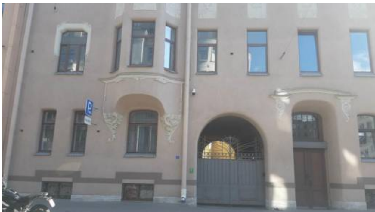
3. «Дом А.И. Ерошенко» (Басков пер., д. 5, лит. А). Лицевой фасад. Фрагмент. Фото мест установки оборудования и прокладки кабельных трасс. Штиглиц М.С. 12.06.2026.
