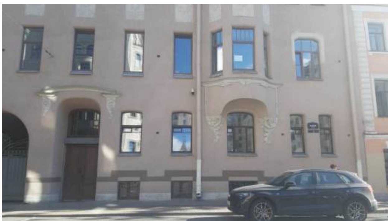
4. «Дом А.И. Ерошенко» (Басков пер., д. 5, лит. А). Лицевой фасад. Фрагмент. Фото мест установки оборудования и прокладки кабельных трасс. Штиглиц М.С. 12.06.2026.
