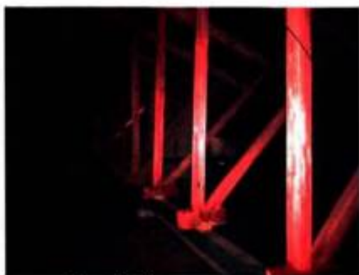
Фото 20. Конструкция крыши (дата съемки 10.04.2025).
