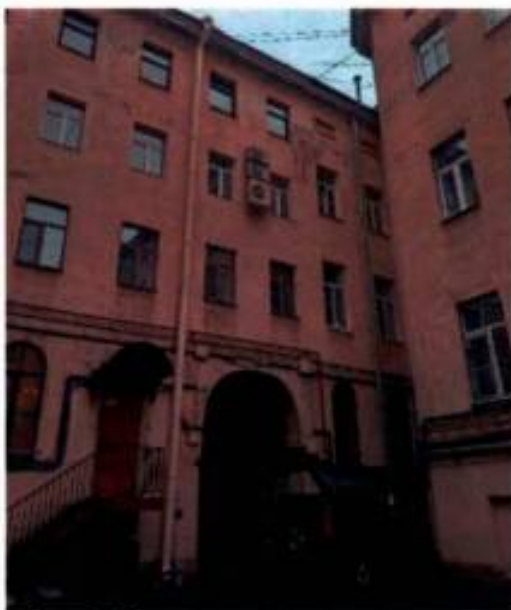
Фото 7. Фрагмент северного и восточного фасадов внутреннего двора объекта культурного наследия (дата съемки 10.04.2025).
