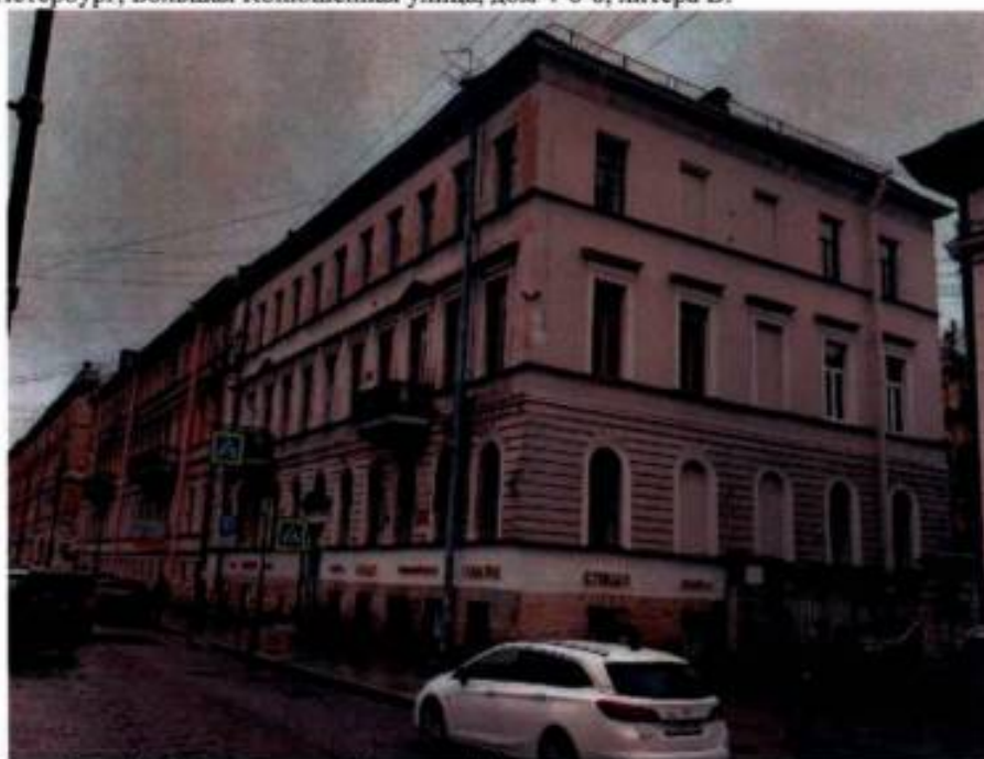
Фото 22. Вид на западный и южный фасады объекта культурного наследия (дата съемки 10.04.2025).
