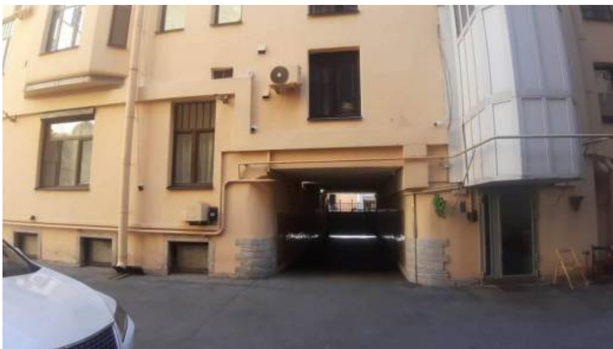
24. «Дом М.Н. и Н.А. Мельцеров» (Большая Конюшенная ул., д. 19/8, лит. А). Дворовый фасад. Фото мест установки оборудования и прокладки кабельных трасс. Штиглиц М.С. 12.06.2026.
