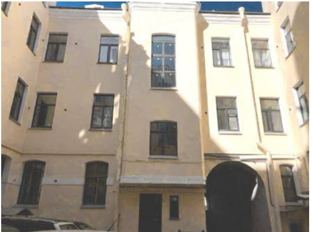
5. «Дом А.И. Ерошенко» (Басков пер., д. 5, лит. А). Дворовый фасад. Фрагмент. Фото мест установки оборудования и прокладки кабельных трасс. Штиглиц М.С. 12.06.2026.
