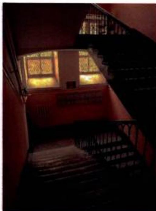
Фото 17. Лестничная клетка 5ЛК объекта культурного наследия.
