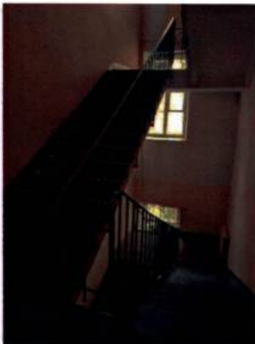
Фото 5. Лестничная клетка 4ЛК объекта культурного наследия.
