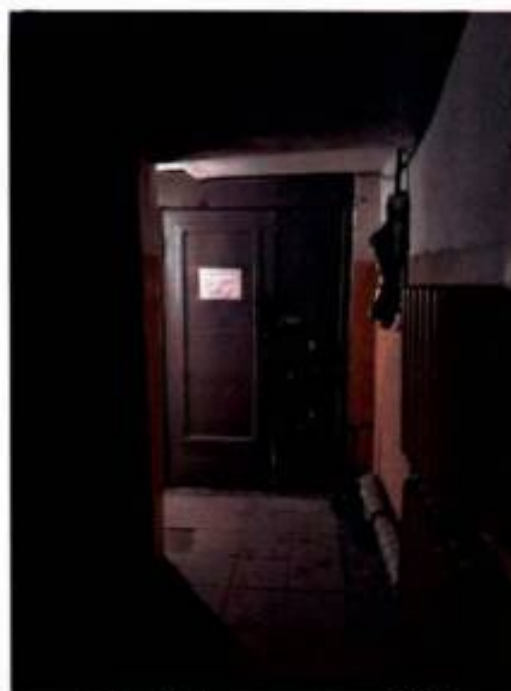
Фото 17. Лестничная клетка 7ЛК (дата съемки 10.04.2025).
