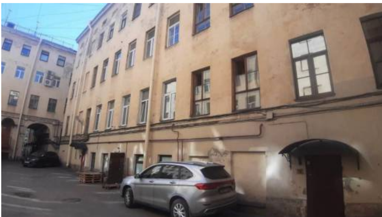
10. «Дома Евангелической лютеранской церкви св. Марии» (Большая Конюшенная ул., д. 4-6-8, лит. Б). Дворовый фасад. Фото мест установки оборудования и прокладки кабельных трасс. Штиглиц М.С. 12.06.2026.
