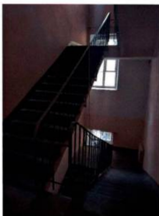
Фото 13. Лестничная клетка 4ЛК (дата съемки 10.04.2025).
