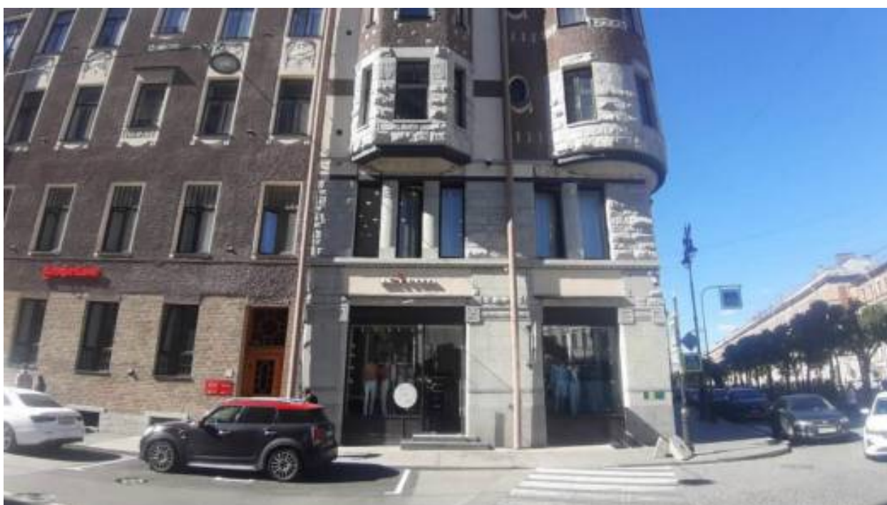
20. «Дом М.Н. и Н.А. Мельцеров» (Большая Конюшенная ул., д. 19/8, лит. А). Лицевой фасад. Фрагмент. Фото мест установки оборудования и прокладки кабельных трасс. Штиглиц М.С. 12.06.2026.
