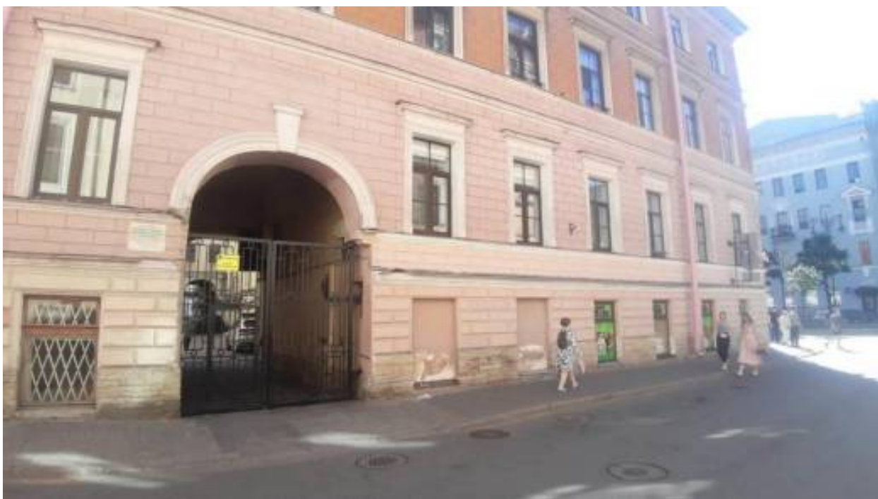
9. «Дома Евангелической лютеранской церкви св. Марии» (Большая Конюшенная ул., д. 4-6-8, лит. Б). Лицевой фасад. Фрагмент. Фото мест установки оборудования и прокладки кабельных трасс. Штиглиц М.С. 12.06.2026.
