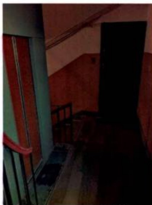
Фото 19. Лестничная клетка 7ЛК объекта культурного наследия.
