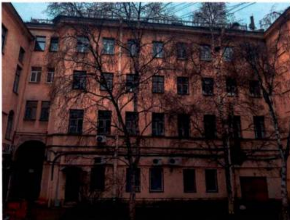
Фото 9. Южный фасад объекта культурного наследия (дата съемки 10.04.2025).
