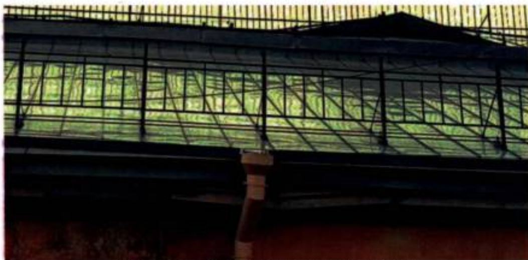
Фото 22. Вид на кровлю объекта культурного наследия.
