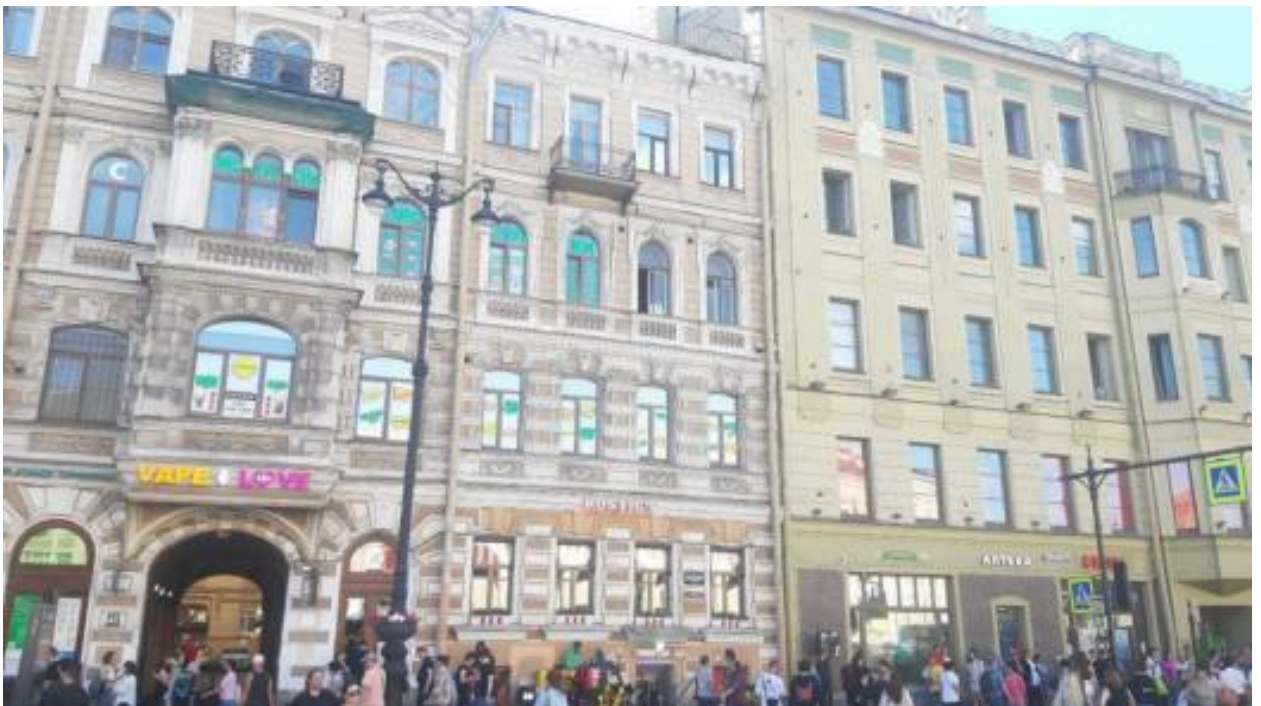
32. «Дом Ф.И. Коровина» (Лиговский пр., д. 47, лит. А). Лицевой фасад. Фрагмент. Фото мест установки оборудования и прокладки кабельных трасс. Штиглиц М.С. 12.06.2026.
