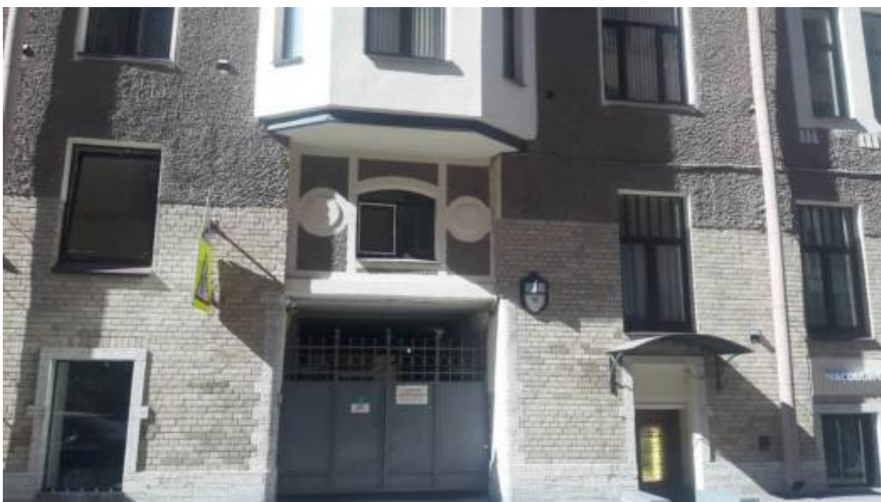
22. «Дом М.Н. и Н.А. Мельцеров» (Большая Конюшенная ул., д. 19/8, лит. А). Лицевой фасад. Фрагмент. Фото мест установки оборудования и прокладки кабельных трасс. Штиглиц М.С. 12.06.2026.
