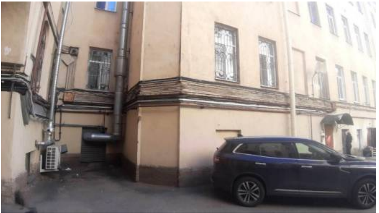
17. «Дома Евангелической лютеранской церкви св. Марии» (Большая Конюшенная ул., д. 4-6-8, лит. В). Дворовый фасад. Фото мест установки оборудования и прокладки кабельных трасс. Штиглиц М.С. 12.06.2026.
