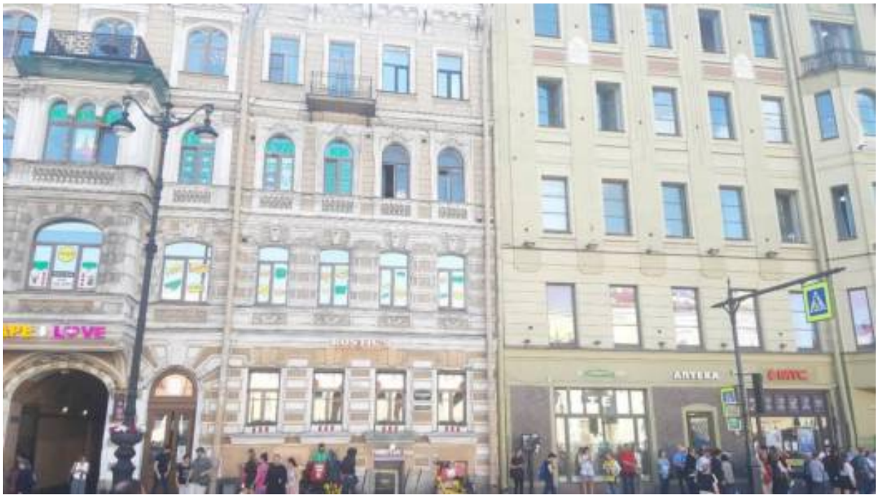
33. «Дом Ф.И. Коровина» (Лиговский пр., д. 47, лит. А). Лицевой фасад. Фрагмент. Фото мест установки оборудования и прокладки кабельных трасс. Штиглиц М.С. 12.06.2026.
