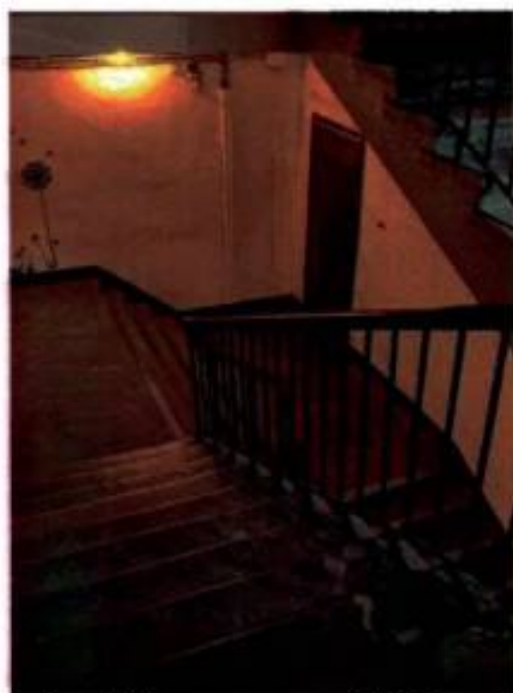
Фото 18. Лестничная клетка 6ЛК объекта культурного наследия.
