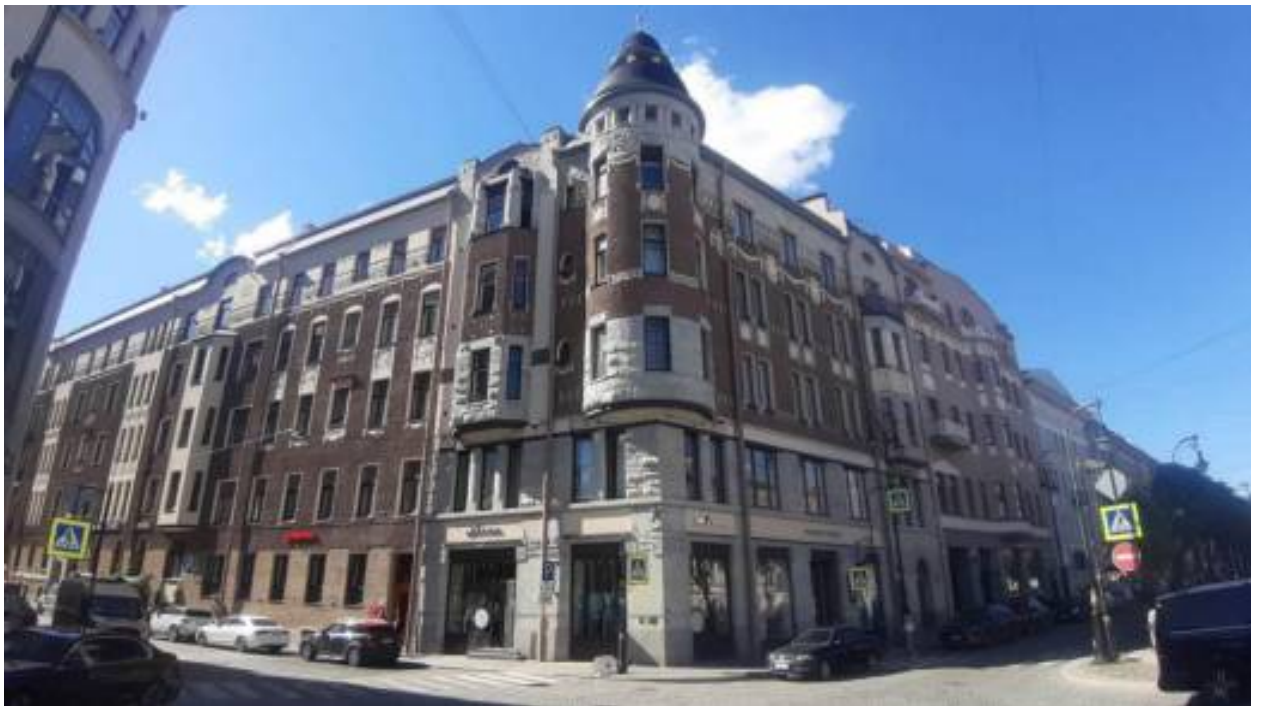
18. «Дом М.Н. и Н.А. Мельцеров» (Большая Конюшенная ул., д. 19/8, лит. А). Общий вид. Штиглиц М.С. 12.06.2026.
