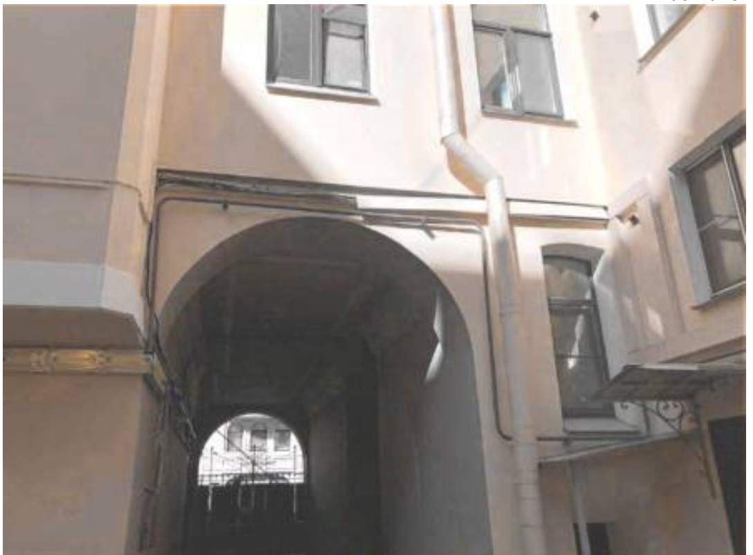
6. «Дом А.И. Ерошенко» (Басков пер., д. 5, лит. А). Дворовый фасад. Фрагмент. Фото мест установки оборудования и прокладки кабельных трасс. Штиглиц М.С. 12.06.2026.
