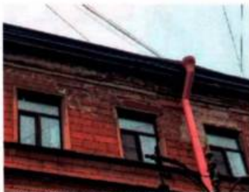
Фото 3. Фрагмент западного фасада объекта культурного наследия. Утраты венчающего карниза (дата съемки 10.04.2025).
