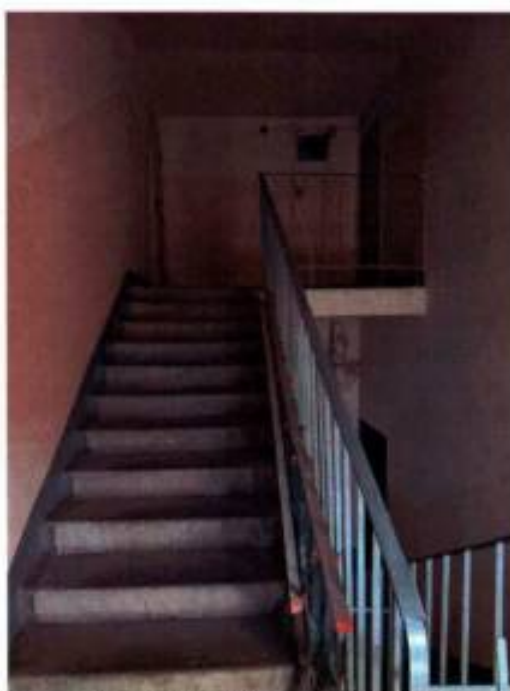
Фото 12. Лестничная клетка 4ЛК (дата съемки 10.04.2025).
