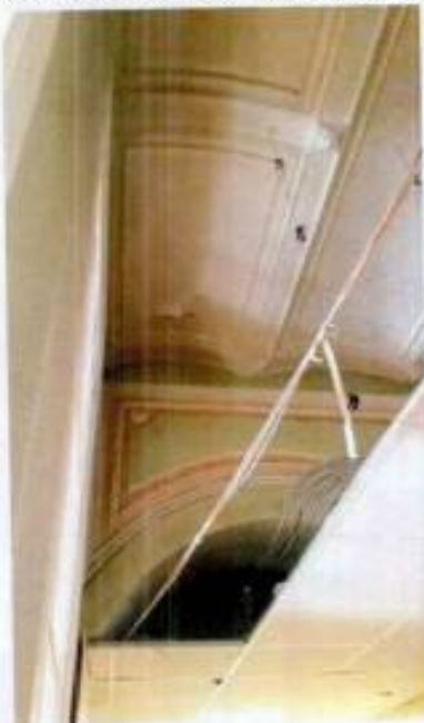
21. Сводчатое пом. IX-Н в уровне 4-го этажа
