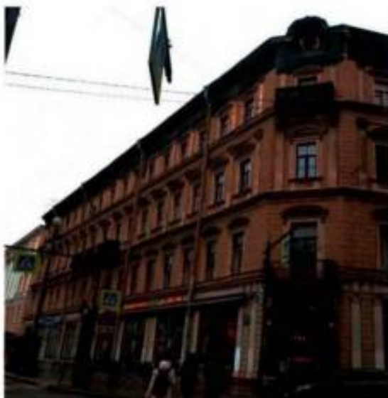
3. Общий вид северо-западного лицевого фасада объекта культурного наследия. (фото от 27.02.2025)
