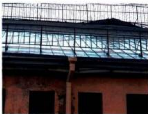
Фото 21. Вид на кровлю объекта культурного наследия (дата съемки 10.04.2025).
