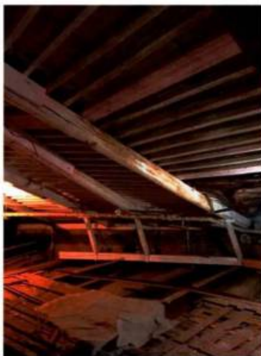
27. Чердачное пространство объекта культурного наследия (фото от 25.02.2025).
