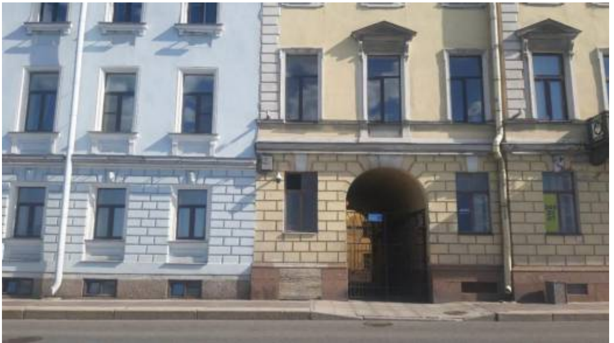
37. «Дом М.И. Скалон» (наб. Кутузова, д. 32, лит. А). Лицевой фасад. Фрагмент. Фото мест установки оборудования и прокладки кабельных трасс. Штиглиц М.С. 12.06.2026.
