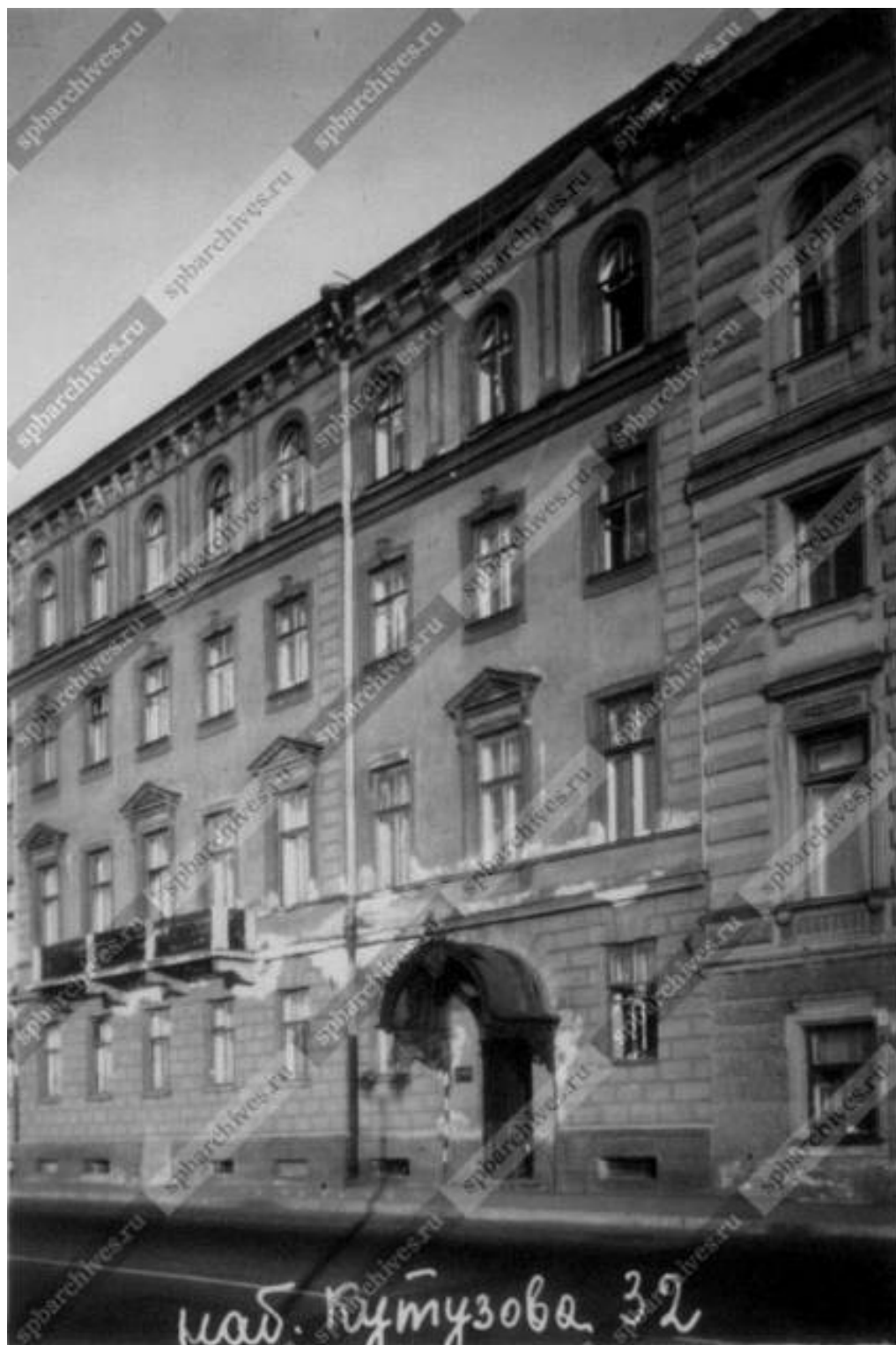
25. «Дом М.И. Скалон» (наб. Кутузова, д. 32, лит. А). 1960 г. Фасад дома №32 по наб. Кутузова ЦГАКФФД СПб Гр 74529.
