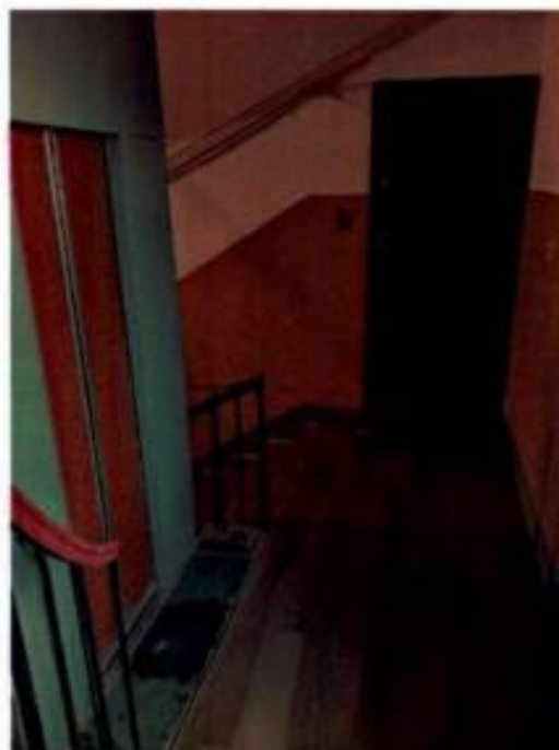
Фото 8. Лестничная клетка 7ЛК объекта культурного наследия.
