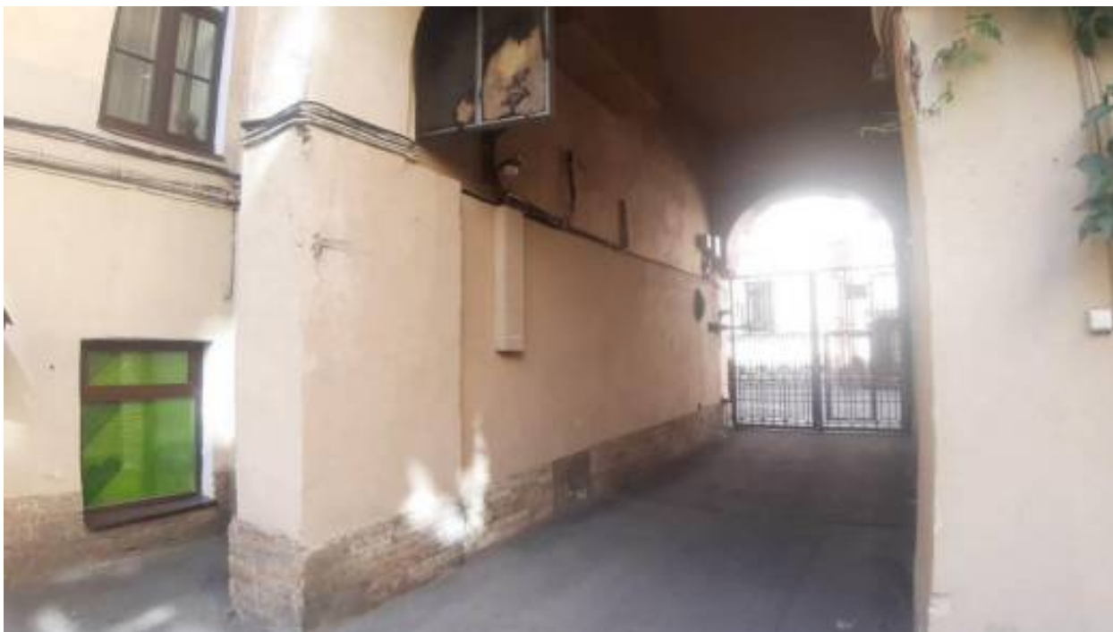
11. «Дома Евангелической лютеранской церкви св. Марии» (Большая Конюшенная ул., д. 4-6-8, лит. Б). Дворовый фасад. Фото мест установки оборудования и прокладки кабельных трасс. Штиглиц М.С. 12.06.2026.
