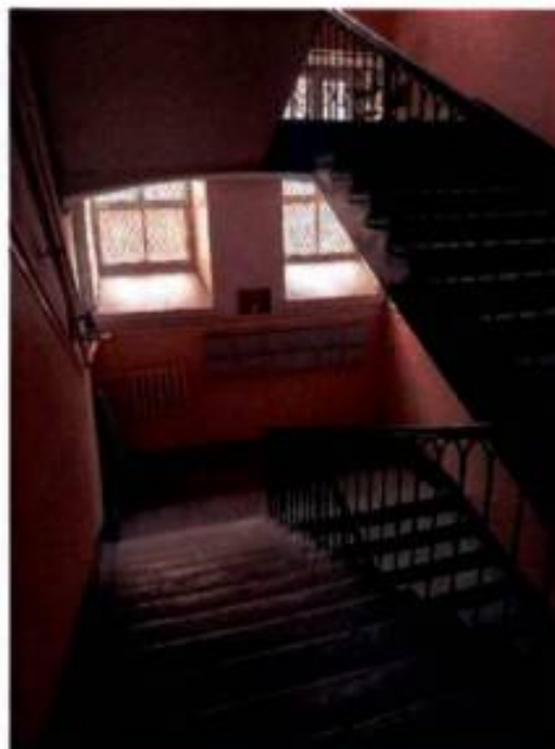
Фото 15. Лестничная клетка 5ЛК (дата съемки 10.04.2025).
