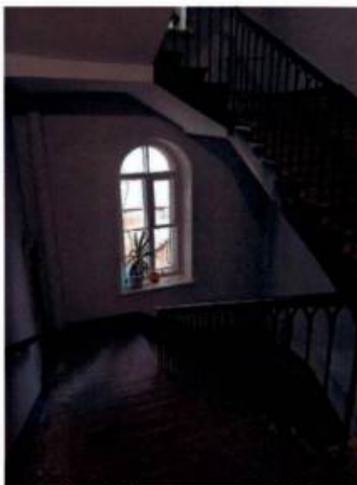
Фото 31. Лестничная клетка 3ЛК (дата съемки 10.04.2025).
