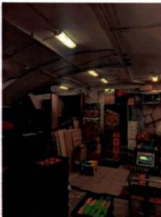
Фото 20. Общий вид подвального помещения 13-Н (ч.п. 14) объекта культурного наследия.
