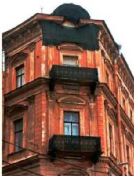
14. Фрагмент южного лицевого фасада объекта культурного наследия. (фото от 25.02.2025)
