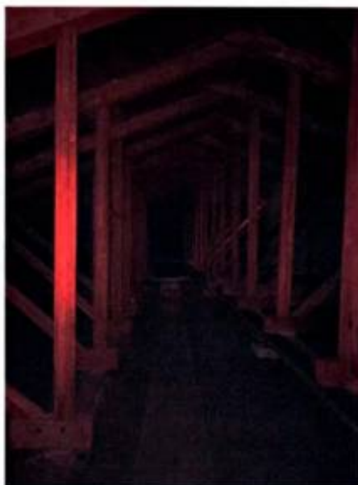
Фото 19. Конструкция крыши (дата съемки 10.04.2025).
