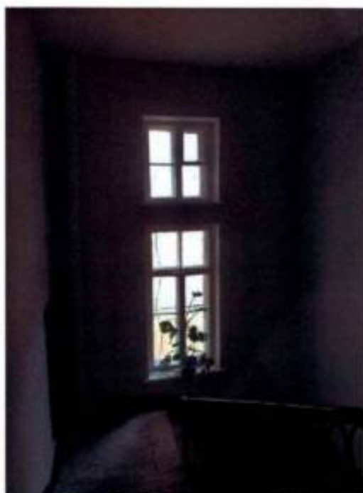
Фото 32. Лестничная клетка 3ЛК (дата съемки 10.04.2025).
