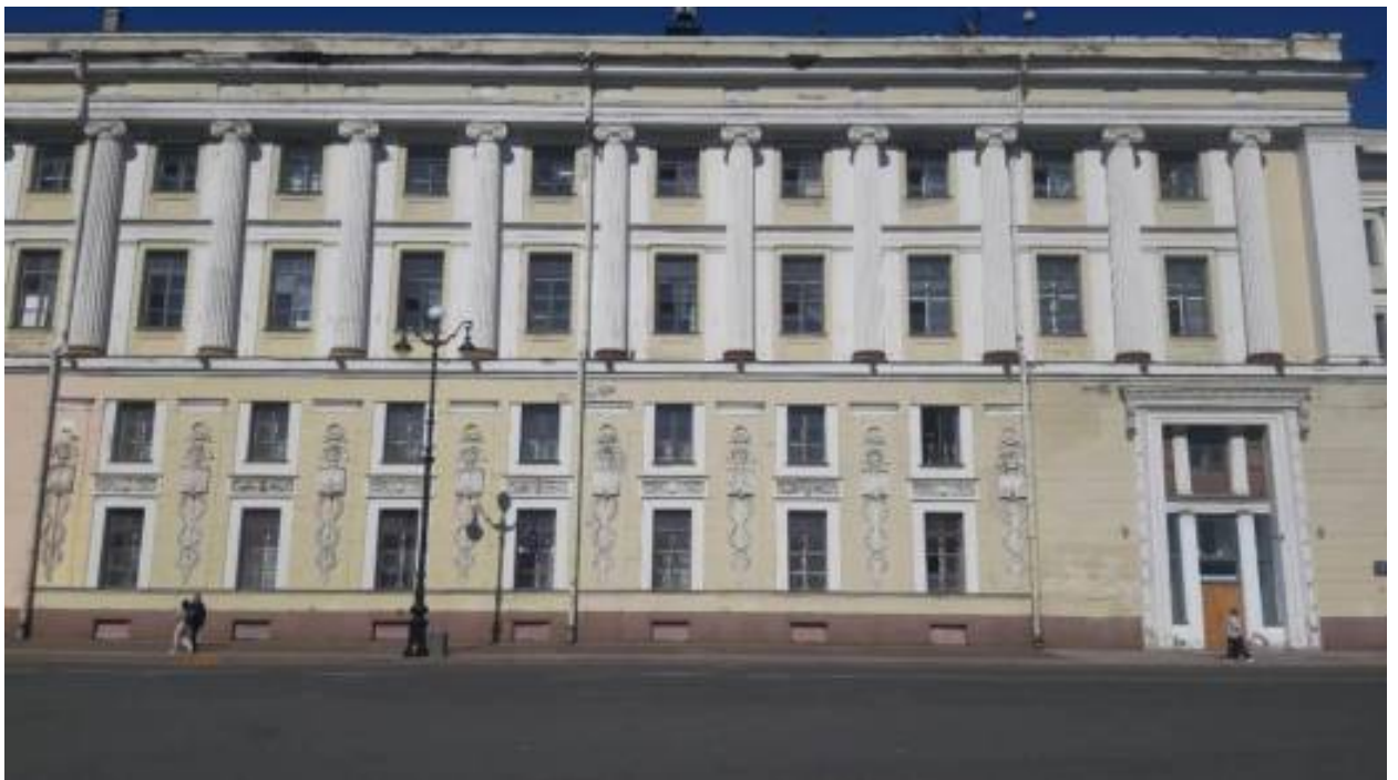
26. «Штаб Гвардейского корпуса» (Дворцовая пл., д. 4, лит. А). Лицевой фасад. Фрагмент. Фото мест установки оборудования и прокладки кабельных трасс. Штиглиц М.С. 12.06.2026.
