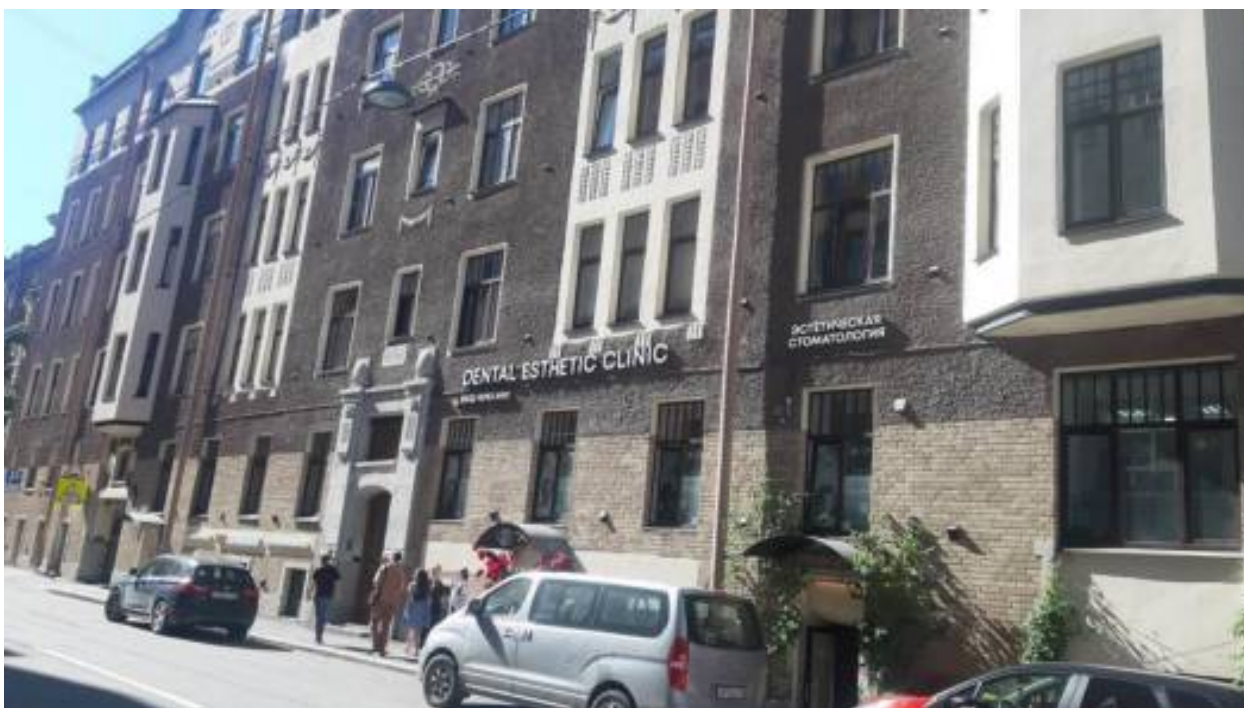
21. «Дом М.Н. и Н.А. Мельцеров» (Большая Конюшенная ул., д. 19/8, лит. А). Лицевой фасад. Фрагмент. Фото мест установки оборудования и прокладки кабельных трасс. Штиглиц М.С. 12.06.2026.
