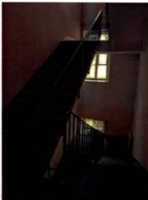
Фото 16. Лестничная клетка 4ЛК объекта культурного наследия.
