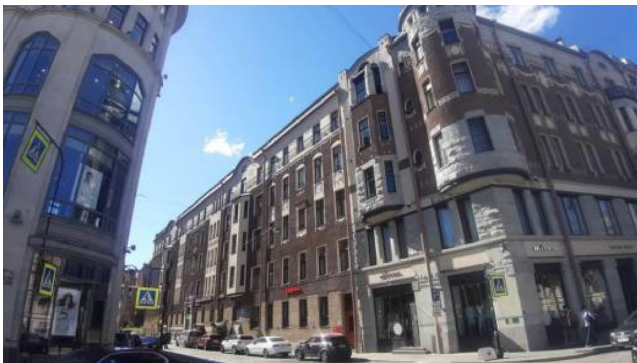
19. «Дом М.Н. и Н.А. Мельцеров» (Большая Конюшенная ул., д. 19/8, лит. А). Общий вид. Штиглиц М.С. 12.06.2026.
