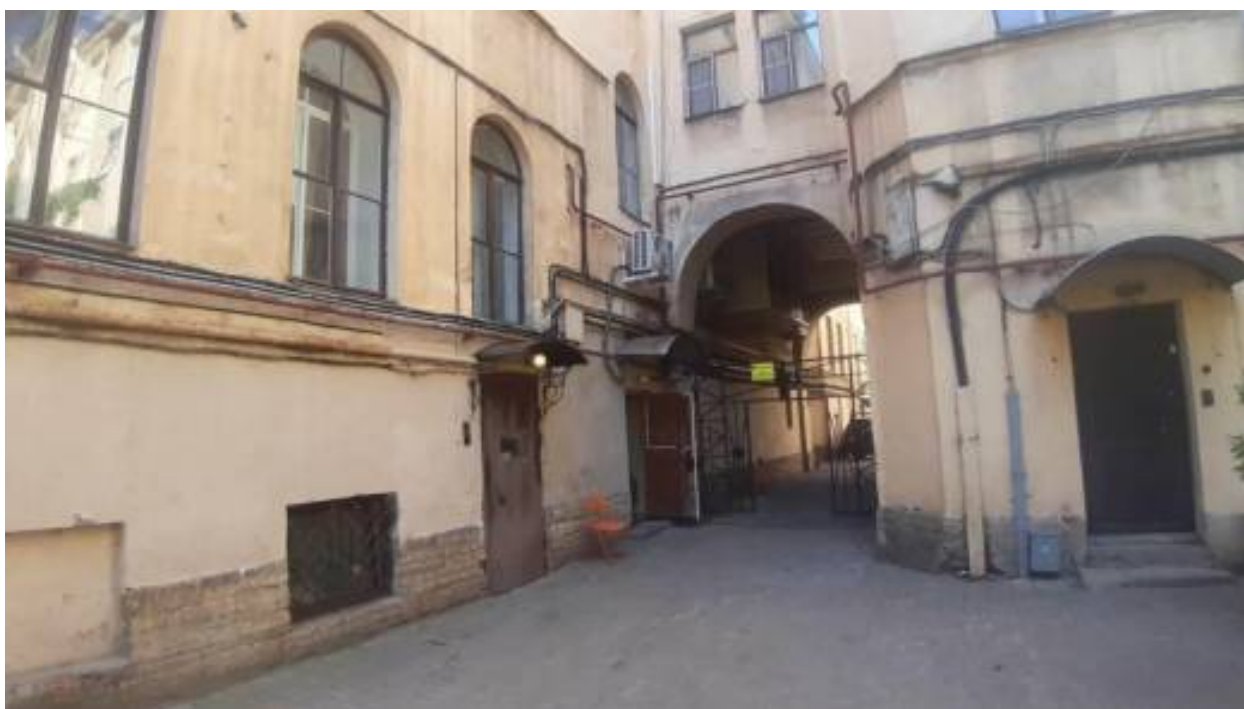
16. «Дома Евангелической лютеранской церкви св. Марии» (Большая Конюшенная ул., д. 4-6-8, лит. В). Дворовый фасад. Фото мест установки оборудования и прокладки кабельных трасс. Штиглиц М.С. 12.06.2026.
