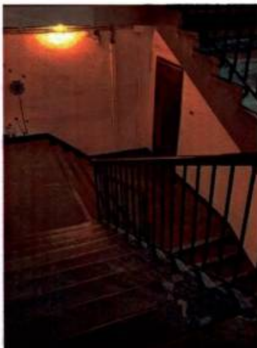
Фото 7. Лестничная клетка 6ЛК объекта культурного наследия.
