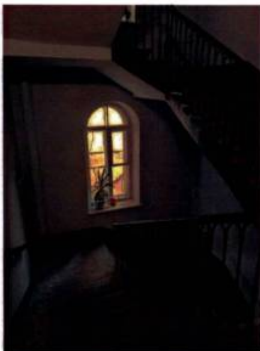
Фото 25. Лестничная клетка ЗЛК объекта культурного наследия.
